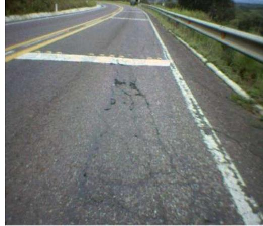
Km 25+540 lado derecho, grietas Longitudinales con abertura hasta de 1 cm y desprendimiento de agregados.
