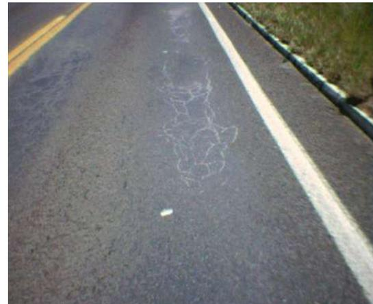
Km 9+530 lado izquierdo presencia de agrietamiento con deformación.
