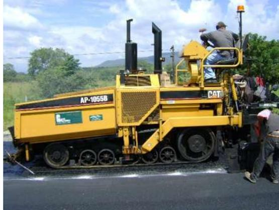
**Figura 41:** Pavimentadora AP-1055B (Utilizada en este proyecto).
