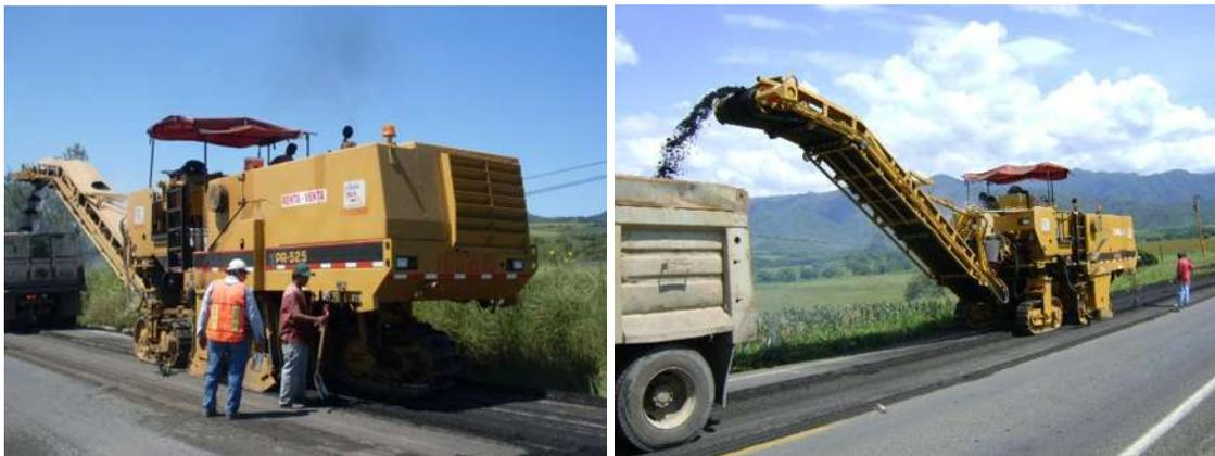
**Figura 11:** Fresadora de pavimentos CMI PR-525, en el proceso de fresado del pavimento actual.
