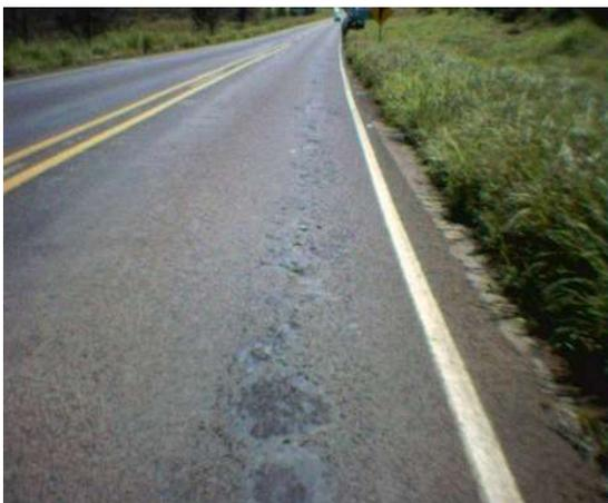
Km 17+180 lado izquierdo, presencia de Agrietamientos con desprendimiento de agregados.
