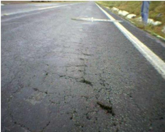
Km 14+940 lado derecho, agrietamientos calavereo y deformación hasta 2.0 cm.
