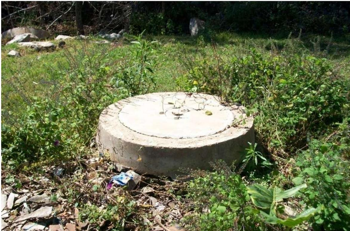
Figura 4.5 Pozo de visita del colector, el cual se encuentra próximo al lago y corre el riesgo de quedar inundado al subir el nivel del lago
