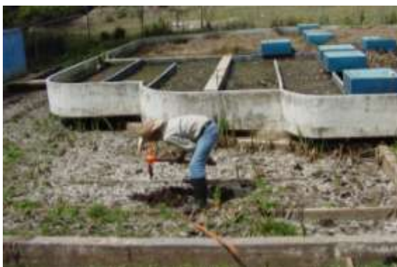
Figuras 12 y 13. Humedal de “tule” totalmente azolvado o saturado de arcilla y limo.
