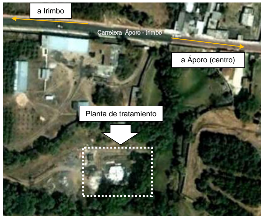
Figura 3. Vista aérea de la planta de tratamiento
