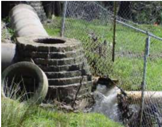
Figuras 14 y 15. Desbordamiento de aguas residuales sobre el sistema de humedales
