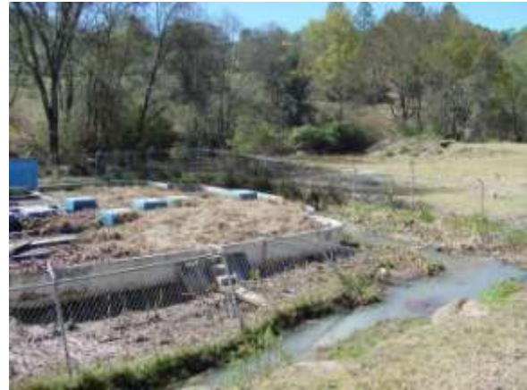
Figuras 14 y 15. Desbordamiento de aguas residuales sobre el sistema de humedales
