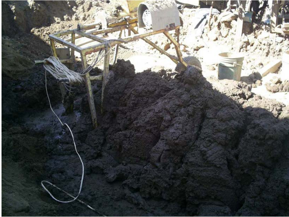
Fotografía 3.15 Mezclado de las arcillas.
