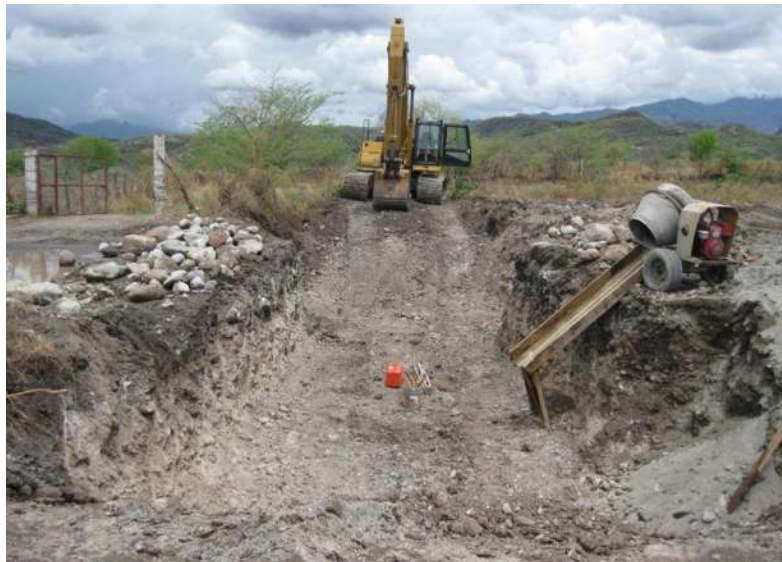
Figura 5.6. Excavadora realizando excavación para obra de drenaje.
