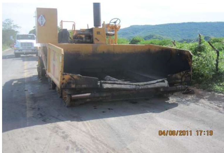
Figura 5.18. Pavimentadora Finisher lista para recibir la carpeta asfáltica y realizar su colocación.
