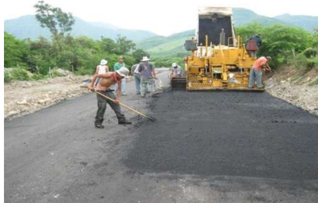
Figura 4.42. Rastrillado en la carpeta asfáltica.
