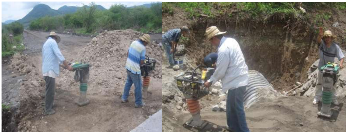
Figura 4.14. Relleno y compactación en estructuras de drenaje, (Aproches).
