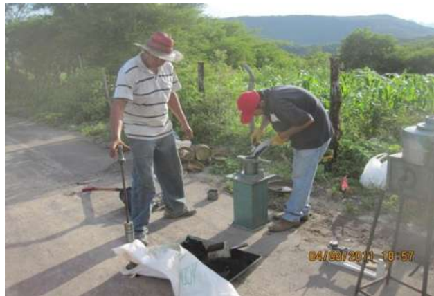
Figura 4.44. Muestreo de la carpeta asfáltica para control de calidad.
