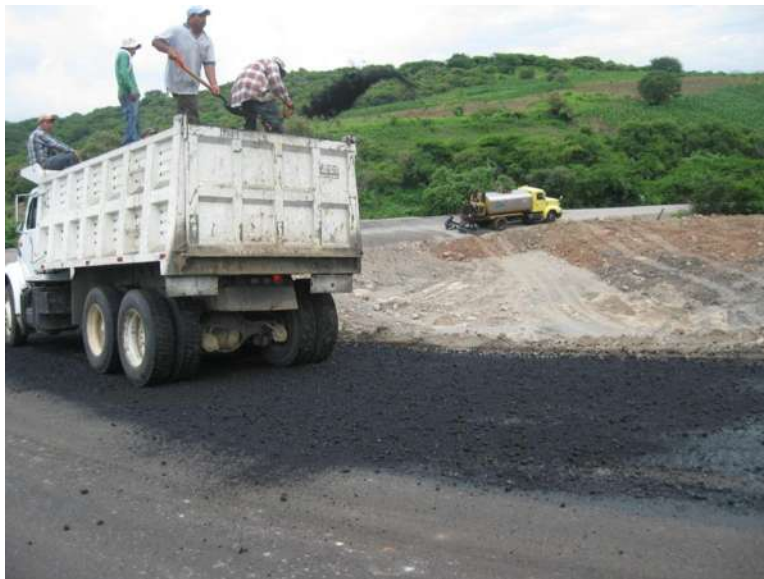
Figura 5.22. Camión volteo con carpeta asfáltica y rastrilleros realizando poreo.
