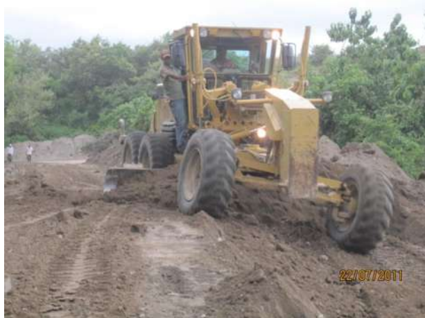
Figura 5.2. Motoconformadora en etapa de terraplén.
