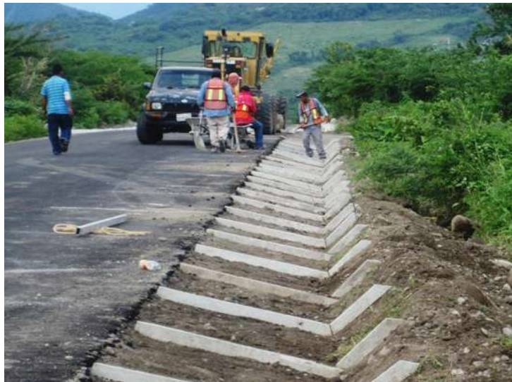
Figura 5.11. Cuadrilla de trabajadores realizando colocado de cerchas para cunetas.
