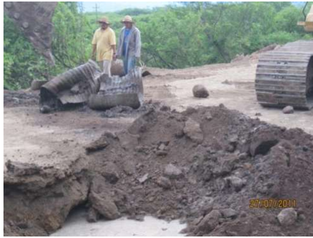
Figura 4.23. Demolición de tubo de lámina.
