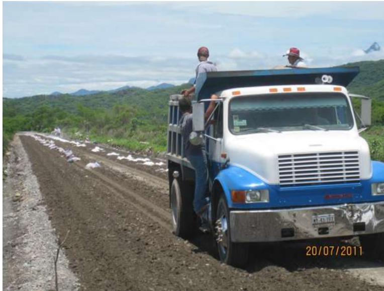
Figura 5.15. Camión volteo de 7 m 3 de capacidad.
