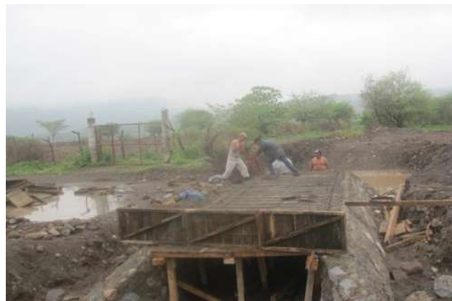
Figura 4.16. Suministro y armado del acero de refuerzo.
