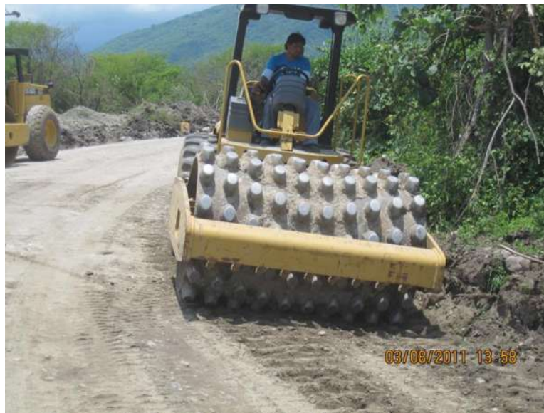
Figura 5.14. Compactador pata de cabra compactando los hombros del camino, se aprecia el correcto manejo del equipo.
