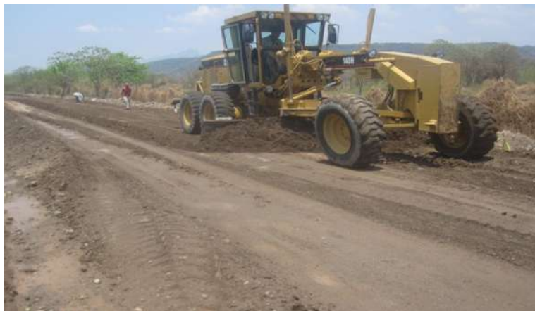
Figura 4.29. Afine de la capa Subrasante.
