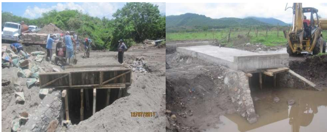
Figura 4.18. Terminado de la losa de concreto hidráulico F'c=250 \text{ kg/cm}^2 .
