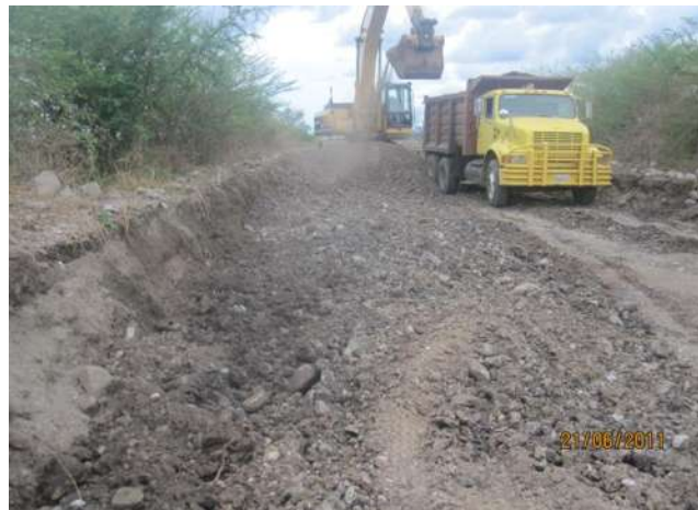
Figura 5.5. Camión volteo con capacidad de 14 m 3 .
