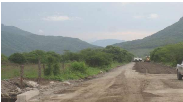
Figura 4.28. Tendido de la capa Subrasante.
