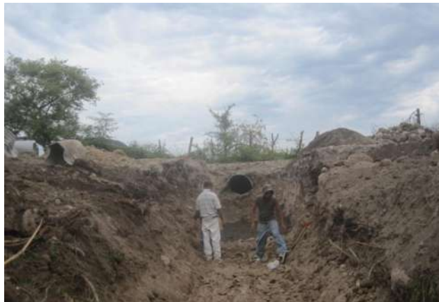
Figura 4.24. Demolición de mampostería.
