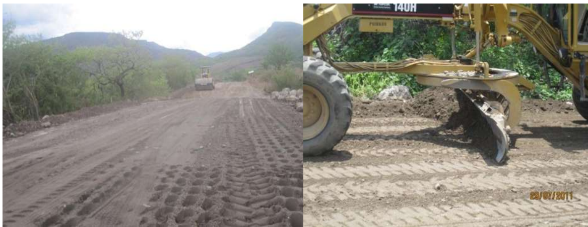
Figura 4.33. Suministro y tendido de la base hidráulica.
