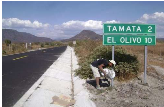
Figura 4.51. Señalamiento horizontal y vertical (SIG).
