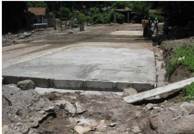
Figura 4.22. Terminado del vado de concreto en concreto hidráulico.
