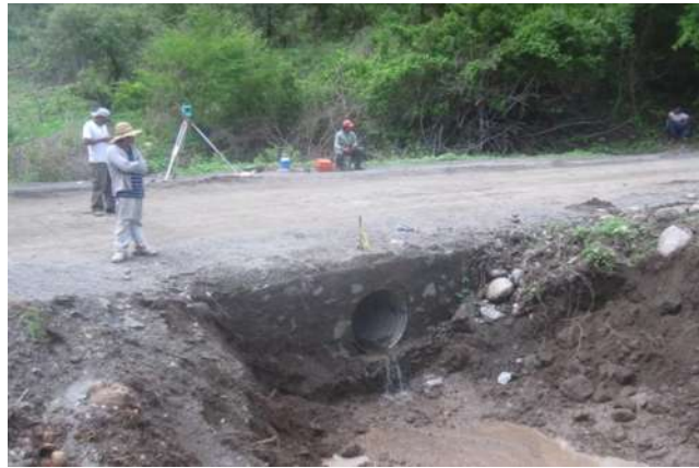
Figura 4.4. Trazo y nivelación acorde a proyecto.
