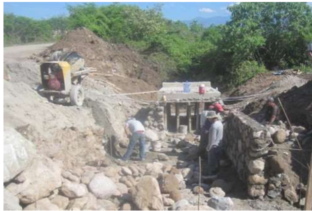
Figura 4.15. Mampostería de tercera clase en alcantarilla de losa.
