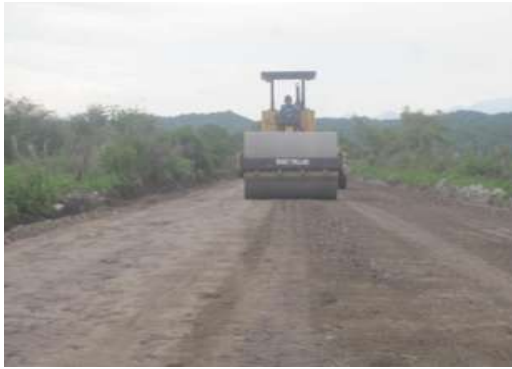
Figura 4.30. Compactación de la capa Subrasante.
