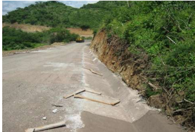
Figura 4.48. Terminado de cunetas.
