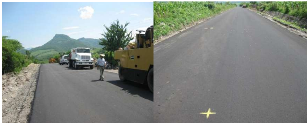
Figura 4.45. Terminado de la carpeta asfáltica.
