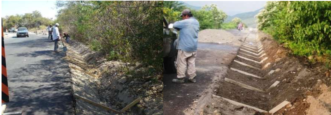
Figura 4.46. Colocado de cerchas para el zampeo de cunetas.
