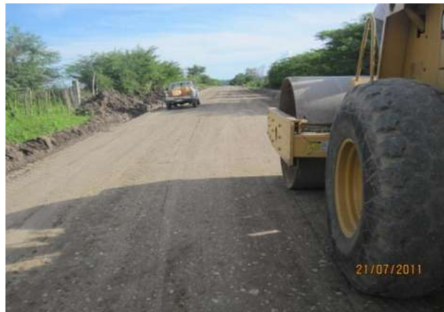
Figura 4.32. Capa Subrasante terminada, lista para recibir capa de base hidráulica.
