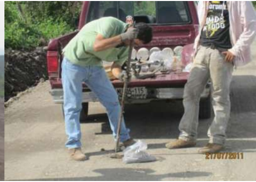
Figura 4.31. Verificación en campo del grado de Compactación en capa Subrasante.
