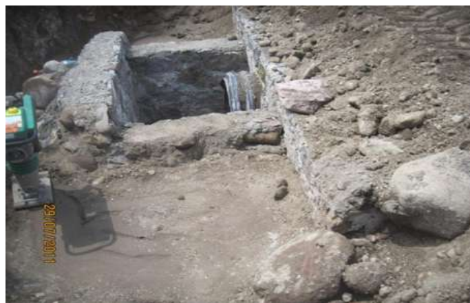
Figura 4.27. Terminado de alcantarilla de tubo.
