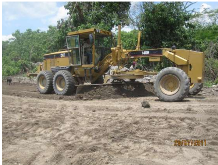
Figura 5.12. Motoconformadora realizando el bandeo del material para homogeneizarlo y eliminar con ello las partículas de dimensiones que exceden la granulometría.
