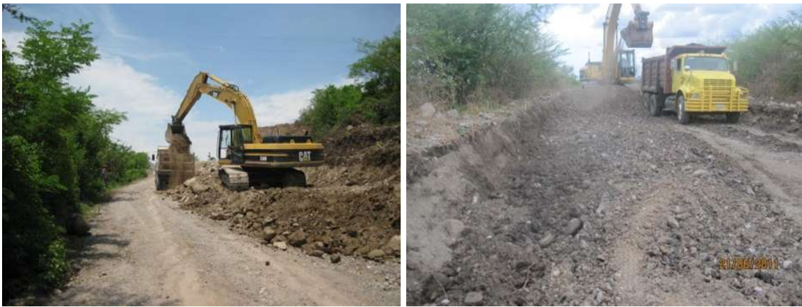
Figura 4.9. Excavación en corte.
