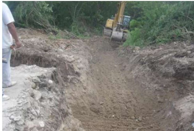
Figura 4.12. Excavación para canales de entrada.
