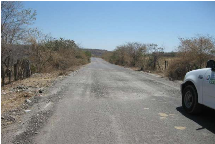
Figura 4.3. Inicio del tramo en construcción Km 5+800.
