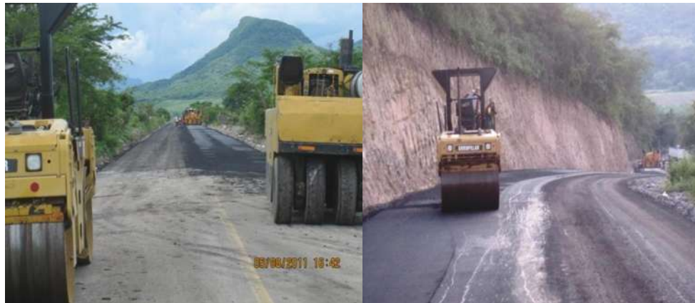
Figura 4.43. Compactación en la carpeta asfáltica.
