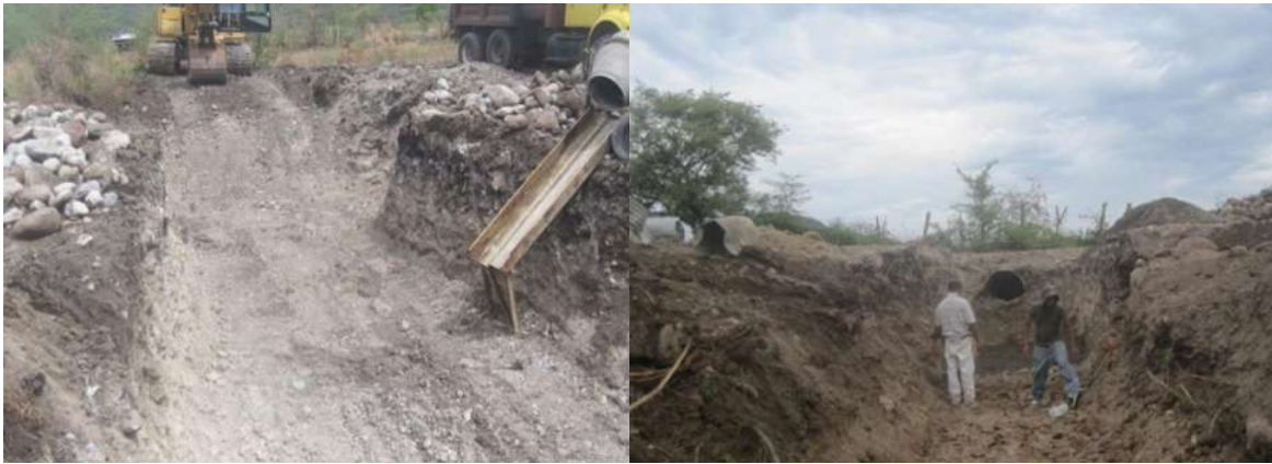
Figura 4.13. Excavaciones para estructuras de drenaje.
