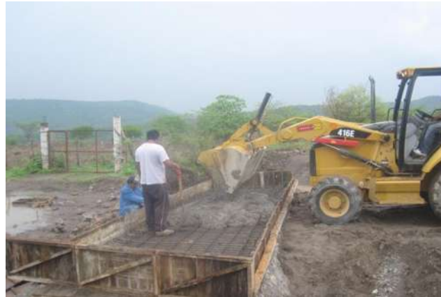
Figura 4.17. Suministro y colocación de concreto hidráulico F'c=250 \text{ kg/cm}^2 .
