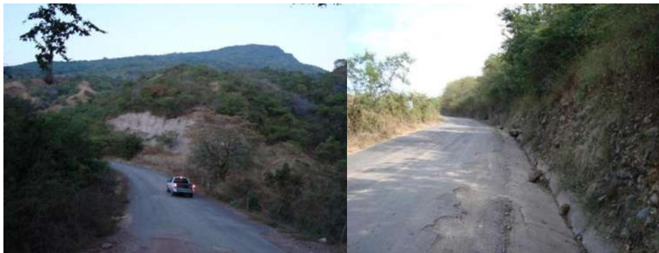
Figura 2.12. Condiciones iniciales del camino (vista de taludes).
