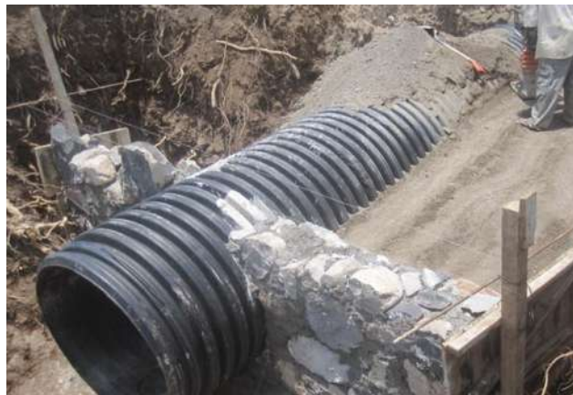
Figura 4.26. Mampostería de tercera clase en alcantarilla de tubo.
