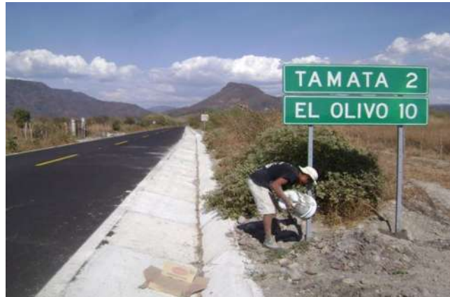
Figura 5.23. Colocación de señalamiento vertical.
