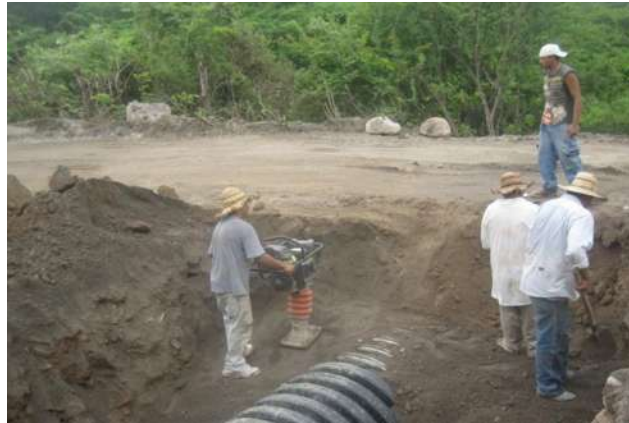
Figura 4.25. Colocación de tubo y relleno para estructuras de drenaje.
