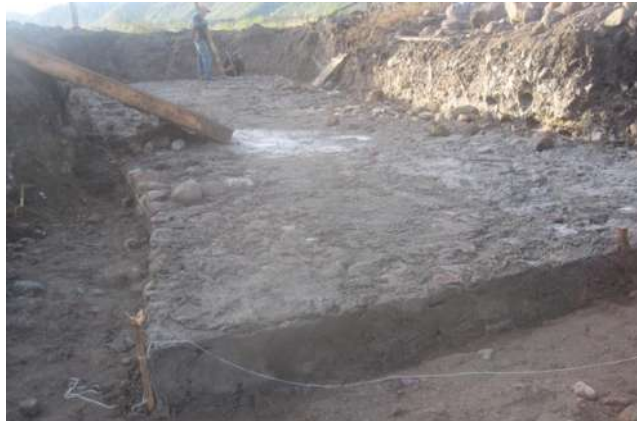
Figura 4.19. Vado: zampeado de mampostería de tercera clase.
