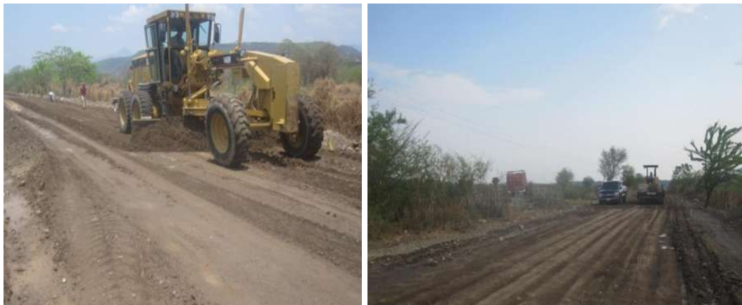
Figura 4.11. Capa de terraplen.
