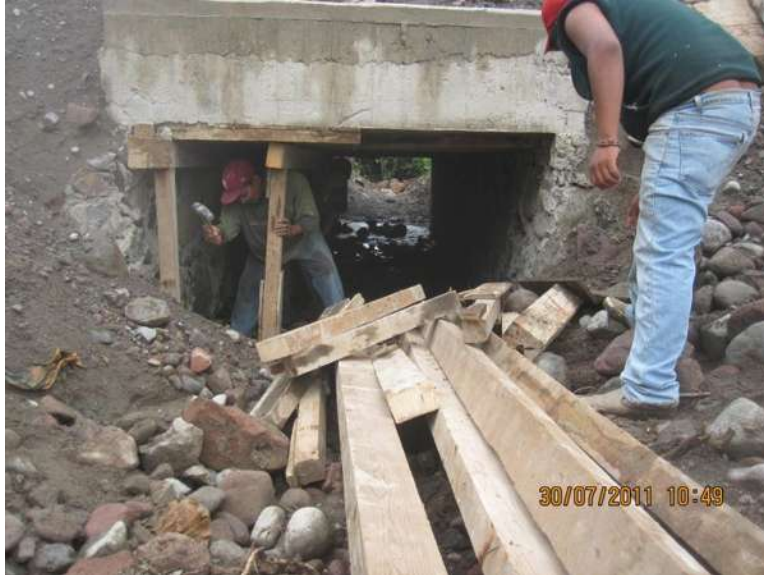
Figura 5.10. Descimbrado en obra de drenaje de losa, cimbrada con madera de tercera.
