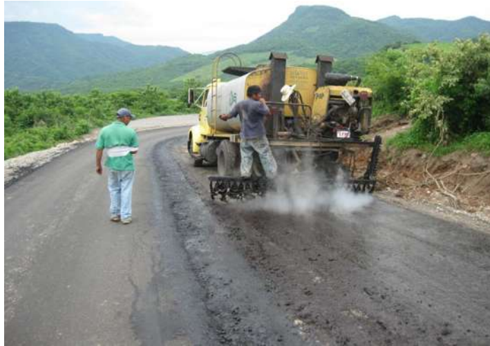
Figura 5.17. Petrolizadora realizando riego de liga.
