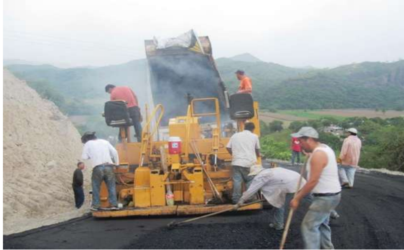
Figura 5.21. Cuadrilla de rastrilleros en tendido de carpeta asfáltica.
