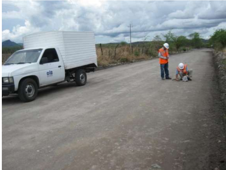
Figura 4.35. Verificación del grado de compactación de la base hidráulica.
