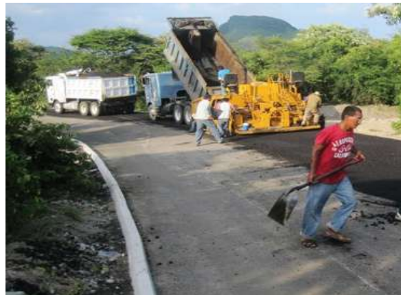
Figura 4.49. Terminado de construcción de bordillos.
