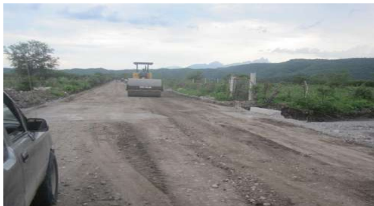
Figura 4.34. Compactación de la base hidráulica.
