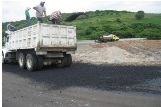
Figura 4.40. Ligado de la base hidráulica.
