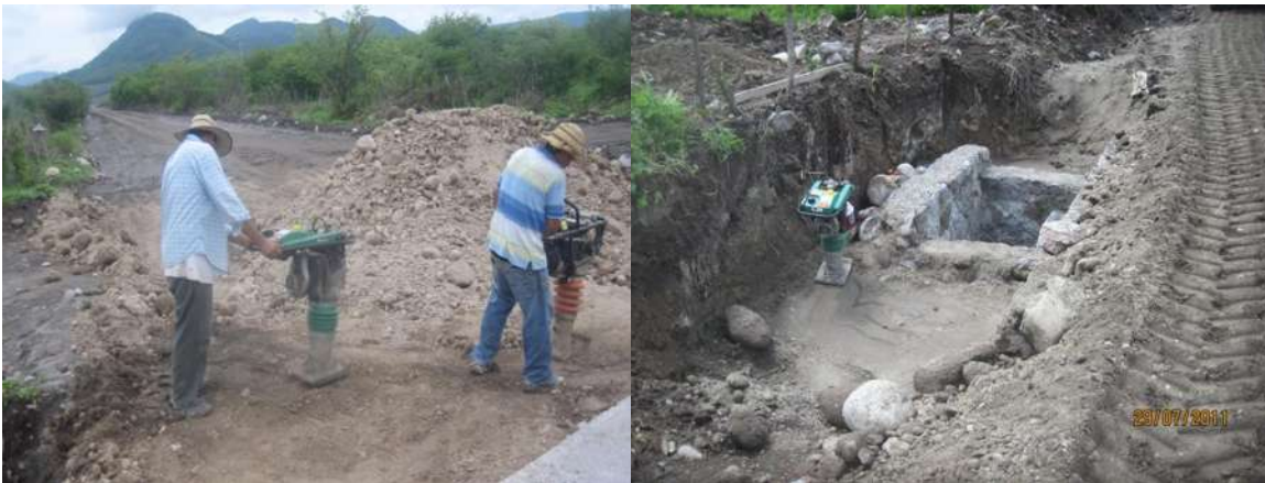
Figura 5.9. Compactador vibratorio tipo bailarina empleado en compactación de aproches.
