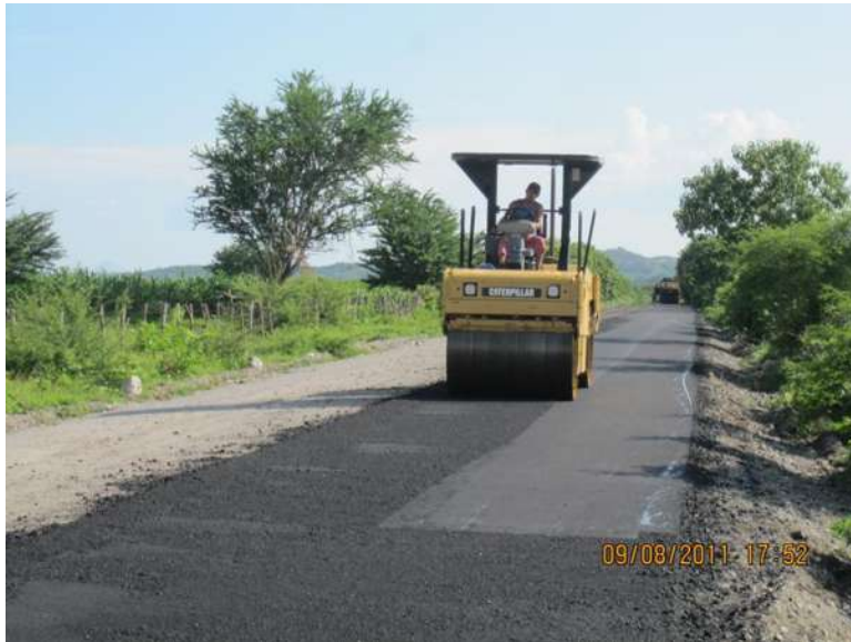
Figura 5.19. Compactador de doble tambor liso compactando carpeta asfáltica.
