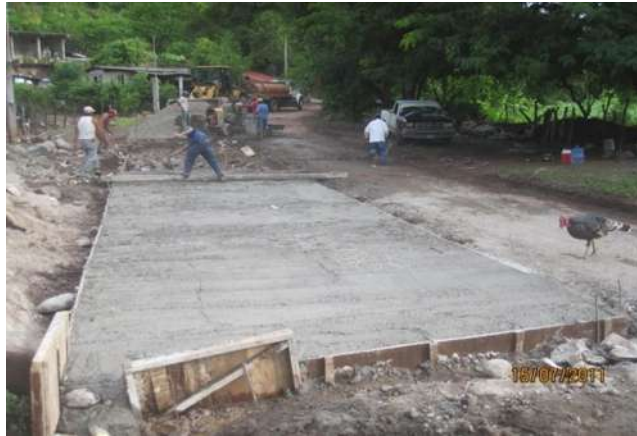
Figura 4.21. Acabado y colado del concreto hidráulico.
