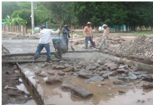
Figura 4.20. Suministro y colado del concreto hidráulico.
