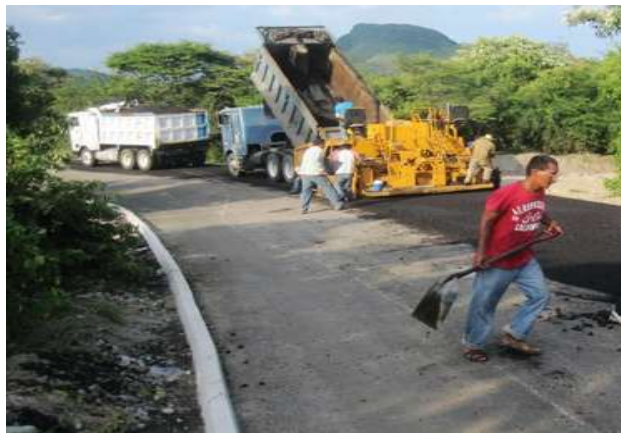
Figura 4.41. Suministro y colocación de la carpeta asfáltica.
