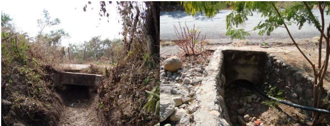
Figura 2.6. Antecedentes de obras de drenaje en el camino.
