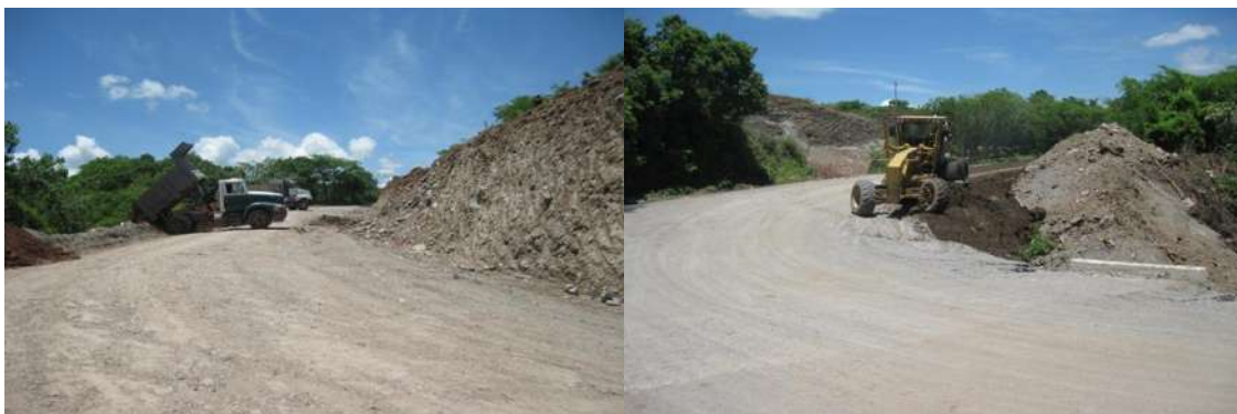
Figura 4.33. Arrope de talud.
