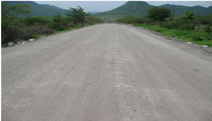
Figura 4.36. Base hidráulica lista para recibir riego de impregnación.
