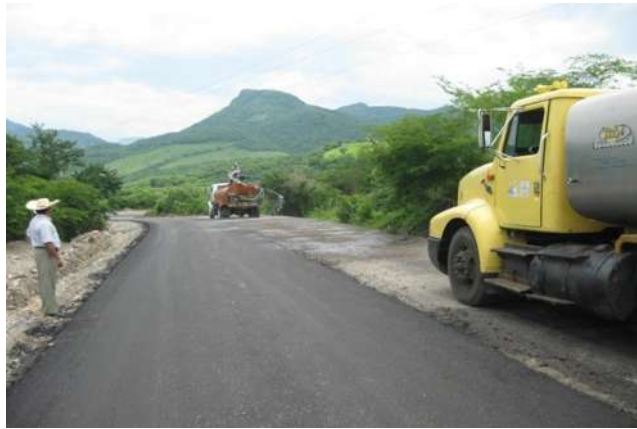
Figura 4.37. Aplicación de humedad a la base hidráulica.
