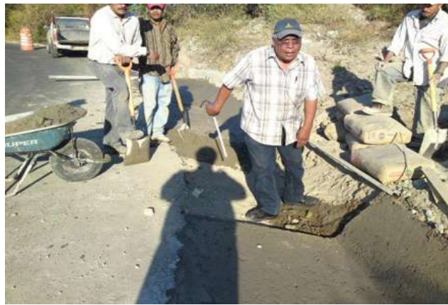
Figura 4.47. Zampeado de cunetas con concreto hidráulico.
