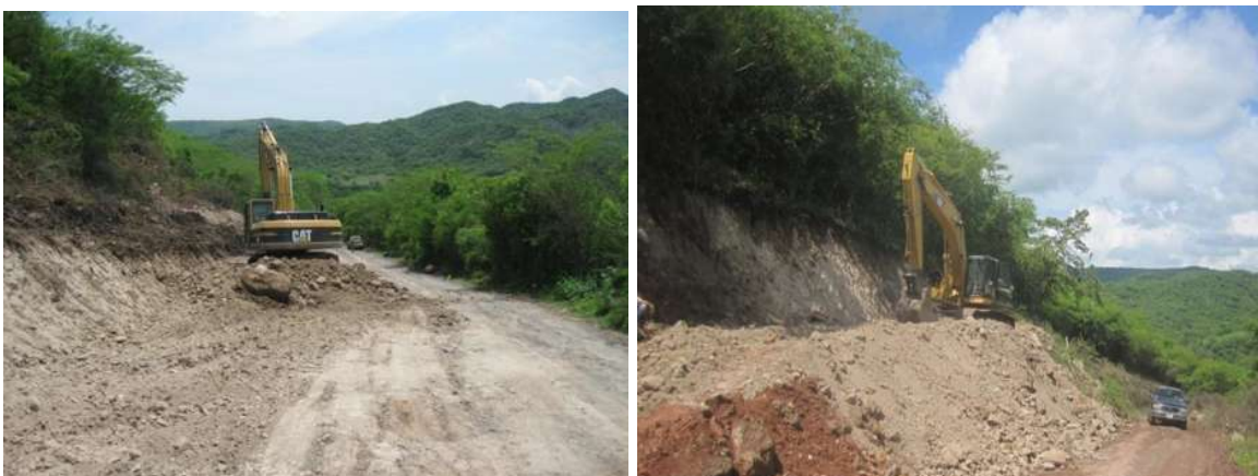
Figura 4.10. Excavación en terraplén.
