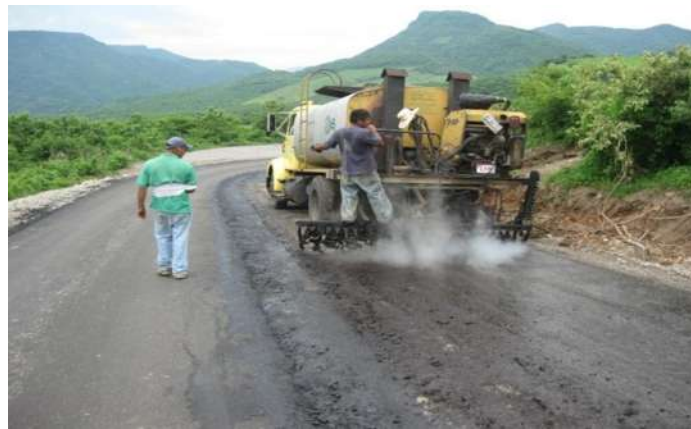
Figura 4.38. Impregnación de la base hidráulica.
