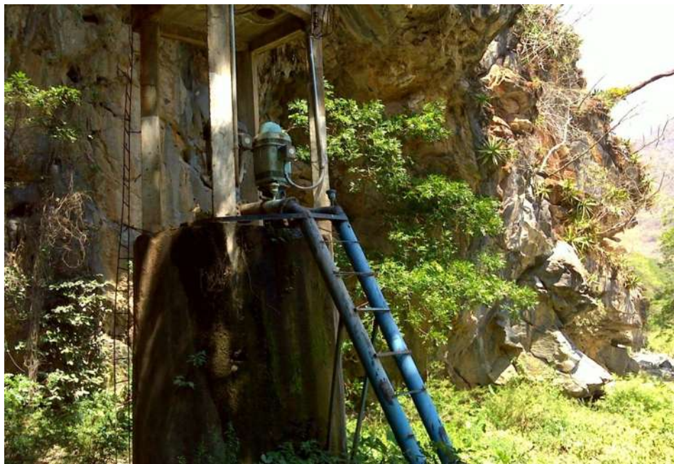
Imagen 15. Cárcamo de bombeo actual.
