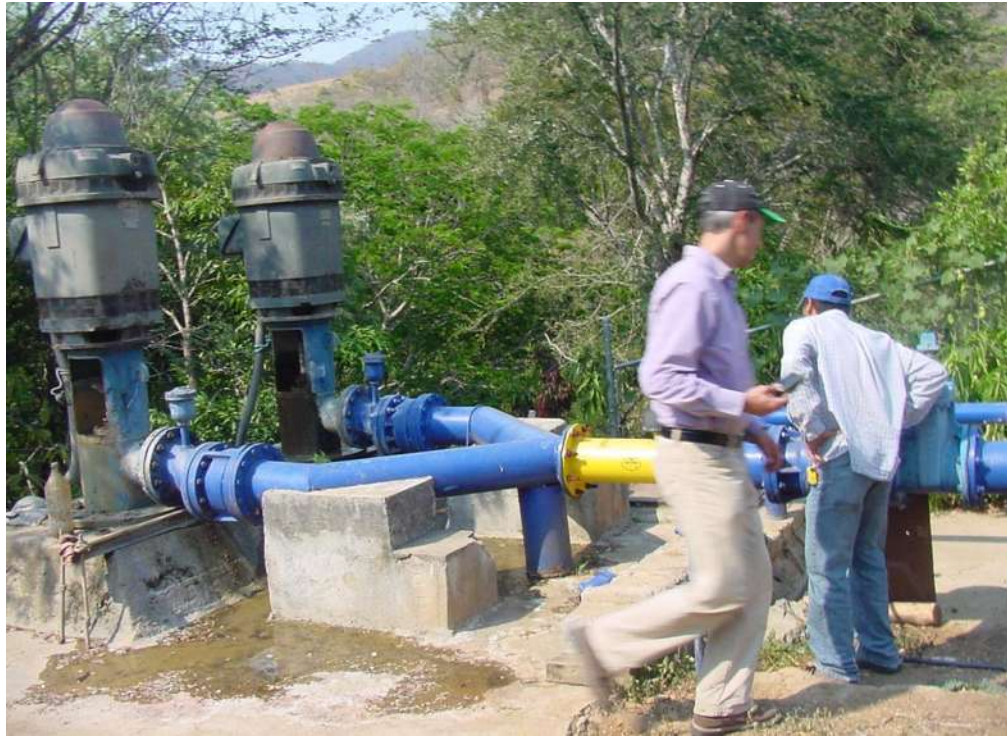
Imagen 9. Cárcamo de rebombeo actual.
