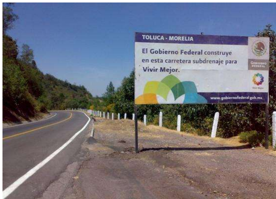
Figura 49. Letrero informativo de obra.
