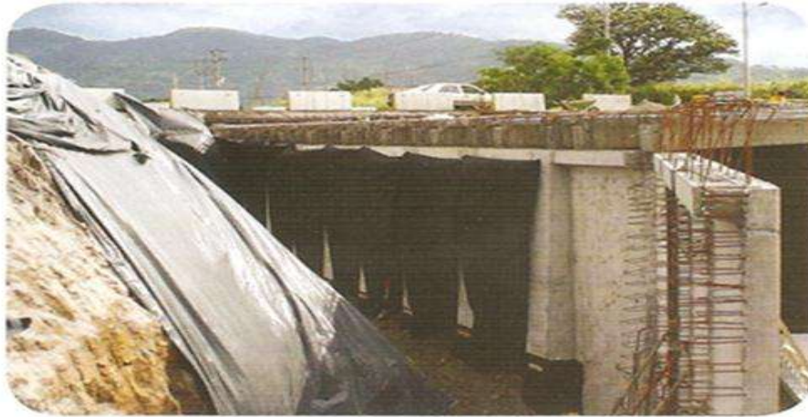
Figura 17. Sótanos y Muros de Contención.
