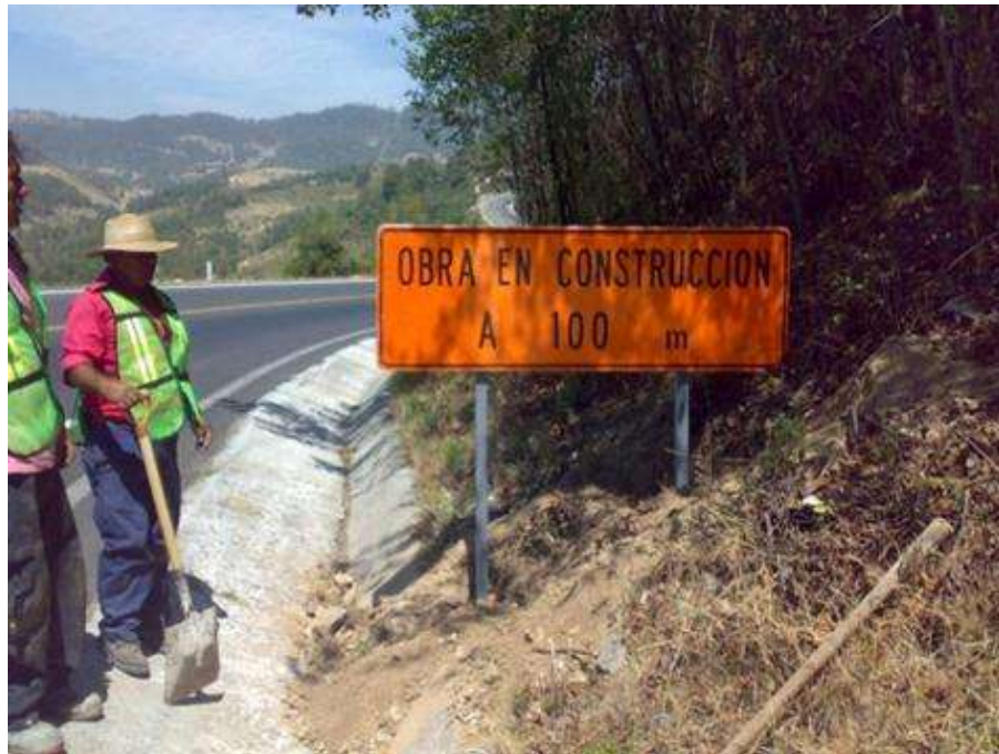
Figura 37. Obra en construcción a 100 m. 56X178.
