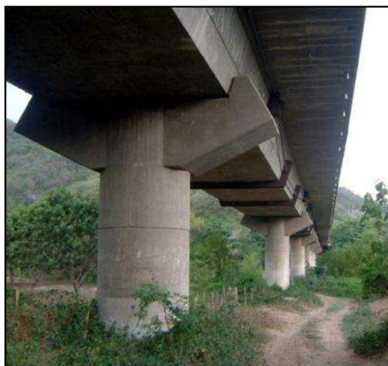
Figura 78.- Puente la Chuta
