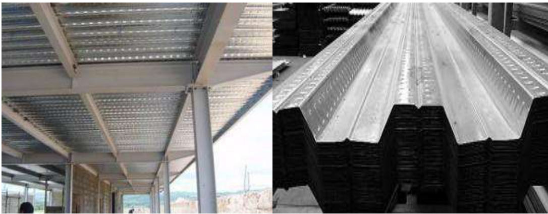
Fig. 3.3.4.c Forma de la losacero en la construcción
