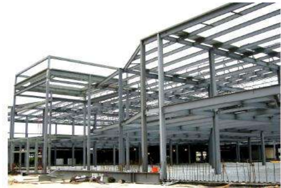
Fig. 2.1.1.b Estructura con marcos no arriostrados
