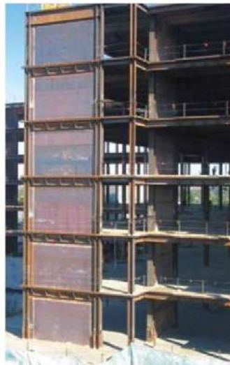
Figura c.1 Muro de corte de placas de acero en construcción.
