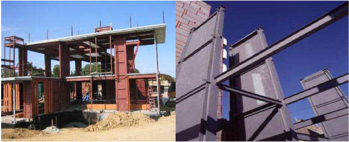
Fig. 2.2.c Edificios con muros de corte de placas de acero en su proceso de construcción.
