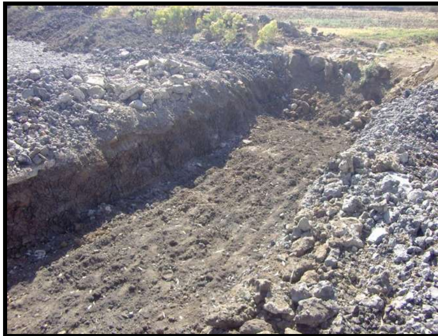
Fig. 3.9 EXCAVACION PARA ESTRUCTURAS EST. 1+840
