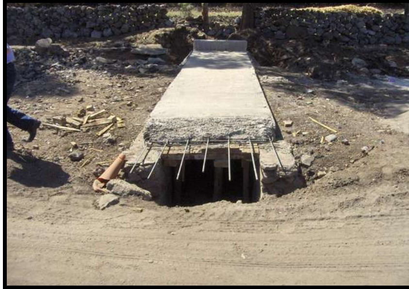
Fig. 3.10 RELLENO EN OBRAS DE DRENAJE EST. 1+174.45
