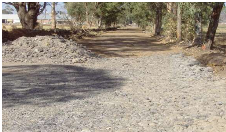
Fig. 3.7 SUMINISTRO DE MATERIAL CAPA SUBRASANTE
