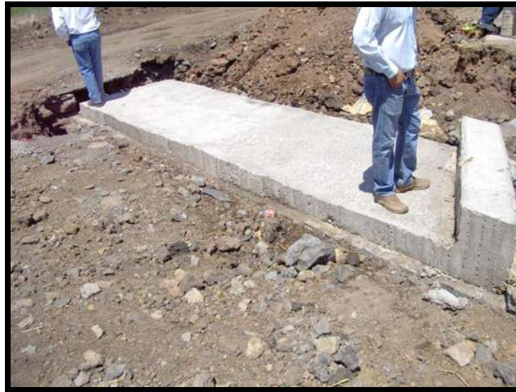
Fig. 3.13 LOSA DE CONCRETO HIDRAULICO
