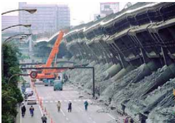
Figura 1.- Colapso de una autopista elevada durante el terremoto de Kobe en 1995 (Fuente: Allianz Knowledge).
