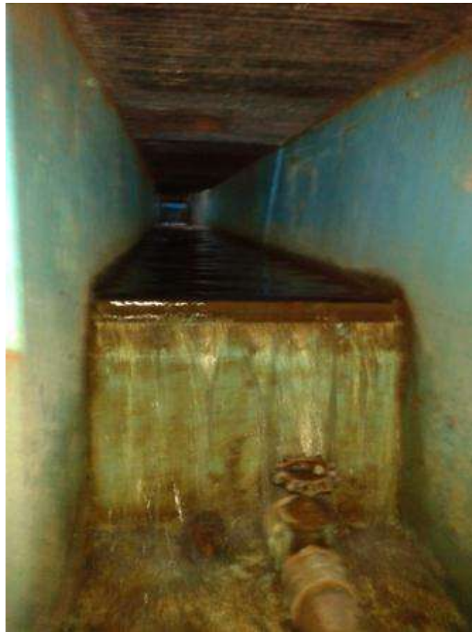
Figura 10. Descarga en el vertedor rectangular y retorno a la cisterna
