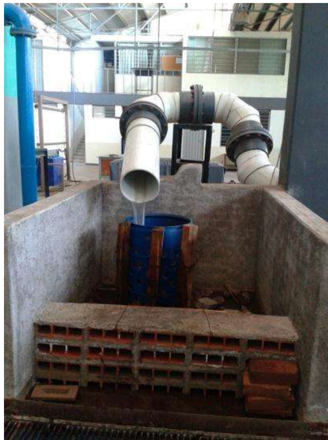
Figura 8. Descarga de la tubería a la estructura amortiguadora
