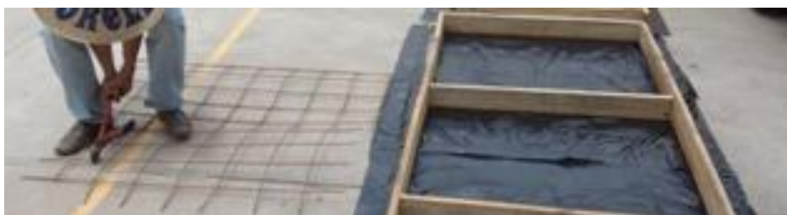
Figura 4.18 Cimbra para losas.
