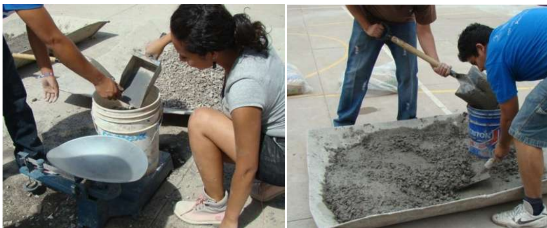
Figura 4.19 Pesado y mezclado de los materiales para elaboración de losas.
