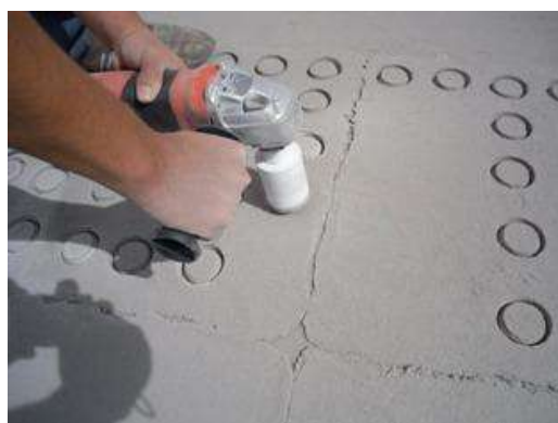
Figura 8.19 Perforación de losas para prueba de adherencia.
