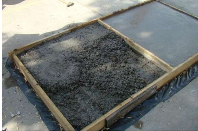
Figura 4.20 Colado y acabo de las losas de adherencia.
