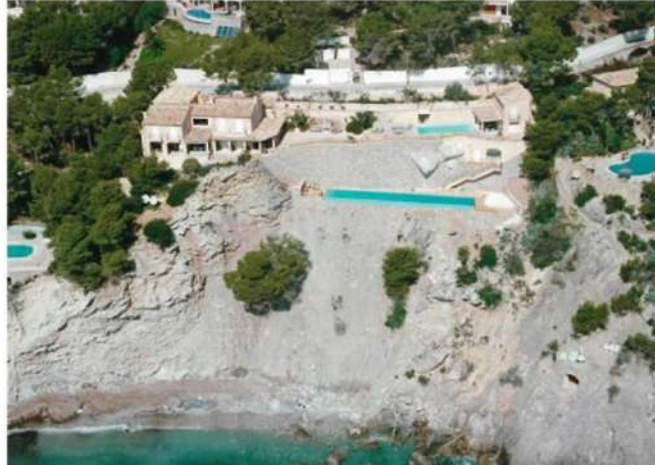
Figura 2.19 Estabilización del Talud.
