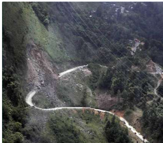
Figura 2.27 Imagen del trazo del camino donde se observa el deslizamiento.
