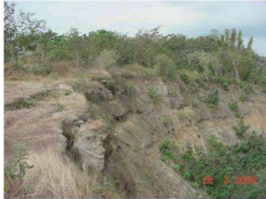
Figura 2.22 Grietas en la parte alta del deslizamiento de las colinas, 25 de febrero de 2003.
