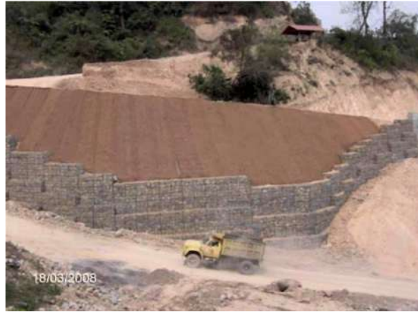
Figura 2.28 Camino con la obra terminada, donde se colocaron gaviones.
