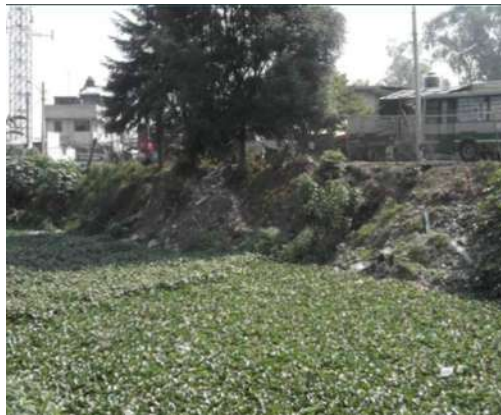
Figura 2.29 Parque Lineal Canal Nacional, antes de la obra.
