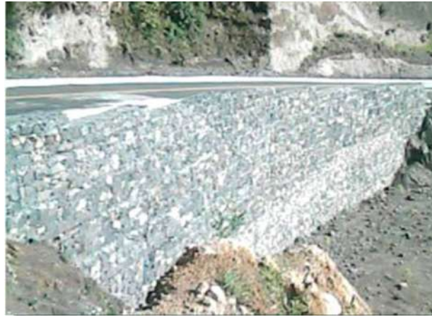
Figura 2.26 Carretera Tetela del Volcán – La espada, obra terminada con gaviones.
