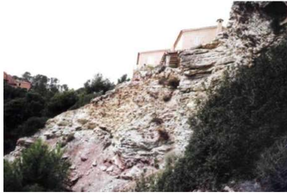
Figura 2.18 Talud y vivienda en estudio.
