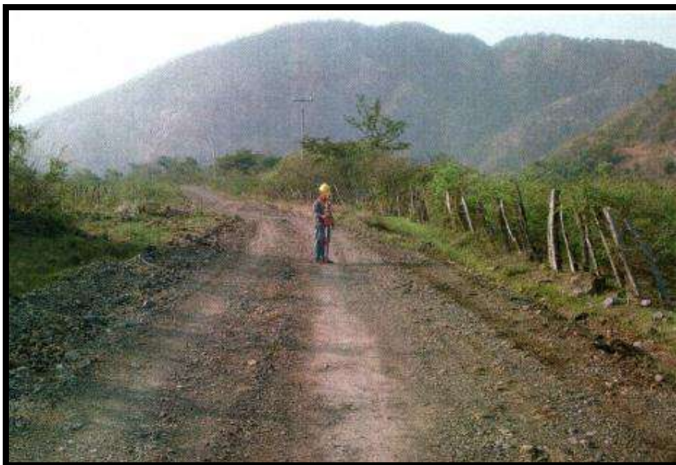
Figura1.3.- Fotografía de la brecha existente y topógrafo visando puntos
