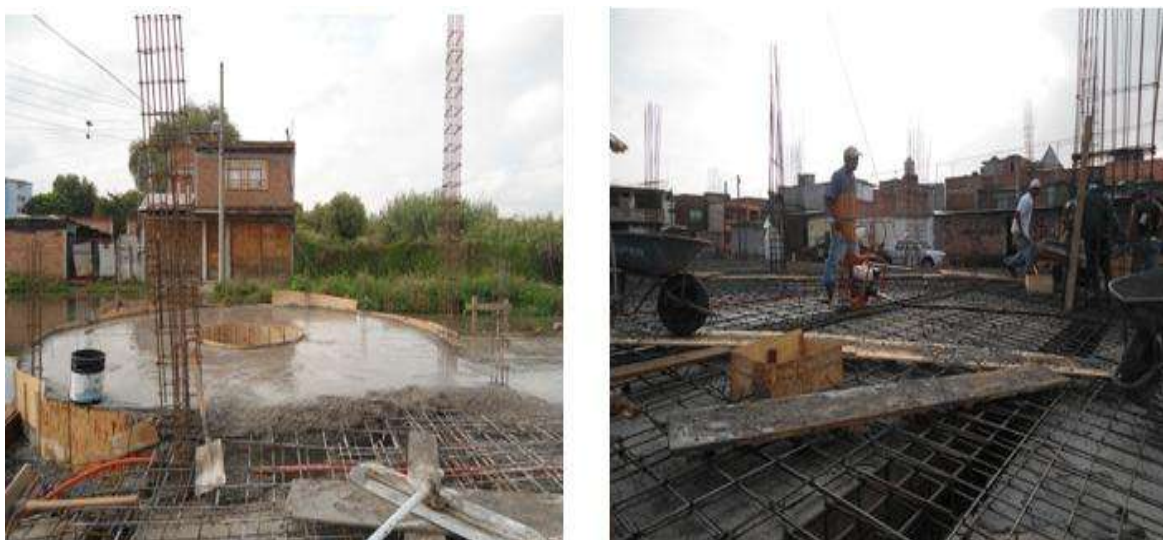
Fig. 8.24 Elaboración y vaciado de concreto para la losa de cimentación, vista 1.
