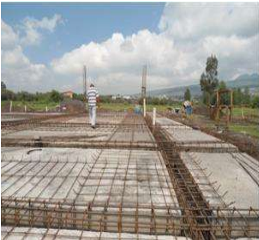
Fig. 8.22 habilitado y armado de acero para contratrabes y losa de cimentación, vista 1.
