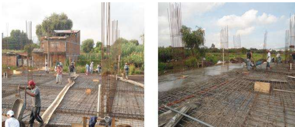
Fig. 8.25 Elaboración y vaciado de concreto para la losa de cimentación, vista 2.
