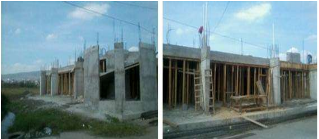
Fig. 8.35 Planta baja terminada.
