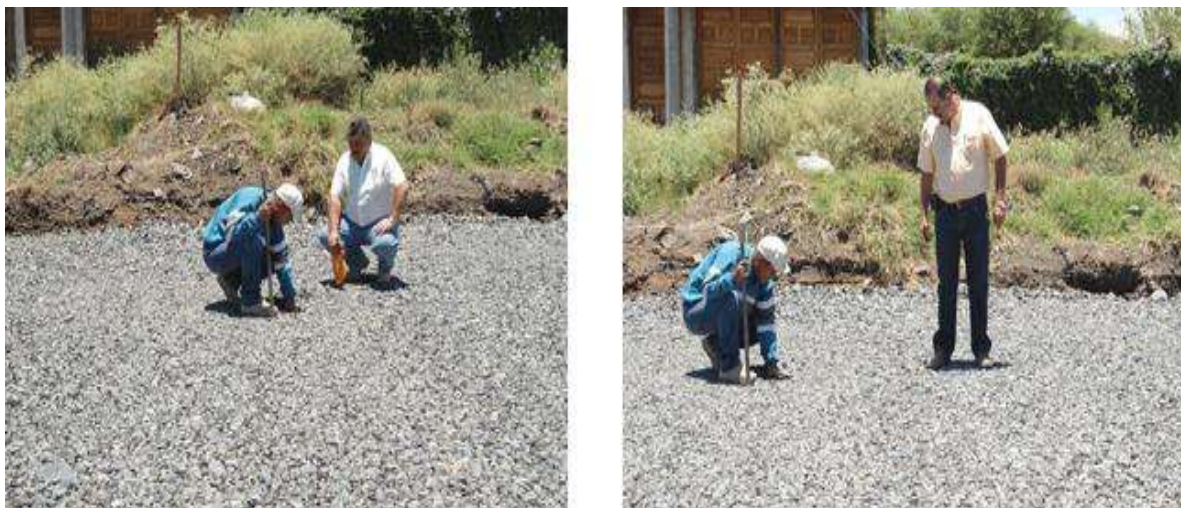
Fig. 8.11 Término de la segunda etapa de filtro y aplicación de la segunda etapa de filtro, vista 1.
