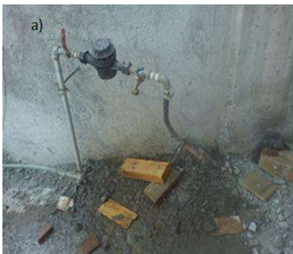
Fig. 4.5a) Toma domiciliaria de agua potable b) Tubería para la instalación hidráulica
