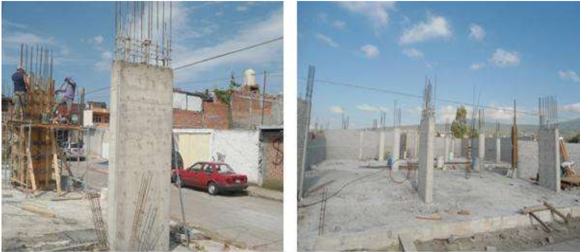
Fig. 8.30 Retiro del cimbrado de columnas y muros de concreto, vista 2.
