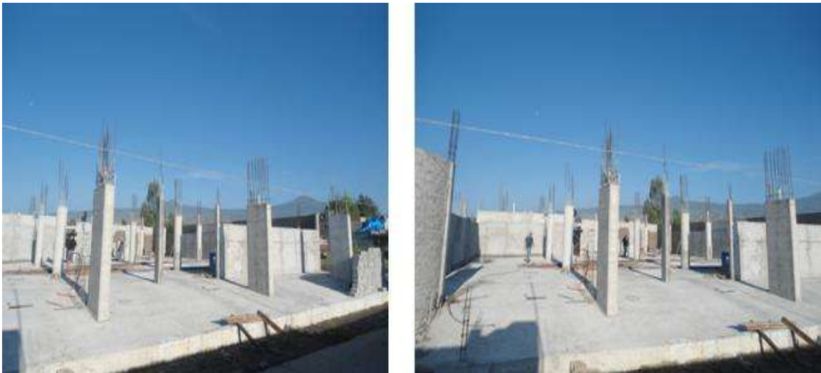
Fig. 8.31 Aplanado interior de los muros, vista 1.
