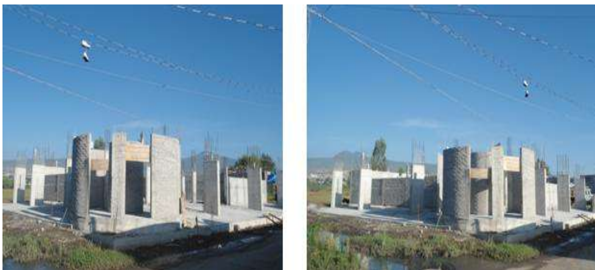
Fig. 8.32 Aplanado interior de los muros, vista 2.
