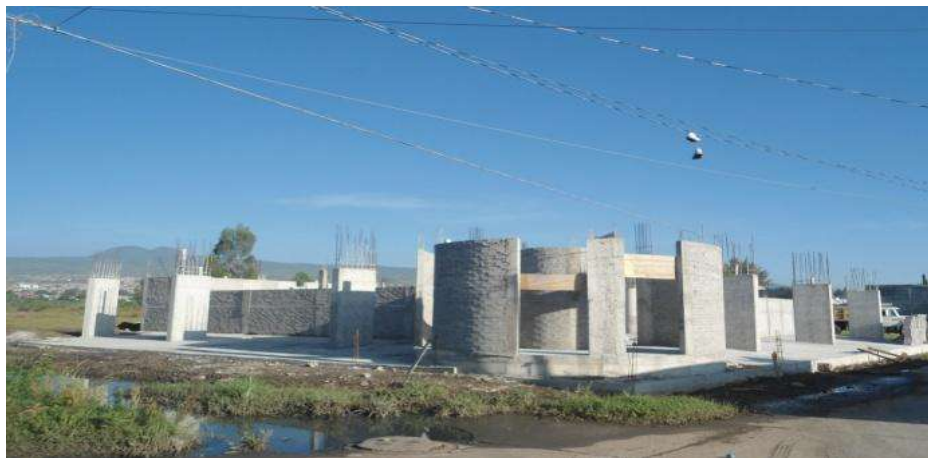
Fig. 5.2 Muros de tabicón.
