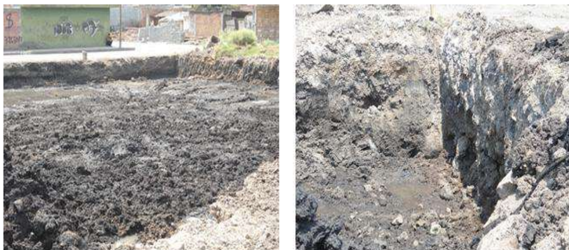
Fig. 8.5 Excavación (dejando expuesto el nivel freático), vista 2.
