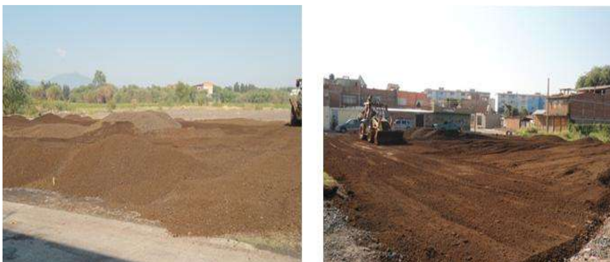
Fig. 8.16 Suministro de material para la subrasante, vista 2.
