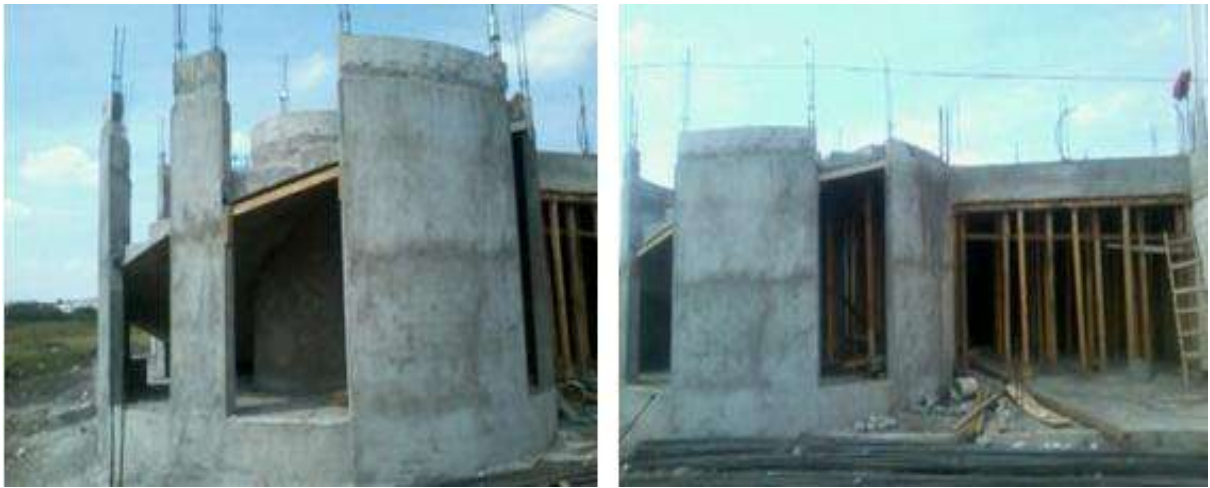
Fig. 8.34 Apuntalamiento y colado de la planta baja.
