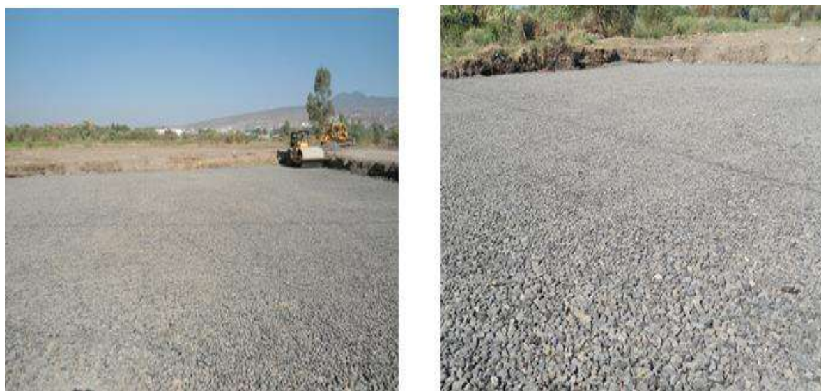
Fig. 8.10 Término de la primera etapa de filtro y aplicación de la segunda etapa de filtro, vista 2.
