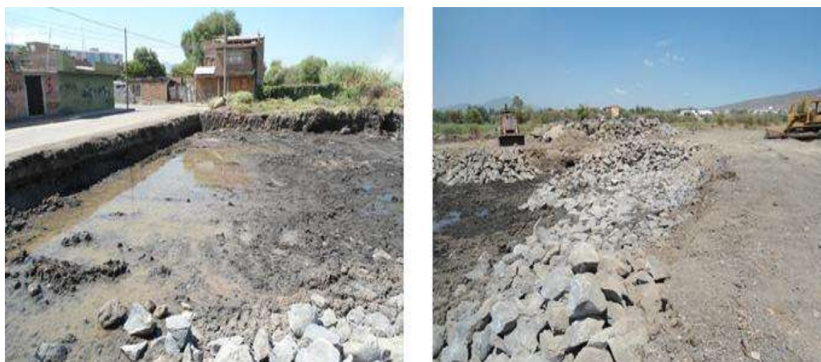
Fig. 8.6 Aplicación de la capa de pedraplén, vista 1.
