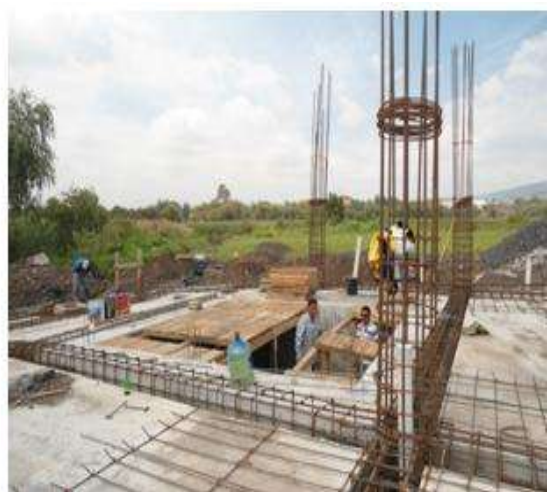
Fig. 8.22 habilitado y armado de acero para contratrabes y losa de cimentación, vista 1.
