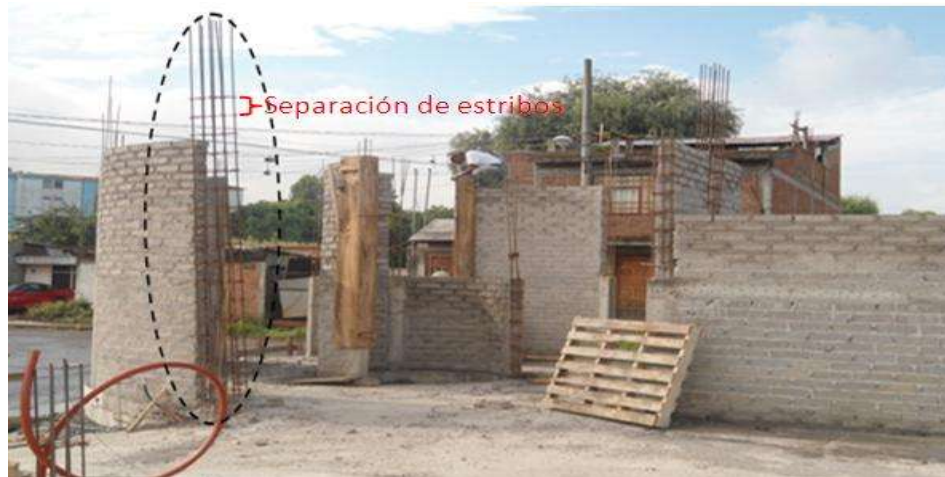
Fig. 5.3 Vista de castillos y separación de estribos.
