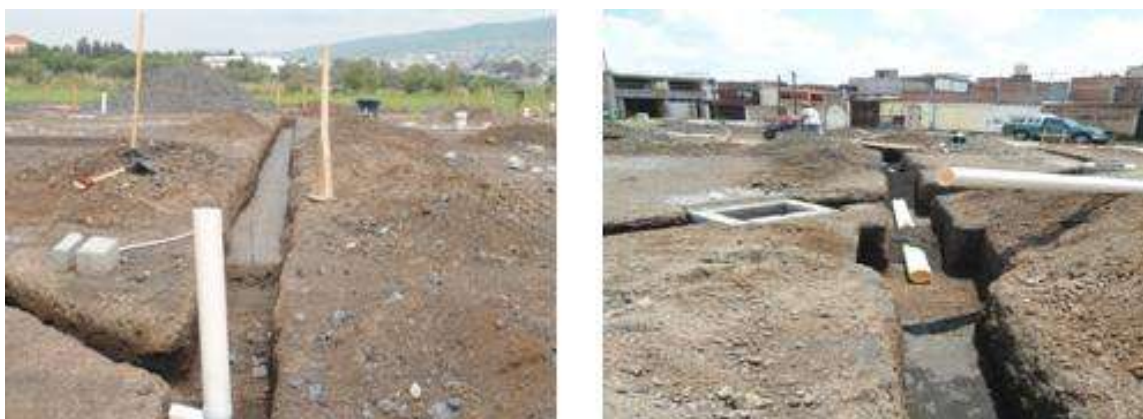
Fig. 4.2 Instalación sanitaria
