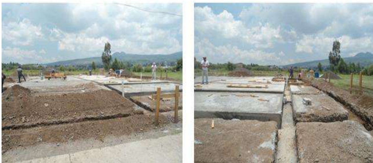
Fig. 8.19 Colocación de tubería para la instalación sanitaria y pluvial, vista 1.
