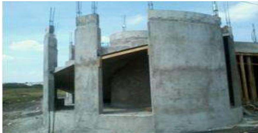
Fig. 5.7 Vista de aplanado realizado en el área de las escaleras
