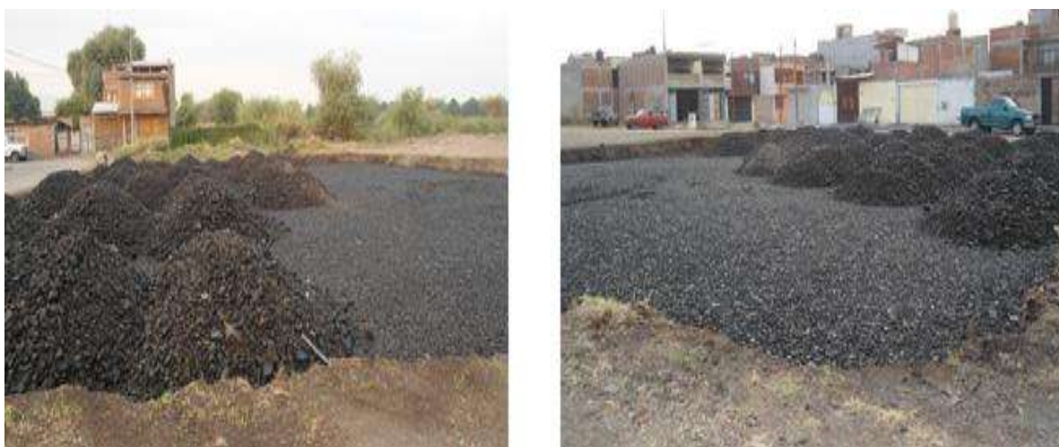
Fig. 8.12 Término de la segunda etapa de filtro y aplicación de la segunda etapa de filtro, vista 2.
