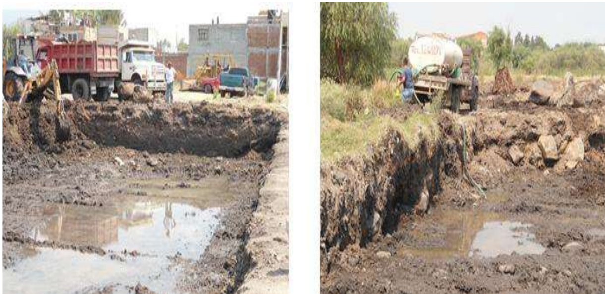
Fig. 8.3 Excavación dejando expuesto el nivel freático, vista 2.
