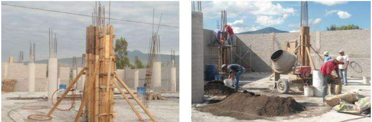
Fig. 8.28 Cimbrado y colado de columnas y muros de concreto, vista 2.
