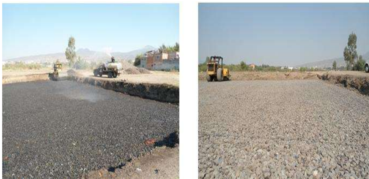
Fig. 8.9 Término de la primera etapa de filtro y aplicación de la segunda etapa de filtro, vista 1.
