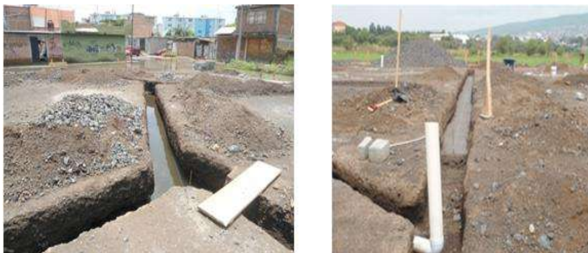
Fig. 8.20 Colocación de tubería para la instalación sanitaria y pluvial, vista 2.
