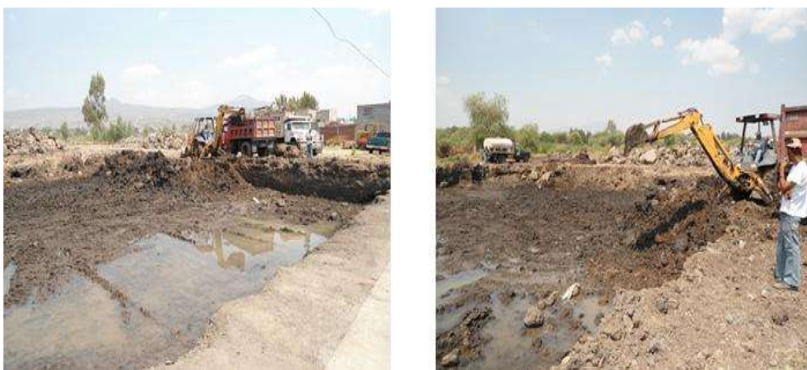
Fig. 8.2 Excavación dejando expuesto el nivel freático, vista 1.
