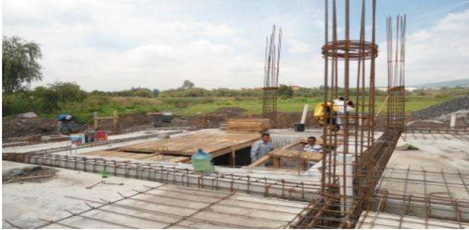
Fig. 5.5 Armado columnas con sección circular.
