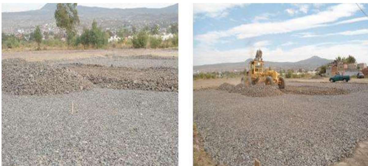
Fig. 8.14 Finalización de tendido de filtro.
