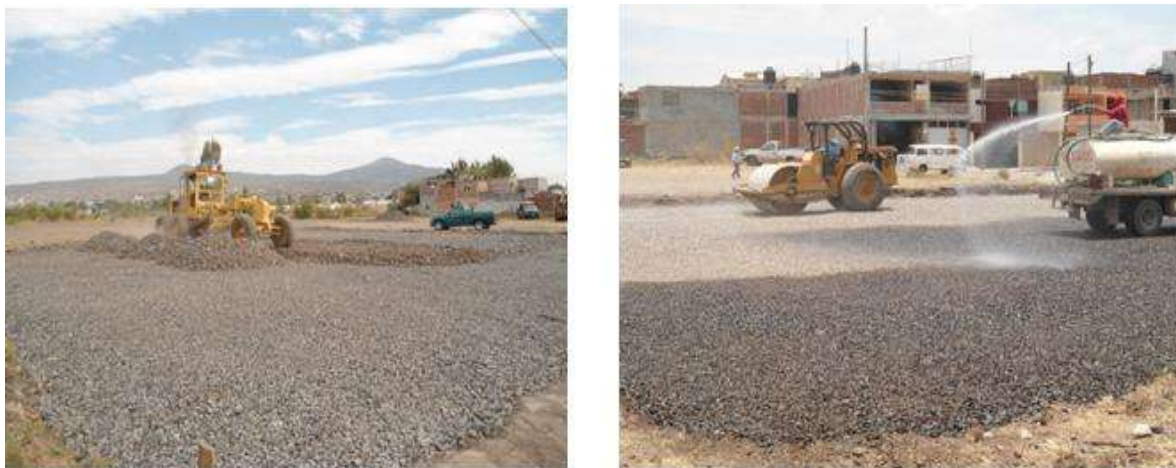
Fig. 8.13 Término de la segunda etapa de filtro y aplicación de la tercera etapa de filtro
