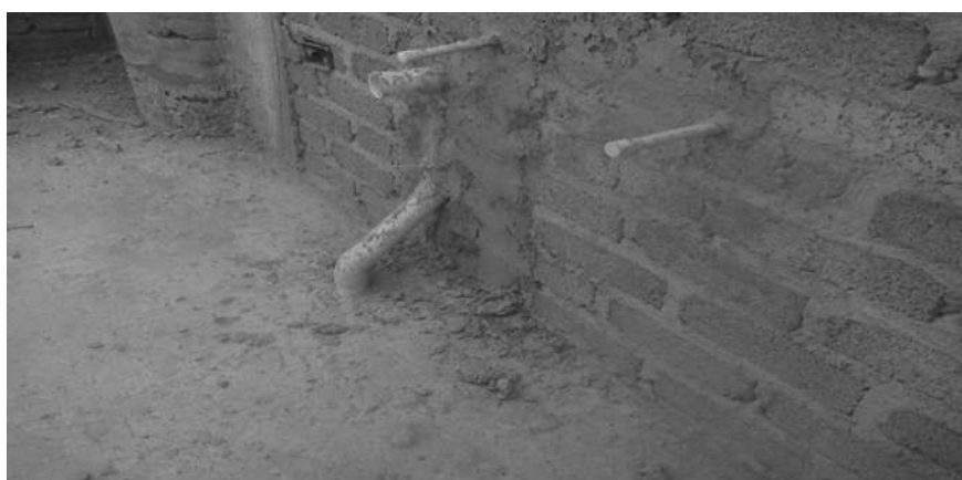
Fig. 4.3 Tubería de la instalación sanitaria dentro de la edificación.
