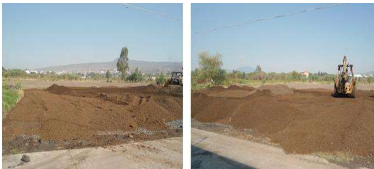
Fig. 8.15 Suministro de material para la subrasante, vista 1.
