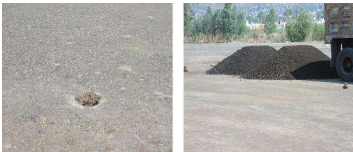
Fig. 8.17 Compactación de la subrasante y suministro de material para la plataforma
