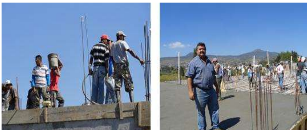
Fig. 8.33 Colado de la planta baja.
