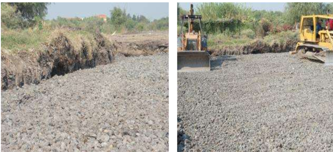
Fig. 8.8 Tendido del filtro.
