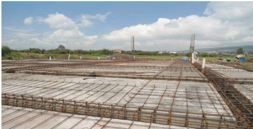
Fig. 5.1 Losa de cimentación.
