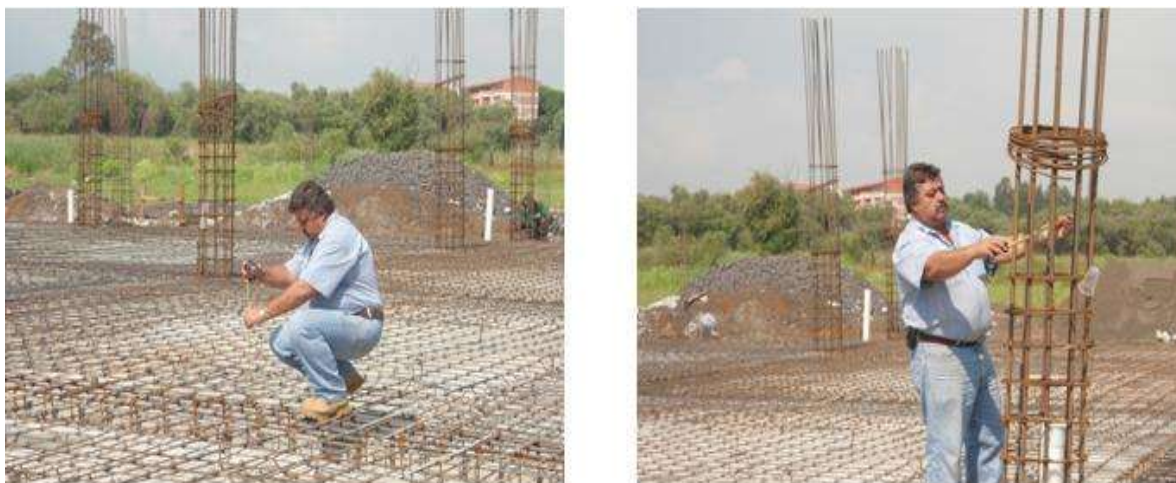
Fig. 8.23 habilitado y armado de acero para contratraves y losa de cimentación, vista 2.
