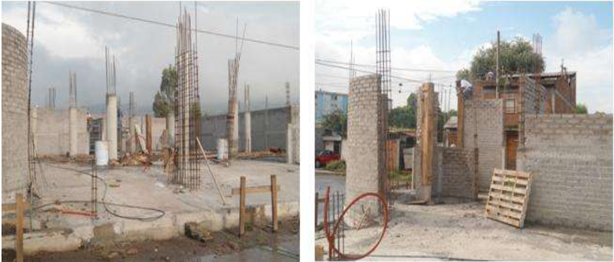
Fig. 8.26 Levantamiento de muros de tabicón.
