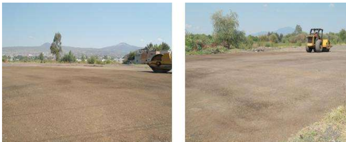
Fig. 8.18 Compactación de la plataforma
