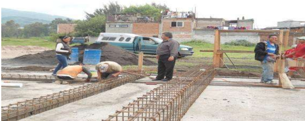
Fig. 5.4 Armado de traveses y contraveses.
