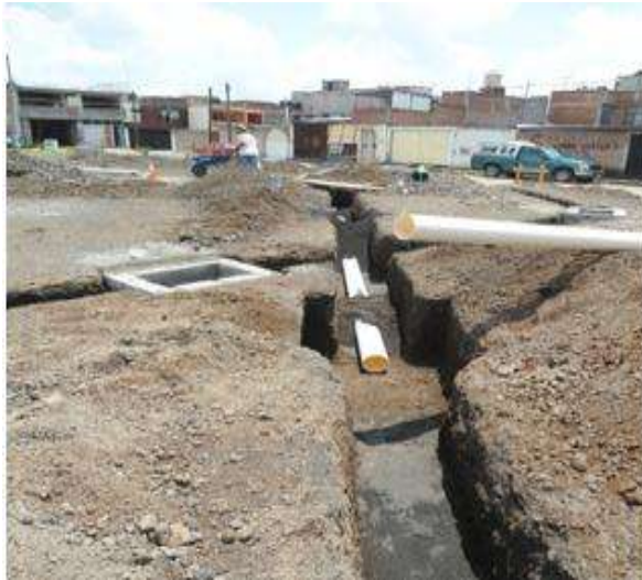
Fig. 8.21 Colocación de tubería para la instalación sanitaria y pluvial, vista 3.
