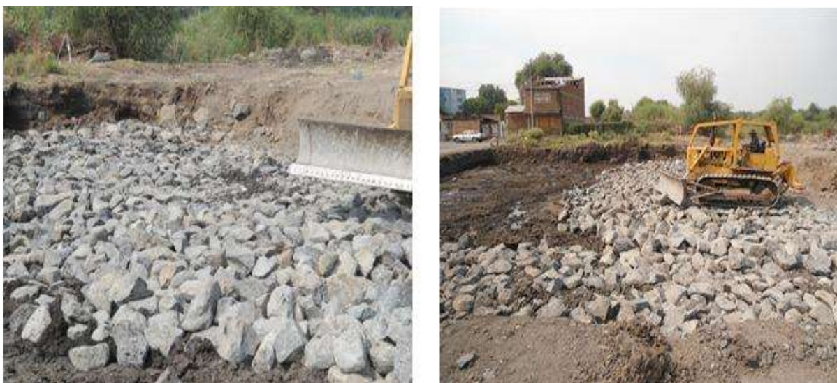
Fig. 8.7 Aplicación de la capa de pedraplén, vista 2.
