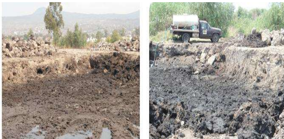
Fig. 8.4 Excavación (dejando expuesto el nivel freático), vista 1.
