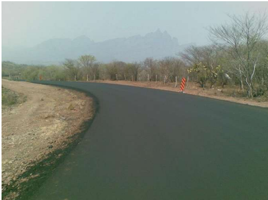
Imagen 21. Terminación de la carpeta asfáltica.
