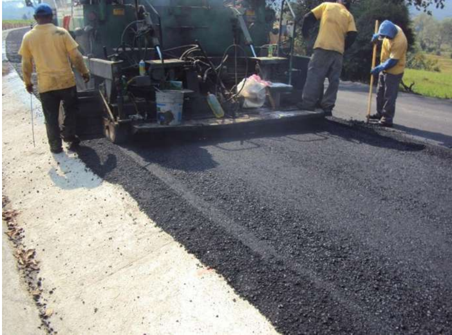
Imagen 14. Realizando tendido con el equipo.
