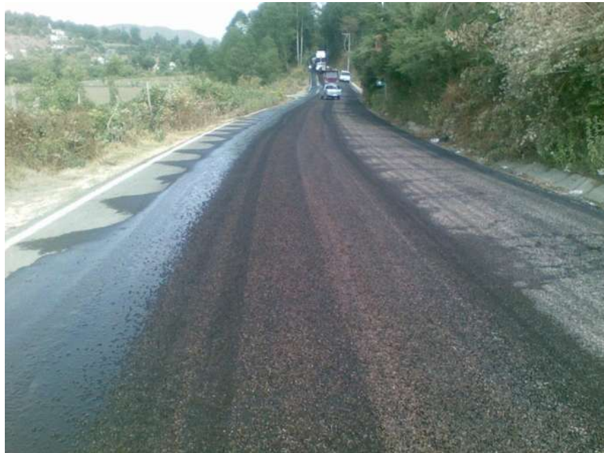
Imagen 19. Textura de la superficie del riego de sello.
