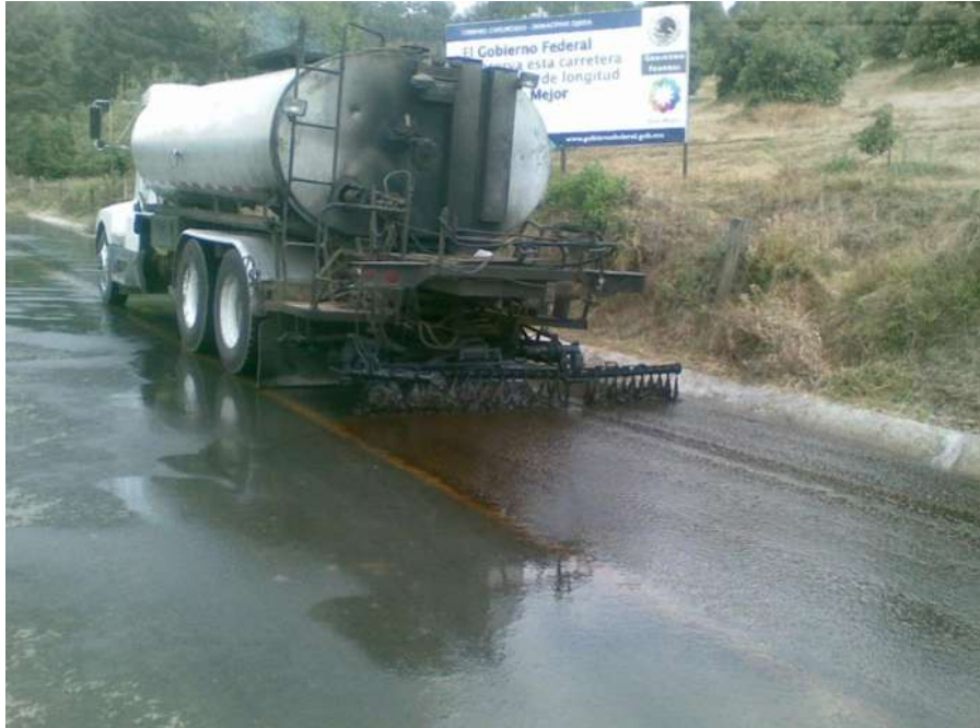
Imagen 16. Aplicación de emulsión para riego de sello.
