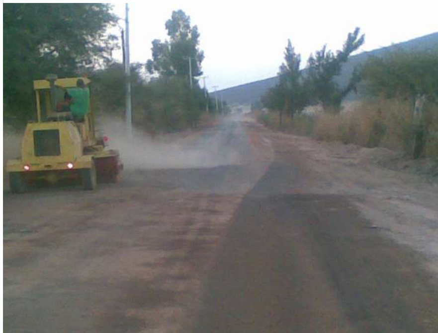
Imagen 05. Limpieza de arena a orilla del camino.
