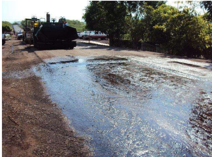
Imagen 24. Riego de liga con emulsión R.M. para alojar la carpeta asfáltica previo poreo.
