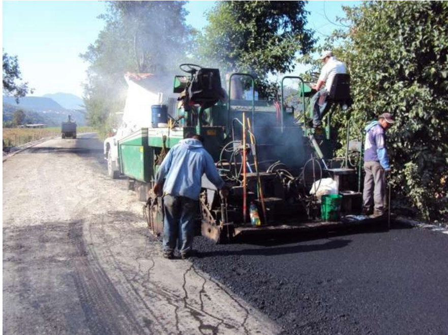
Imagen 12. Tendido de la carpeta asfáltica.
