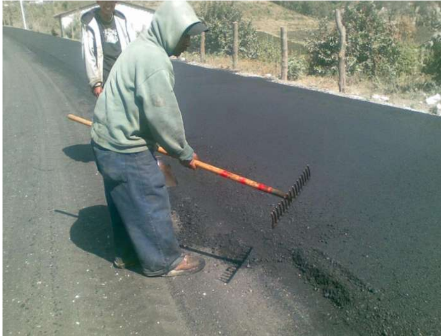
Imagen 10. Limpieza de corte para el segundo tendido.
