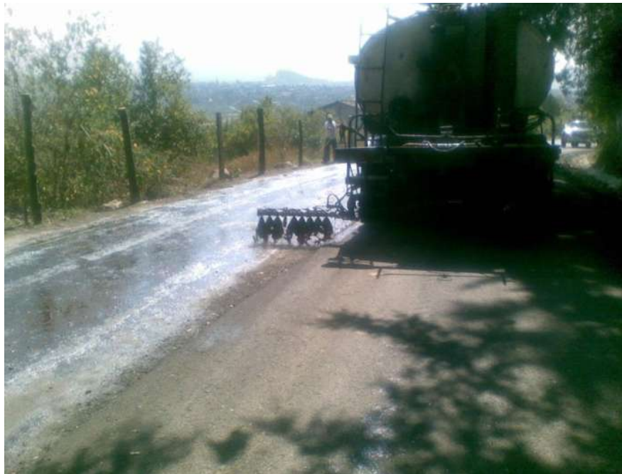
Imagen 07. Aplicación de riego de liga.
