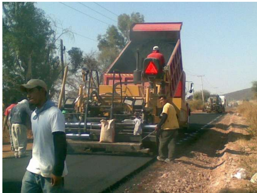
Imagen 09. Tendido de carpeta asfáltica.
