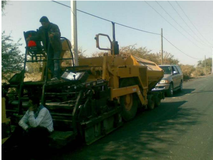
Imagen 02. Equipo de tendido Finisher.
