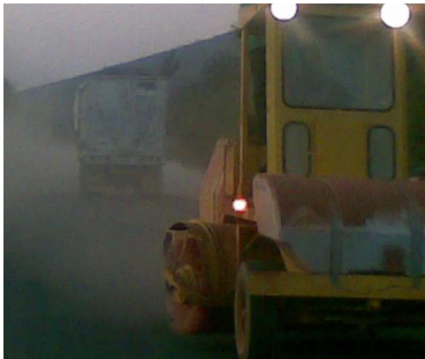
Imagen 03. Barrido de la superficie impregnada.
