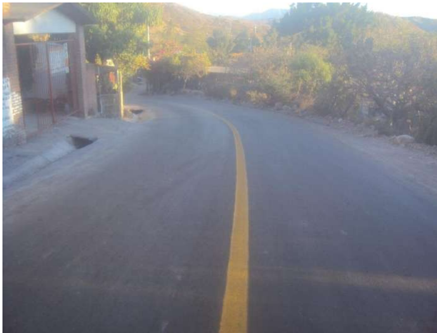
Imagen 15. Acabado de la superficie de la carpeta asfáltica.
