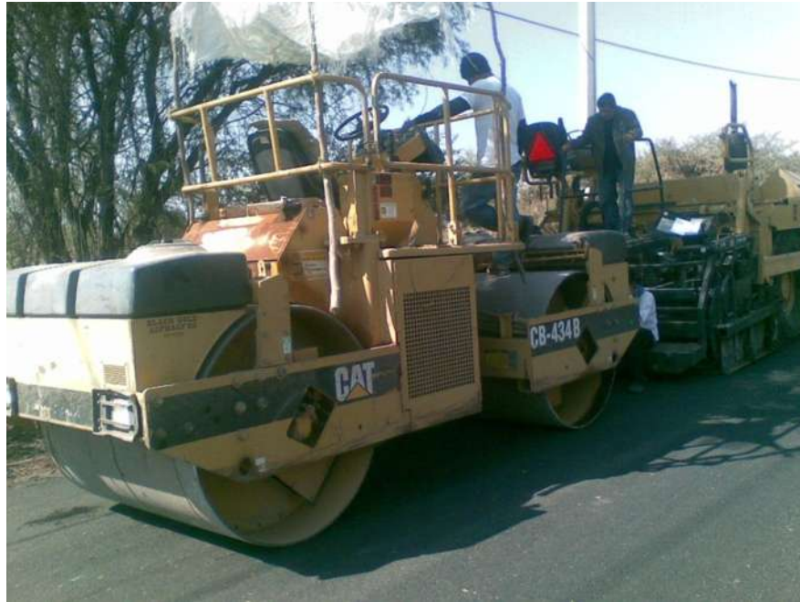
Imagen 01. Equipo de compactación.
