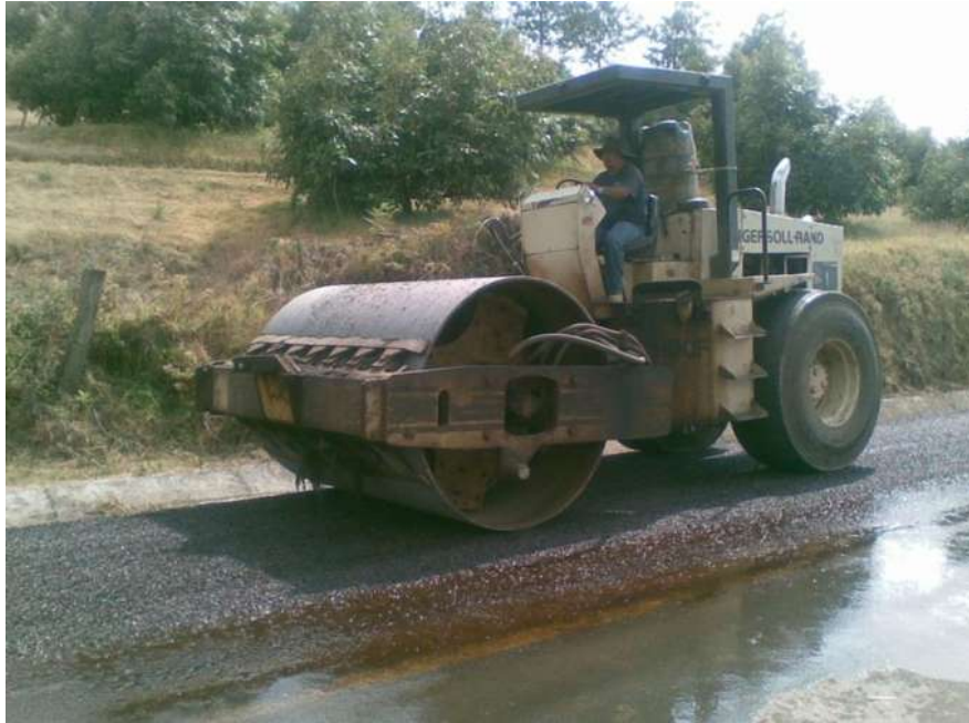
Imagen 18. Compactación del riego de sello.
