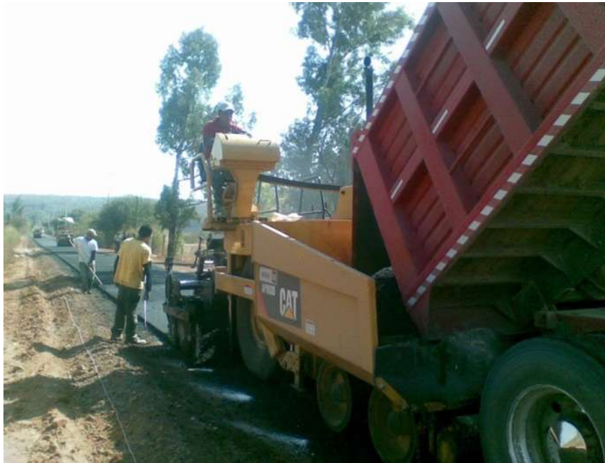
Imagen 08. Vaciado de mezcla asfáltica a equipo de tendido.
