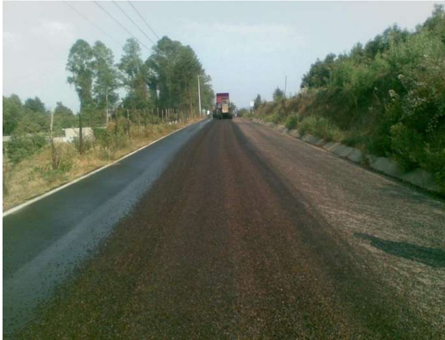
Imagen 20. Acabado del riego de sello.
