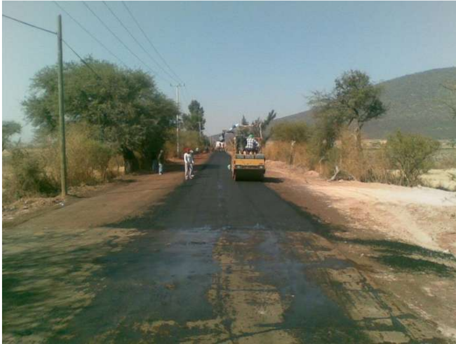
Imagen 06. Compactación de la carpeta asfáltica.
