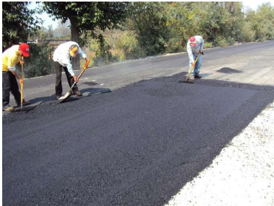
Imagen 13. Acabado de la superficie.
