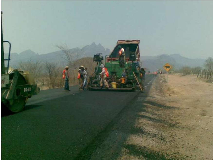
Imagen 22. Tendido de carpeta asfáltica.
