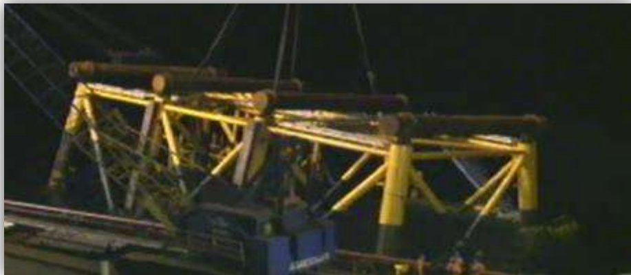
FIGURA 2.10. SISTEMA DE FLOTACIÓN
