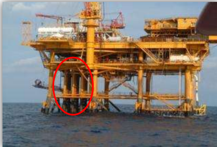
FIGURA 2.23. PLATAFORMA DE PERFORACIÓN CONDUCTORES DE TUBOS DE PERFORACIÓN
