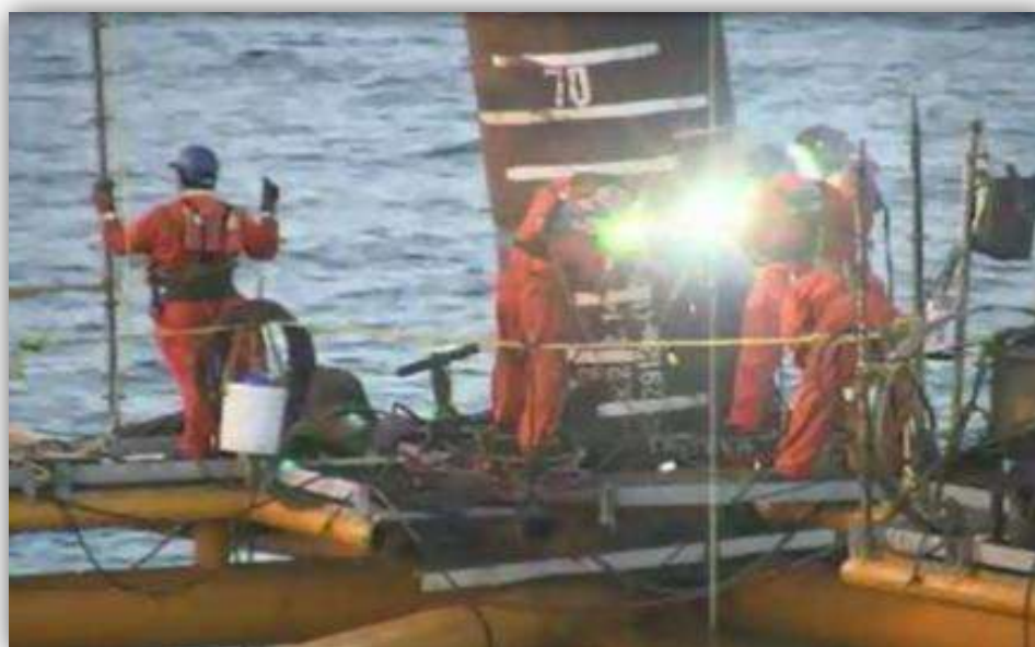
FIGURA 2.28. SOLDADURA DE SECCIONES DE PILOTE PARA HACER UNA SOLA PIEZA BAJO NORMAS Y SUPERVISIÓN DE CALIDAD.
