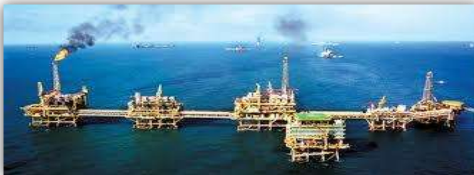
Figura 1.4. Plataforma de enlace.
