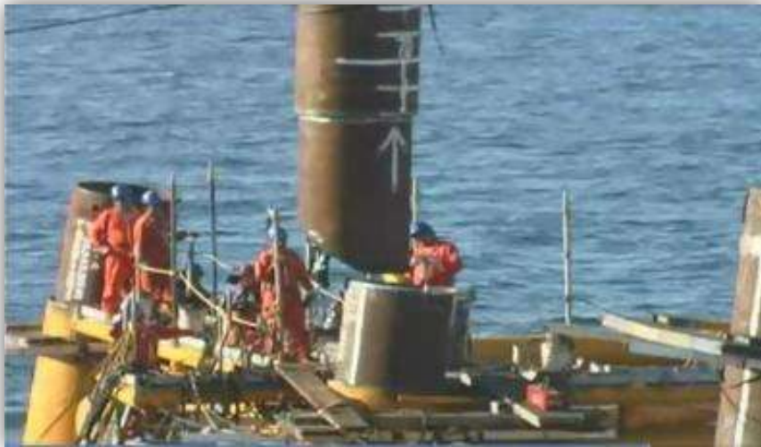
FIGURA 2.26. UNIÓN DE DOS PIEZAS DE QUE CONFORMAN EL PILOTE DIFERENCIA DE DIÁMETROS PARA EL ENSAMBLE.
