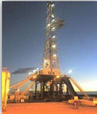
Figura 2.5. Torre de perforación
