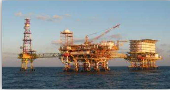
Figura 1.6. Plataforma de Rebombero.
