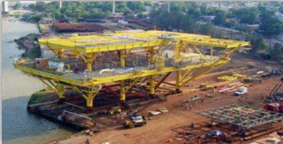
FIGURA 2.2. CUBIERTAS DE LA SUPERESTRUCTURA EN PATIO DE CONSTRUCCIÓN.
