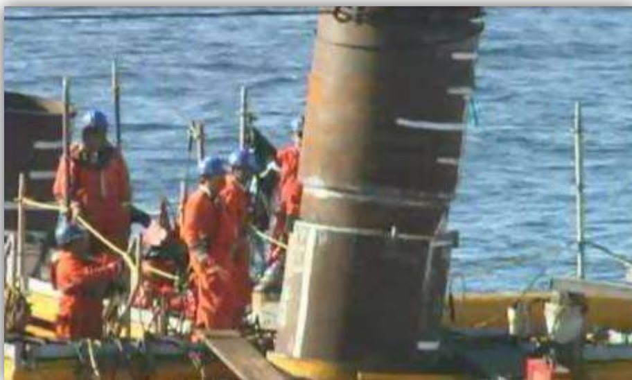
FIGURA 2.27. JUNTA DE DOS SECCIONES DEL PILOTE.
