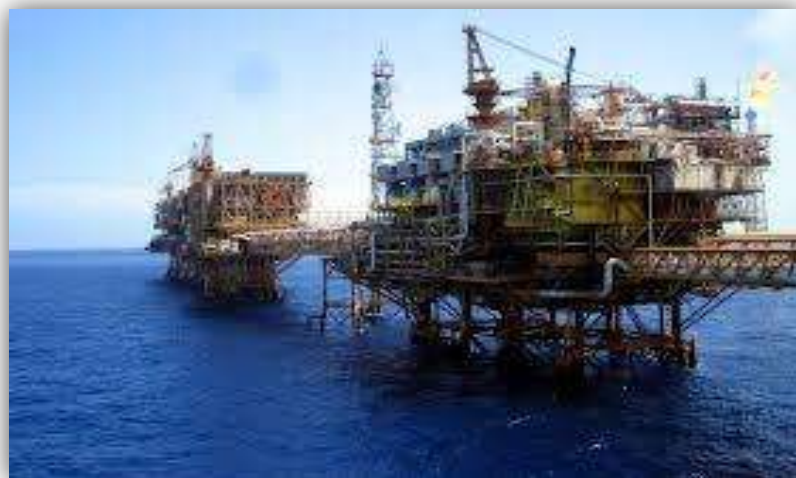
Figura 1.8. Plataforma de compresión de gas.
