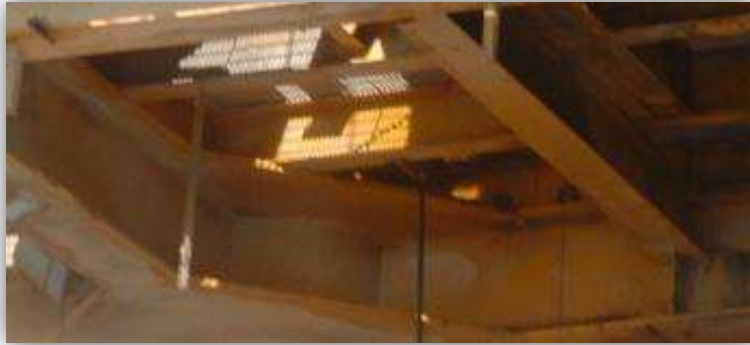
FIGURA 2.4. CONVERGENCIA DE TRABES ACARTELADAS
