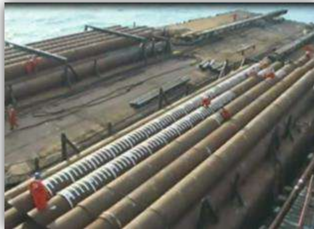
FIGURA 2.24. PIEZAS PARA ENSAMBLADO DE PILOTES.
