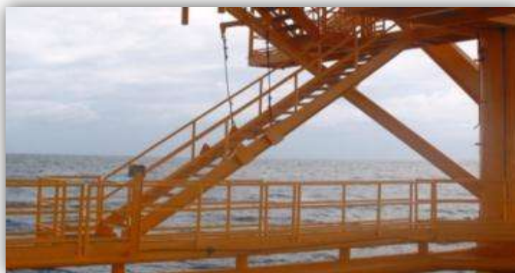
FIGURA 2.20. ESCALERA DE RAMPA Y BARANDALES
