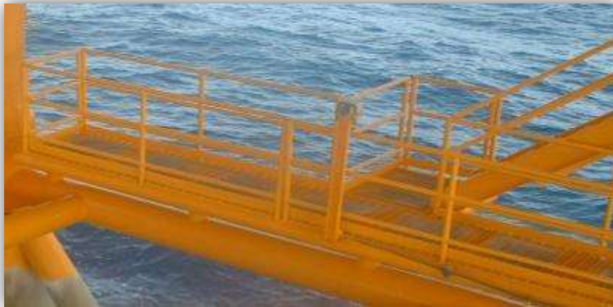
FIGURA 2.19. PASILLO DE ACCESO Y BARANDALES
