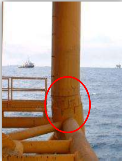
FIGURA 2.6. UNIÓN DE LA SUPERESTRUCTURA CON EL JACKET.
