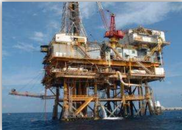
FIGURA 2.3. SUPERESTRUCTURA CON PAQUETE DE PERFORACIÓN
