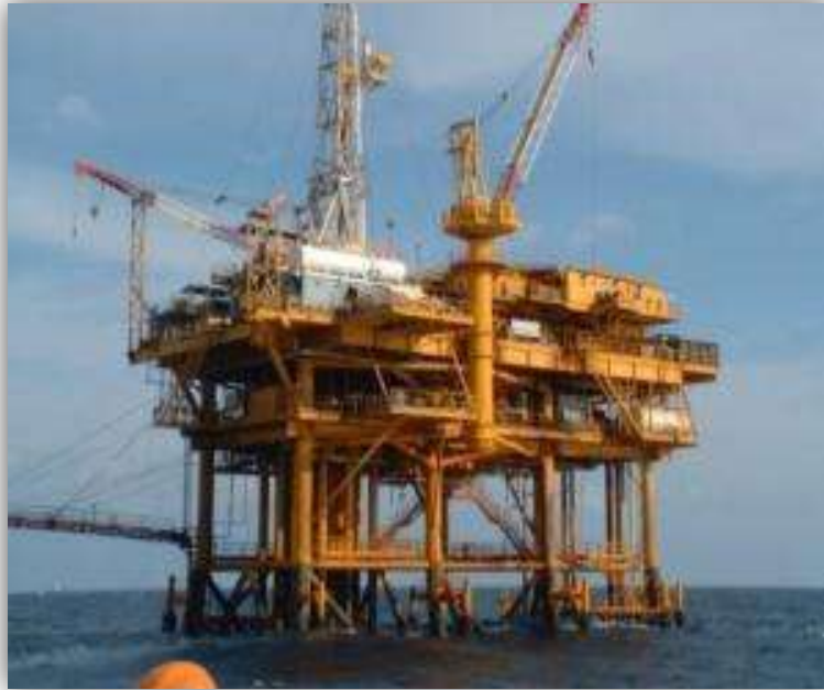
Figura 1.2. Plataforma de perforación.
