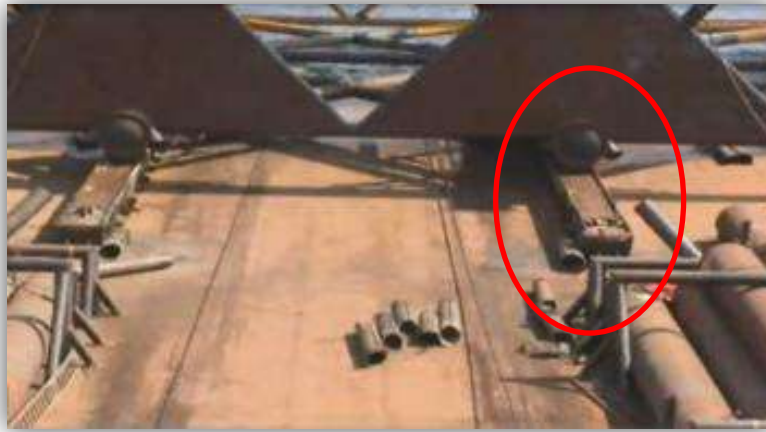
FIGURA 2.8. SISTEMA DE DESLIZAMIENTO DURANTE EL LANZAMIENTO DE LA SUBESTRUCTURA
