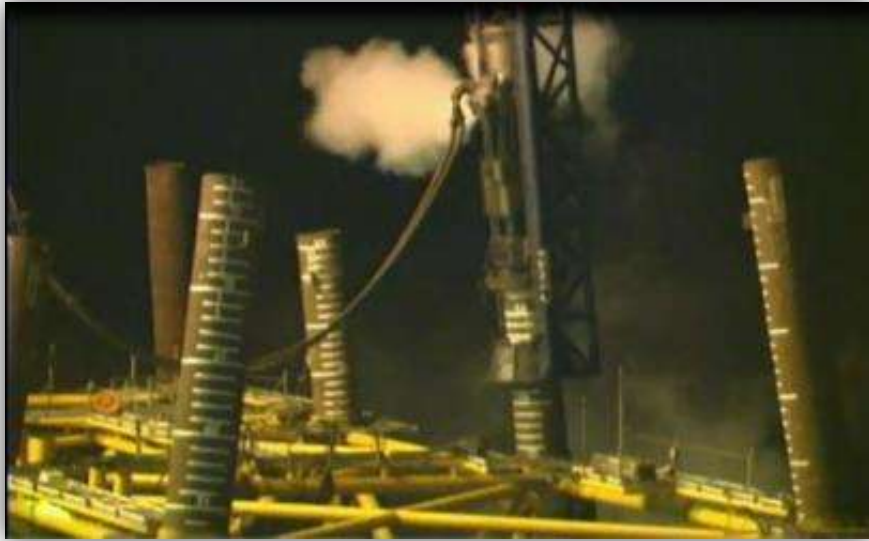
FIGURA 2.25. INTRODUCCIÓN DE PILOTES POR MEDIO DE GOLPES DEL MARTILLO HIDRÁULICO
