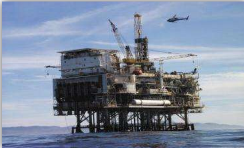
Figura1.9. Plataforma de inyección de agua.
