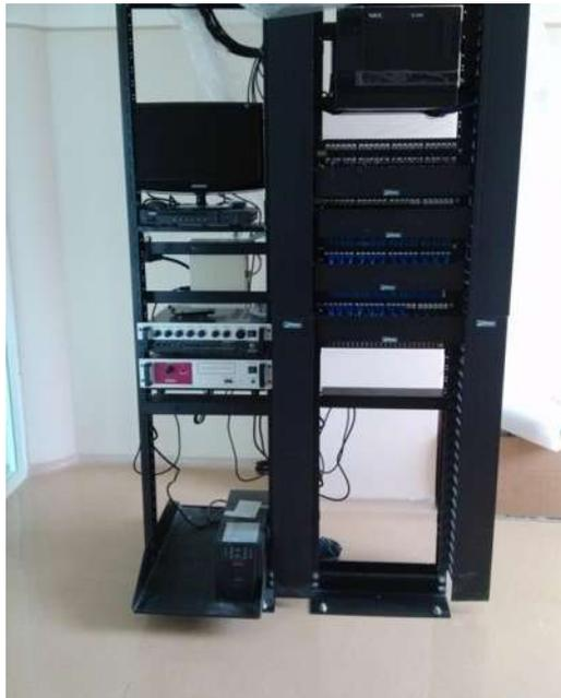
Figura 6.1.A.- Racks Instalados con Organizadores Horizontales y Verticales.
