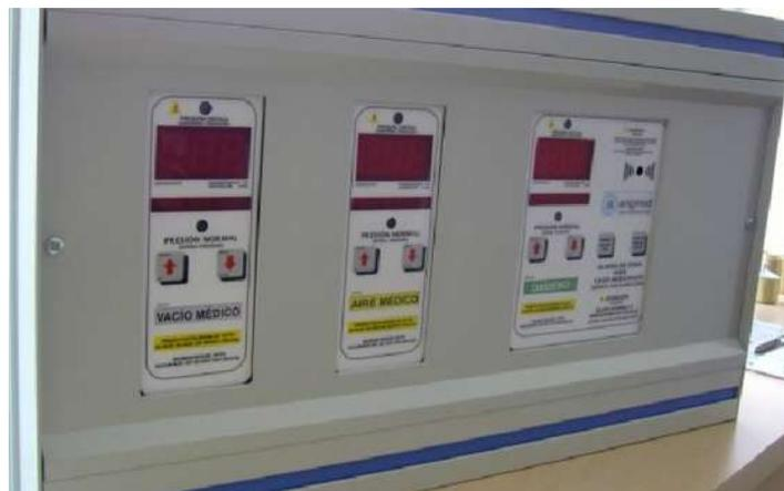
Figura 3.3.3.5.A.- Modulo de Alarma, para Gases Medicinales.
