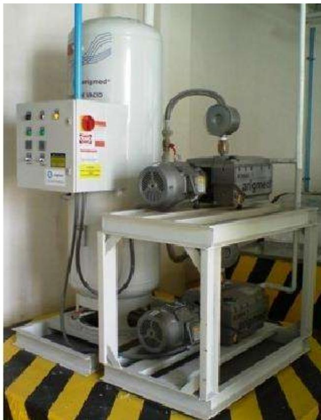
Figura 3.3.1.B.- Bomba de Vacío Grado Medico Doble de 7.5 hp., Libre de Aceite.
