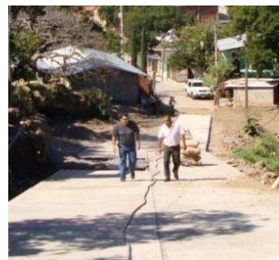
Ilustración XI-11. Colocación de concreto. Foto: Dirección de Desarrollo Social, Taretan.
