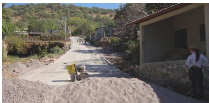
Ilustración XI-16. Corte de pavimento y guarniciones. Foto: Dirección de Desarrollo Social, Taretan.
