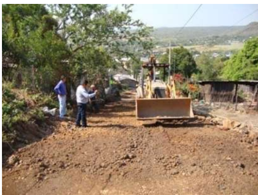
Ilustración XI-8. Conformación de la sub-base. Foto: Dirección de Desarrollo Social, Taretan.
