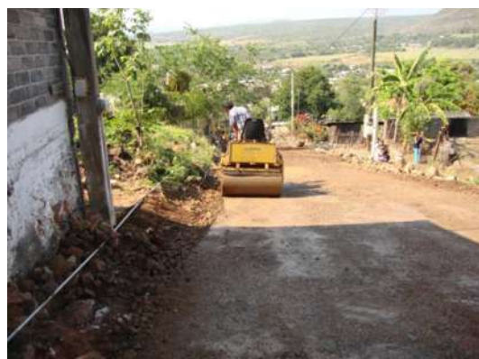
Ilustración XI-7. Compactación de la sub-base. Foto: Dirección de Desarrollo Social, Taretan.
