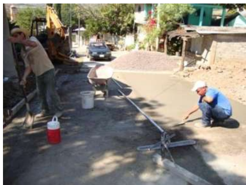
Ilustración XI-10. Colocación de concreto. Foto: Dirección de Desarrollo Social, Taretan.
