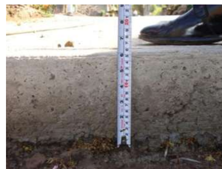
Ilustración XI-12. Espesor de pavimento. Foto: Dirección de Desarrollo Social, Taretan.
