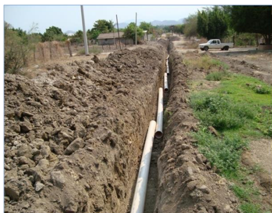
Ilustración I-2. Línea de conducción agua potable, El Letrero, Mpio. de Múgica. Foto FBE
