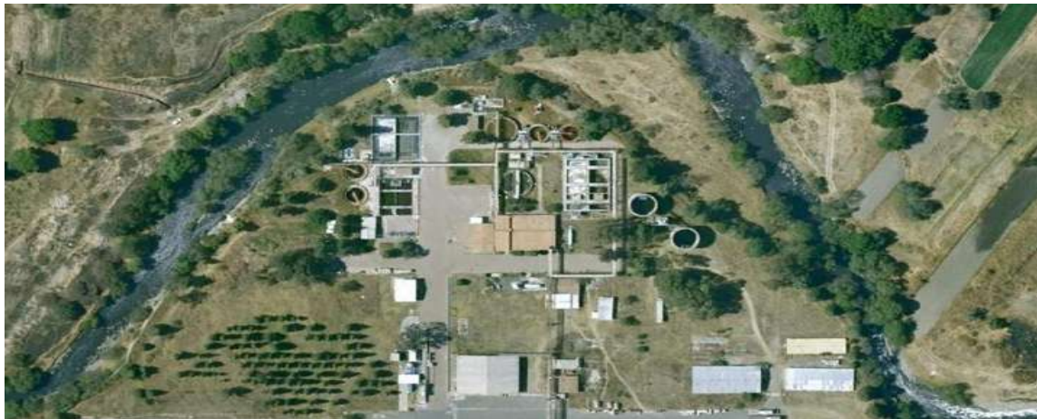
Planta de tratamiento de aguas residuales denominada Barranca del conde en la ciudad de Puebla, Puebla
