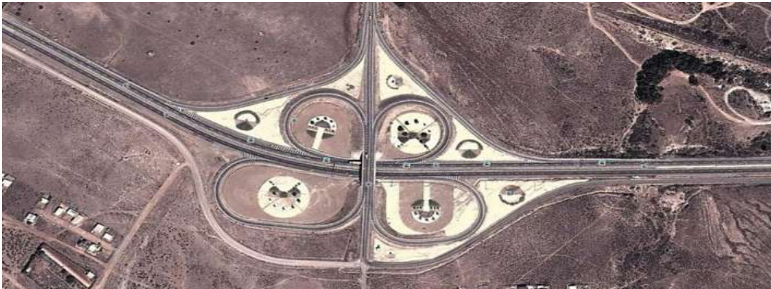
Enlace Acceso Norte-Pichidangui, carretera Santiago los Vilos en la republica de Chile
