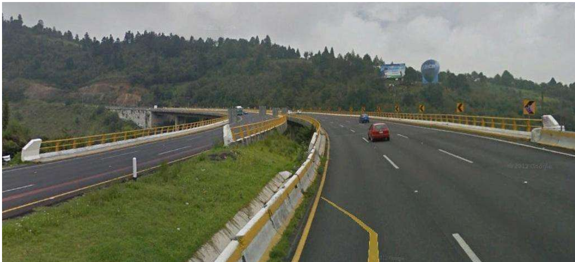
Viaducto 27+300 Autopista México-La Venta-La Marquesa
