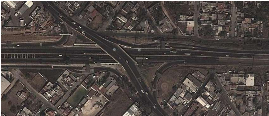
Vista aérea del entronque Lago de Guadalupe en la autopista La Venta-Chamapa-Lecheria
