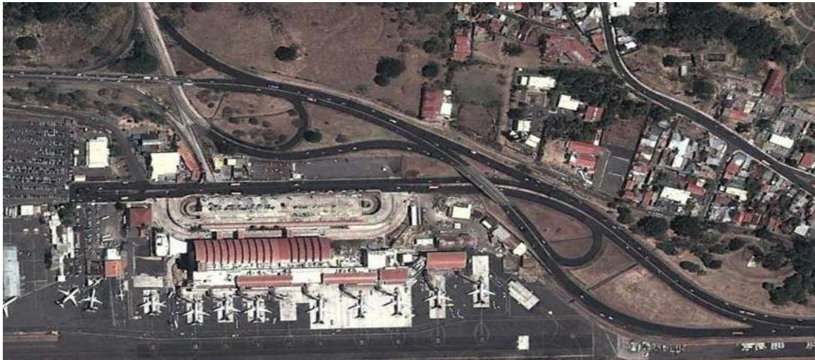
Entronque Aeropuerto, Autopista Bernardo Soto en la republica de Costa Rica.
