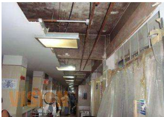
IMAGEN 56.- DESMANTELAMIENTO DE PLAFÓN.
