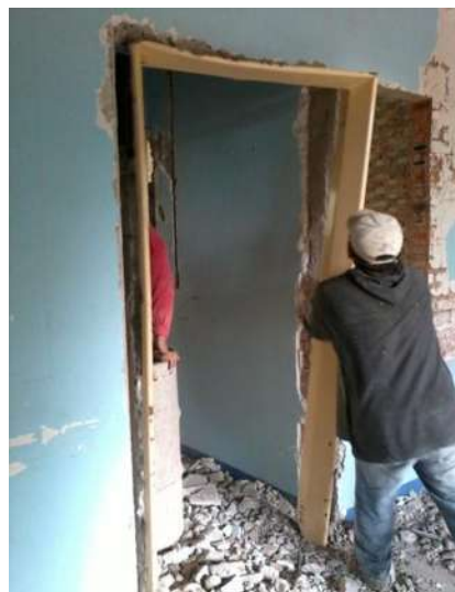
IMAGEN 167.- RETIRO DE MARCOS DE PUERTAS COLADOS A LOS CASTILLOS.
