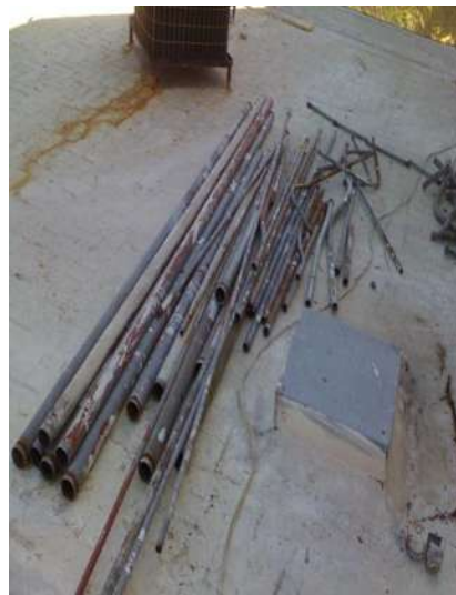
IMAGEN 171.- RETIRO DE TUBERÍA PARED DELGADA DE QUIRÓFANOS.
