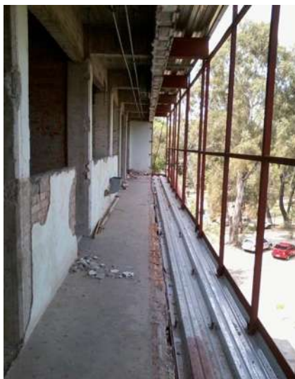
IMAGEN 188.- AMPLIACIÓN DE PASILLO FACHADA ORIENTE 3ER PISO.
