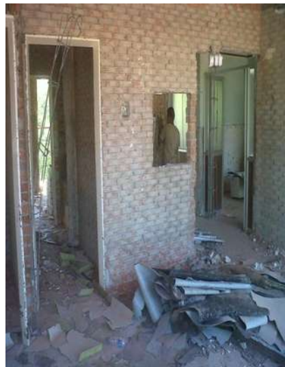
IMAGEN 153.-RETIRO DE PUERTAS.
