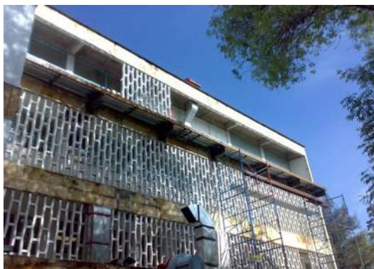
IMAGEN 139.- FACHADA ORIENTE MURO DE CELOSÍA
