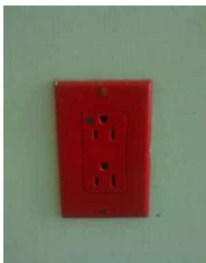
IMAGEN 256.- CONTACTO GRADO HOSPITALARIO COLOR ROJO.
