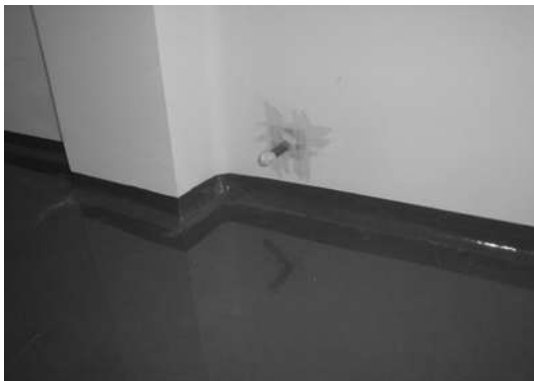
IMAGEN 267.-SALIDA PARA GASES DE ANESTESIA.
