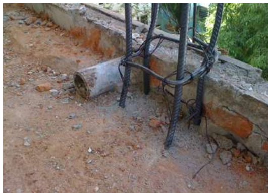
IMAGEN 177.- ANCLAJE DE CASTILLOS
