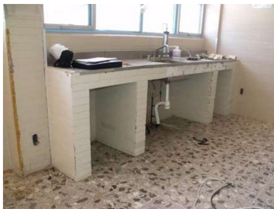
IMAGEN 43-TARJA ELABORADA DE CONCRETO PARA EL LAVADO DE MATERIAL CUBIERTO DE LOSETA EN CEYE.
