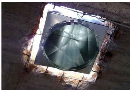
IMAGEN 114.-APERTURA DE LOSA PARA COLOCAR DUCTOS.
