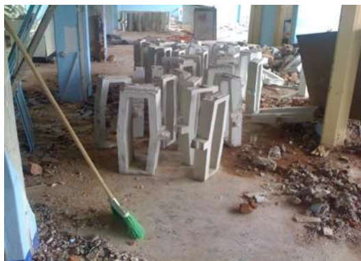
IMAGEN 141.- DESMANTELAMIENTO CELOSÍA PASILLO DE SERVICIO.
