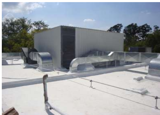
IMAGEN 110.-AZOTEA CUARTO DE AIRE ACONDICIONADO.
