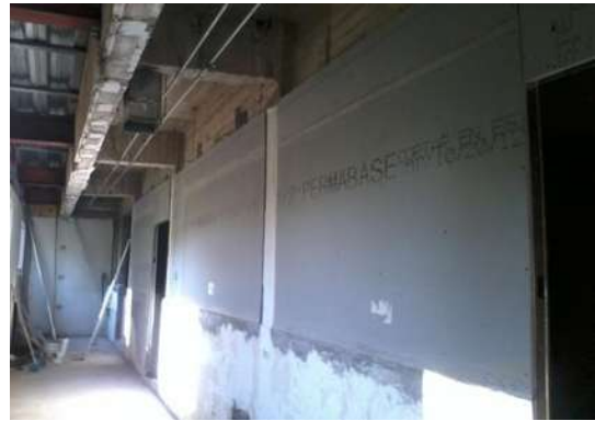
IMAGEN 221.- COLOCACIÓN DE TABLA-CEMENTO EN MUROS INTERIORES.
