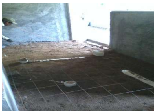
IMAGEN 183.- RELLENO PARA PERDER INSTALACIONES SANITARIAS
