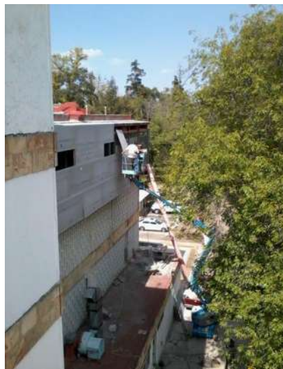
IMAGEN 213.- COLOCACIÓN DE MUROS DE TABLA-CEMENTO CON GRÚA A UNA ALTURA DE 12 MTS
