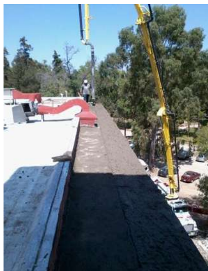
IMAGEN 191.- AMPLIACIÓN DE PASILLO ALA ORIENTE AZOTEA.
