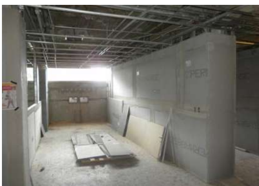
IMAGEN 70.- COLOCACIÓN DE MURO DE DUROCK EN LACTANTES.
