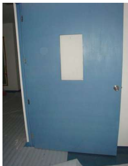
IMAGEN 229.- COLOCACIÓN DE PUERTAS DE MADERA.
