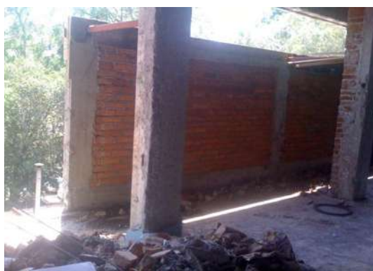
IMAGEN 65.-MUROS DE TABIQUE, DALAS Y CASTILLOS.
