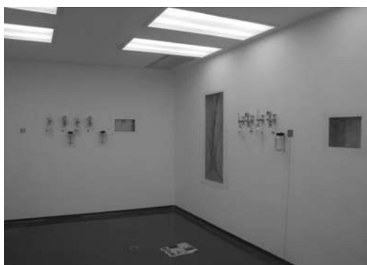
IMAGEN 264.- QUIRÓFANOS 3 CON BARITA.
