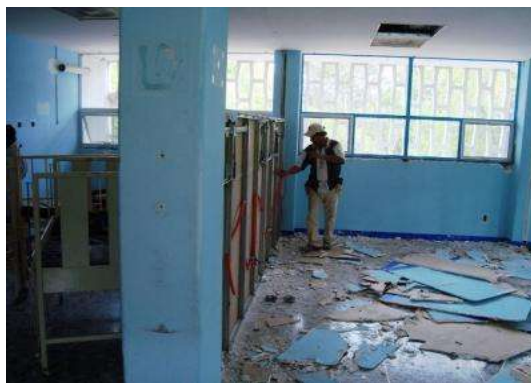
IMAGEN 57.- DEMOLICIÓN DE MUROS Y PLAFÓN.
