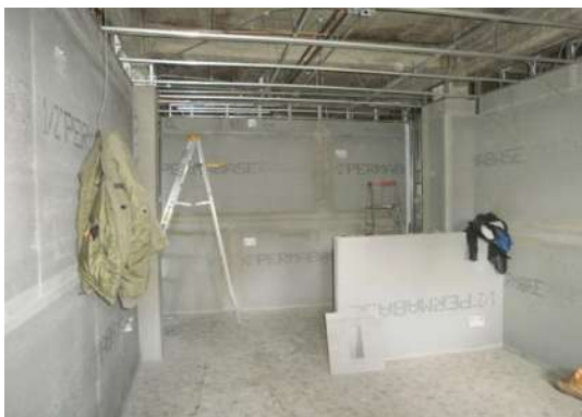
IMAGEN 68.- COLOCACIÓN DE MURO DE DUROCK.
