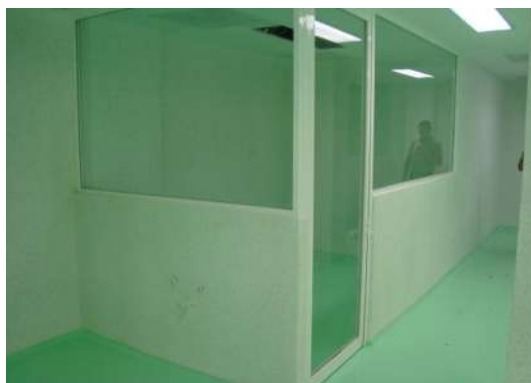
IMAGEN 73.- COLOCACIÓN DE CANCELERÍAS DE ALUMINIO BLANCO EN EL ÁREA DE AISLADO LACTANTES.
