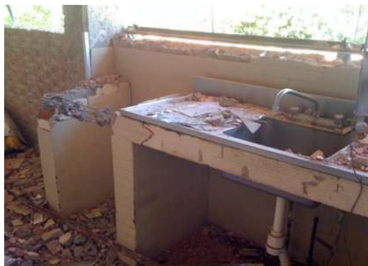
IMAGEN 145.- DEMOLICIÓN DE TARJA DE CONCRETO EN CEYE.
