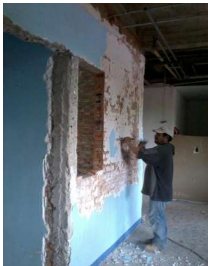
IMAGEN 146.-RETIRO DE YESO Y APLANADO.
