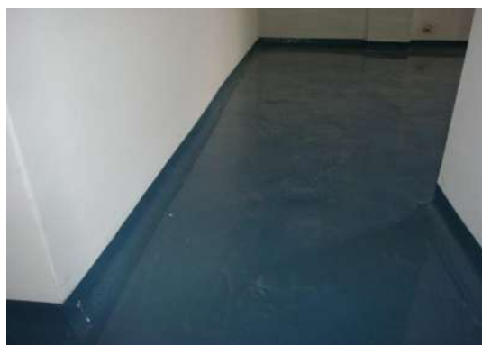
IMAGEN 210.- ACABADO EN PISO QUIRÓFANO 1 "PISO EPOXICO CONDUCTIVO.
