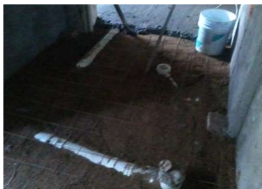
IMAGEN 181.- RELLENO PARA INSTALACIONES SANITARIAS.
