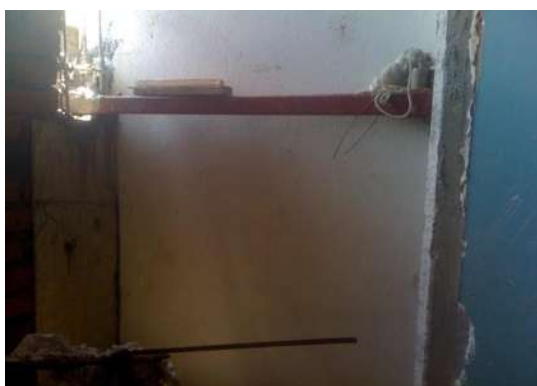
IMAGEN 64.-ANCLAJE DE CASTILLOS A LAS COLUMNAS.
