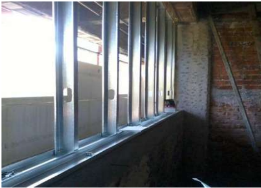
IMAGEN 220.- COLOCACIÓN DE POSTE Y CANALETA EN MUROS INTERIORES.
