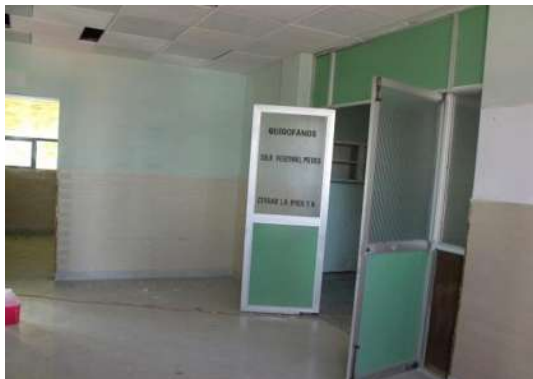
IMAGEN 48.- ACCESO A QUIRÓFANOS.
