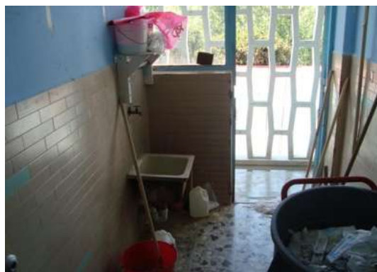
IMAGEN 26.- EL CUARTO DE ASEO FUNCIONABA PARA EL ÁREA DE TERAPIA INTENSIVA LACTANTES Y DABA PASO AL PASILLO DE SERVICIO, SUS ACABADOS YA ERAN TOTALMENTE ASÉPTICOS.
