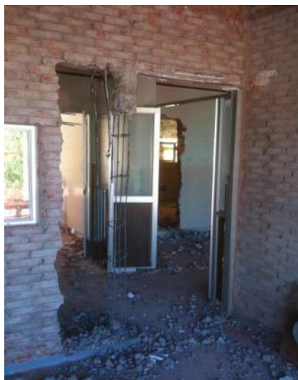
IMAGEN 148.- DEMOLICIÓN DE ELEMENTOS ESTRUCTURALES.
