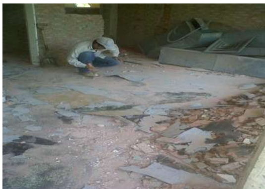
IMAGEN 154.- RETIRO DE PISO DE PVC DE LAS SALAS DE CIRUGÍA.
