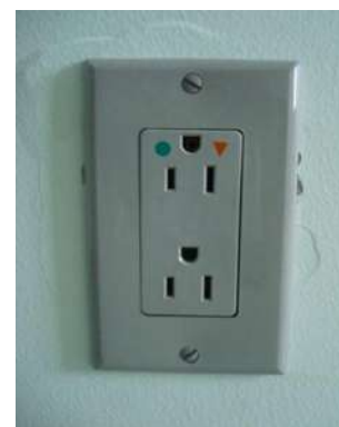
IMAGEN 257.- CONTACTO GRADO HOSPITALARIO COLOR GRIS.
