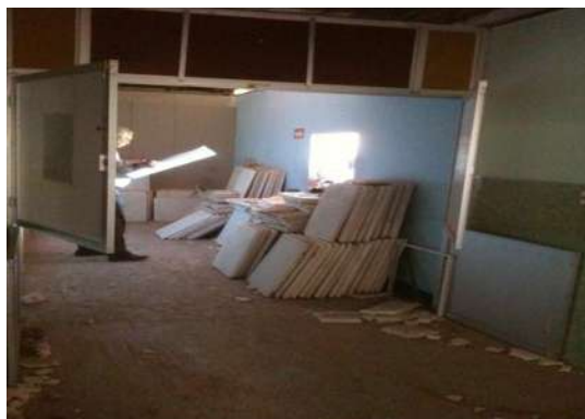
IMAGEN 158.- RETIRO DE TRANSFER DE ALUMINIO.
