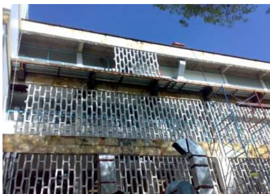
IMAGEN 54.-VENTANAS DE HERRERÍA EN PASILLO DE SERVICIO Y CELOSÍA.
