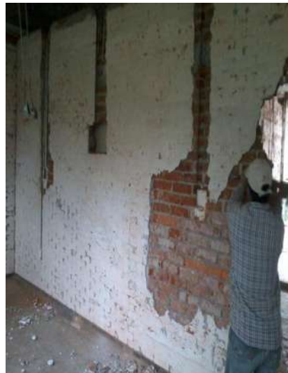
IMAGEN 147.-RETIRO DE YESO EN MUROS.
