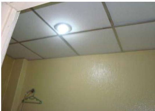
IMAGEN 8.- PLAFÓN REGISTRABLE EN BAÑO DE TERAPIA INTENSIVA.
