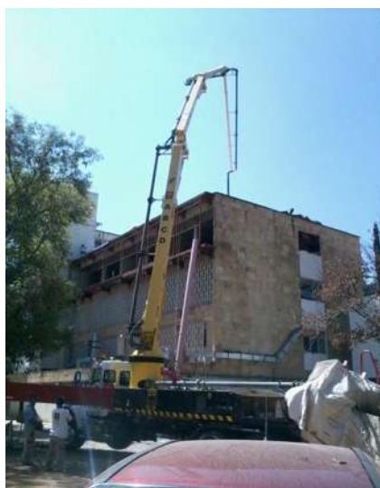
IMAGEN 220.-COLADO DE AMPLIACIÓN DE PASILLO FACHADA PONIENTE 3ER PISO.
