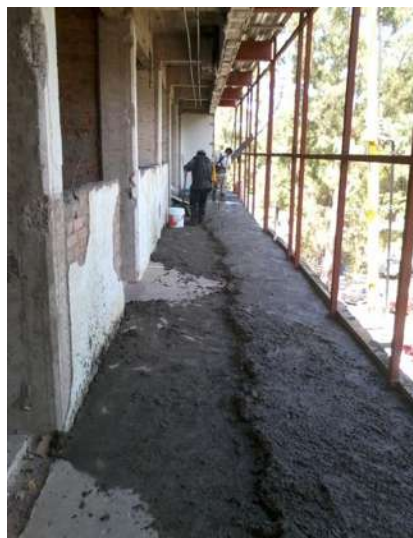
IMAGEN 189.- AMPLIACIÓN DE PASILLO ALA ORIENTE 3ER PISO.
