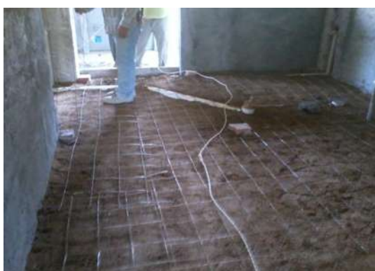
IMAGEN 182.- RELLENO PARA PERDER INSTALACIONES SANITARIAS.
