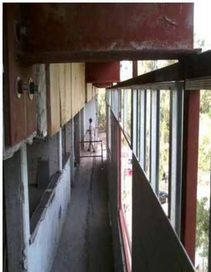
IMAGEN 192.-VIGAS IPR ANCLADAS A TRABES.
