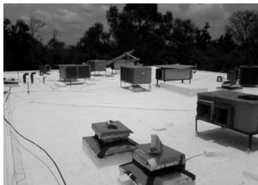
IMAGEN 175.- RETIRO DE EQUIPOS DE AIRE ACONDICIONADO.
