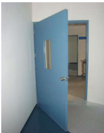
IMAGEN 230.- COLOCACIÓN DE PUERTAS DE MADERA EN QUIRÓFANOS.
