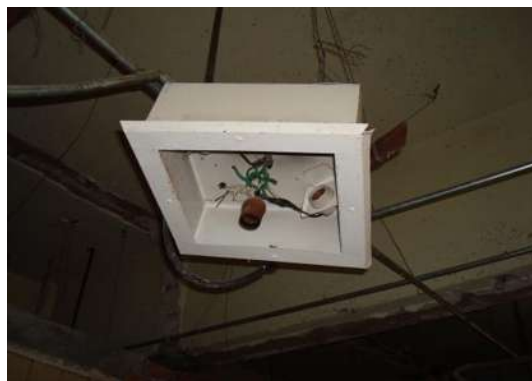
IMAGEN 173.- RETIRO DE LUMINARIOS
