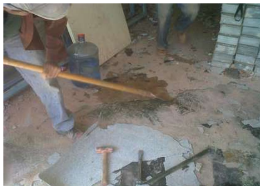
IMAGEN 155.-RETIRO DE PISO DE PVC DE LAS SALAS DE CIRUGÍA.
