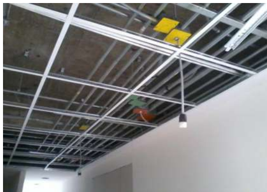
IMAGEN 250.-TUBERIA NORMAL Y DE EMERGENCIA.
