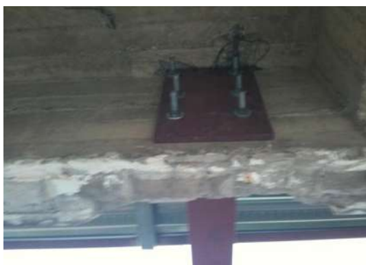
IMAGEN 194.-PLACA ANCLADA A TRABE.
