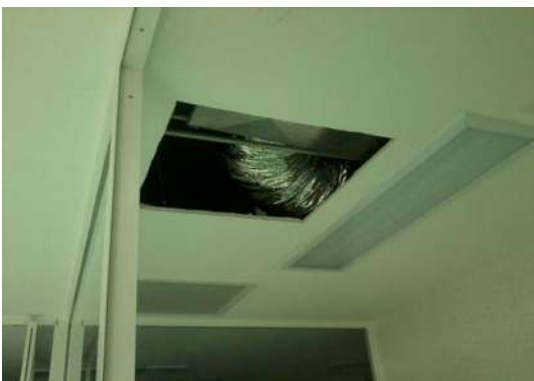
IMAGEN 113.-DUCTOS FLEXIBLES POR PLAFÓN.
