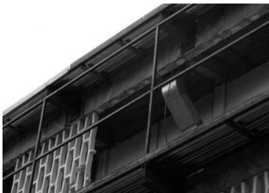
IMAGEN 138.- DESMANTELAMIENTO DE CELOSÍA FACHADA EN EL 3ER PISO
