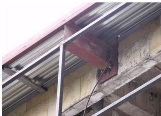
IMAGEN 197.-ESTRUCTURA DE PTR SOLDADA A VIGA IPR.
