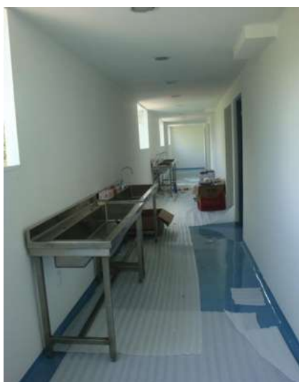
IMAGEN 277.-AMPLIACION DE PASILLO DE CIRCULACIÓN BLANCA.
