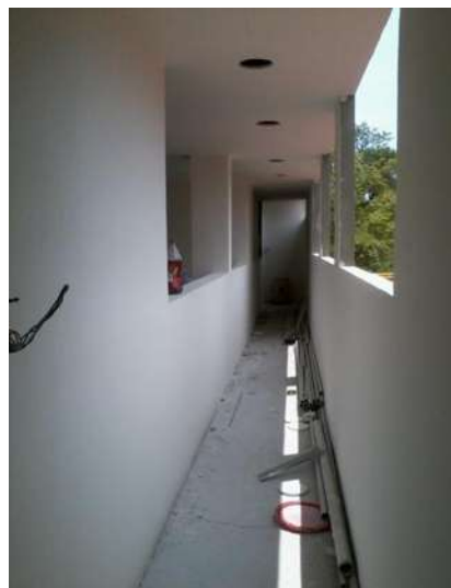
IMAGEN 205.- PASILLO ALA PONIENTE.
