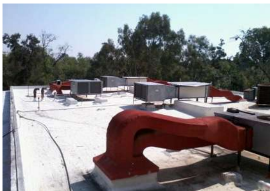
IMAGEN 174.- RETIRO DE EQUIPOS DE AIRE ACONDICIONADO.
