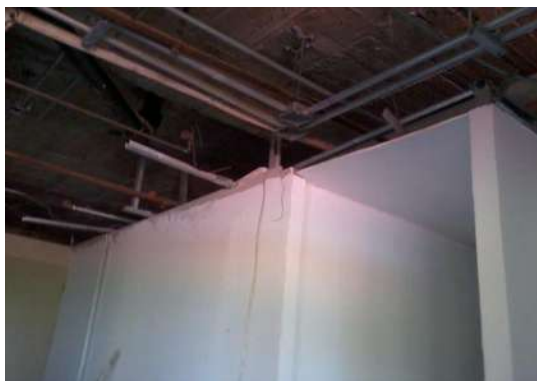
IMAGEN 172.- RETIRO DE TUBERÍA PARED DELGADA DE QUIRÓFANOS.
