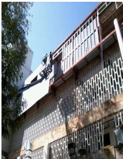
IMAGEN 212.- COLOCACIÓN DE MUROS DE TABLA-CEMENTO CON GRÚA A UNA ALTURA DE 12 MTS.
