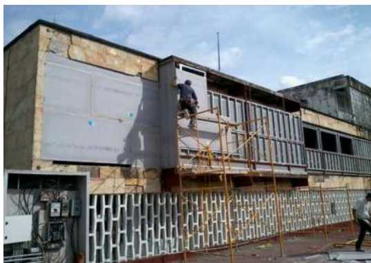
IMAGEN 216.- COLOCACIÓN DE TABLA-CEMENTO FACHADA ORIENTE CON ANDAMIOS.
