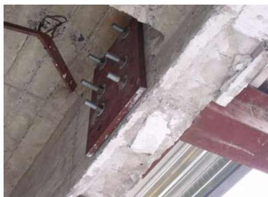
IMAGEN 195.- PLACA ANCLADA A TRABE.
