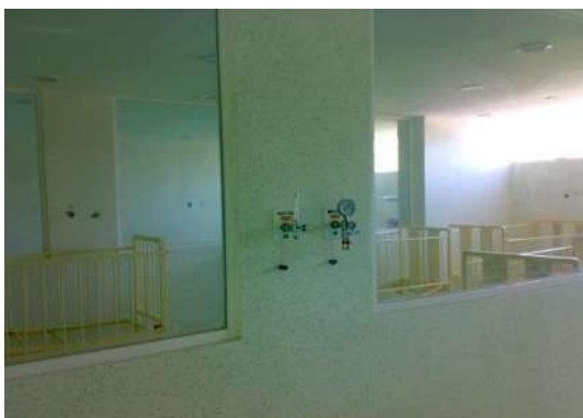
IMAGEN 72.-COLOCACION DE VENTANAS ALUMINIO BLANCO EN EL ÁREA DE AISLADO LACTANTES.
