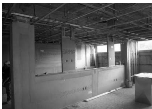
IMAGEN 71.- COLOCACIÓN DE MURO DE DUROCK EN LACTANTES.
