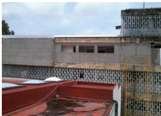
IMAGEN 217.- COLOCACIÓN DE TABLA-CEMENTO FACHADA ORIENTE CON ANDAMIOS.
