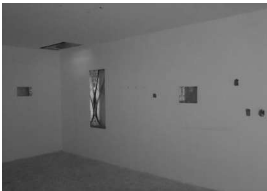
IMAGEN 208.-ACABADOS EN QUIRÓFANO 1.
