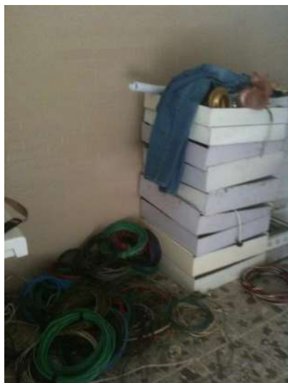
IMAGEN 170.- RETIRO CABLE Y LUMINARIOS DE QUIRÓFANOS.
