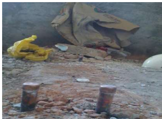
IMAGEN 163.- CANCELACIÓN DE SALIDAS HIDRÁULICAS Y SANITARIAS
