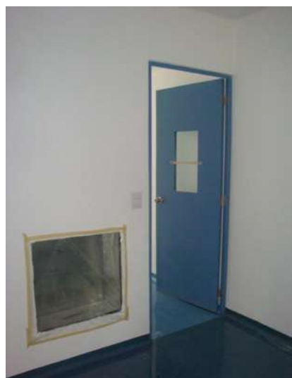
IMAGEN 231.- COLOCACIÓN DE PUERTAS DE MADERA EN QUIRÓFANOS.
