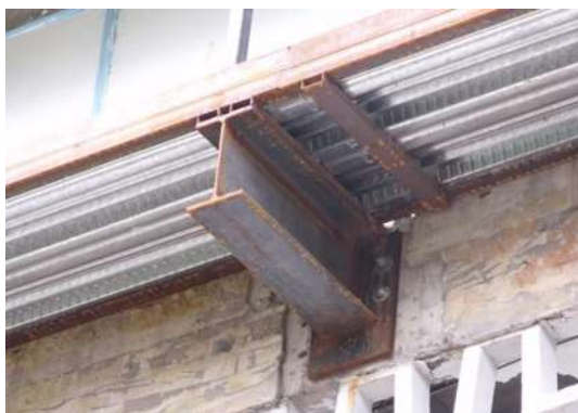
IMAGEN 196.-VIGA IPR AMPLIACIÓN DE PASILLO AZOTEA.
