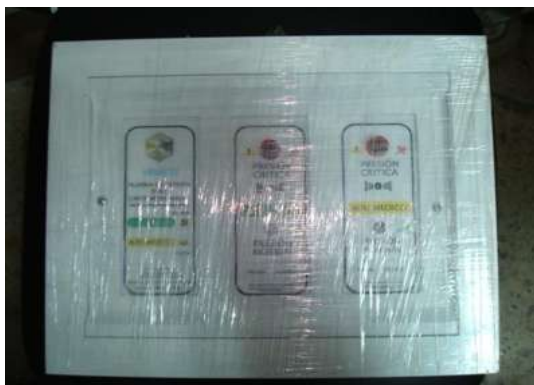
IMAGEN 239.- ALARMA DE OXÍGENO Y AIRE.
