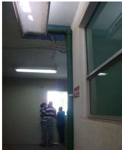
IMAGEN 246.- TUBERÍA DE VAPOR PARA AUTOCLAVE.
