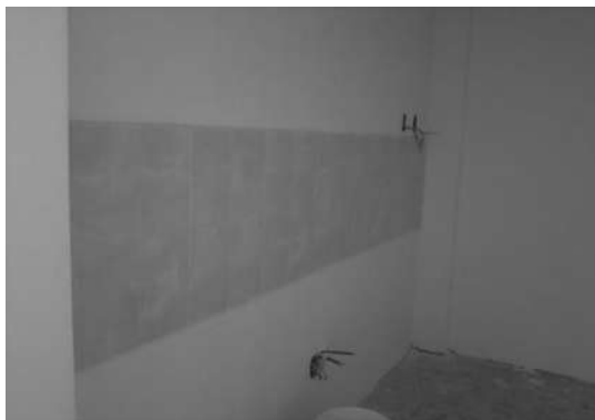
IMAGEN 202.- ACABADO EN CEyE.
