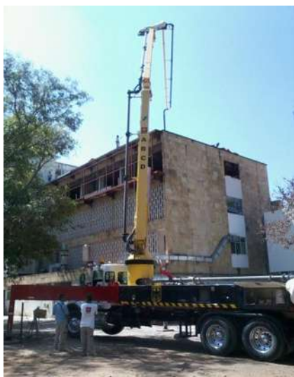
IMAGEN 190.- AMPLIACIÓN DE PASILLO FACHADA ORIENTE 3ER PISO.
