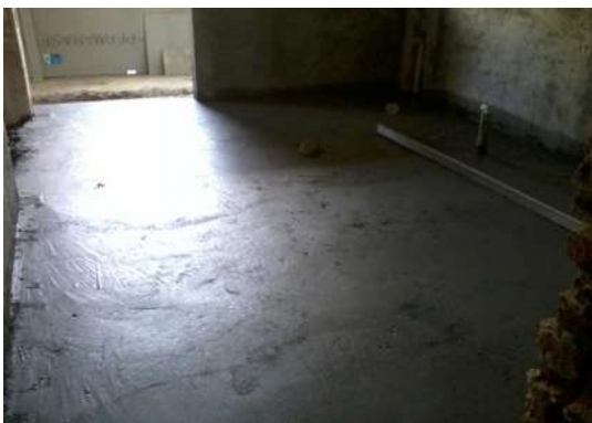
IMAGEN 184.- FIRME DE CONCRETO VESTIDOR DE DOCTORES Y DOCTORAS.
