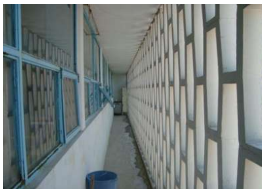
IMAGEN 40.- PASILLO DE SERVICIO.
