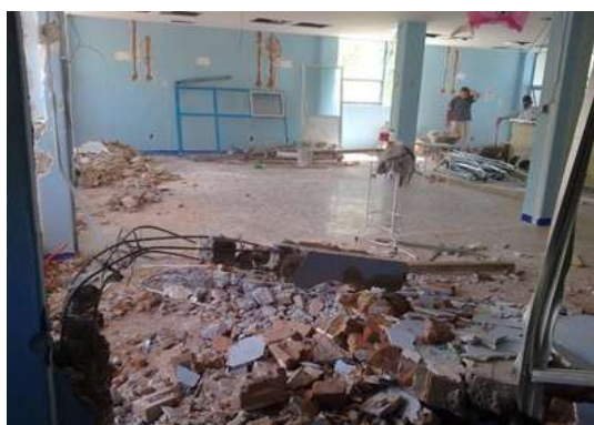
IMAGEN 58.- DEMOLICIÓN DE MUROS Y CASTILLOS.
