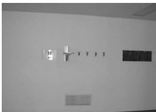
IMAGEN 96.-TOMAS DE OXÍGENO Y AIRE EN TERAPIA INTENSIVA.
