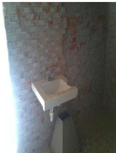
IMAGEN 156.-RETIRO DE LAVAMANOS.
