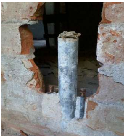
IMAGEN 164.- CANCELACIÓN DE SALIDAS HIDRÁULICAS Y SANITARIAS.
