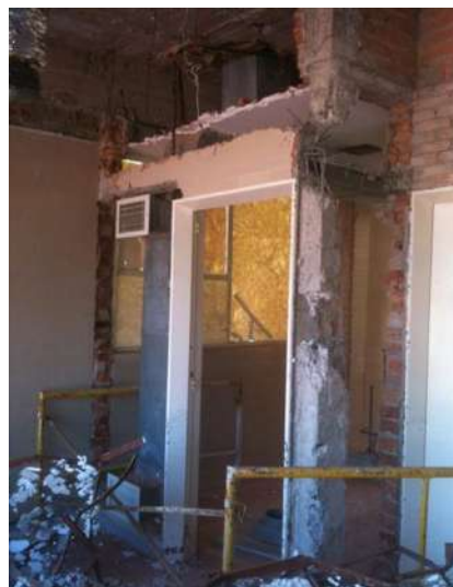
IMAGEN 149.- DEMOLICIÓN DE ELEMENTOS ESTRUCTURALES.
