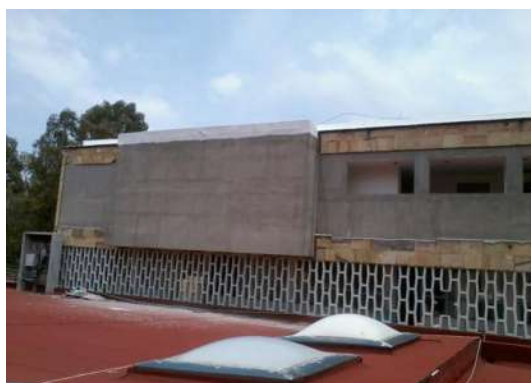
IMAGEN 219.- COLOCACIÓN DE TABLA-CEMENTO FACHADA ORIENTE CON ANDAMIOS.
