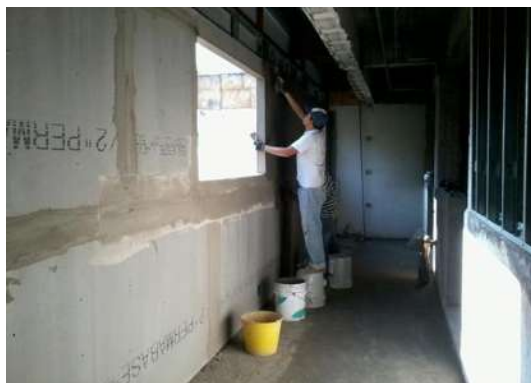
IMAGEN 215.- MURO DE TABLA-CEMENTO PASILLO DE CIRCULACIÓN BLANCA.
