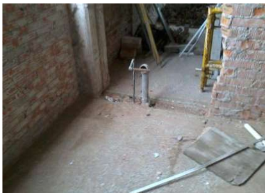
IMAGEN 162.- CANCELACIÓN DE SALIDAS HIDRÁULICAS Y SANITARIAS
