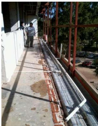
IMAGEN 232.- TUBERÍA DE PVC AMPLIACIÓN DE PASILLO FACHADA
