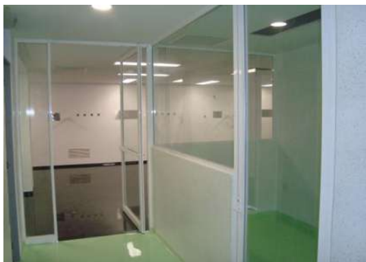
IMAGEN 74.- COLOCACIÓN DE PUERTAS Y VENTANAS ALUMINIO BLANCO.
