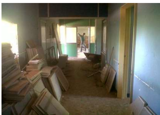
IMAGEN 136.- DESMANTELAMIENTO DE PLAFÓN.
