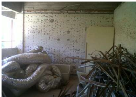
IMAGEN 135.- DESMANTELAMIENTO DE PLAFÓN.
