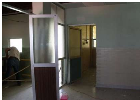
IMAGEN 53.-ACCESO A CIRUGÍA EN QUIRÓFANOS CON PUERTAS ABATIBLES AUN SOLO LADO.
