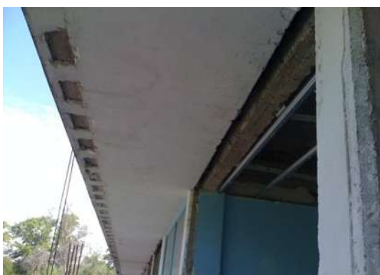
IMAGEN 137.- DESMANTELAMIENTO DE PLAFÓN.
