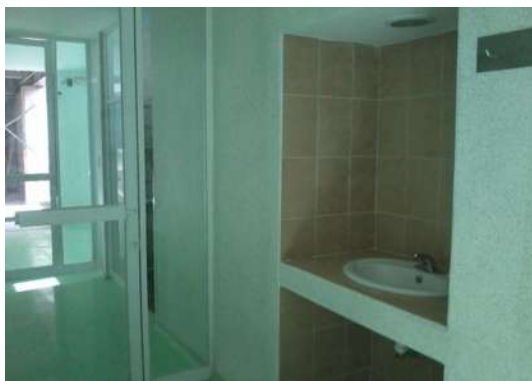
IMAGEN 128.-PASILLO, FILTRO DE ACCESO A TERAPIA INTENSIVA CON LAVAMANOS Y FACHADA PONIENTE.
