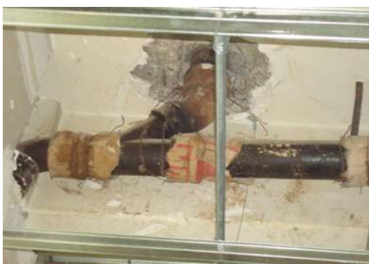
IMAGEN 83.- TUBERÍA EXISTENTE EN EL HOSPITAL INFANTIL DE FIERRO FUNDIDO.
