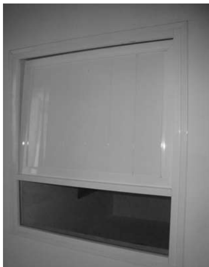
IMAGEN 222.- VENTANA DE GUILLOTINA DE ALUMINIO EN CEYE.
