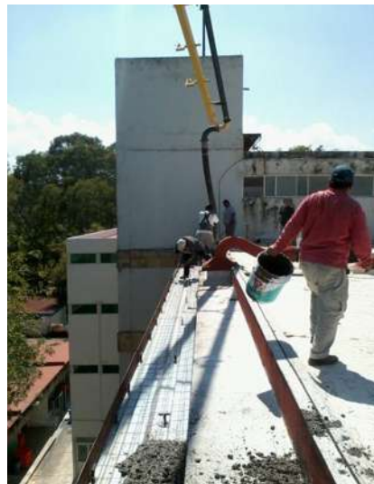
IMAGEN 193.-COLADO DE AMPLIACIÓN DE PASILLO POR AZOTEA.
