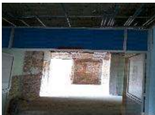
IMAGEN 159.- RETIRO DE TRANSFER DE ALUMINIO.
