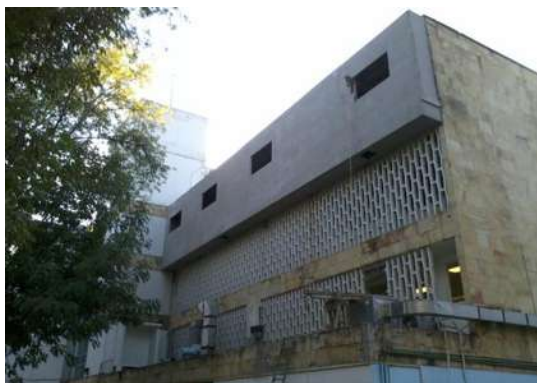
IMAGEN 214.- COLOCACIÓN DE TABLA-CEMENTO ALTURA DE 12 MTS.
