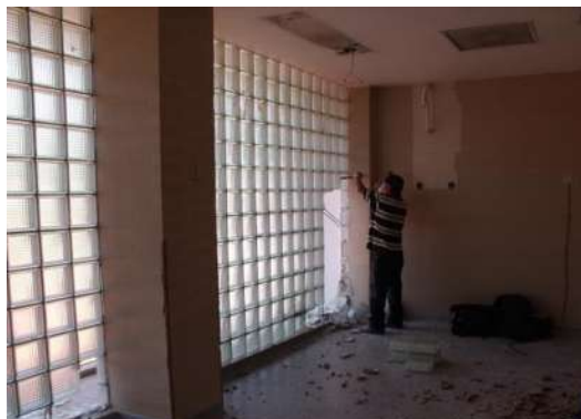
IMAGEN 142.-RETIRO DE MURO DE BITROBLOK DENTRO DE QUIRÓFANOS.
