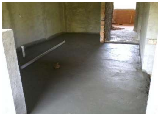
IMAGEN 185.- FIRME DE CONCRETO VESTIDOR DE DOCTORES Y DOCTORAS.
