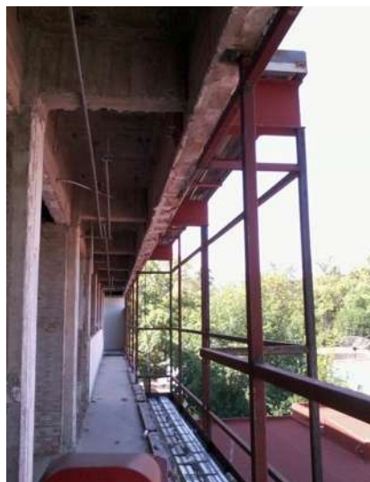
IMAGEN 199.- AMPLIACIÓN DE PASILLO ALA PONIENTE 3ER PISO.
