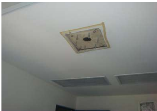
IMAGEN 275.-BASE PARA LÁMPARA DE CIRUGÍA.
