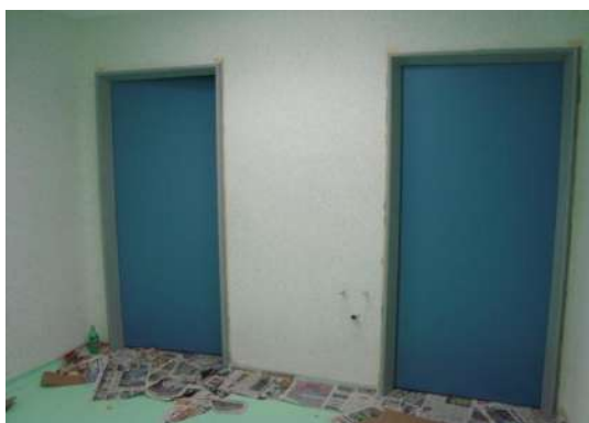
IMAGEN 75.- COLOCACIÓN DE PUERTAS DE MADERA.
