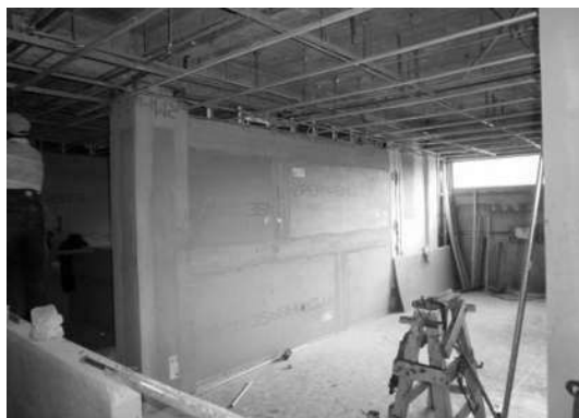
IMAGEN 69.- COLOCACIÓN DE MURO DE DUROCK.
