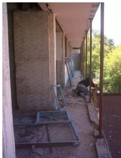
IMAGEN 151.- RETIRO VENTANAS DE HERRERÍA.
