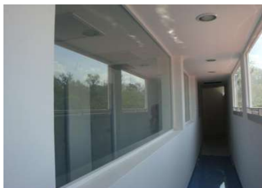
IMAGEN 227.- VENTANAS EN PASILLO A HUESO
