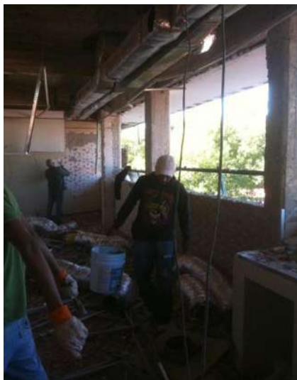
IMAGEN 134.- DESMANTELAMIENTO DE PLAFÓN.
