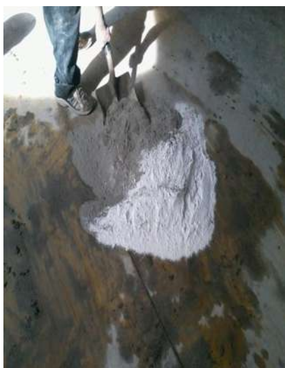
IMAGEN 186.- CEMENTO Y SULFATO DE BARIO EN 1 QUIRÓFANO.
