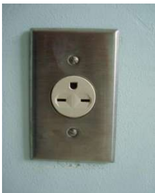
IMAGEN 258.-CONTADOR PARA EQUIPOS.
