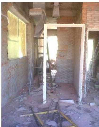
IMAGEN 150.- DEMOLICIÓN DE MUROS DE TABIQUE.
