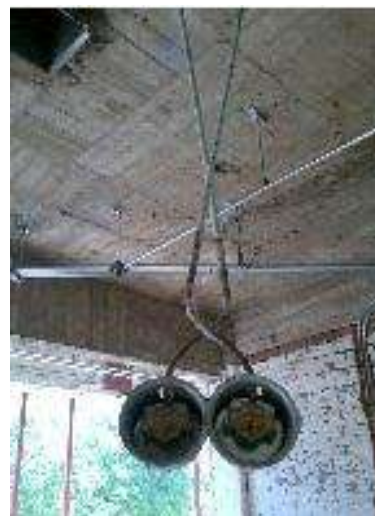
IMAGEN 161.- RETIRO DE TOMAS DE AIRE.
