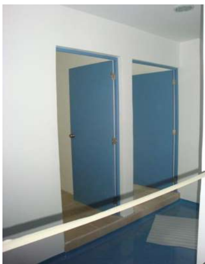
IMAGEN 228.- COLOCACIÓN DE PUERTAS DE MADERA.
