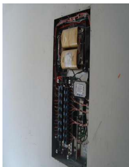
IMAGEN 106.-PEINADO DEL TABLERO DE AISLAMIENTO COLOCADO EN TERAPIA INTENSIVA.
