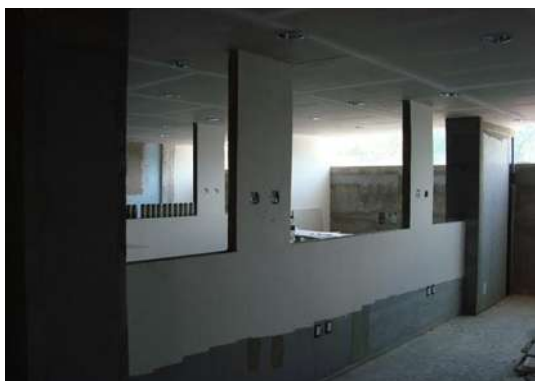
IMAGEN 66.- RECUBRIMIENTO EN MUROS PARA RECIBIR ACABADO ACUAREL LAVABLE.
