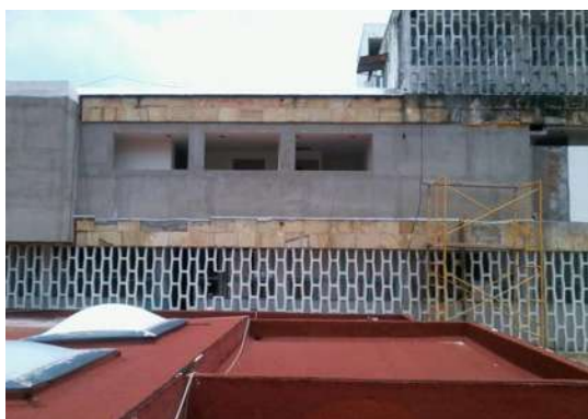
IMAGEN 218.- COLOCACIÓN DE TABLA-CEMENTO FACHADA ORIENTE CON ANDAMIOS.
