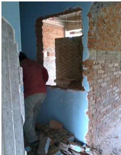
IMAGEN 152.- DEMOLICIÓN DE MUROS DE TABIQUE.
