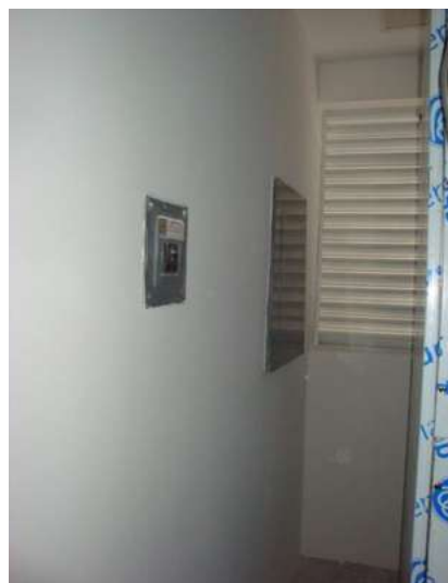
IMAGEN 254.-CENTRO DE CARGA PARA AUTOCLAVE.
