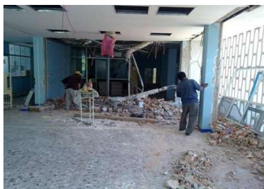
IMAGEN 59.- DEMOLICIÓN DE MUROS DE TABLAROCA E INSTALACIONES ELÉCTRICAS Y GASES MEDICINALES.
