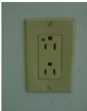
IMAGEN 259.-CONTACTO SISTEMA NORMAL.
