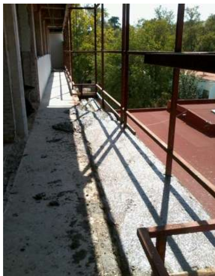
IMAGEN 198.- AMPLIACIÓN DE PASILLO FACHADA PONIENTE 3ER PISO.
