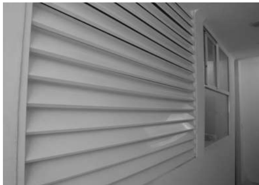
IMAGEN 268.-VENTANA LOUVER PARA AUTOCLAVE.
