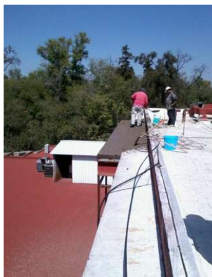
IMAGEN 201.- AMPLIACIÓN DE PASILLO ALA PONIENTE AZOTEA.
