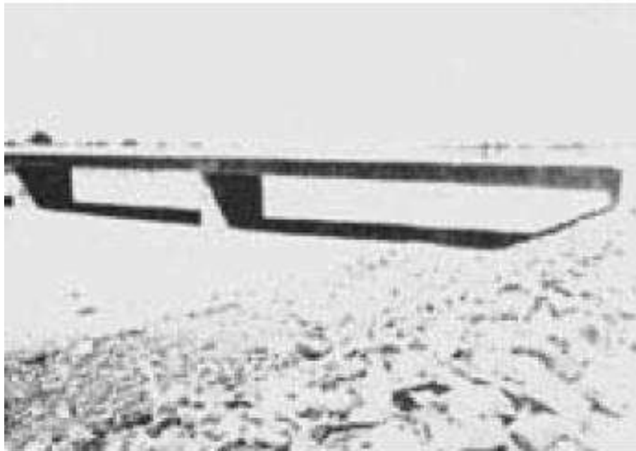
Figura 1.3 Puente Zaragoza. Primer puente presforzado construido en México.
