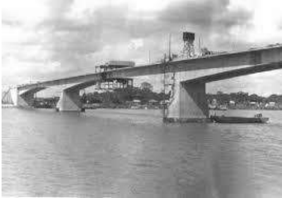
Figura 1.4 Puente Tuxpan. Primer puente construido con el sistema de dovelas en América.
