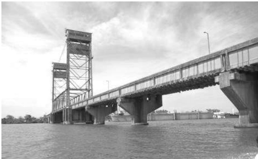
Figura 1.5 Puente Coatzacoalcos I. Puente mixto de aproximadamente 1 km.
