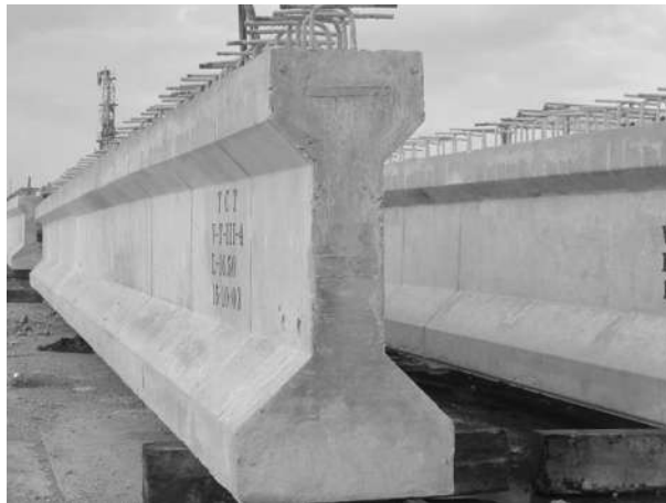
Figura 3.4 Trabe AASHTO con conectores.
