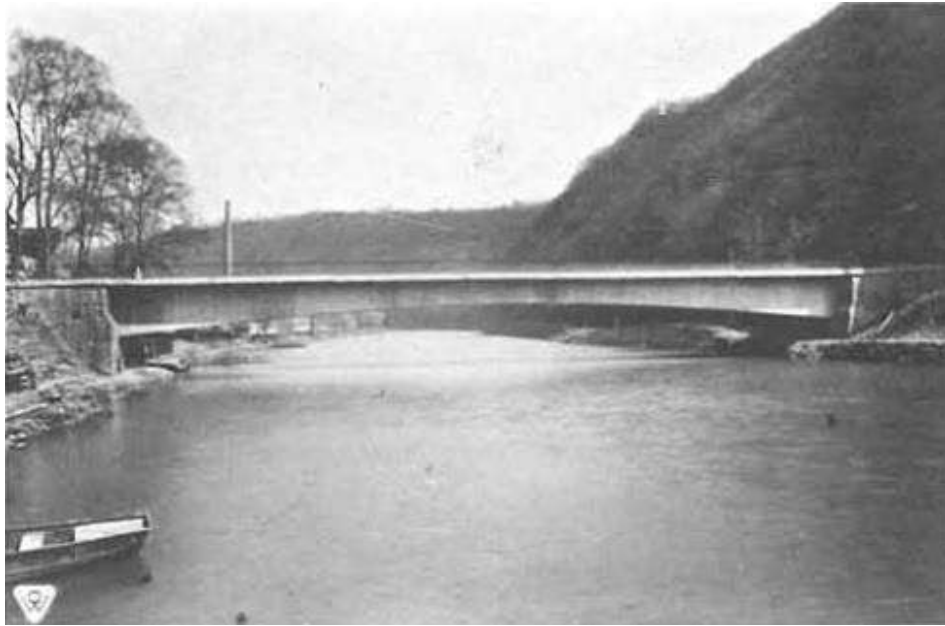
Figura 1.1 Puente Balduistein. Primer puente construido en el mundo por el procedimiento de avance en voladizo sucesivo. (Manterola, 1984)
