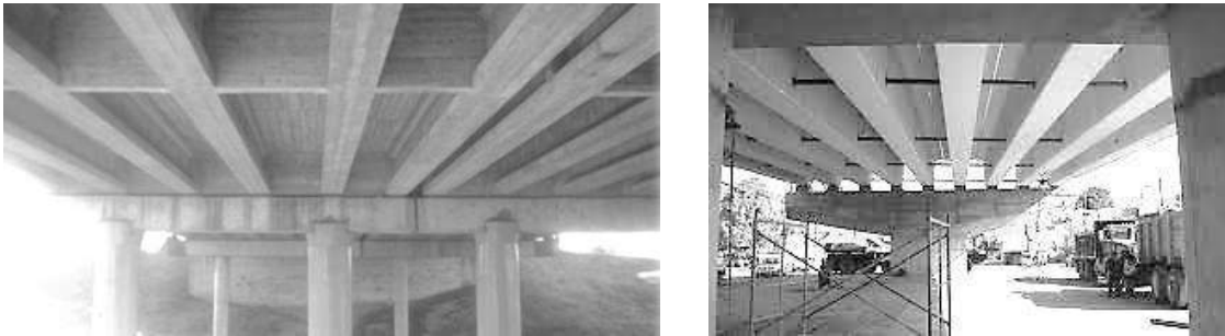
Figura 3.5 Diafragmas de concreto y metálicos.
