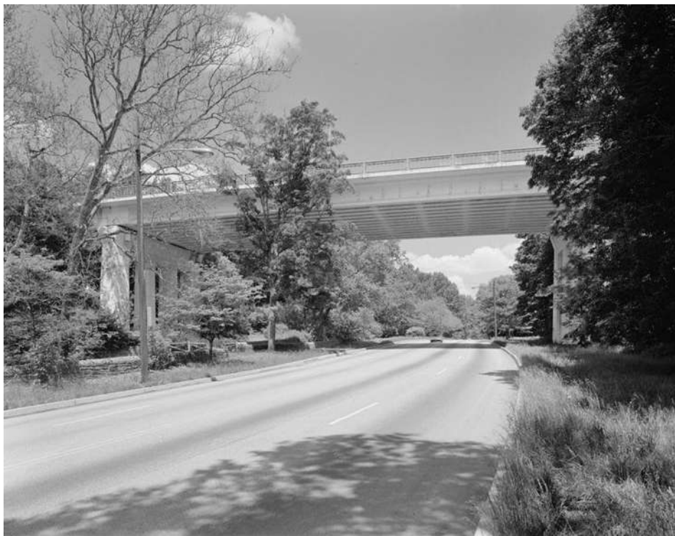
Figura 1.2 Walnut Lane Memorial Bridge. Primer puente presforzado construido en el continente americano.
