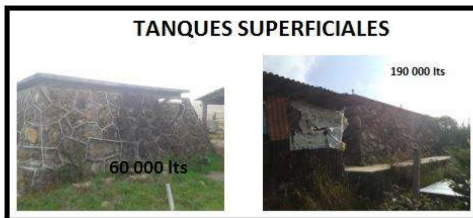
Figura 14 TANQUES SUPERFICIALES DEL MUNICIPIO DE HUIRAMBA.
