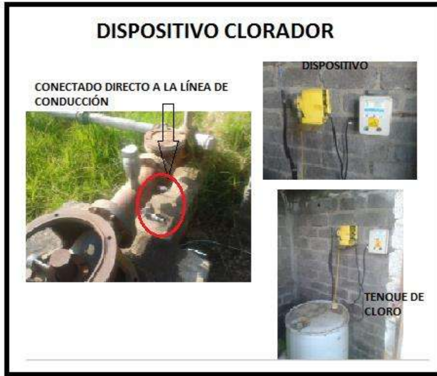
Figura 16 DISPOSITIVO CLORADOR.
