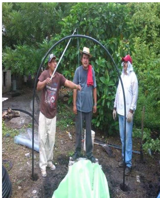
Imagen 5.9.- Construcción de estructura
