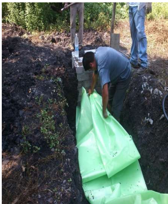
Imagen 5.6.- Colocación del biodigestor.
