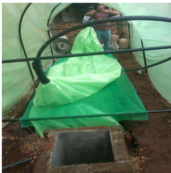
Imagen 5.15.- Colocación del bolso reservorio.
