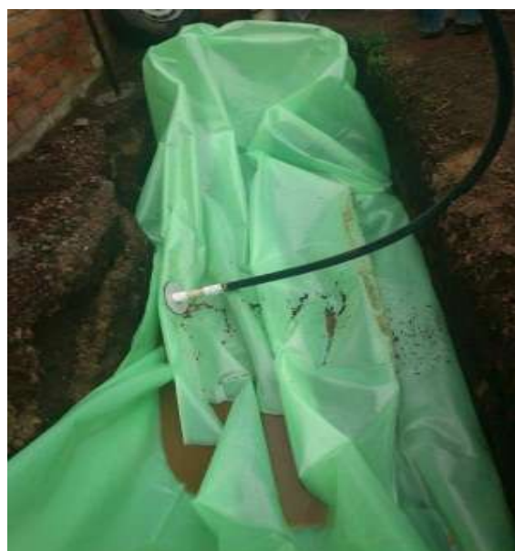
Imagen 5.5.- colocación del sándwich.
