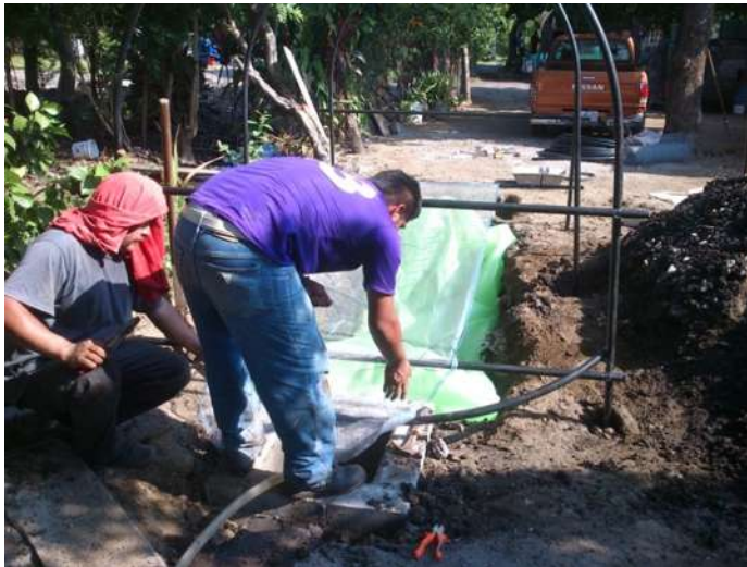
Imagen 5.10.- Colocación de tela-malla
