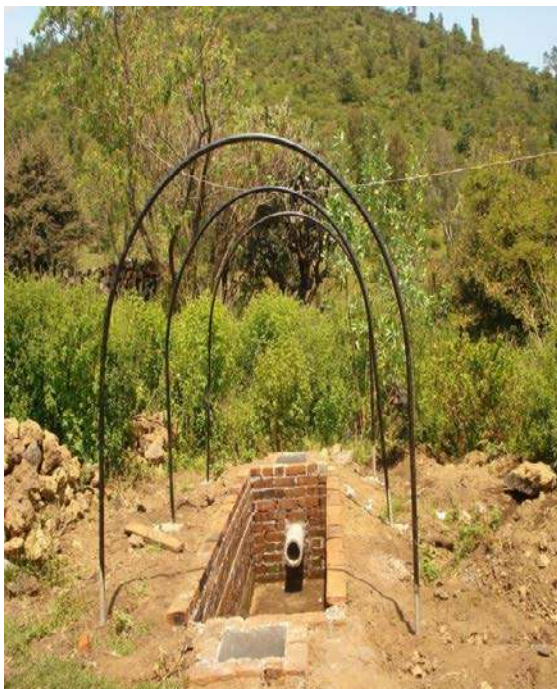
Imagen 5.8.- Estructura de metal.
