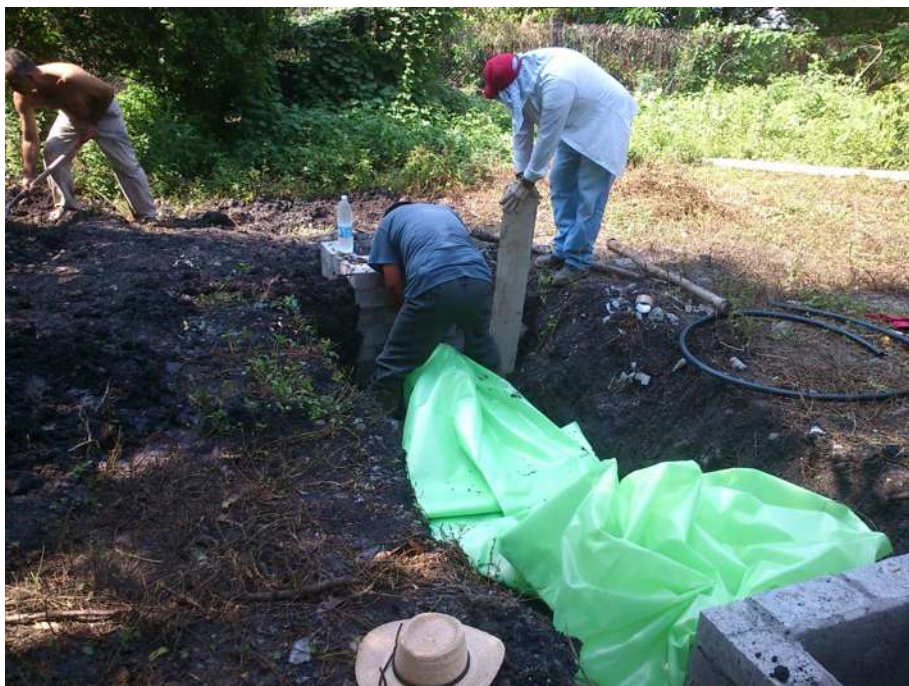
Imagen 5.2.- Fosa con talud de tierra
