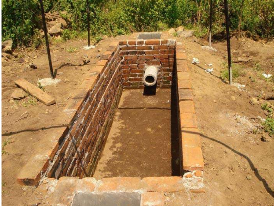
Imagen 5.1.- Fosa con ladrillo asentado
