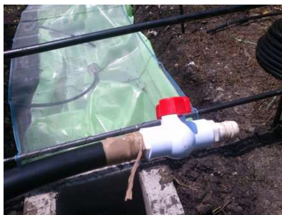
Imagen 5.18.- Colocación de la llave de paso
