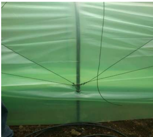
Imagen 5.12.- Sujeción del polietileno
