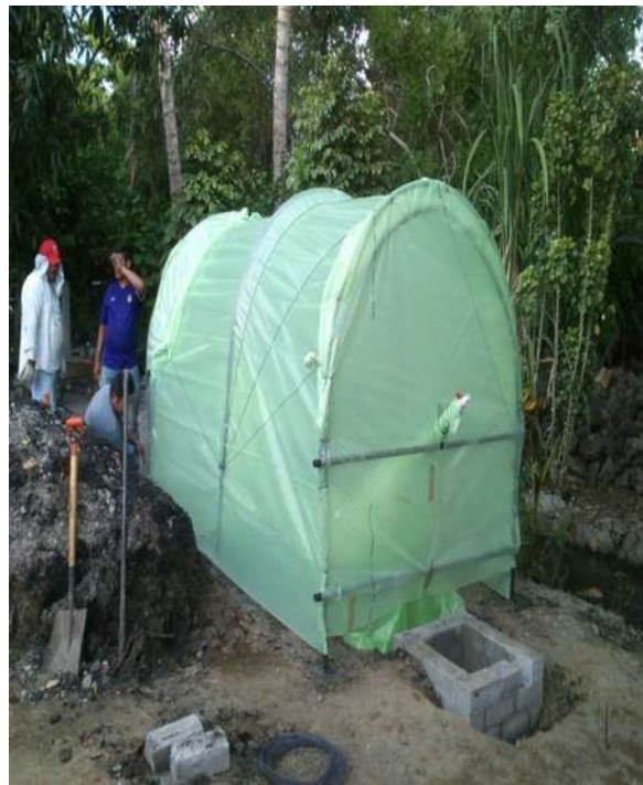
imagen 5.17.- colocación de malla de gallinero
