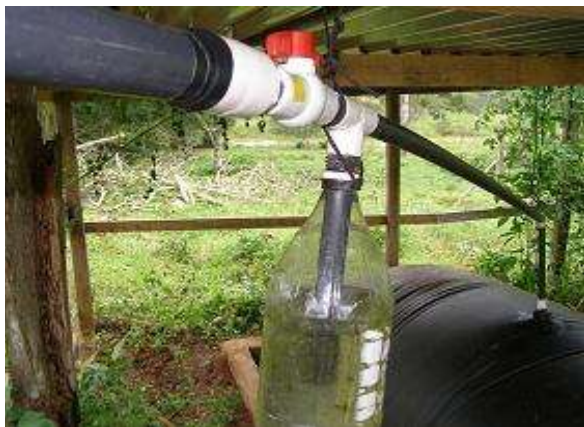
Imagen 5.19.- colocación de válvula
