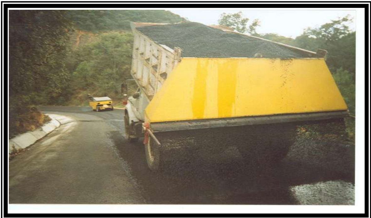
FOTO No.26 APLICACIÓN DEL RIEGO DE SELLO.
