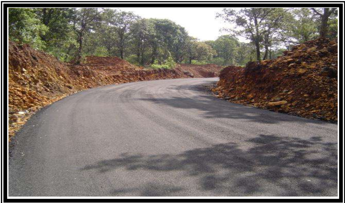
FOTO No.20 CARPETA ASFALTICA.
