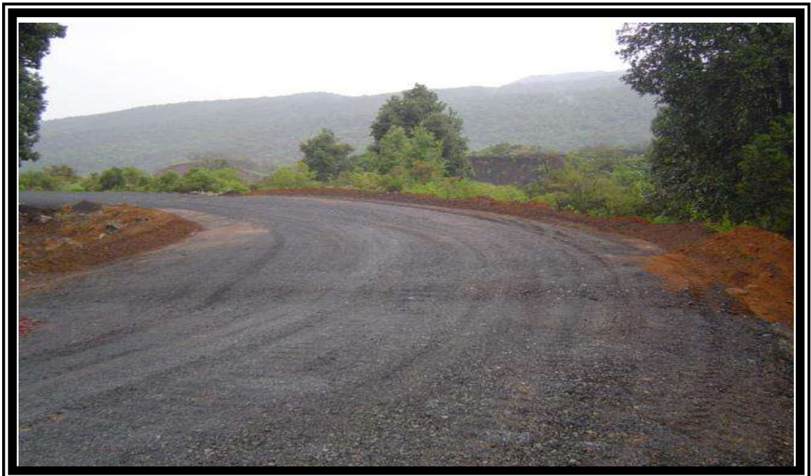
FOTO No.18 ARROPE DE TALUD PARA ENCAJONAR BASE Y CARPETA.
