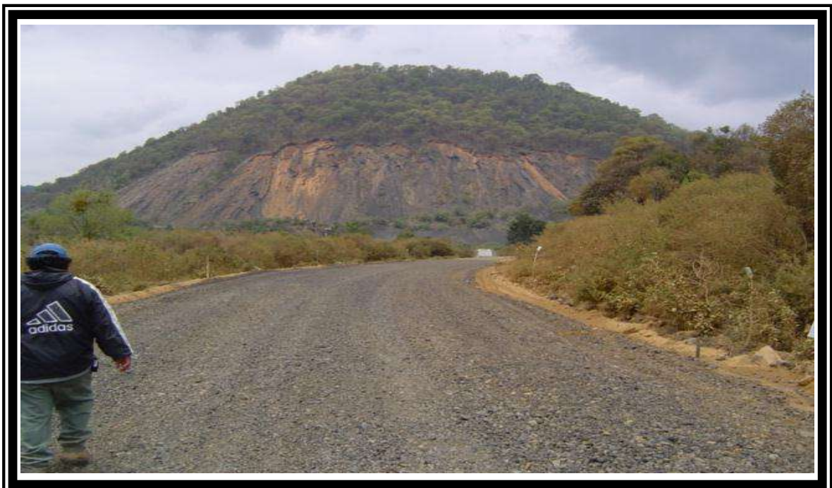
FOTO No.12 CONSTRUCCION DE LA CAPA SUBRASANTE.
