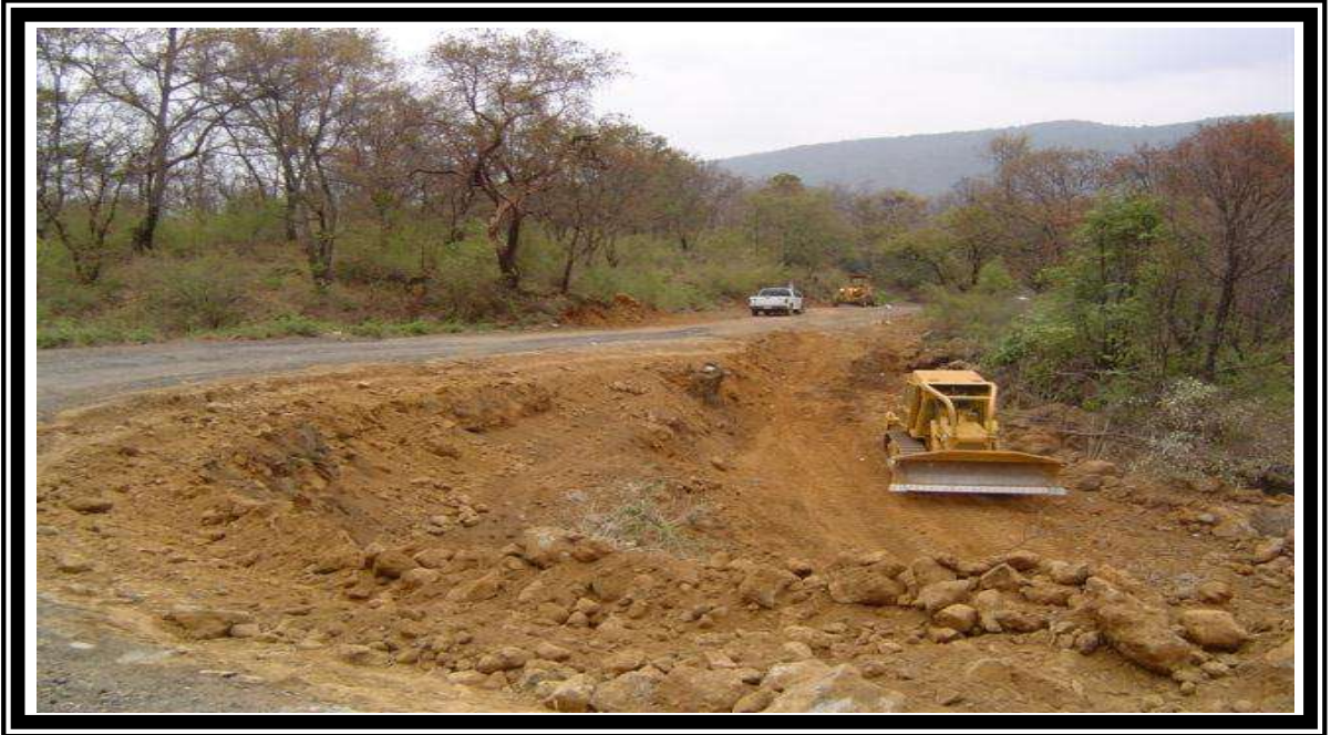
FOTO No.5 CONSTRUCCION DE TERRACERIAS.
