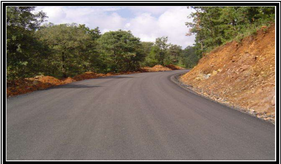
FOTO No.22 CARPETA ASFALTICA TERMINADA.
