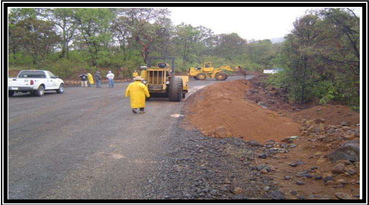
FOTO No.17 ARROPE DE TALUD.
