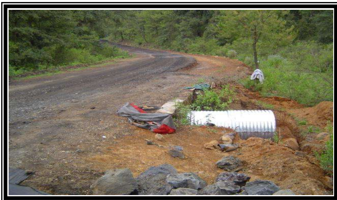
FOTO No.8 AMPLIACION DE OBRAS DE DRENAJE. TUBO DE LÁMINA CORRUGADA.
