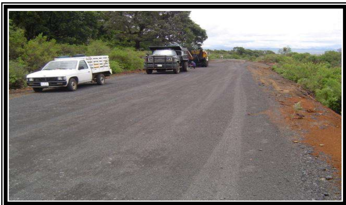
FOTO No.14 CONSTRUCCION DE LA BASE HIDRAULICA.
