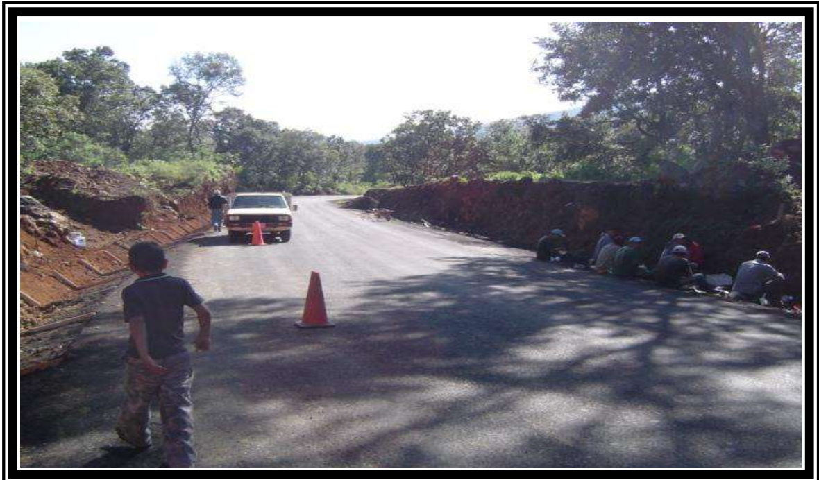
FOTO No.24 CONSTRUCCION DE CUNETAS.
