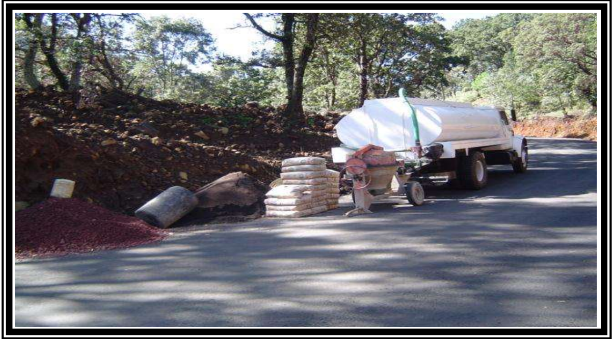
FOTO No.23 CONSTRUCCION DE CUNETAS.
