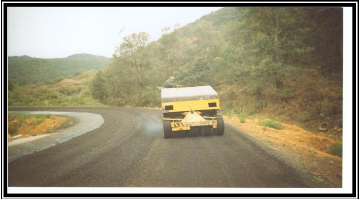
FOTO No.27 APLICACIÓN DEL RIEGO DE SELLO.
