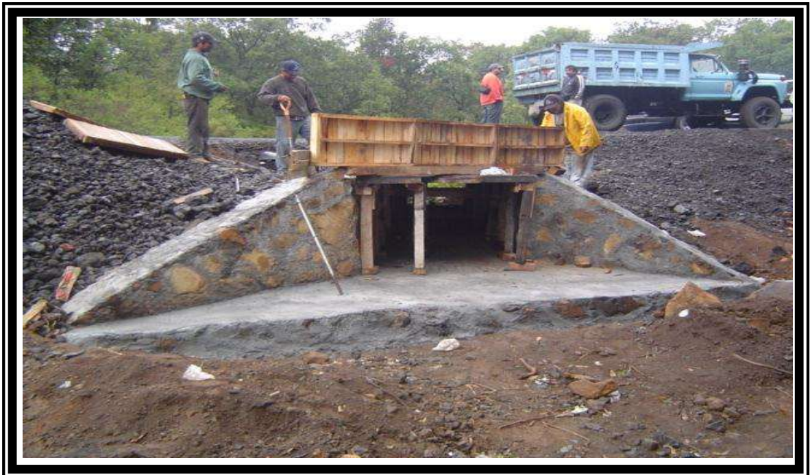
FOTO No.10 AMPLIACION DE OBRAS DE DRENAJE. DE LOSA DE CONCRETO.
