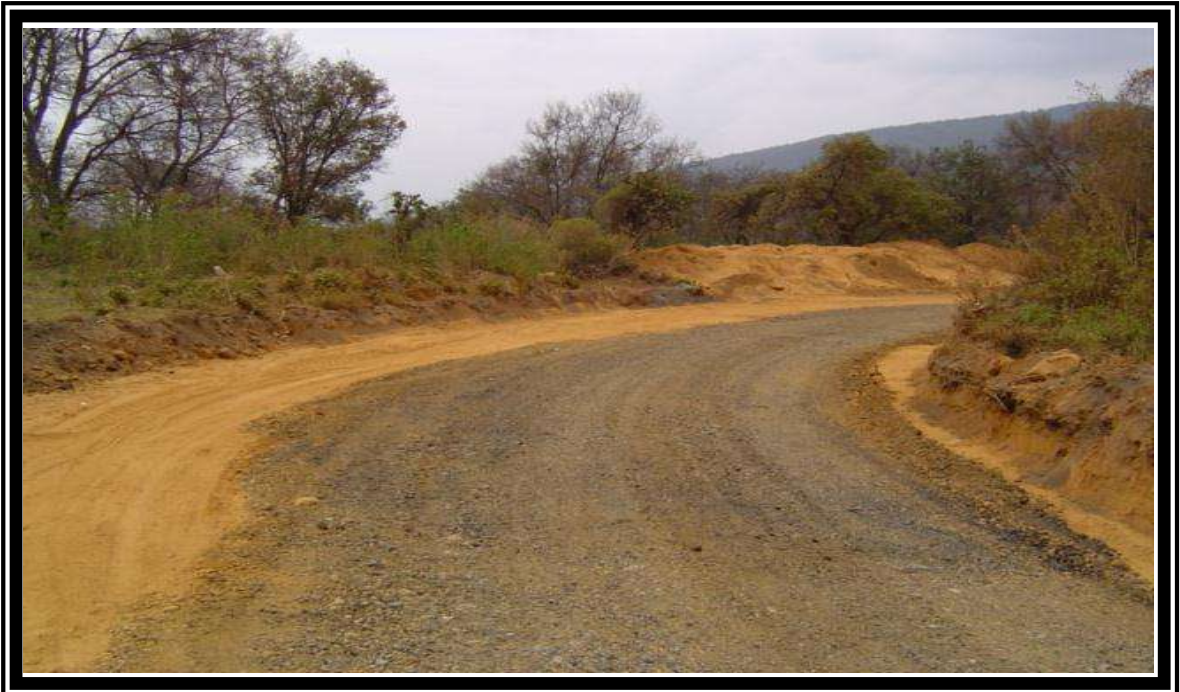
FOTO No.6 CONSTRUCCION DE TERRACERIAS.
