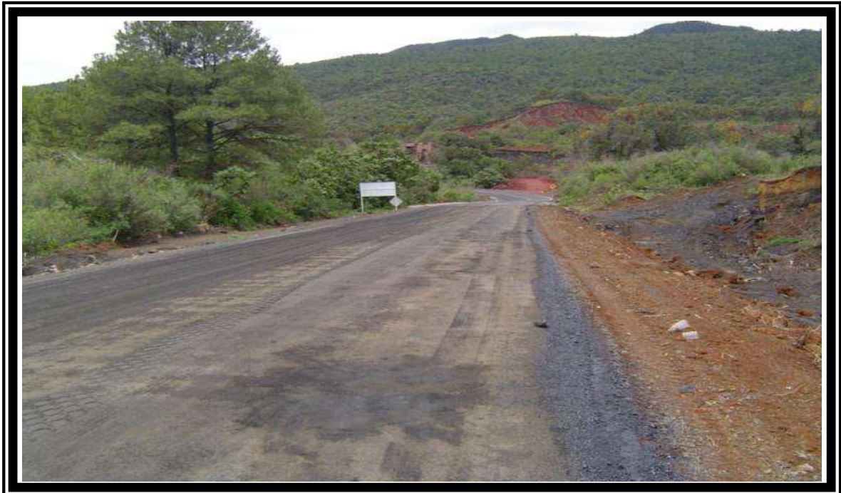
FOTO No.16 BASE HIDRAULICA IMPREGNADA Y POREADA CON ARENA.
