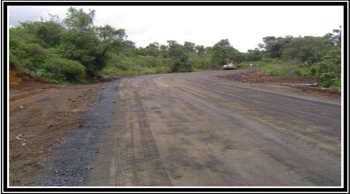
FOTO No.15 RIEGO DE IMPREGNACION Y POREO CON ARENA DE LA BASE HIDRAULICA.
