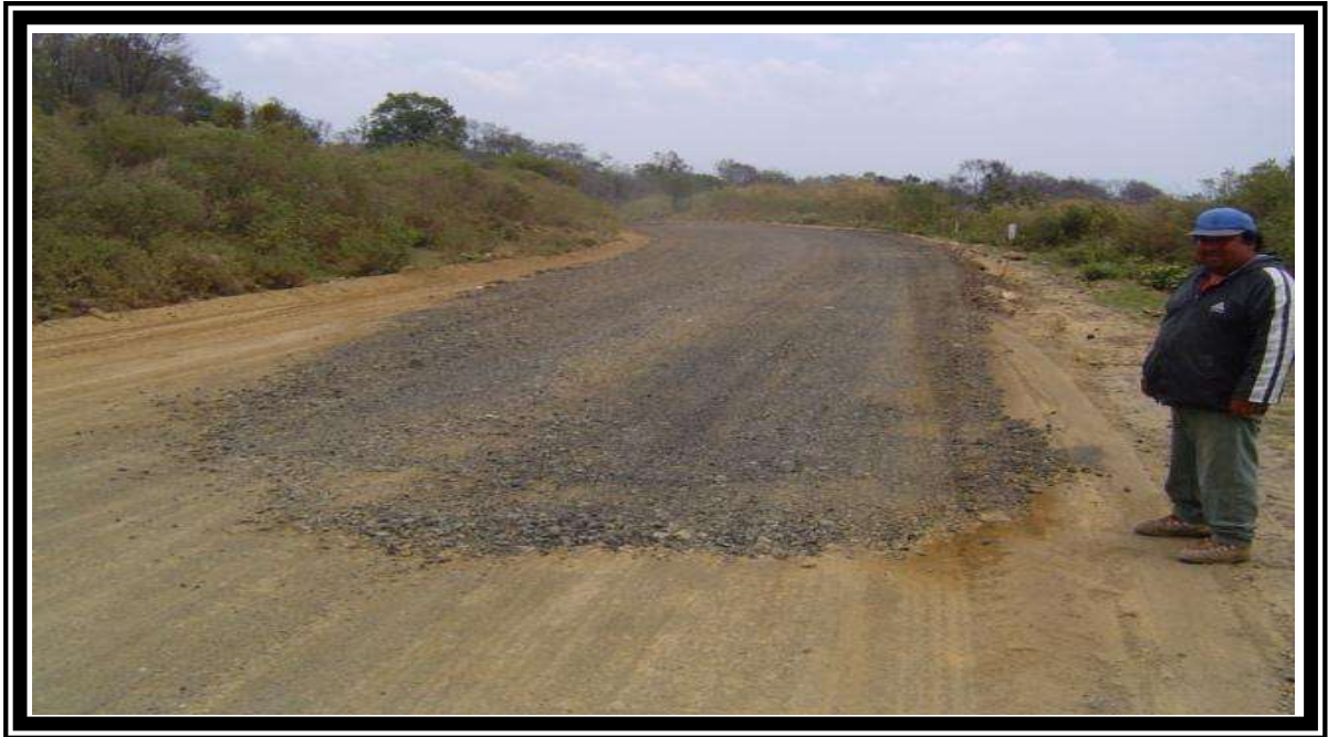
FOTO No.11 CONSTRUCCION DE LA CAPA SUBRASANTE.
