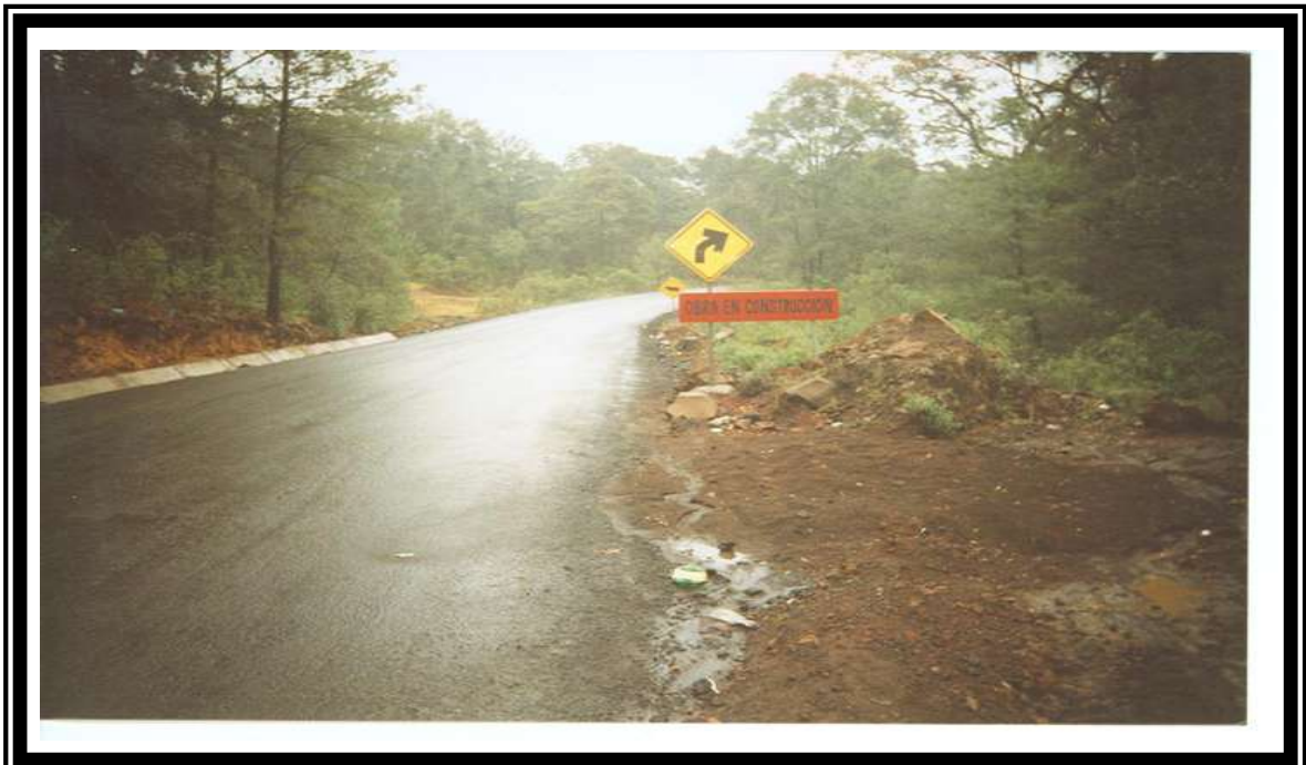
FOTO No.28 CAMINO TERMINADO CON RIEGO DE SELLO, CUNETAS Y SEÑALAMIENTO.
