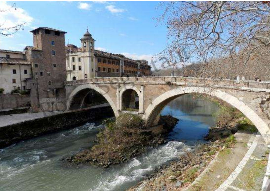
Fig. 2.1-2. Puente Fabricio, Roma, Italia [27].
