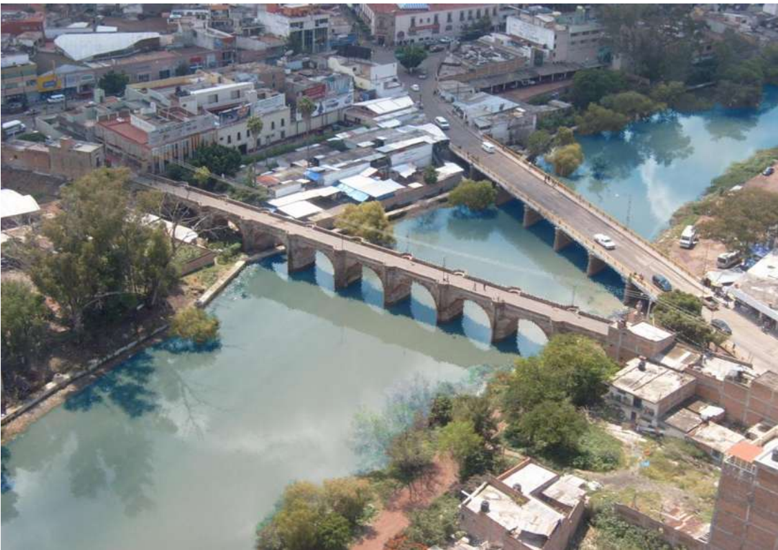
Fig. 2.4-4. Puente Cavadas, la Piedad, Michoacán (Fuente: Google).
