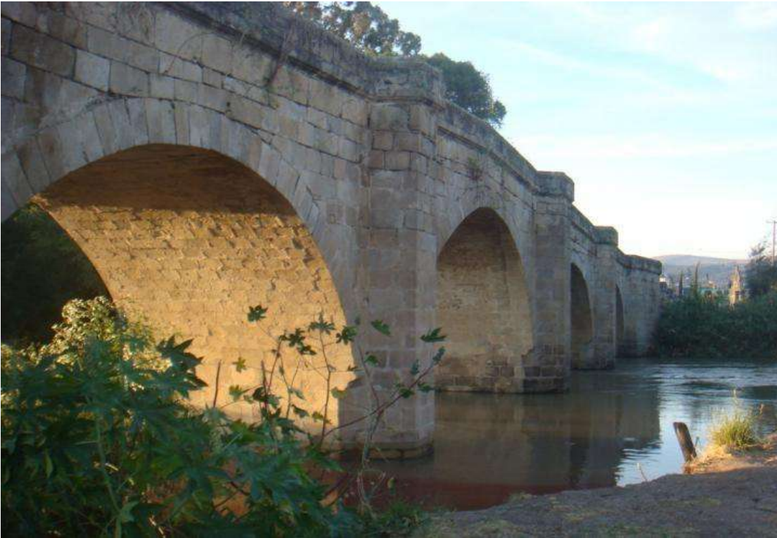
Fig. 2.2-1. El puente de Acámbaro, Guanajuato (Fuente: Google).
