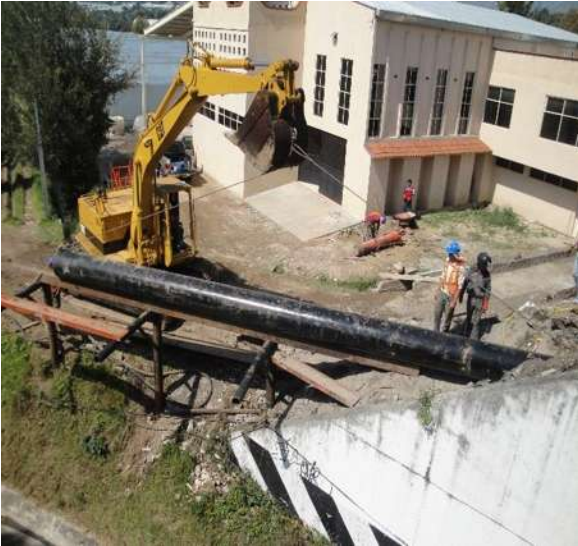
Imagen VII.4.5.9. Tubo montado en viga
