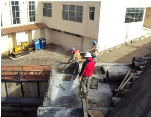
Imagen VII.4.14.13. Lanzado de losa portal Ixtapan
