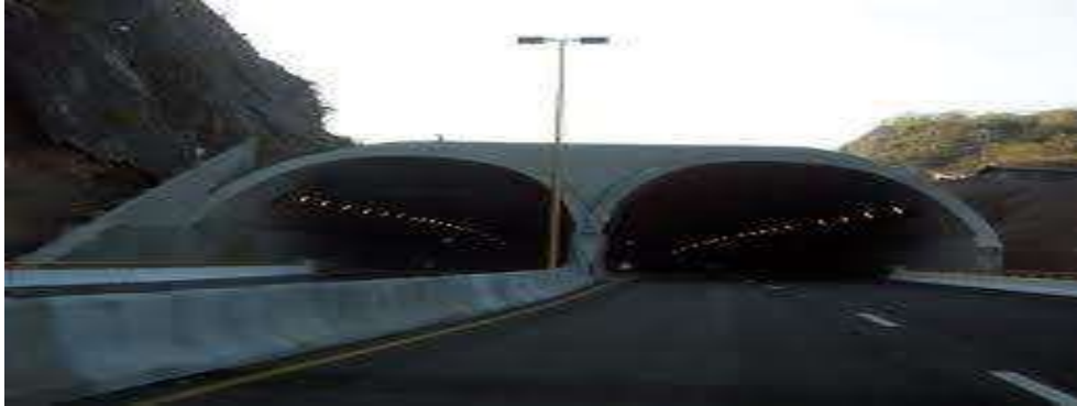
Imagen III.2.2.1. Túnel Zumpango del rio (Chilpancingo, Guerrero)
