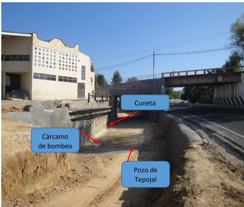
Imagen VII.4.25.1. Portal Ixtapan de la sal detalles provisionales
