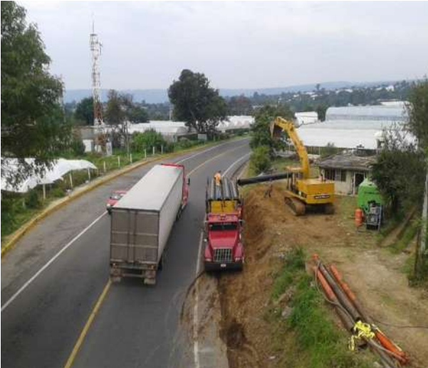
Imagen VII.4.5.6. Descarga de tubería
