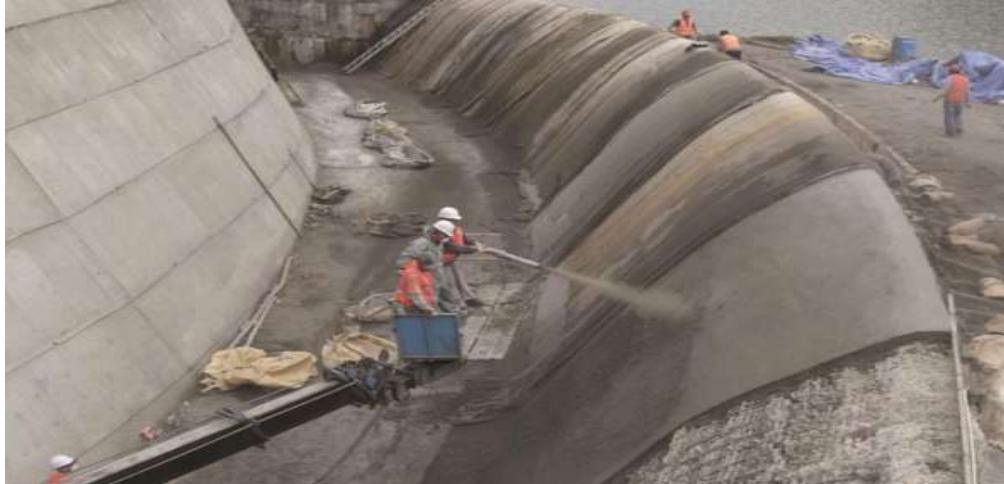
Imagen VII.4.20.4. Lanzado en muros
