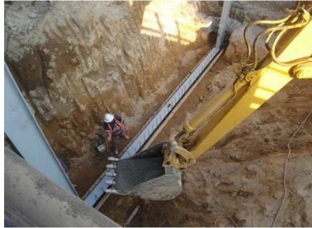
Imagen VII.4.9.20. Colado de contratrabe
