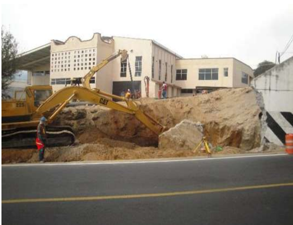
Imagen VII.4.5.17. Excavación en trinchera
