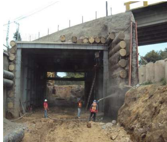
Imagen VII.4.15.10. Portal Ixtapan (lanzado)
