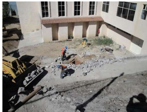
Imagen VII.4.6.6. Demolición de muro
