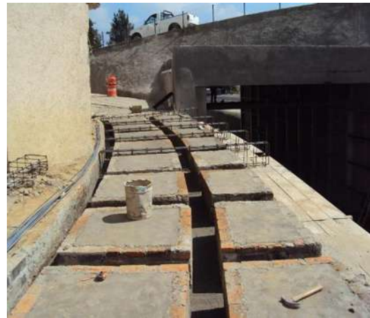
Imagen VII.4.22.7. Excavación traves y diafragmas
