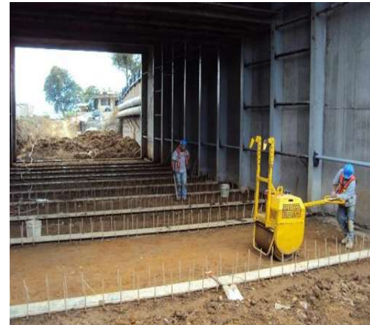
Imagen VII.4.17.9. Compactación de terreno
