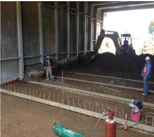
Imagen VII.4.17.8. Limpieza de módulos
