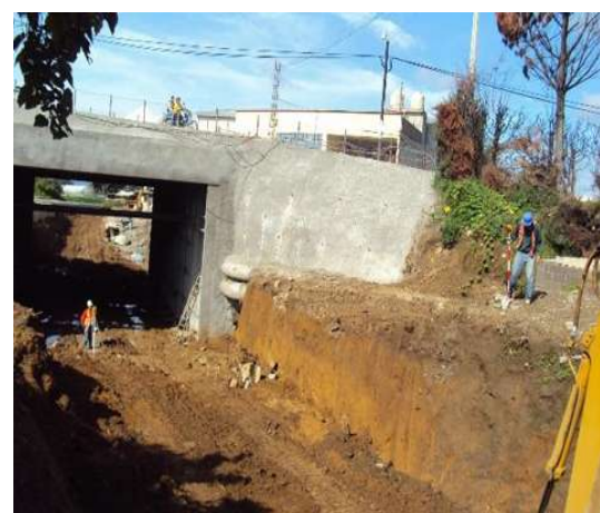
Imagen VII.4.16.16. Trazando perfil de corte
