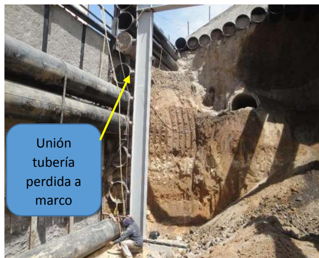
Imagen VII.4.9.23. Unión de laterales a marco
