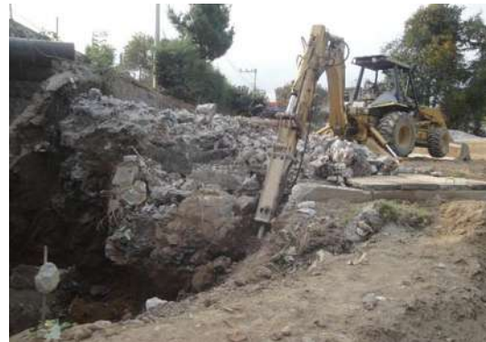
Imagen VII.4.13.2. Demolición de cajas
