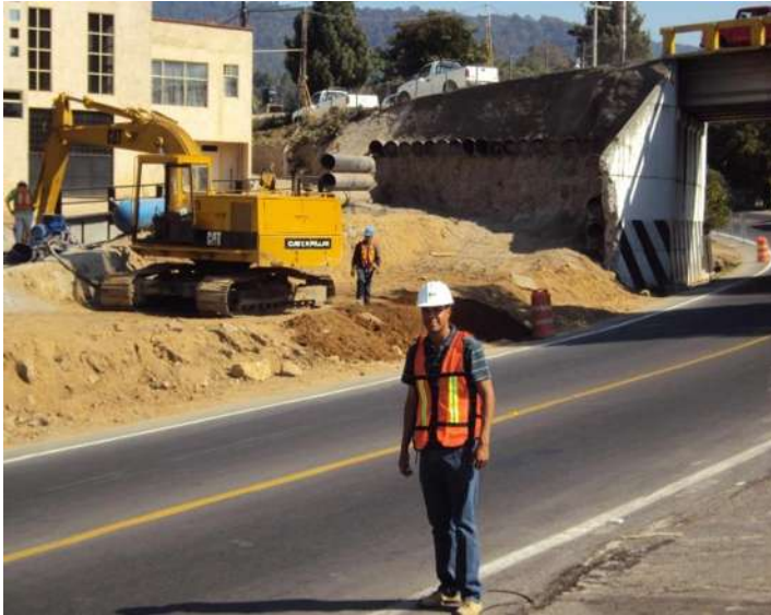
Imagen VII.4.8.1. Comienzo de excavación
