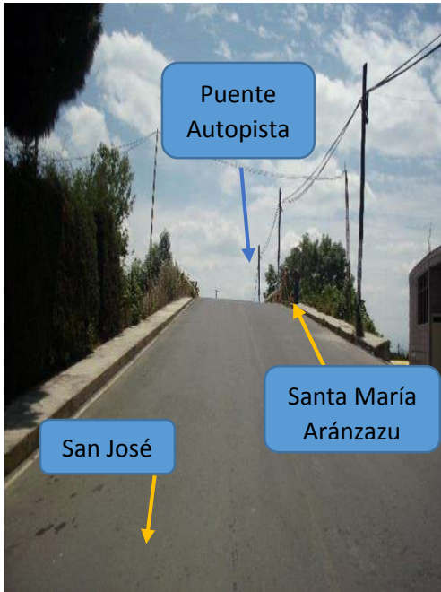
Imagen VII.4.1.4. Paso superior del túnel
