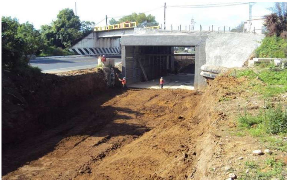
Imagen VII.4.17.22. Piso terminado en túnel
