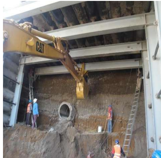
Imagen VII.4.10.8. Cuerno adaptado en Excavadora para colocar vigas.
