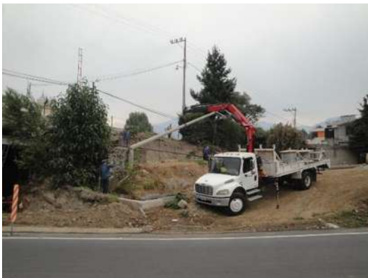
Imagen VII.4.12.5. Retirando poste
