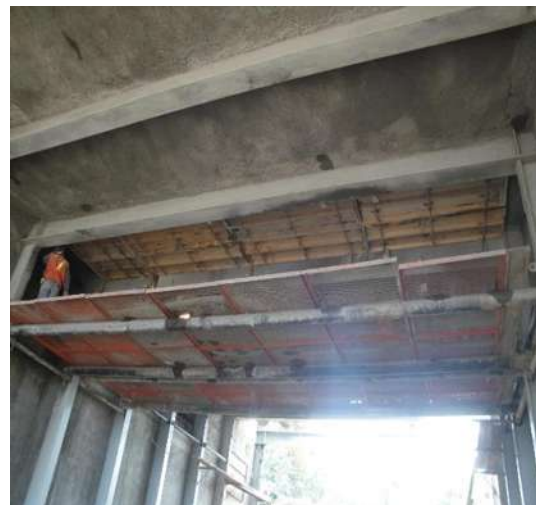
Imagen VII.4.14.16. Cimbrado en losa interior
