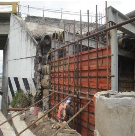
Imagen VII.4.13.11. Troquelado de muro
