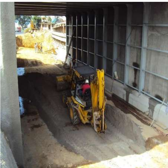
Imagen VII.4.23.3. Homogenizando del material
