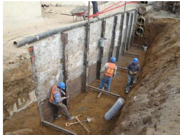
Imagen VII.4.6.9. Repellado de muros
