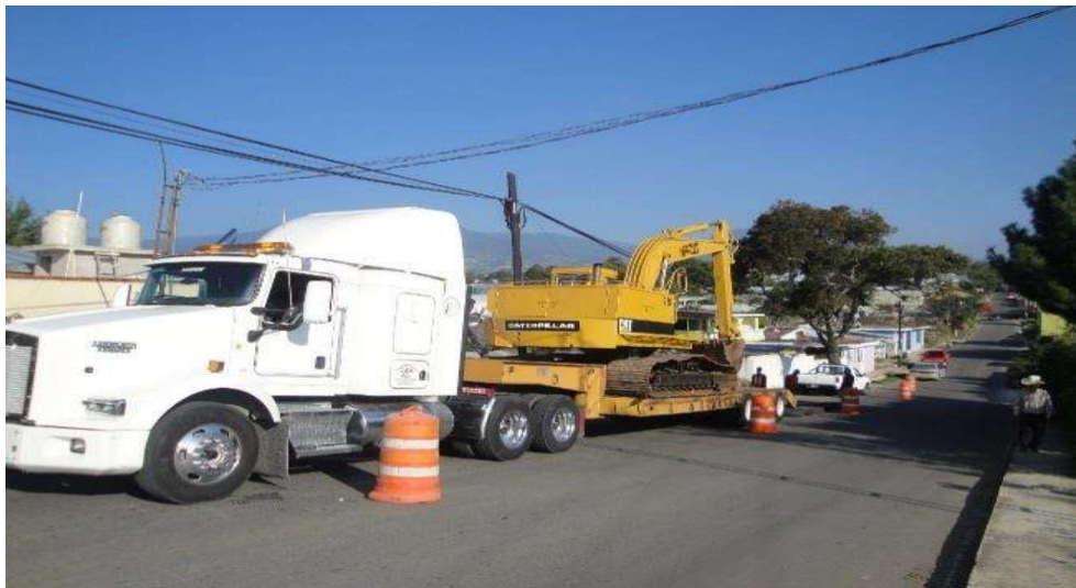
Imagen VII.4.3.1. Llegada de la Excavadora Cat 225
