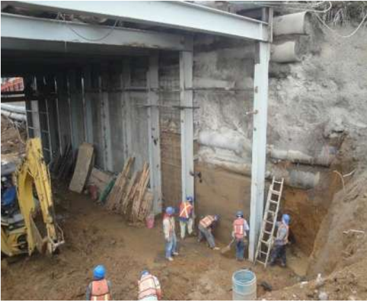
Imagen VII.4.13.7. Armado de últimos muros
