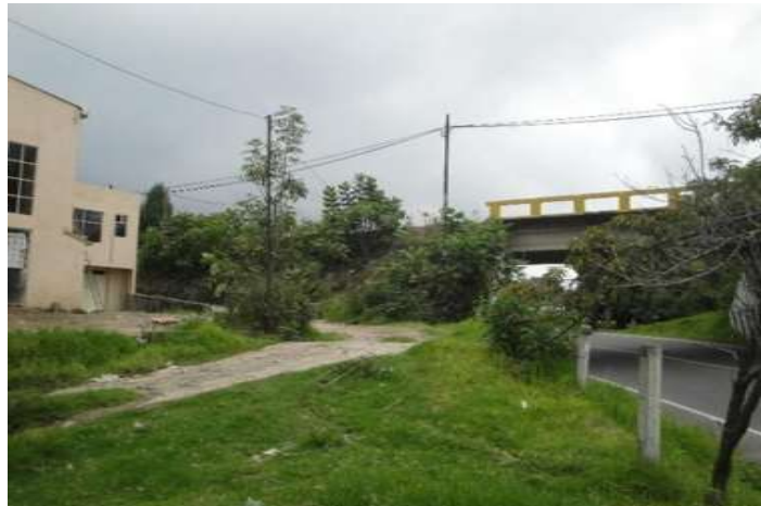
Imagen VII.4.1.2. Levantamiento topográfico del portal Ixtapan
