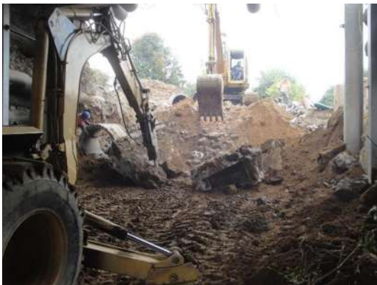
Imagen VII.4.13.3. Retirando tubería y caja
