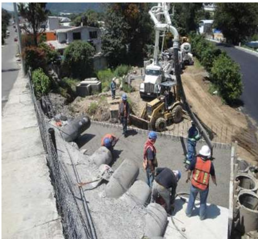
Imagen VII.4.14.21. Concreto portal Tenango
