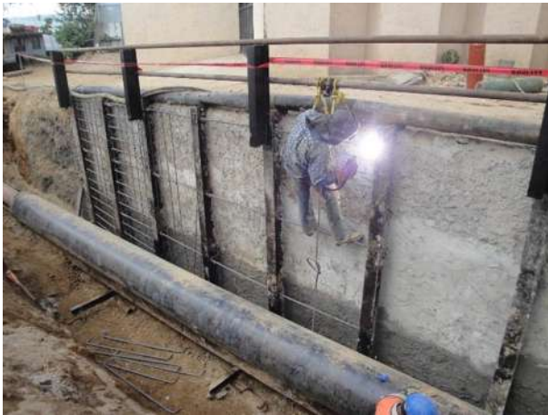
Imagen VII.4.6.11. Armado en muros
