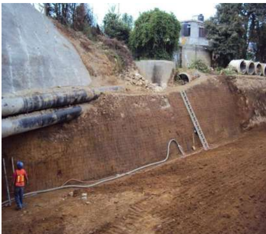
Imagen VII.4.19.8. Colocación de malla 6-6/6x6
