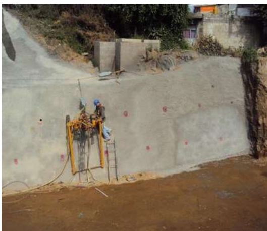
Imagen VII.4.19.10. Perforación para anclas (stenuick)
