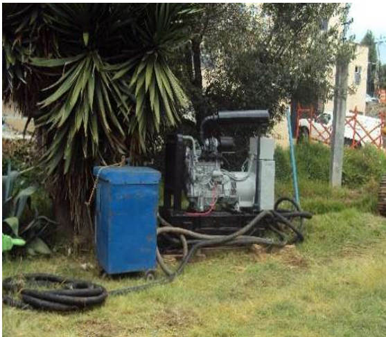
Imagen VII.4.3.4. Generador y planta de soldar
