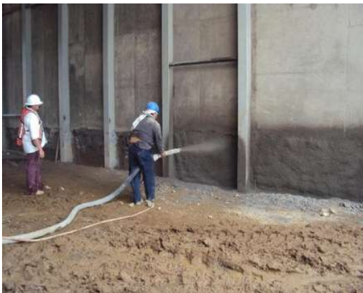
Imagen VII.4.17.4. Lanzado en muros de demolición
