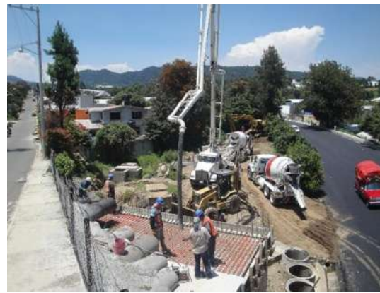
Imagen VII.4.14.20. Colado de losa
