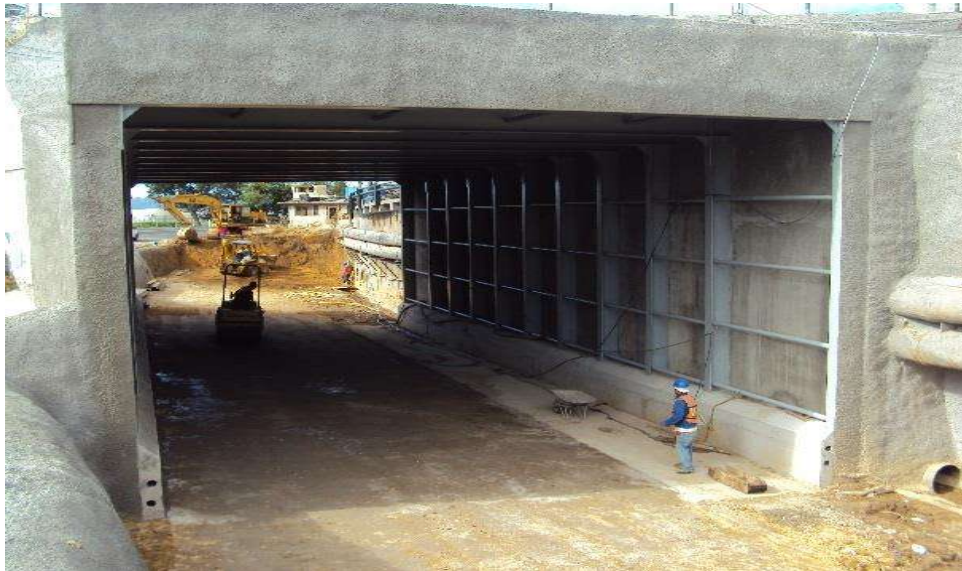
Imagen VII.4.23.5. Compactación de la última capa
