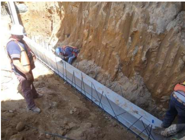
Imagen VII.4.9.16. Conexión viga-columna
