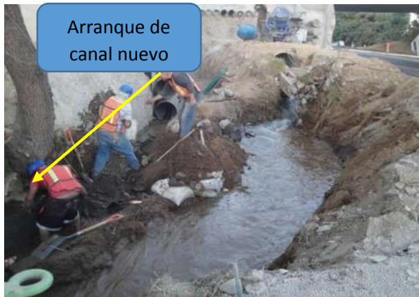
Imagen VII.4.7.3. Cambio de descarga
