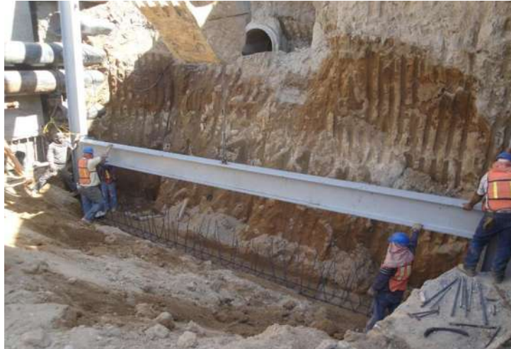
Imagen VII.4.9.14. Colocación de rastra V-2
