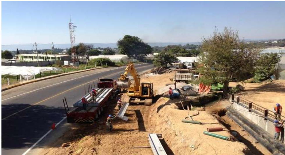
Imagen VII.4.9.2. Llegada de marcos para empotramiento
