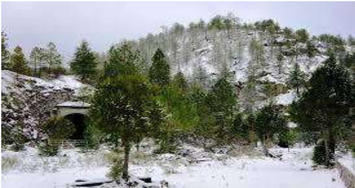
Imagen II.4.6. Túnel la Cumbre (Chihuahua)
