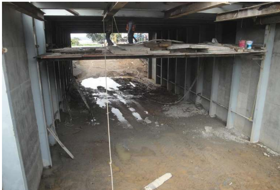
Imagen VII.4.13.17. Ciclo de excavación y muros colados concluido
