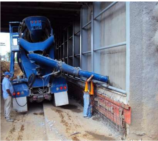
Imagen VII.4.18.5. Colado de relleno fluido
