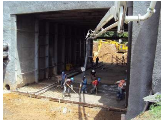
Imagen VII.4.17.21. Colado de marcos 3-1
