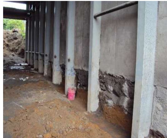
Imagen VII.4.17.3. Zapata demolida
