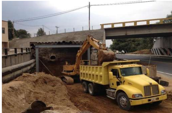
Imagen VII.4.10.2. Acarreo material de túnel
