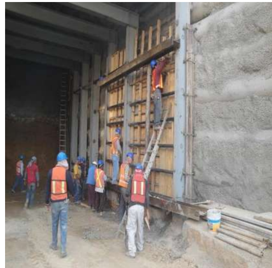
Imagen VII.4.11.14. Vibrado del concreto
