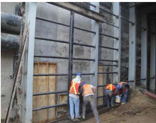
Imagen VII.4.11.15. Descimbrado y curado de muros
