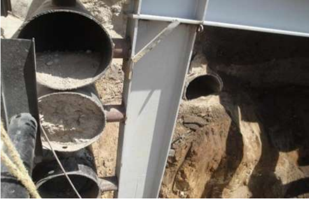
Imagen VII.4.9.24. Tacones de fijación
