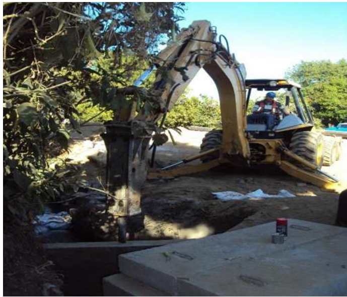
Imagen VII.4.7.10. Demolición de muro de canal
