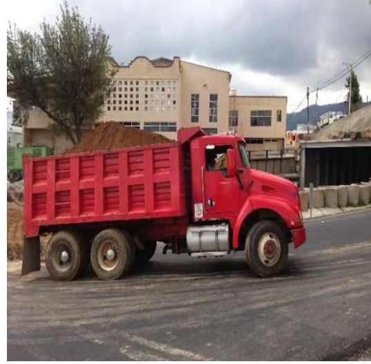
Imagen VII.4.16.10. Camión saliendo de obra
