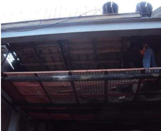
Imagen VII.4.14.11. Cimbra para losa
