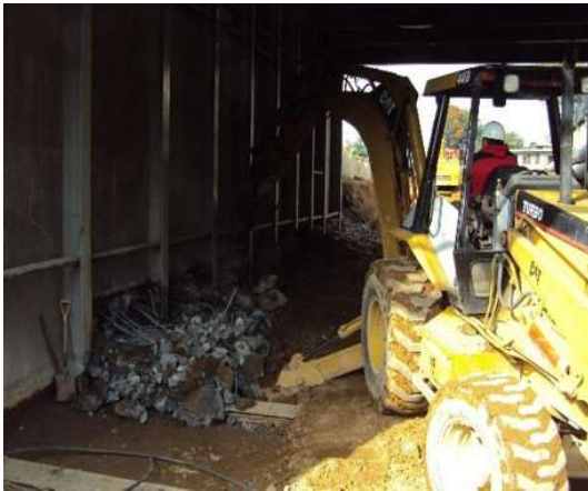
Imagen VII.4.17.2. Demolición de zapata
