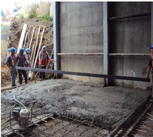
Imagen VII.4.17.14. Colado de piso marco 11- 9
