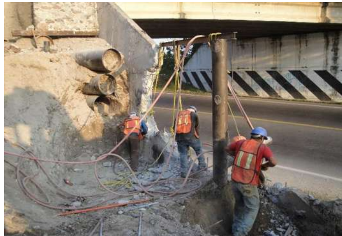
Imagen VII.4.5.13. Demolición alerón
