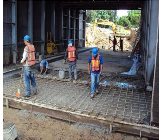
Imagen VII.4.17.19. Armado del marco 3-1
