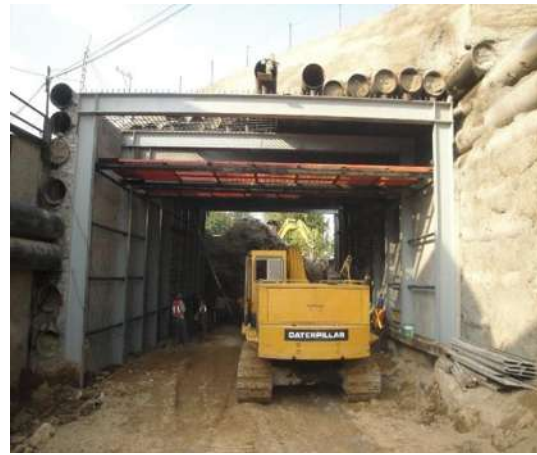
Imagen VII.4.14.6. Colocación de andamios
