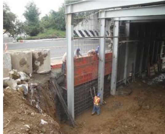
Imagen VII.4.13.8. Cimbrado muros autopista
