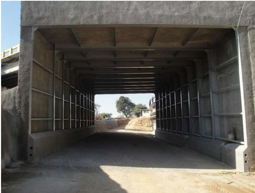
Imagen VII.4.25.3. Interior del túnel terminado
