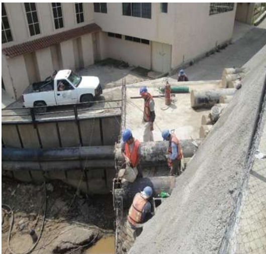
Imagen VII.4.15.5. Llenado tubería superior
