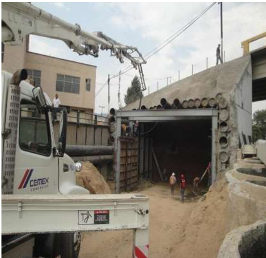
Imagen VII.4.11.13. Colado muros L. Izquierdo
