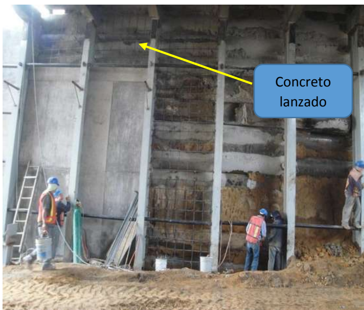
Imagen VII.4.11.17. Armado para siguientes muros
