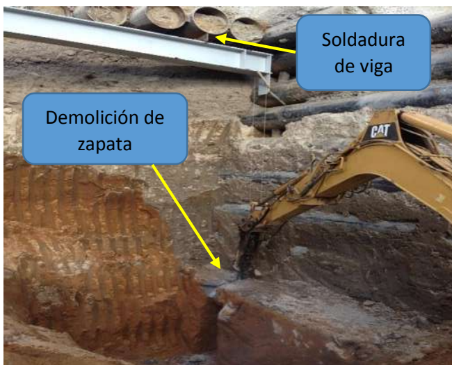
Imagen VII.4.9.5. Demolición de zapata
