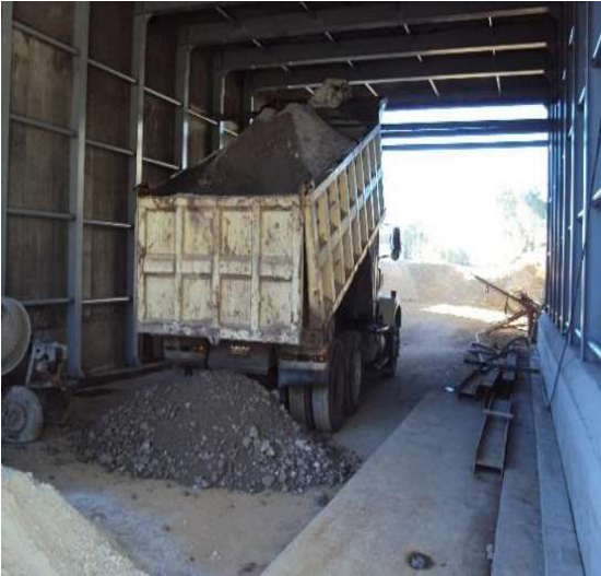
Imagen VII.4.23.1. Llegada de la base hidráulica
