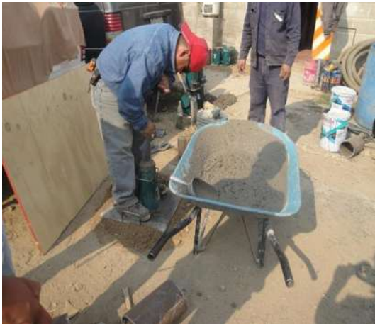
Imagen VII.4.11.11. Prueba de revenimiento
