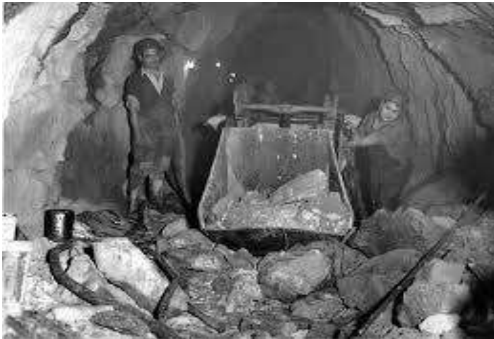
Imagen II.4.11. Rezagadora de material
