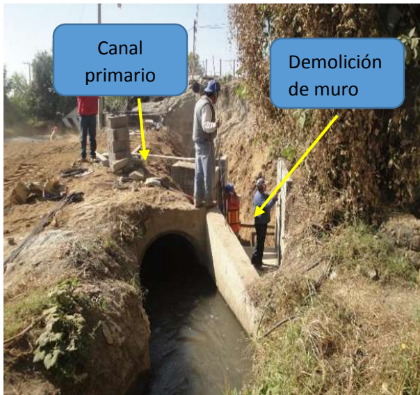
Imagen VII.4.7.6. Construcción de caja
