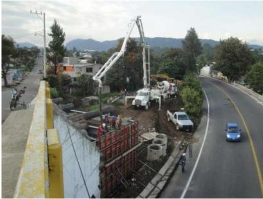
Imagen VII.4.13.13. Colado de último muro
