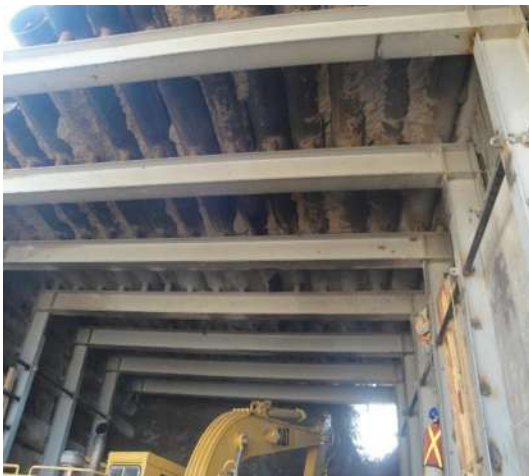
Imagen VII.4.14.7. Tubería cargando en Vigas V-1
