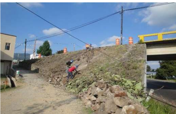
Imagen VII.4.2.5. Talud limpio para hincado de tubería
