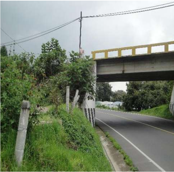
Imagen VII.4.2.1. Lugar de construcción de túnel
