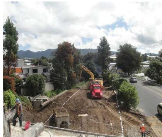
Imagen VII.4.16.6. Trazo de excavación Tenango
