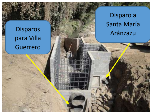
Imagen VII.4.7.7. Armado de caja provisional
