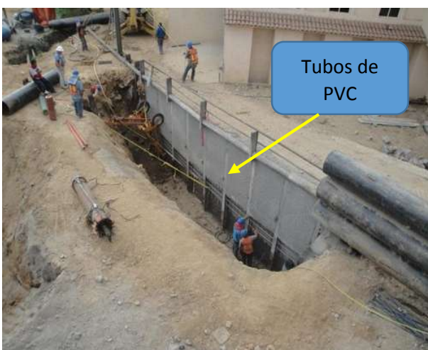
Imagen VII.4.6.13. Muros lanzados
