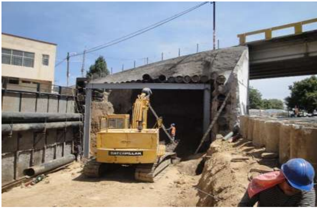
Imagen VII.4.9.10. Vigas verticales C-1
