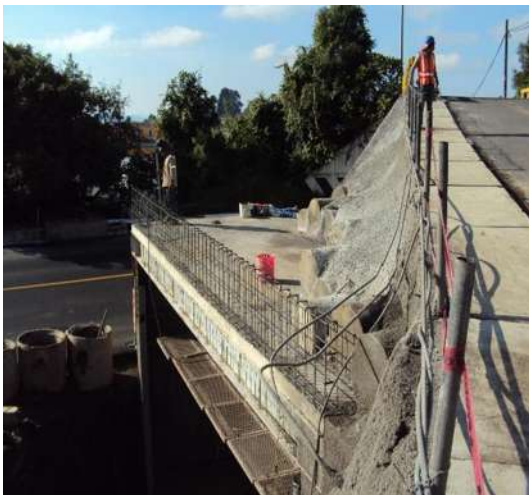
Imagen VII.4.15.7. Armado de contrafuerte Tenango
