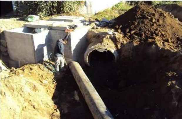
Imagen VII.4.7.12. Excavación para limpieza
