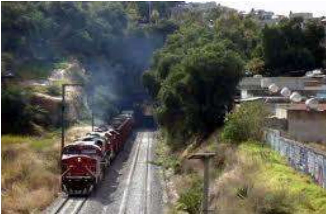
Imagen II.4.4. Túnel ferroviario “Barrientos”
