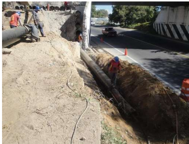
Imagen VII.4.5.16. Hincado lateral derecho
