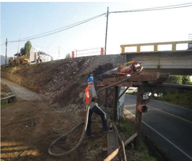
Imagen VII.4.5.11. Hincando tubería con Koloss
