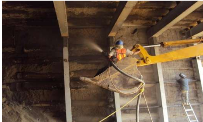
Imagen VII.4.11.16. Concreto lanzado a muros del túnel
