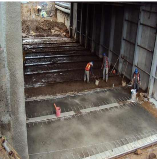
Imagen VII.4.17.10. Colocación de plantilla
