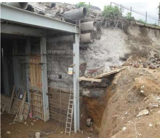
Imagen VII.4.13.9. Cimbrado en madera
