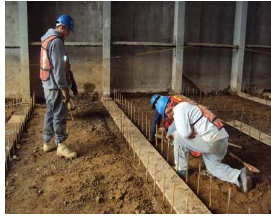
Imagen VII.4.17.5. Limpieza del acero
