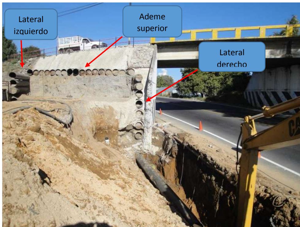
Imagen VII.4.5.19. Ademe de tubería perdida
