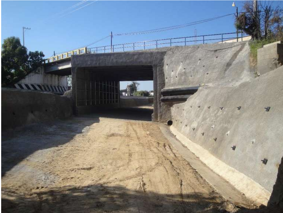
Imagen VII.4.25.4. Portal Tenango terminado
