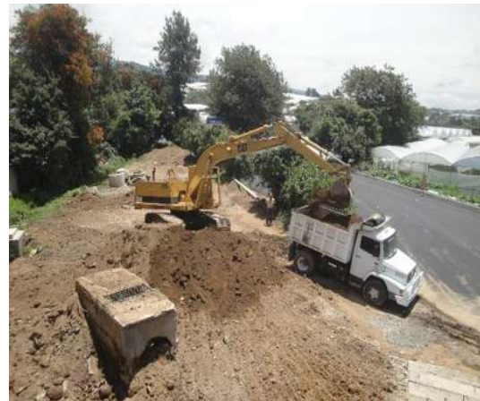
Imagen VII.4.16.2. Excavación portal Tenango
