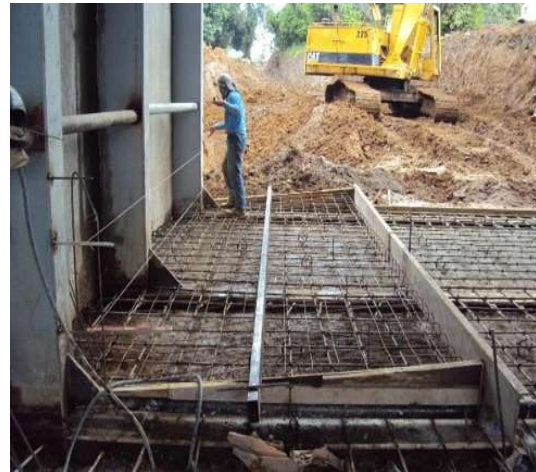
Imagen VII.4.17.13. Armado de piso 2 módulos
