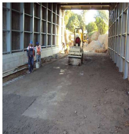
Imagen VII.4.23.4. Compactación de la primera capa
