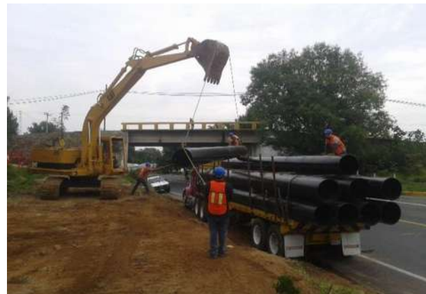
Imagen VII.4.5.7. Almacenaje de tubería
