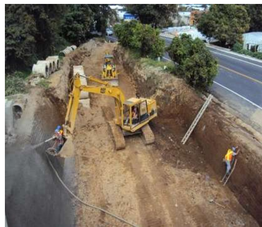
Imagen VII.4.19.9. Lanzado L.I. portal Tenango
