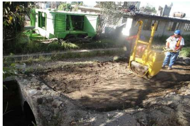
Imagen VII.4.6.3. Compactación de material
