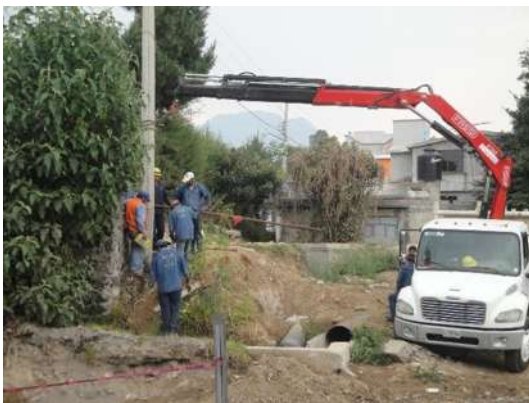
Imagen VII.4.12.3. Grúa sujetando poste
