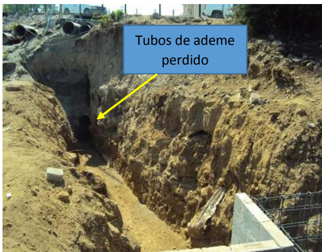
Imagen VII.4.7.8. Excavación para tubos
