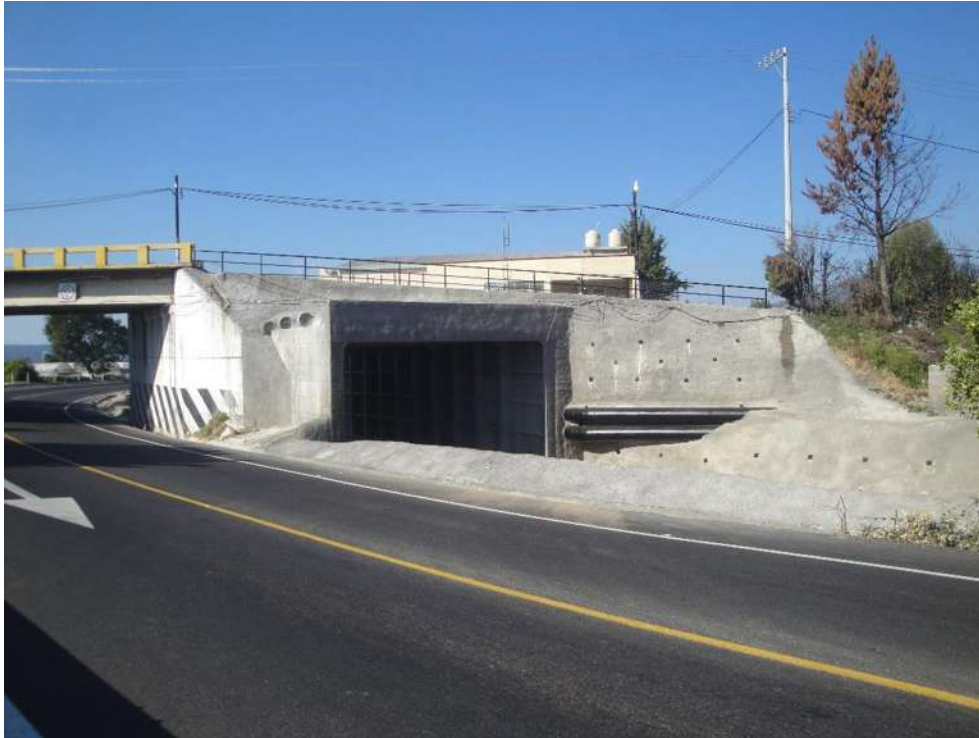
Imagen VII.4.24.6. Vista de autopista portal Tenango
