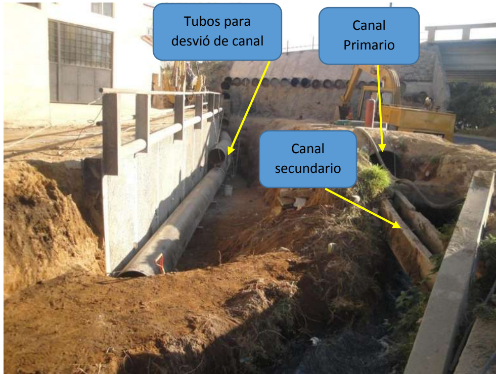
Imagen VII.4.7.1. Desvío de canal primario
