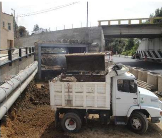
Imagen VII.4.16.1. Excavación portal Ixtapan
