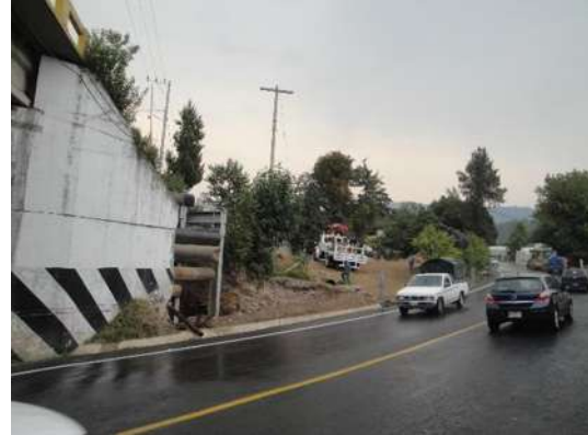
Imagen VII.4.12.2. Poste portal Tenango
