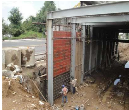
Imagen VII.4.13.10. Cimbrado metálico
