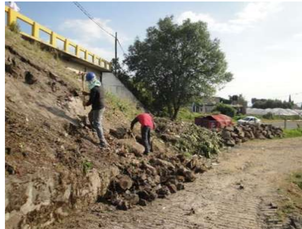
Imagen VII.4.2.4 Retirando piedra de talud
