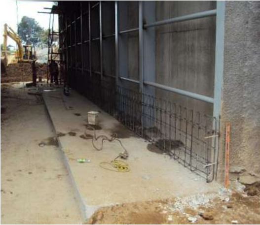
Imagen VII.4.18.3. Armado de guarnición
