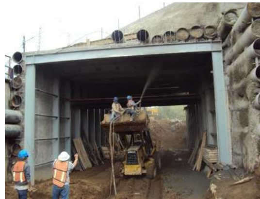
Imagen VII.4.14.14. Afine en losa superior
