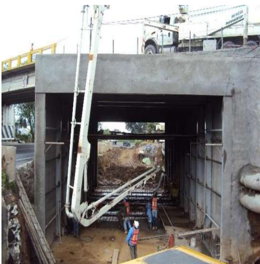
Imagen VII.4.17.16. Colando piso con bomba
