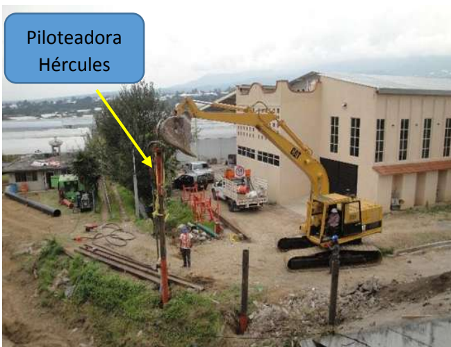
Imagen VII.4.5.8. Hincado de tubos 10"
