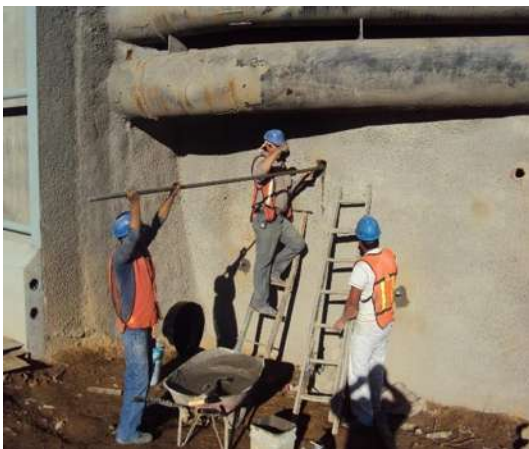
Imagen VII.4.19.16. Colocación de anclas e inyectado
