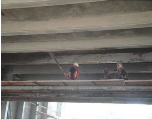
Imagen VII.4.14.17. Afine losa interior
