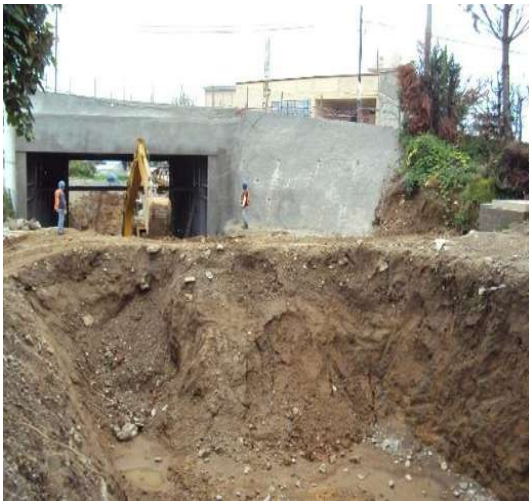
Imagen VII.4.16.11. Excavación casi terminada
