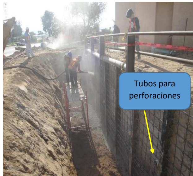
Imagen VII.4.6.12. Lanzado de concreto
