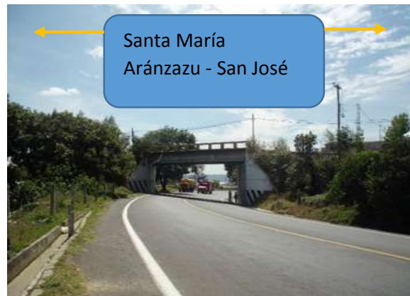
Imagen VII.4.1.5. Autopista Tenango-Ixtapan de la Sal
