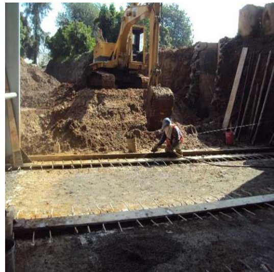
Imagen VII.4.17.11. Sopleteado de vigas y acero
