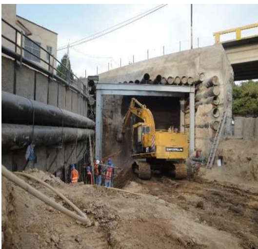
Imagen VII.4.10.5. Excavación con bote invertido
