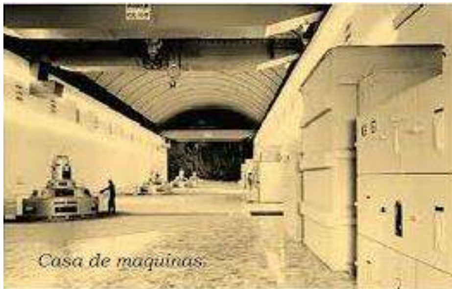
Imagen II.4.7. Casa de Maquinas el Cóbano
