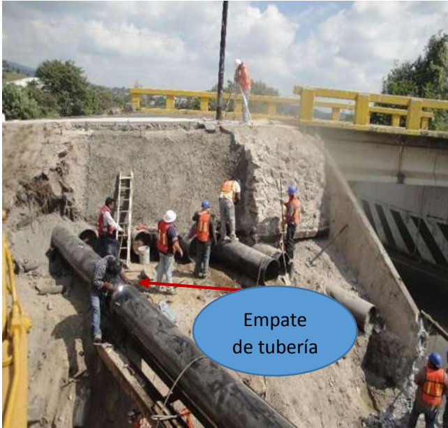
Imagen VII.4.5.12. Empate de tubería
