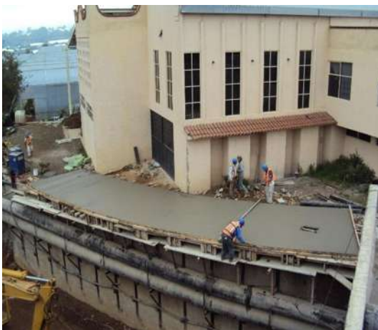
Imagen VII.4.22.10. Colado de voladizo
