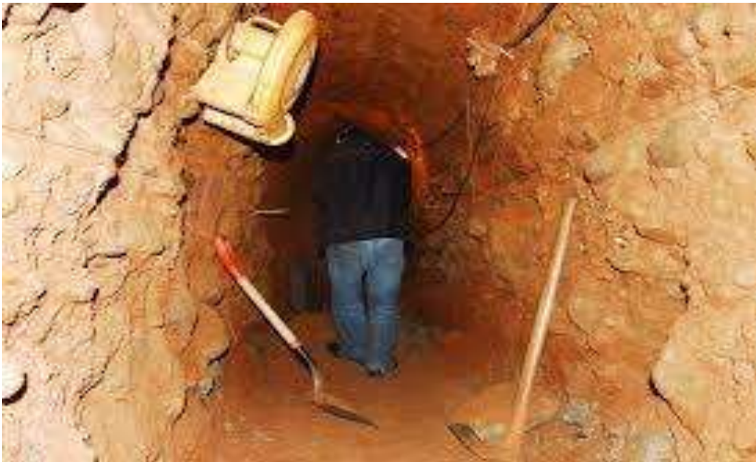
Imagen II.4.8. Excavación a pala y pico de túnel
