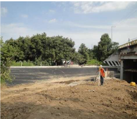
Imagen VII.4.16.3. Levantamiento topográfico
