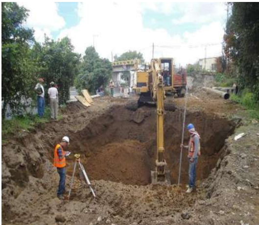
Imagen VII.4.16.7. Niveles de Excavación
