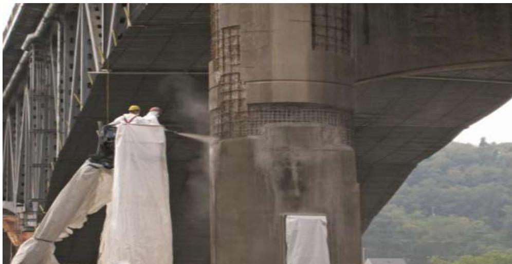
Imagen VII.4.20.3. Lanzado en pilas de concreto
