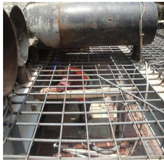
Imagen VII.4.14.10. Colocación de cimbra
