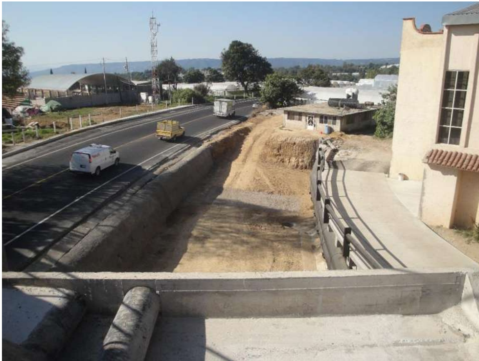
Imagen VII.4.24.7. Vista de puente para portal Ixtapan
