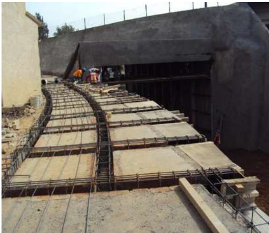
Imagen VII.4.22.8. Colocación de traves y diafragmas
