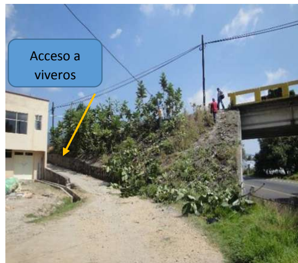
Imagen VII.4.2.2. Corte de hierba en talud
