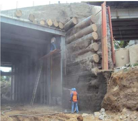
Imagen VII.4.15.11. Lanzado de tubos y columna
