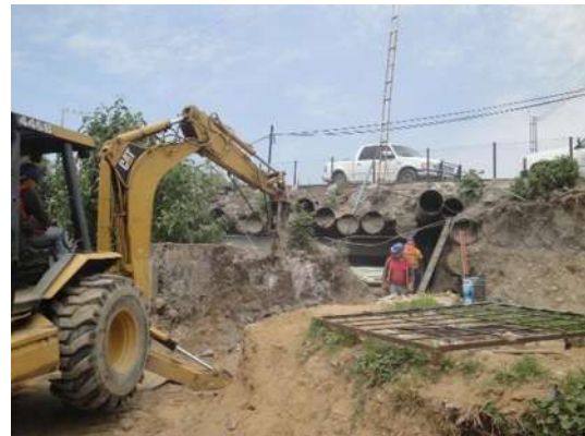
Imagen VII.4.12.6. Demolición de caja y poste
