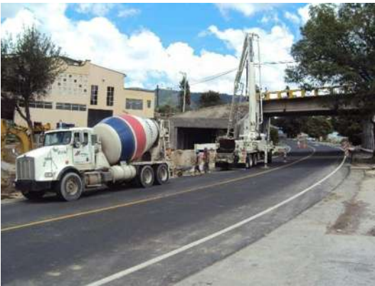
Imagen VII.4.17.20. Bomba en la autopista colando
