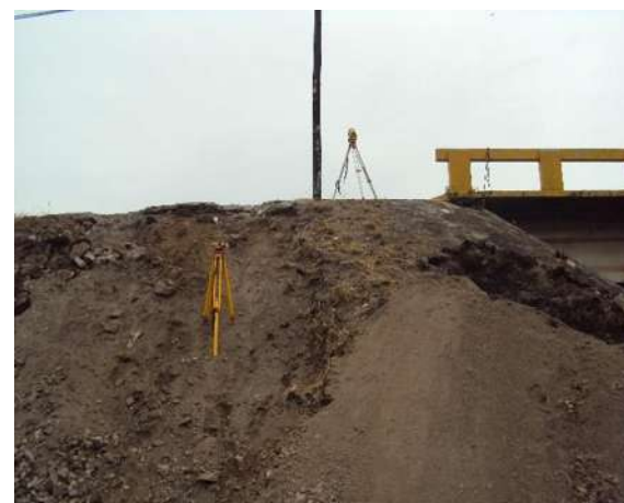
Imagen VII.4.4.4. Línea y nivel de tubo
