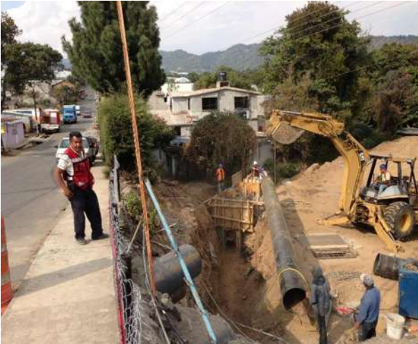
Imagen VII.4.7.9. Colocación de tubos
