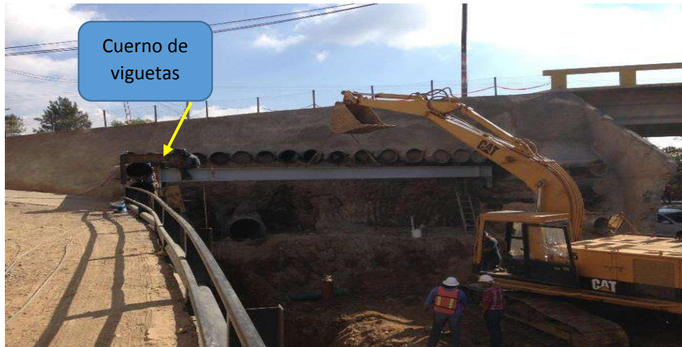
Imagen VII.4.9.4. Colocación de viga de acero V-1
