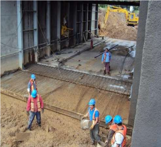
Imagen VII.4.17.18. Piso colado de marco 11-3
