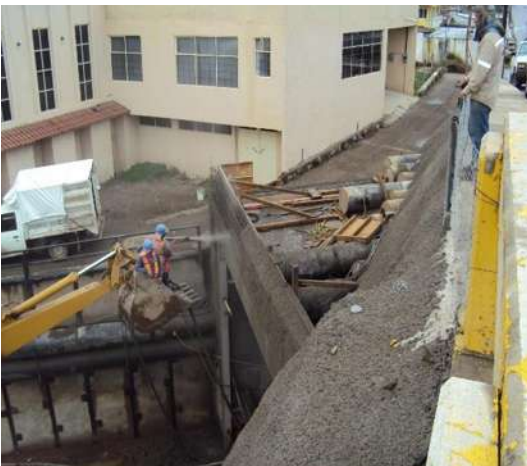
Imagen VII.4.15.13. Muro Ixtapan (lanzado)
