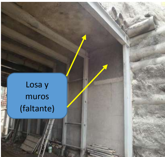
Imagen VII.4.14.15. Lanzado en losa y muros
