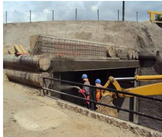
Imagen VII.4.15.12. Lanzado de V-1 y armado
