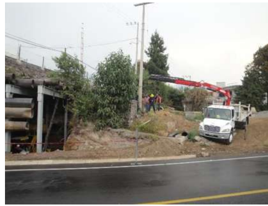
Imagen VII.4.12.4. Demolición de poste
