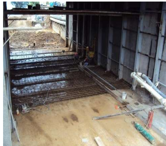
Imagen VII.4.17.15. Piso colado 2 módulos
