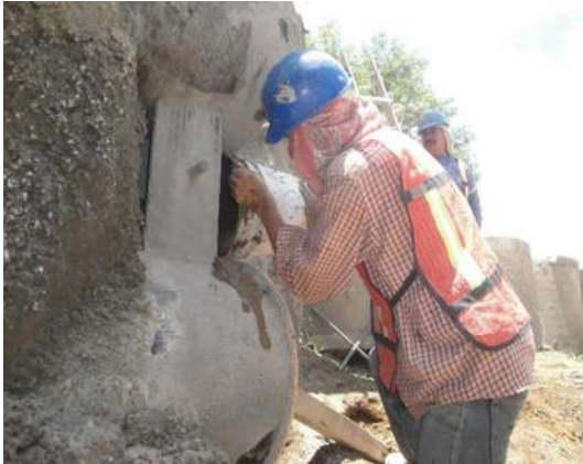
Imagen VII.4.15.3. Llenado de tubos suelo-cemento
