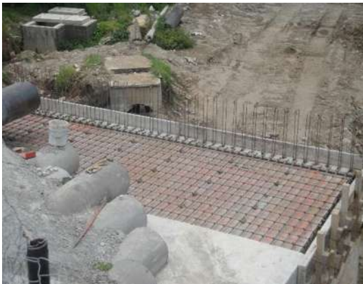
Imagen VII.4.14.19. Armado losa marco 10-11
