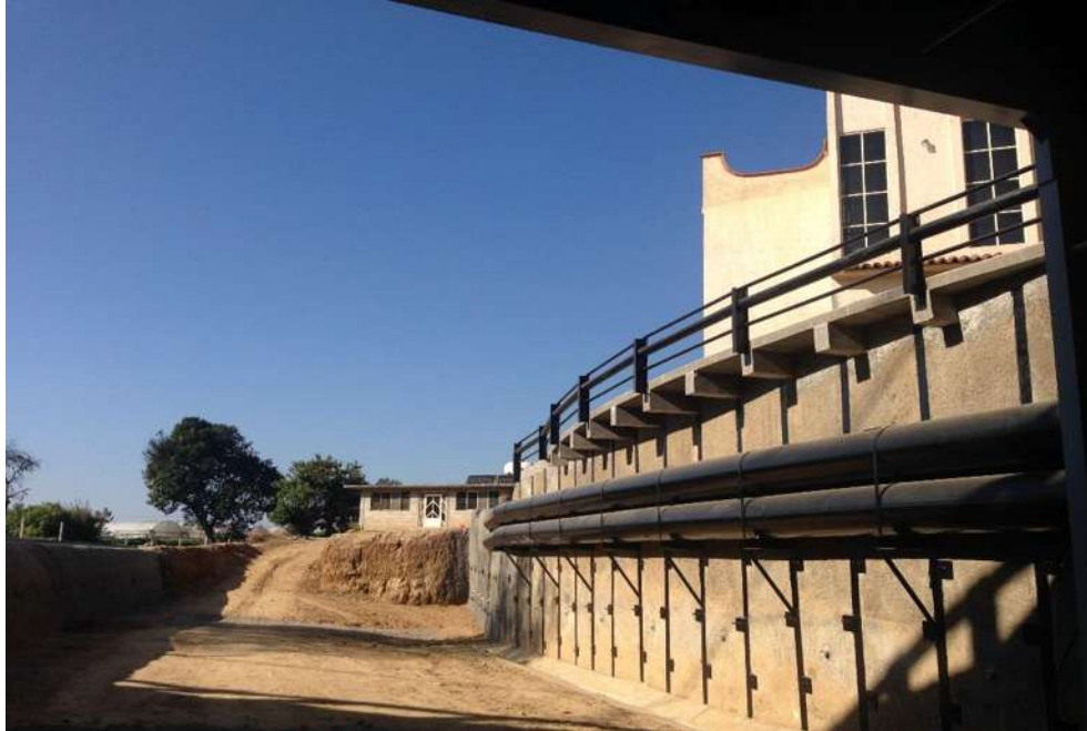
Imagen VII.4.24.8. Vista de voladizo en acceso a invernaderos
