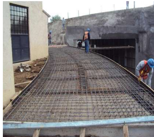
Imagen VII.4.22.9. Colocación de acero para losa
