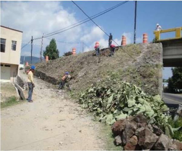
Imagen VII.4.2.3. Limpieza del portal Ixtapan
