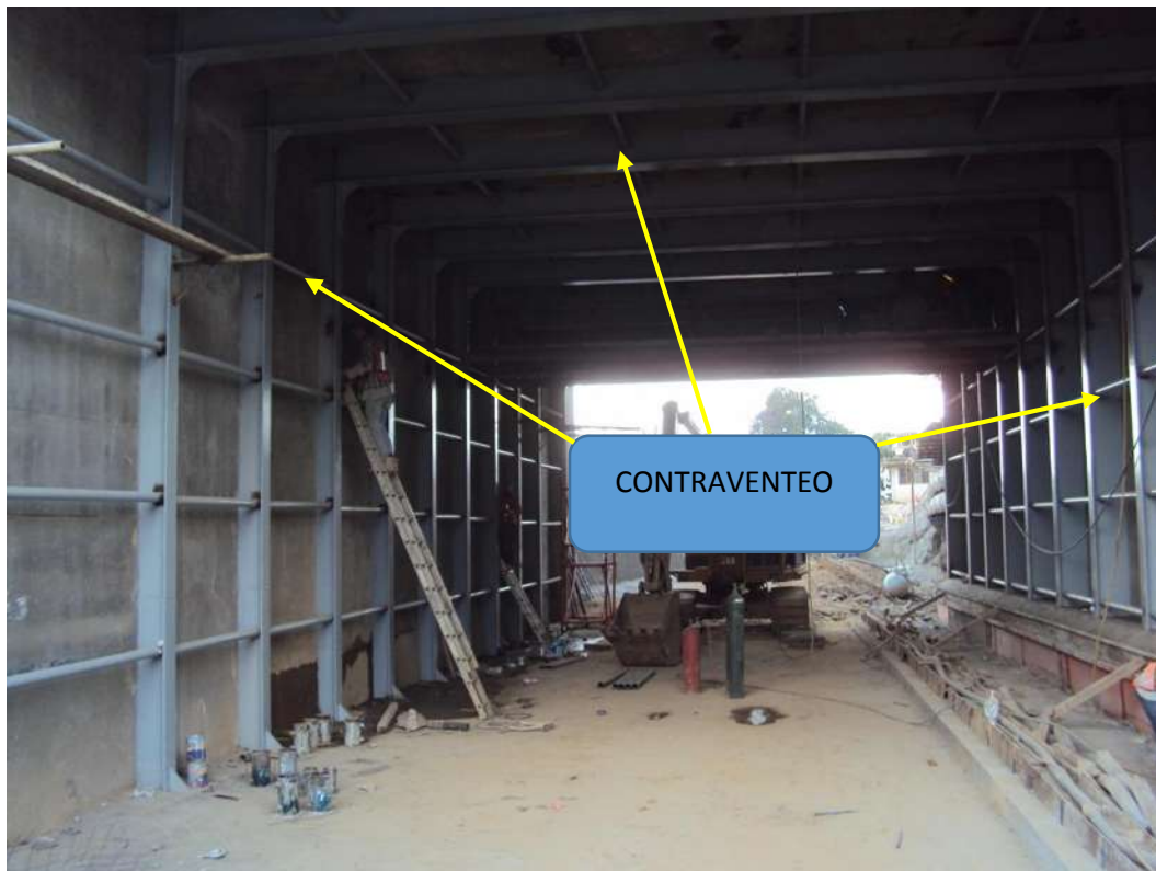
Imagen VII.4.21.2. Contraventeo en el interior de túnel.
