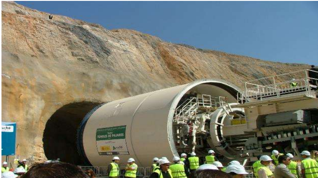
Imagen IV.4.3.3. Escudo para revestimiento
