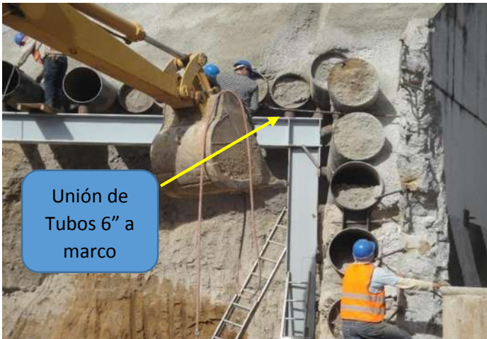
Imagen VII.4.9.22. Fijación de tubos de 6" a marco cerrado
