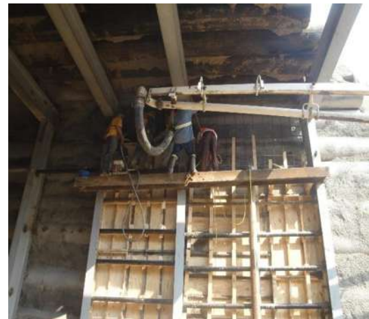
Imagen VII.4.11.10. Colado de muro, Lado
