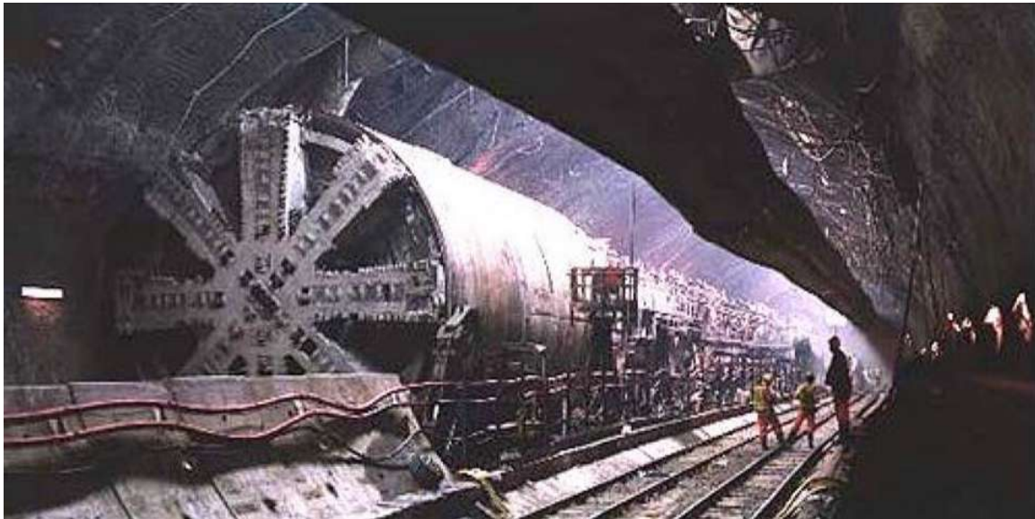
Imagen IV.4.2.7. TBM usada en el canal de la mancha
