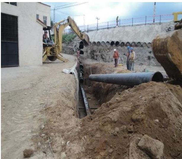
Imagen VII.4.6.10. Hincado lateral izquierdo
