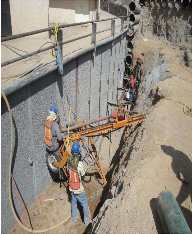
Imagen VII.4.6.14. Perforación para anclas
