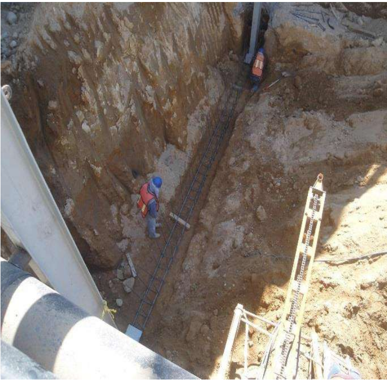
Imagen VII.4.9.13. Armado para rastra (contratrabe)
