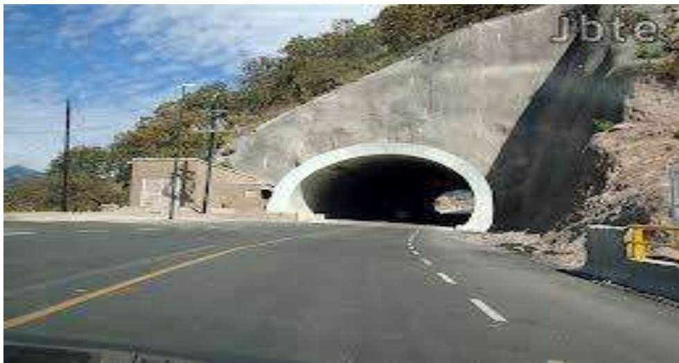
Imagen III.1.1.1. Túnel el sinaloense (Mazatlán, Sinaloa)
