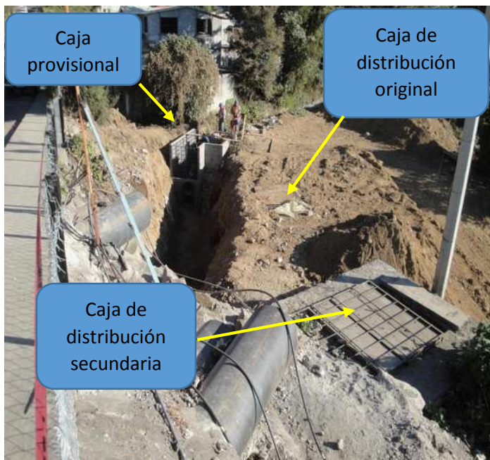
Imagen VII.4.7.5. Construcción de caja de distribución.
