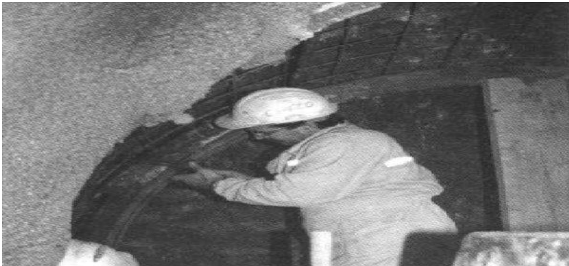
Imagen V.20.1. Sostenimiento mixto (cerchas, mallas y concreto lanzado)
