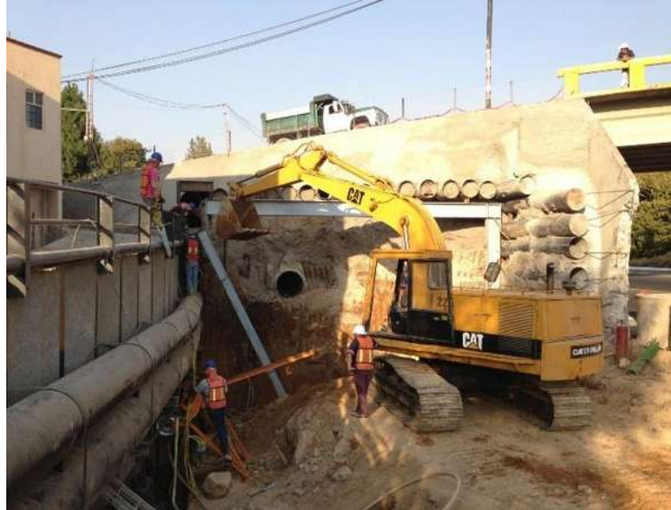
Imagen VII.4.9.9. Colocación de viguetas verticales
