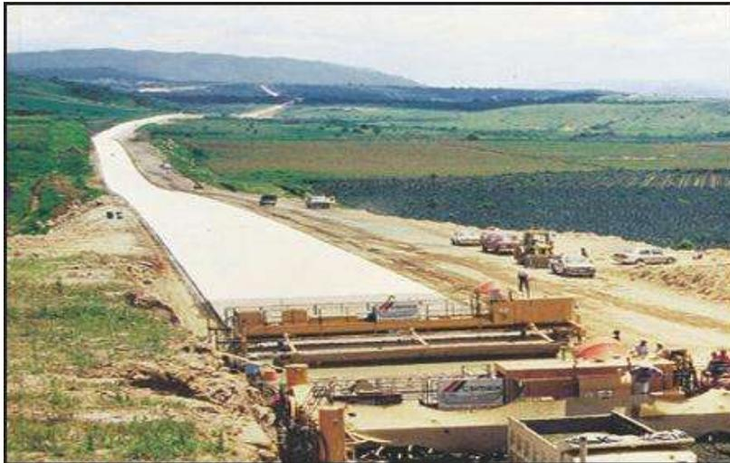
**FIGURA 2. Autopista de concreto hidráulico.**
