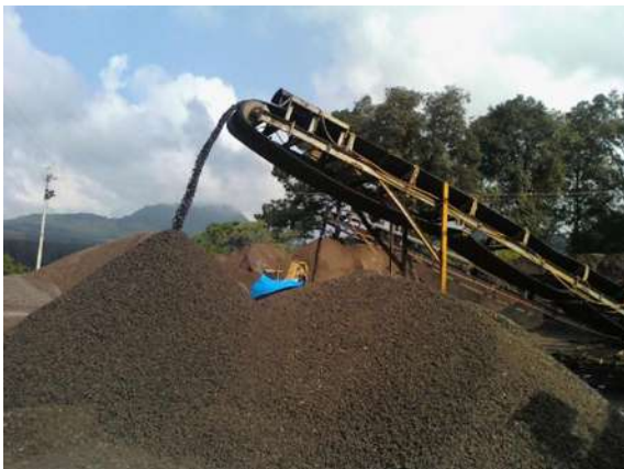
Fig. 2.2.3.- Trituradora de material
