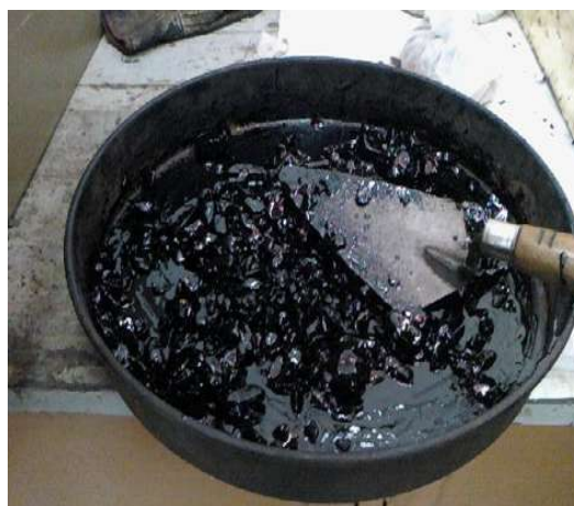
Fig.- 4.2.8. Mezclado del material C.A.
