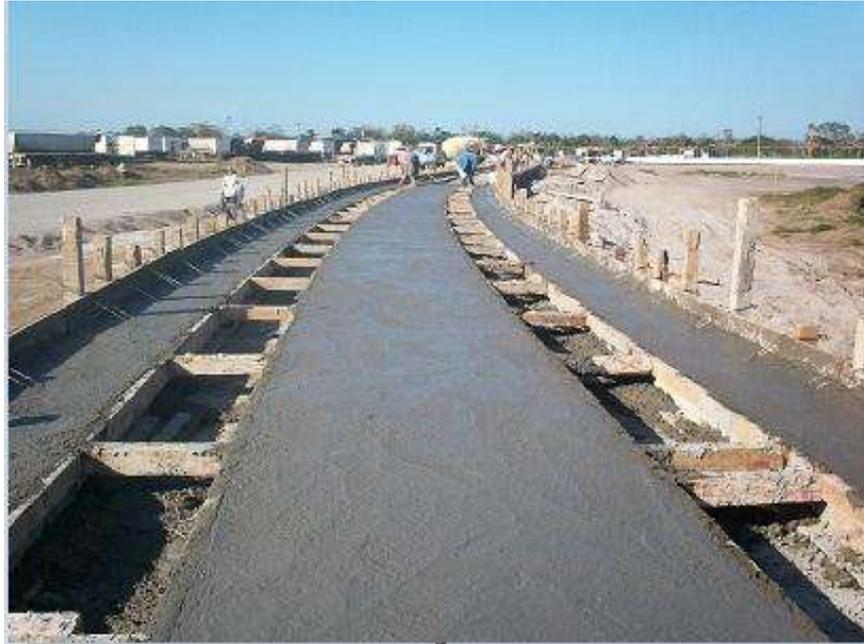
*Colada de concreto hidráulico 350 kg/cm<sup>2</sup>, para la “corona”.*
