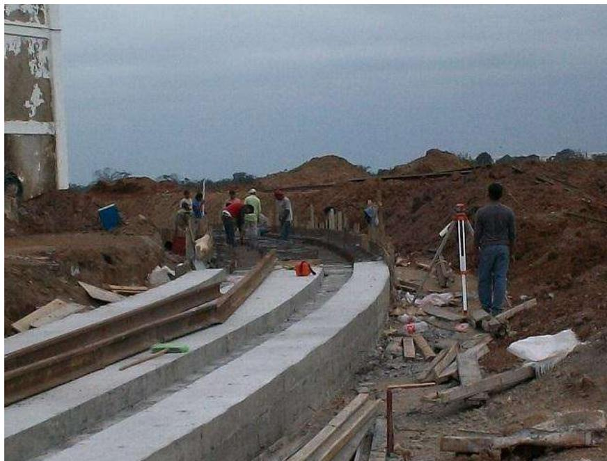
especificada, enseguida los estribos, cuidando el trazo de alineación para no tener que realizar trabajos adicionales de corrección de alineamiento posterior.
