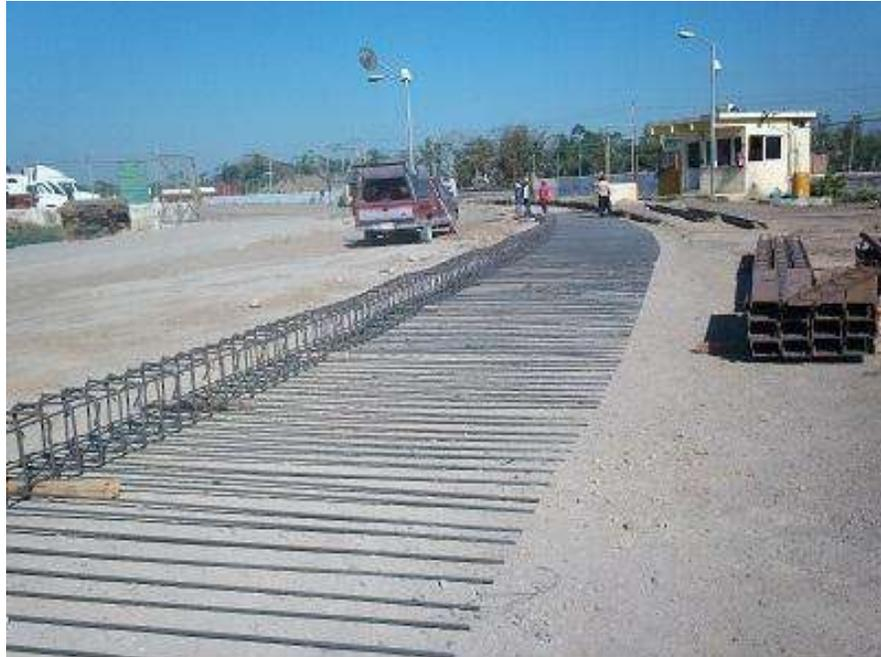
*Armado de acero para vía ahogada en concreto y durmientes canal.*
