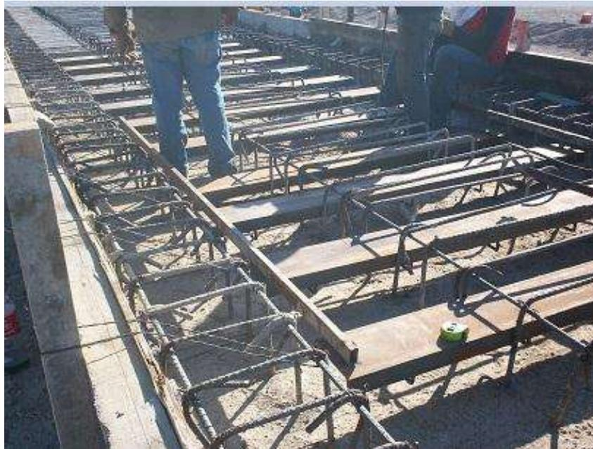
*Fijado y nivelado de durmientes canal.*
