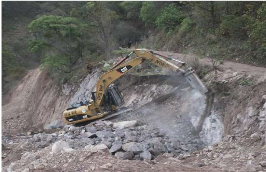
Corte de material tipo C, con Excavadora equipada con martillo
