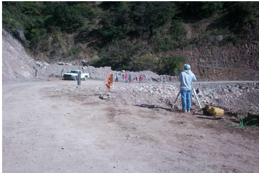
Verificación topográfica del eje de proyecto con Estación total
