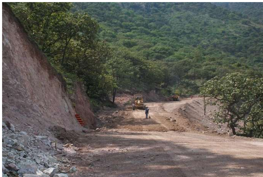
Tendido de material para conformación de terraplenes de proyecto, con motoniveladora
