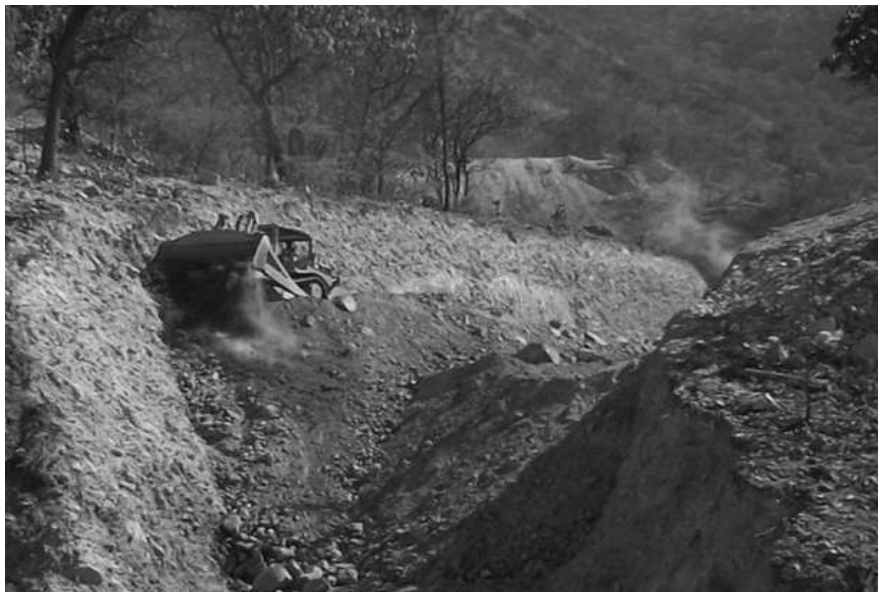
Corte de material de acuerdo a niveles de proyecto con Tractor D-8
