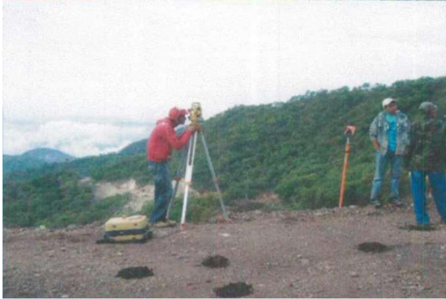
Levantamiento topográfico de terreno natural con estación total, para ubicación el eje de proyecto
