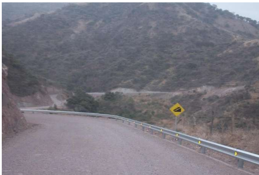
Proyecto ejecutado, del km 21+300 al km 38+000
