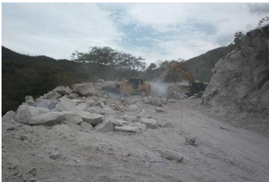
Corte de material de acuerdo a secciones de proyecto con Excavadora
