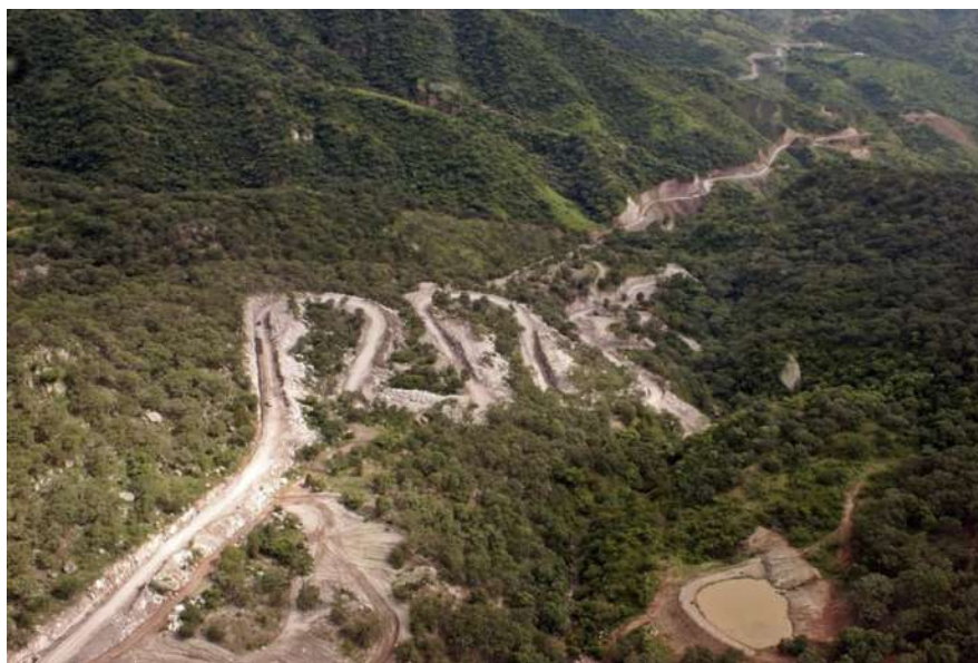
Vista del proyecto ejecutado
