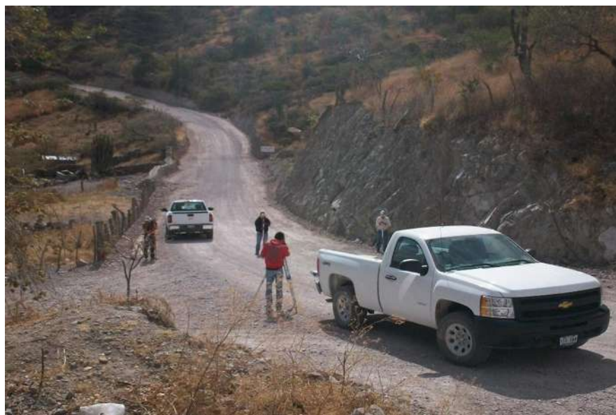
Verificación topográfica secciones transversales del proyecto con Estación total
