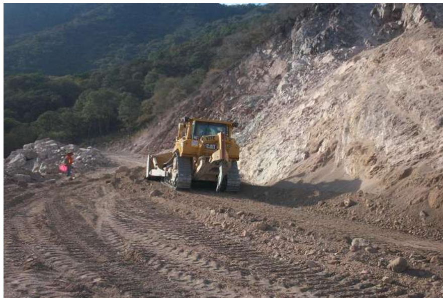
Formación de Terraplenes de acuerdo al proyecto
