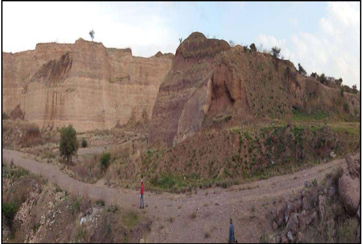
Fotografía 6.- Banco de materiales denominado como sin nombre 7 propuesto para ser cuerpo de terraplén ubicado en el Km 136+000 de la carretera Silao-Irapuato en desviación derecha en camino de terracería y referenciado a 24,500 metros del eje de trazo.
