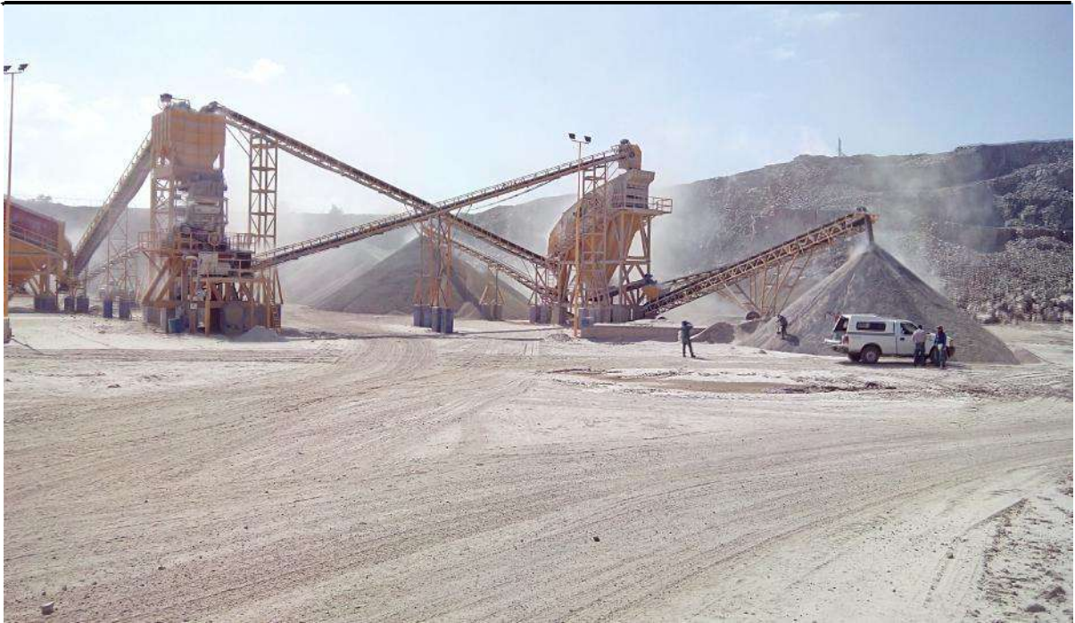
Fotografía 3.- Vista sur del banco triturados y acarreos marvas.
