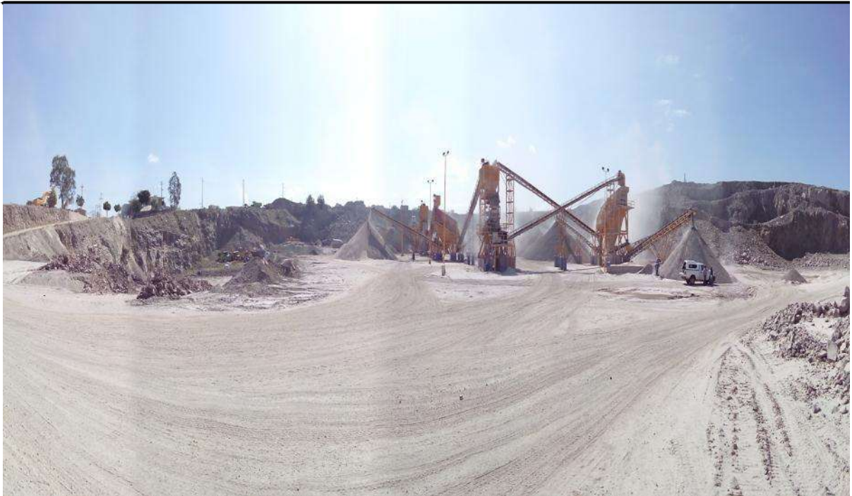
Fotografía 1.- Banco de materiales denominado como TRITURADOS Y ACARREOS MARVAS ubicado en el km 130+000 de la carretera Silao-Irapuato con desviación derecha a 5000 metros en camino pavimentado y referenciado al eje de trazo con 21,300 metros del Km 0+000, propuesto para ser empleado como: base hidráulica, carpeta asfáltica y riego de sello.
