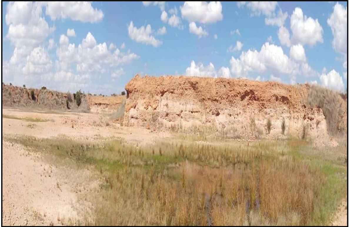
Fotografía 5.- Banco de materiales denominado como sin nombre 5 propuesto para ser empleado como: subyacente y cuerpo de terraplén ubicado en el Km 158+000 de la carretera Silao-San Felipe con desviación derecha en camino de terracería y referenciado a 100 metros del eje de trazo.
