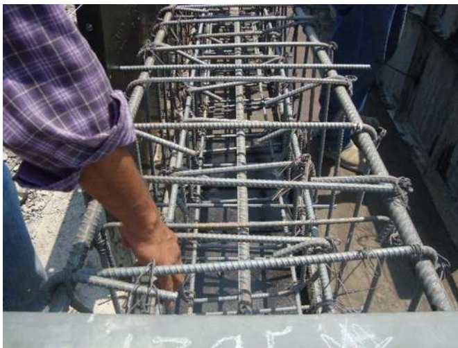
Ilustración 61 Armado Para Cama De Tensado.
