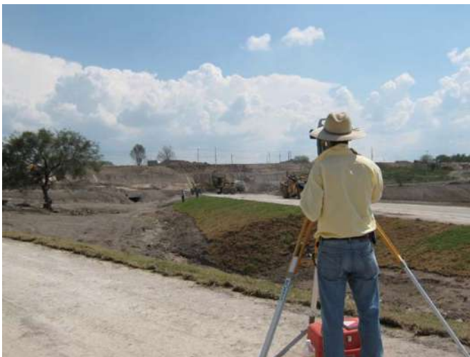
Ilustración 43 Nivelación Y Trazo.
