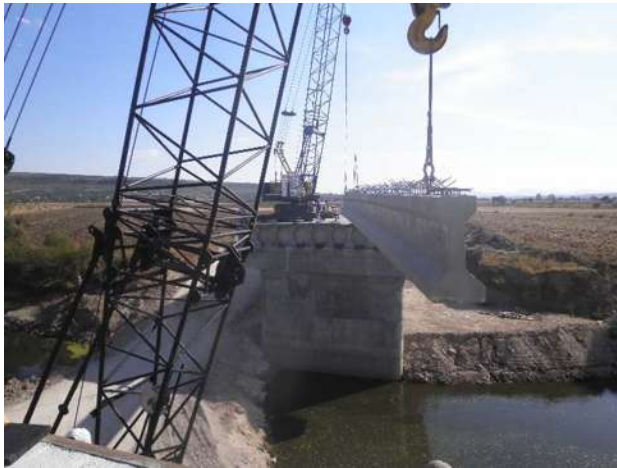
Ilustración 74 Montaje De Trabes.
