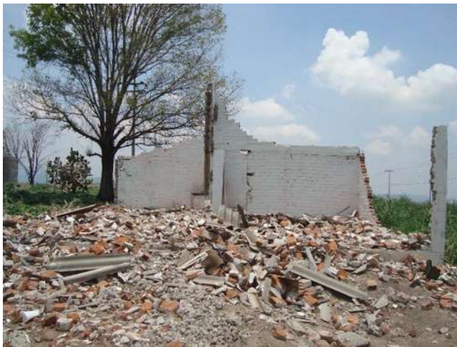
Ilustración 79 Demolición De Mampostería Por Ser Parte Del Trazo Del Camino.
