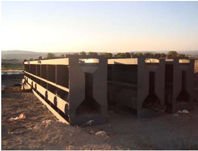
Ilustración 67 Moldes Para Colado De Viga I
