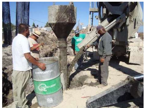
Ilustración 59 Ademe Para Colado De Pilote.
