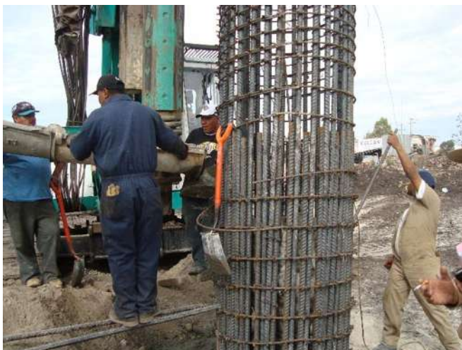
Ilustración 56 Colado De Pilote.
