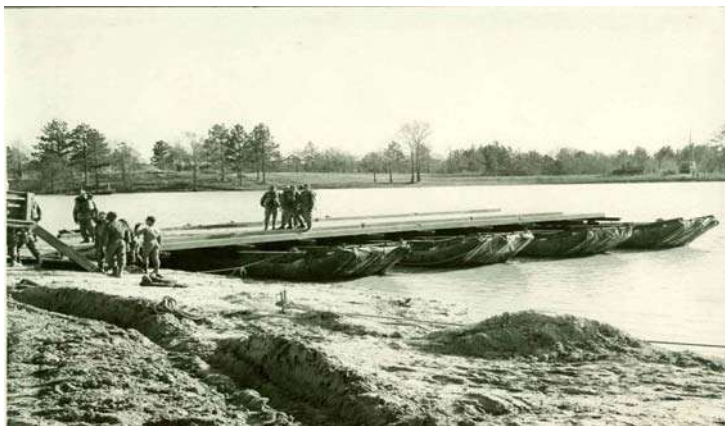
Ilustración 16 Puente De Barcazas, Utilizando Para Transporte De Maquinaria Militar, Mercancía O De Personas.
