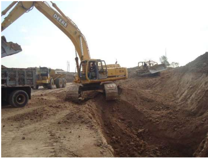
Ilustración 45 Excavación En Cortes Existentes.
