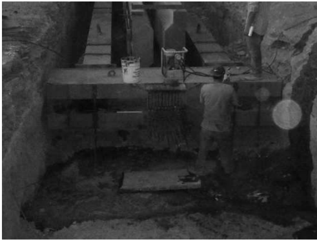
Ilustración 70 Tensado De Torones Por Medios Mecánicos.
