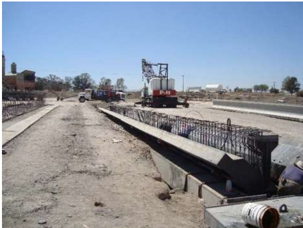
Ilustración 68 Colocación Del Armado Dentro Del Molde.
