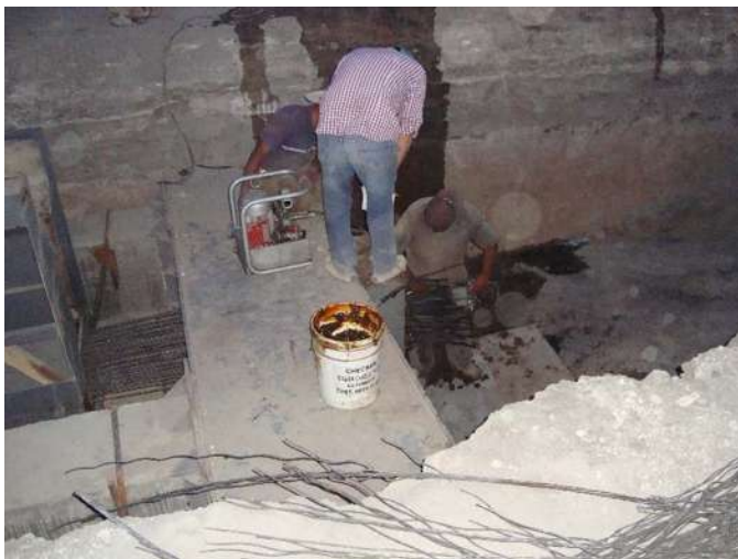
Ilustración 69 Colocación De Torones En Mesa De Tensado.
