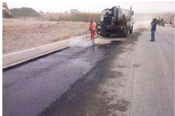
Ilustración 52 Riego De Liga Para Tendido De Carpeta Asfáltica.
