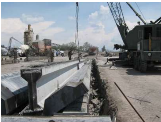
Ilustración 71 Desmolde De Viga Por Medio De Grúas.
