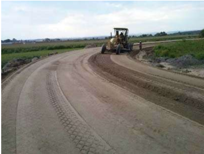
Ilustración 48 Formación De La Capa Subyacente.
