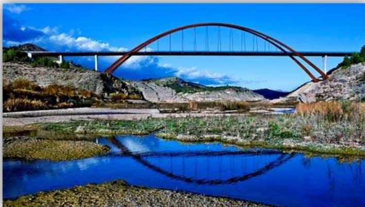
Ilustración 7 Puente De La Vicaría En Albacete, Puente De Arco Metálico Con Tablero.
