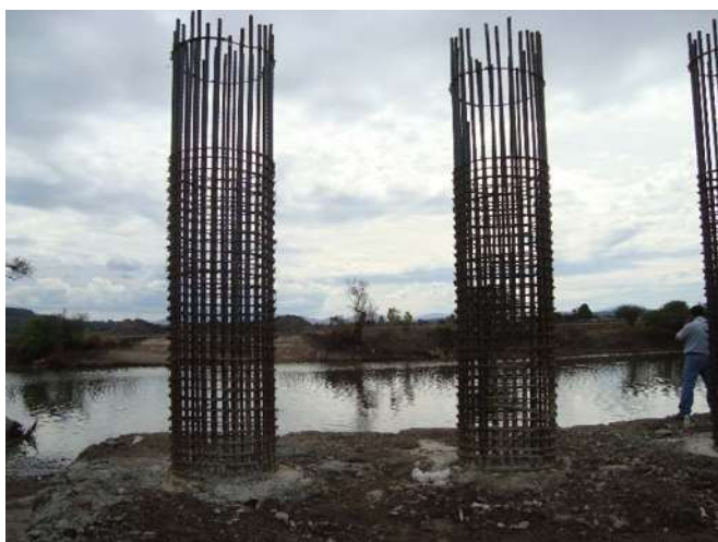
Ilustración 57 Colado En Sitio De Pilotes.
