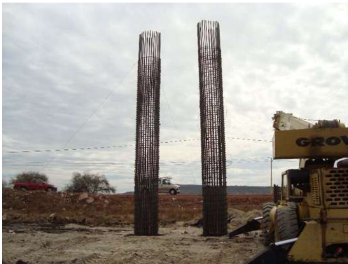
Ilustración 62 Armado De Columnas.
