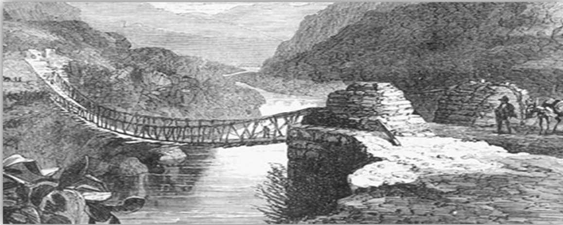
Ilustración 2 Puente Sobre El Río Aporismasen, Perú En El Siglo XX.
