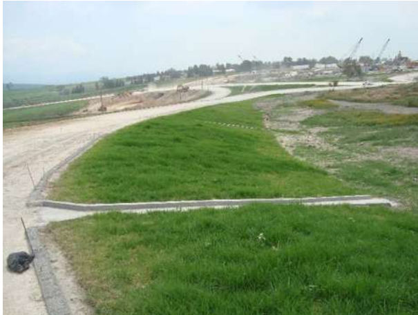
Ilustración 80 Recubrimiento De Taludes.
