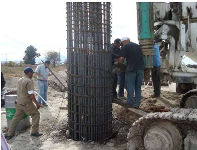
Ilustración 60 Colado De Pilote Con Concreto Premezclado.
