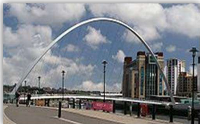
Ilustración 26 Puente Gateshead Millennium Ubicado En Inglaterra.
