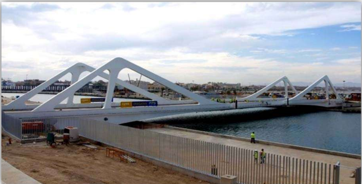
Ilustración 21 Puente Giratorio Del Puerto De Valencia, Puente Móvil, Mar Mediterráneo, Valencia España.
