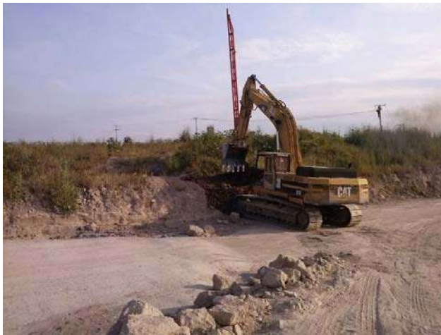
Ilustración 78 Reubicación De Línea De Alta Tensión.
