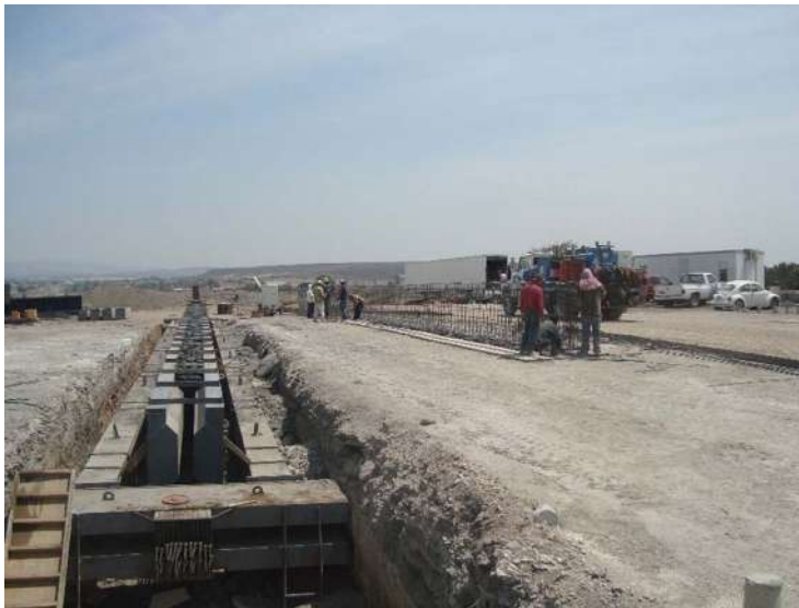
Ilustración 64 Armado Y Colado De Vigas O Trabes I
