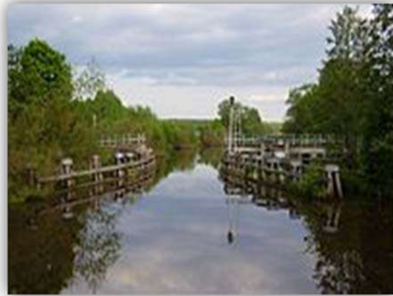
Ilustración 33 Puente Retractable Utunabren.
