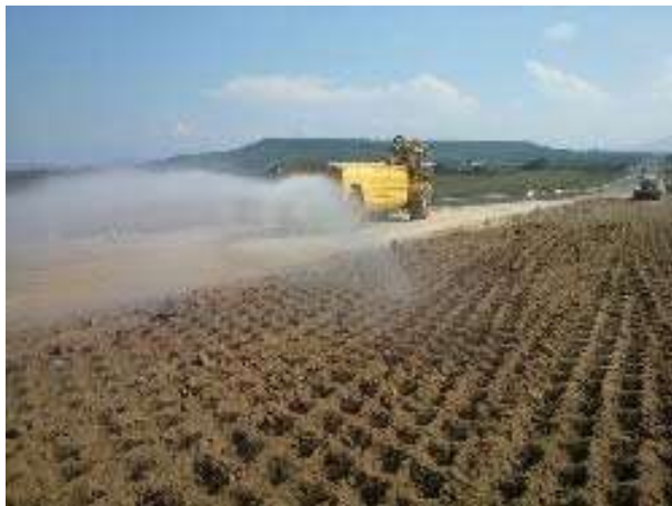
Ilustración 50 Mojado De Base Hidráulica.
