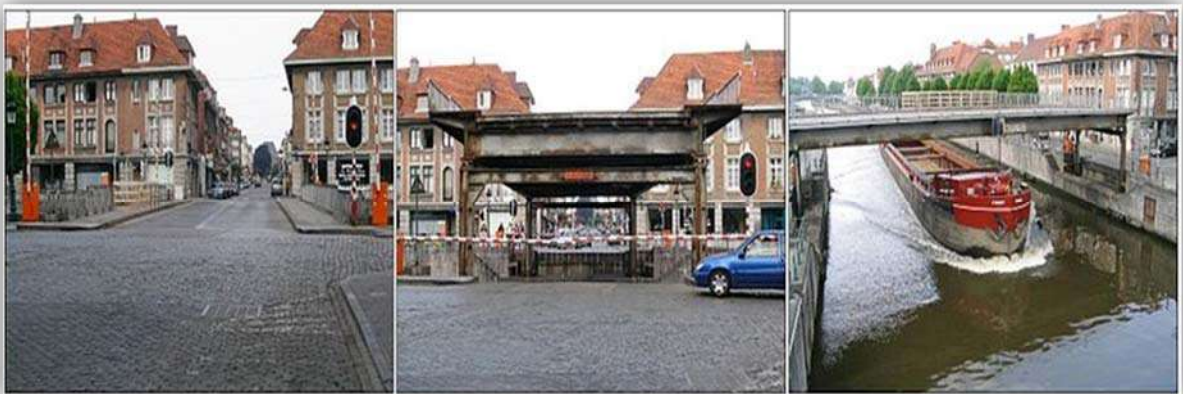
Ilustración 24 Puente De Mesa, Ubicado En Pont Levant Notre Dame De Tournai, Belgica.
