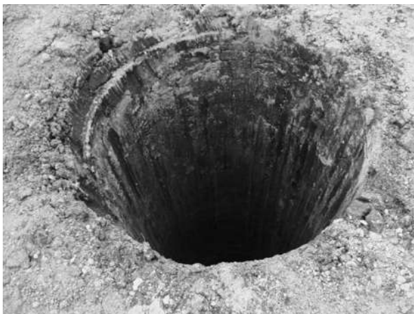
Ilustración 58 Perforación Para Pilote.
