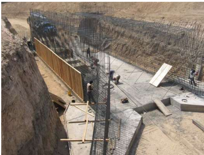
Ilustración 55 Desplante Para Alojjo De Puente.
