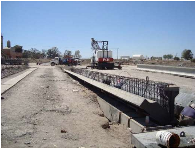
Ilustración 65 Habilitado Y Colocación De Acero De Refuerzo.
