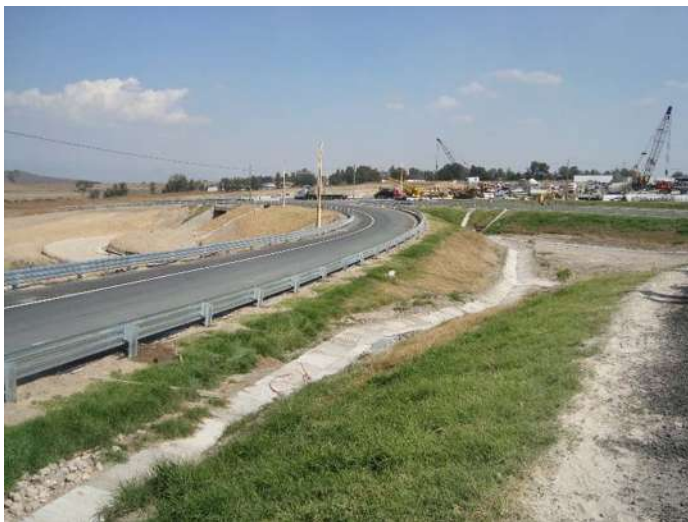
Ilustración 53 Carpeta Asfáltica Terminada.
