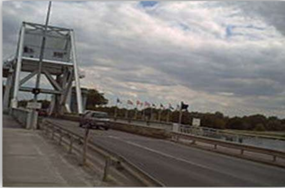
Ilustración 27 Puente Balanceador Pegasus.
