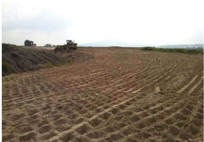
Ilustración 49 Formación Y Compactación De La Capa Subyacente.
