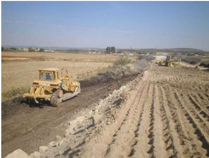
Ilustración 47 Formación Y Compactación De Terraplenes.
