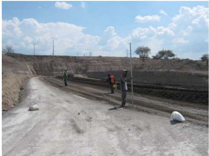
Ilustración 42 Brigada De Topografía En Nivelación.
