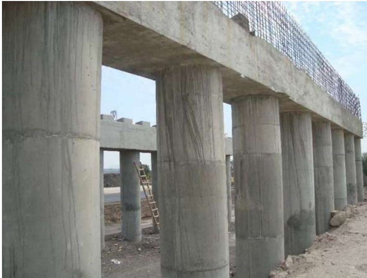
Ilustración 63 Cabezal, Topes Y Bancos De Pilas.
