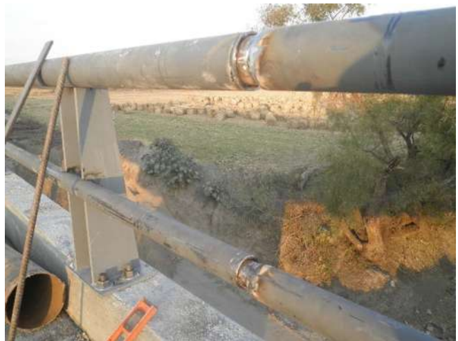
Ilustración 75 Parapeto De Acero Y Guarniciones En Puente.
