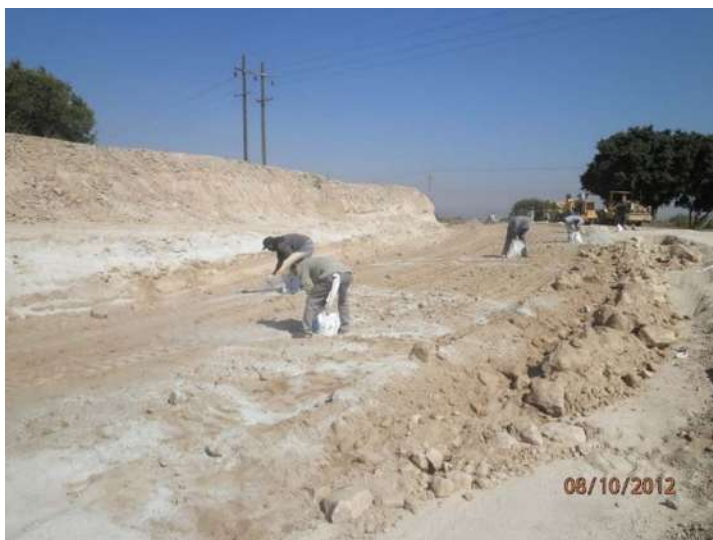
Ilustración 54 Aditivo, Mejoramiento De Adherencia Con El Asfalto.
