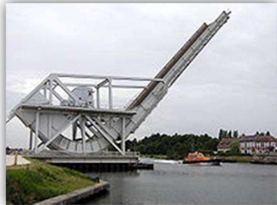
Ilustración 28 Puente Pegasus, Desarrollado Para Trabajar Con Un Sistema De Engranes.
