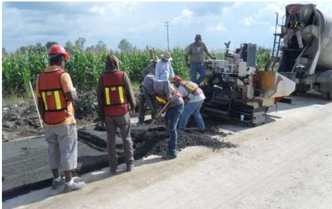
Ilustración 51 Tendido De La Base Asfáltica.
