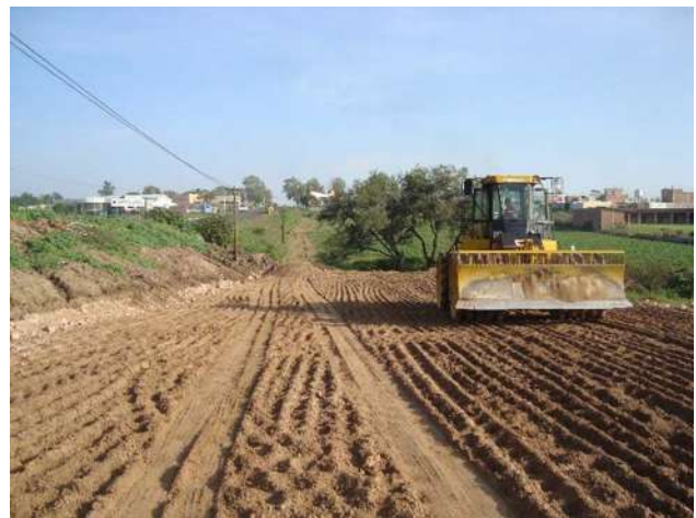
Ilustración 77 Reubicación De Postes De Electricidad.
