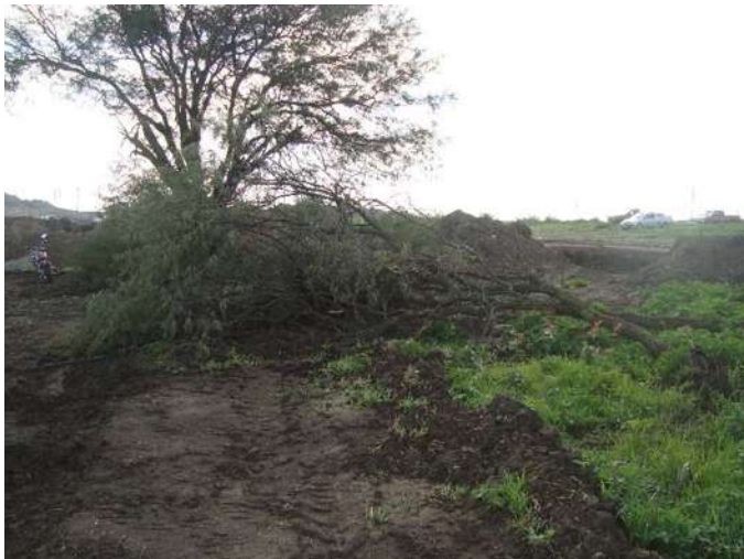
Ilustración 44 Derribe De Arboles Existentes En Zona De Construcción.
