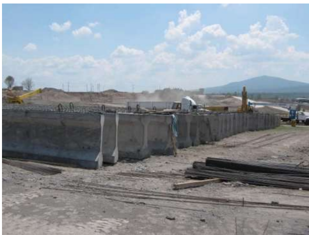
Ilustración 72 Almacén De Vigas.
