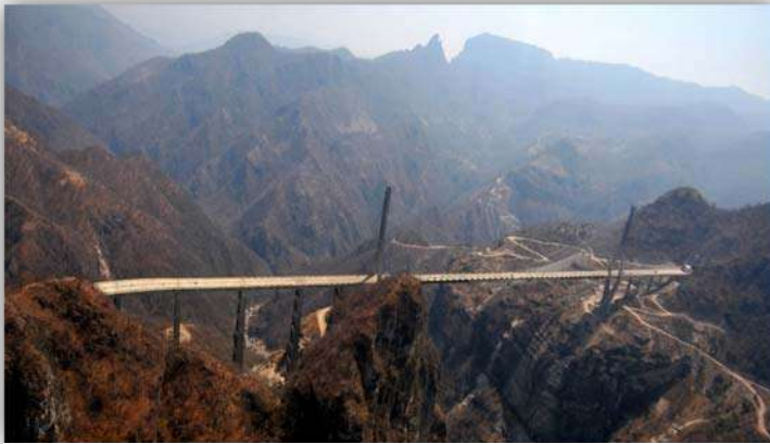
Ilustración 15 Puente Baluarte Bicentenario.
