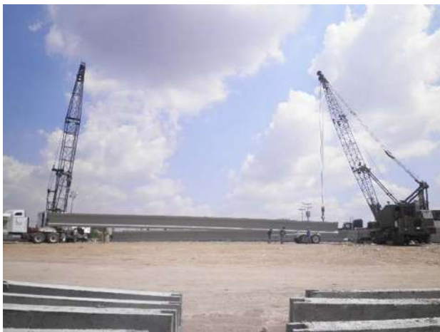
Ilustración 73 Trabe Transportada En Tráiler Hasta El Lugar Requerido.
