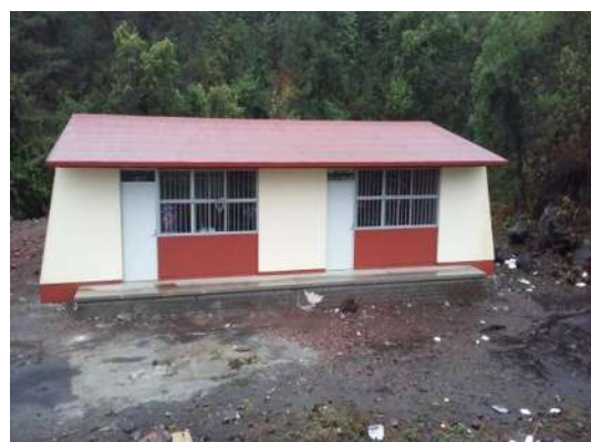
Dos aulas terminadas.
