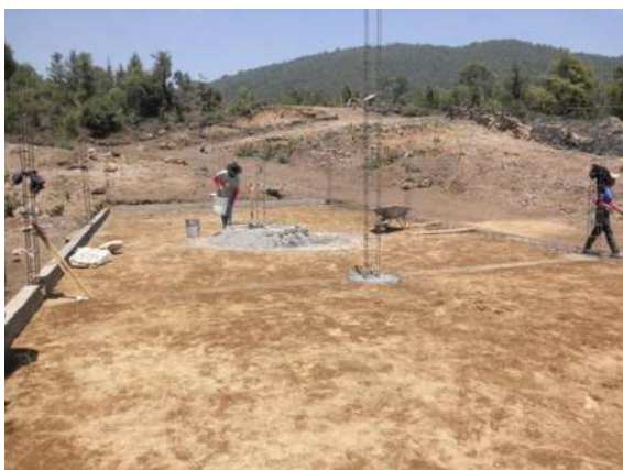
Construcción de dalas de despalnte.
