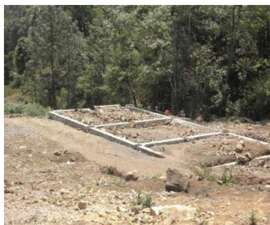
Construcción de cimentación
