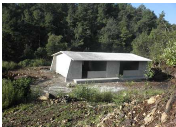
Terminación de las dos aulas en obra negra
