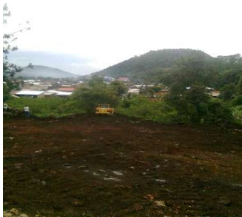
Excavación y nivelación del terreno
