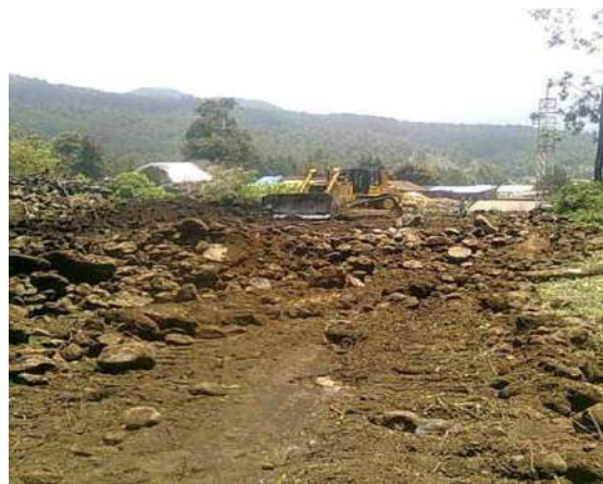
Apertura de la calle de acceso.
