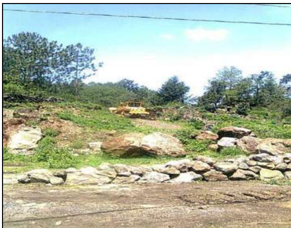
Estado natural de la calle de acceso.
