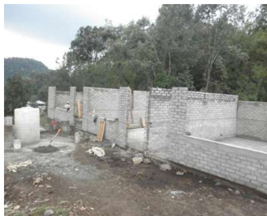
Construcción de muros.
