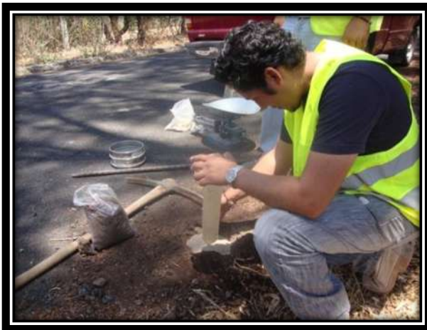
Foto. 19 Determinación del grado de compactación de la capa de Subrasante
