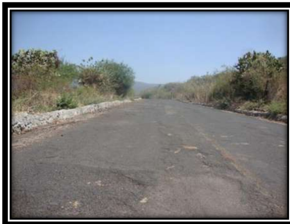
Foto. 3 Vista del camino realizado km 0+490.
