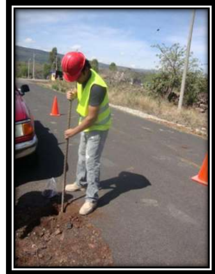
Foto. 10 Elaboración del sondeo para determinar el grado de compactación en km 0+060 lado derecho.
