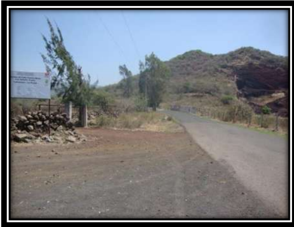
Foto. 1 Comienzo del tramo carretero km 0+000.
