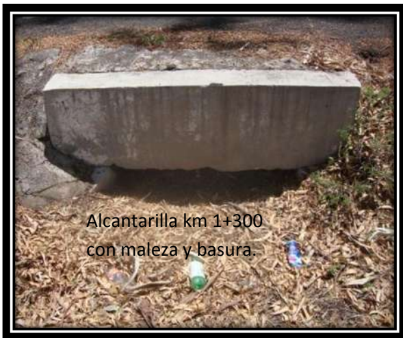
Se observa la alcantarilla ubicada en el km 1+300 en estado de azolve franja derecha.
