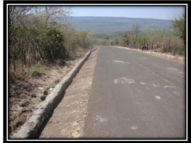
Foto. 6 Vista donde existen cunetas 0+520
