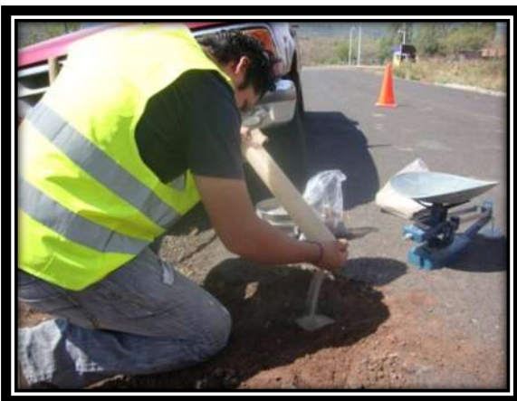
Foto. 11 Determinación de grado de compactación en la capa de base en el sondeo 1.
