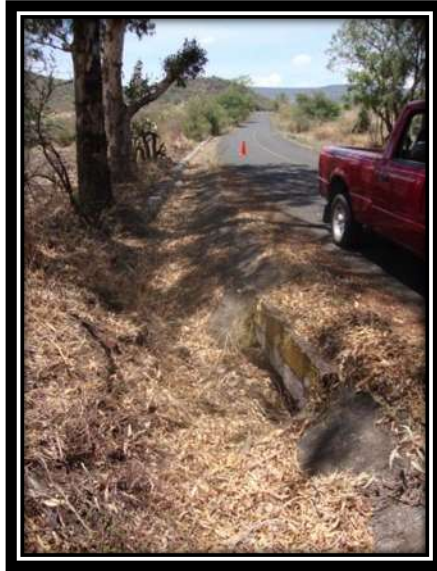
Se observa la alcantarilla ubicada en el km 1+300 en estado de azolve franja derecha.
