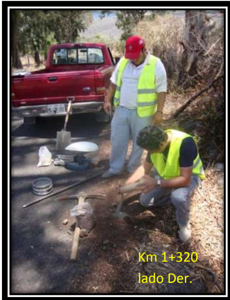
Foto. 17 Vista del sondeo 3 determinando el grado de compactación en el km 1+320.
