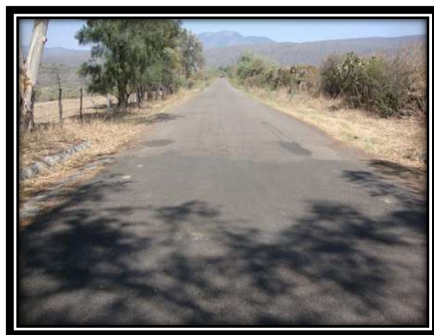
Foto. 8 Vista de fin del tramo carretero con dirección a la presa km 1+500.
