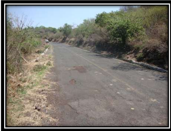
Foto. 5 Vista del tramo carretero donde existe corte km 0+800.
