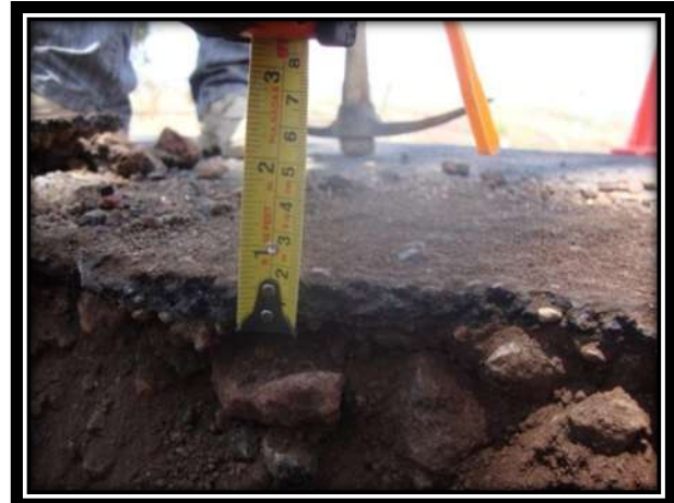
Foto. 18 Se observa el espesor de la capa de rodadura encontrada en el sondeo 3.
