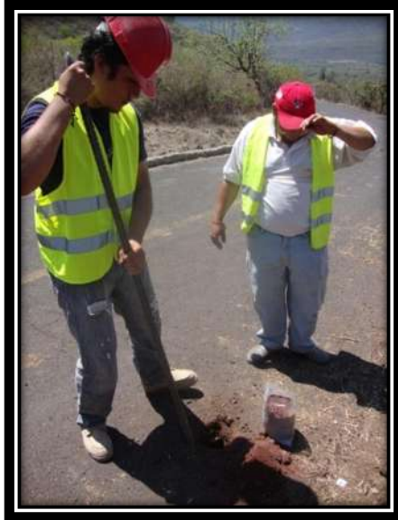
Foto. 13 Elaboración del sondeo 2, ubicado en km 0+650.
