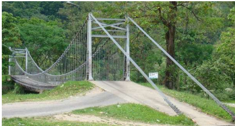
Figura 26. Puente sobre el río Santo Domingo en Barinas, Venezuela
