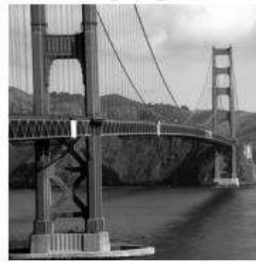
Estructura Flexible Periodo Largo Frecuencia Baja
