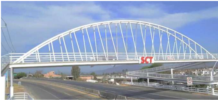
Figura 24. Puente Peatonal Federal en Puente Grande, Jalisco
