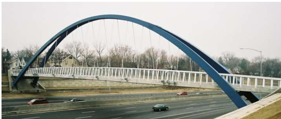
Figura 11. Puente sobre la autopista Oklahoma, USA
