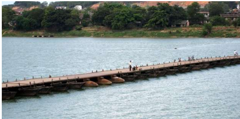
Figura 19. Puente Jian Chunmen en China.
