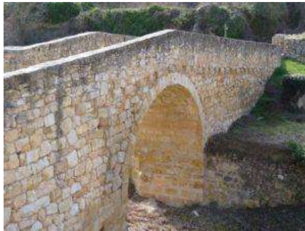
Figura 10. Puente romano en Torre de Arcas, España
