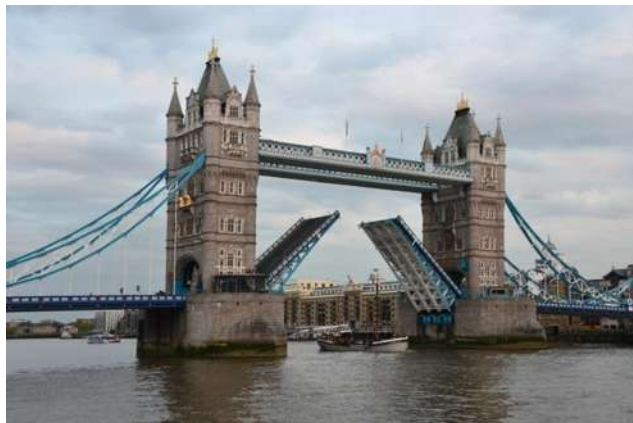
Figura 13. Puente de la Torre, Inglaterra.
