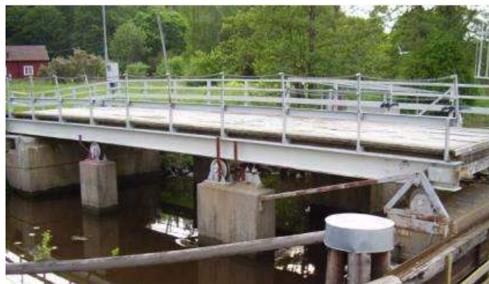
Figura 18. Puente Ultunabron en Uppsala, Suecia
