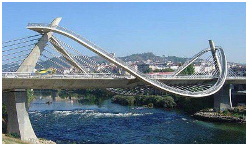
Figura 28. Puente Milenio, de dos torres con tirantes en un plano, dispuestos en arpa, en Galicia, España.
