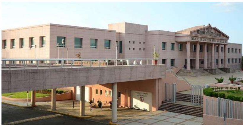
Figura 12. Puente peatonal del Tribunal de Justicia en Morelia, Michoacán.
