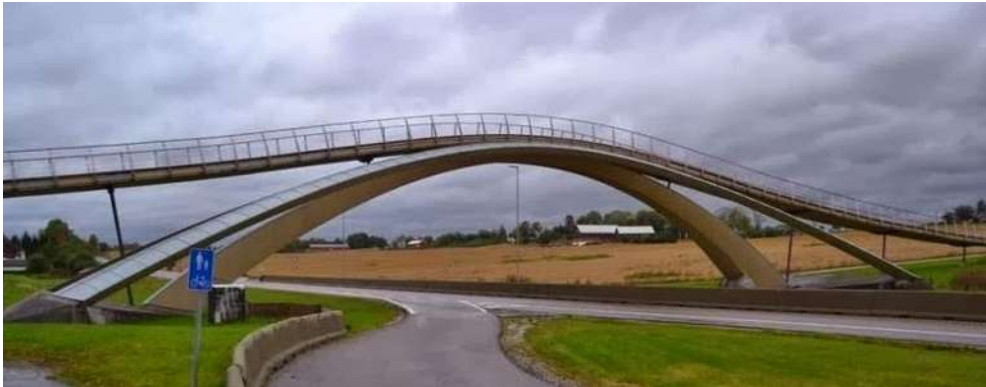
Figura 22. Puente Leonardo de Oslo en Oslo, Noruega.
