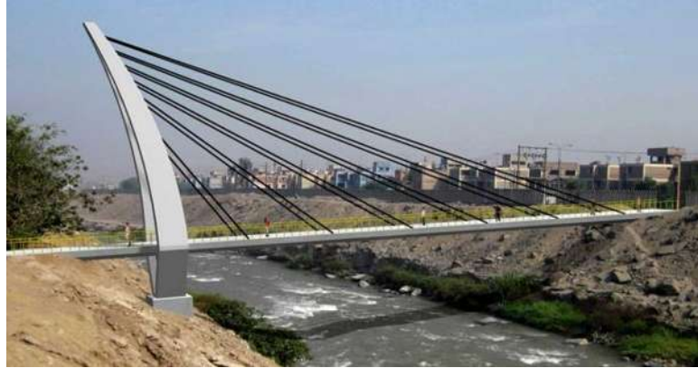
Figura 27. Puente Los Libertadores de una sola torre con tirantes en dos planos y en disposición radial, en Lima, Perú
