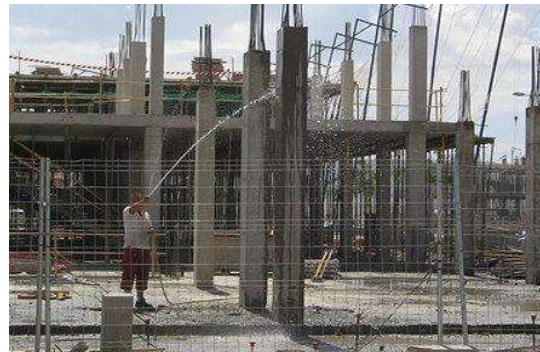
Ilustración 3-XIV"Curado de columna por medio de aspersor"
