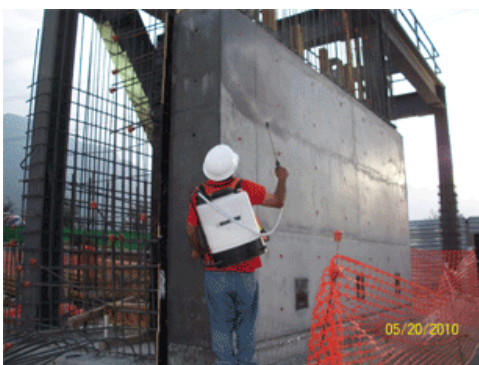
Ilustración 3-XIII "Curado en muro de concreto por medio de aspersion"
