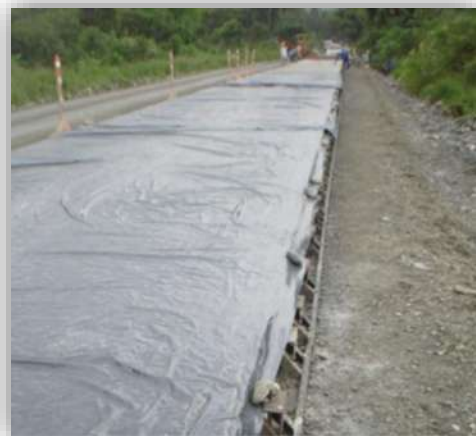
Ilustración 3-IX"Curado con película plástica"
