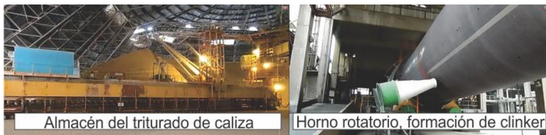
Ilustración 3-II Instalaciones de la planta "La Cruz Azul", Tula de Allende, Hgo.
