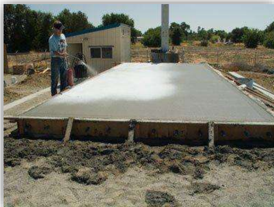
Ilustración 3-X "Curado con membrana plástica color blanco"
