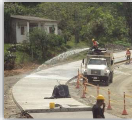
Ilustración 3-VIII "Curado por inmersión en losa de pavimentación"
