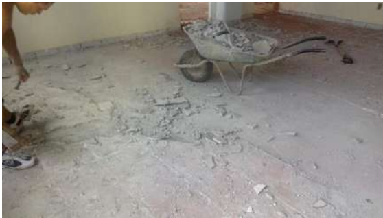
Img 1. Retiro de zoclo y piso de forma manual.
