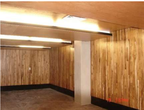
Img 34. Sala de juicios con muros, plafones, salida de aire y luminarias instaladas.
