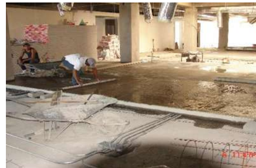
Img 8. Colocación de firme de concreto, con malla electro soldada y preparación
