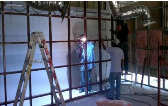
Img 19. Fabricación de la estructura interior del muro.
