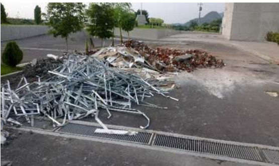
Img 7. Retiro del producto de demolición y cancelería de aluminio fuera del edificio.
