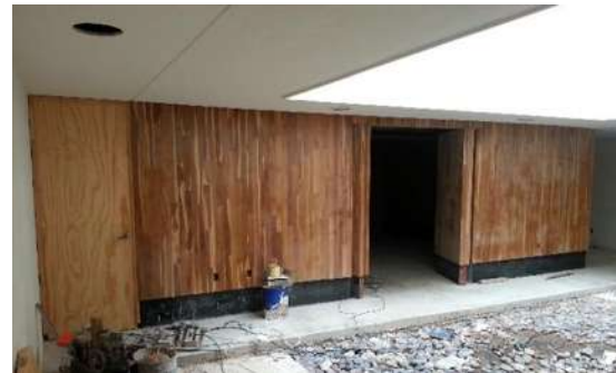
Img 41. Acceso a una de las salas.
