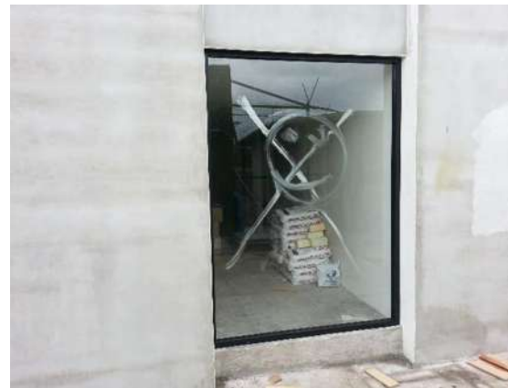
Img 35. Instalación de cancelería y cristalería en el exterior del inmueble.
