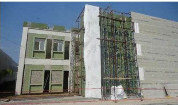
Img 11. Revestimiento del exterior con paneles Durok sujeto a la armadura.
