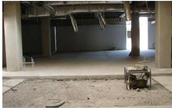
Img 29. Preparación del jardín central dentro del edificio.
