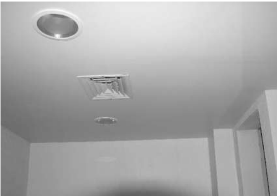
Img 44. Iluminación, salida de aire y pintura en plafón y muros terminados.
