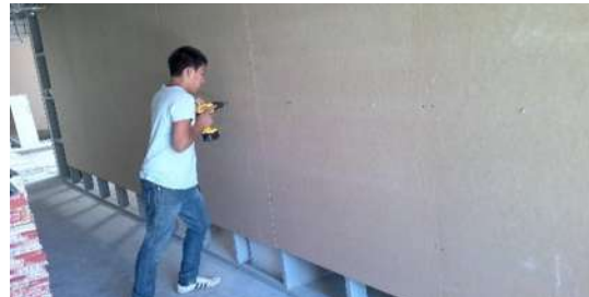
Img 24. Fijación de la parte interna del muro divisorio acústico.
