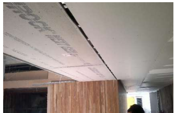
Img 31. Vista de plafones interiores y exteriores (tablaroca y Durok).
