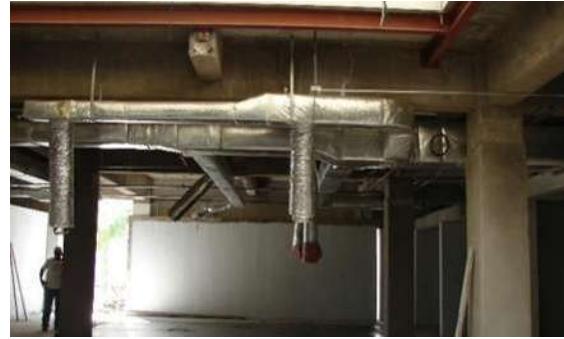
Img 15 y 16. Ductos de instalación de aire al descubierto sujetos a la losa.
