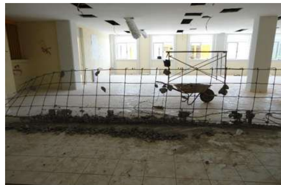
Img 4. Demolición de murete de concreto armado con malla.
