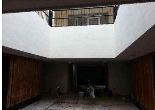
Img 45. Termino de acabados y pintura dentro del edificio.
