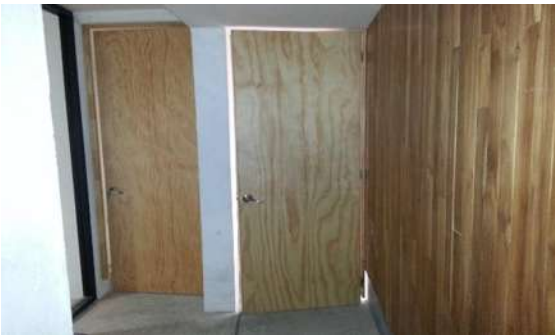
Img 40. Instalación de puertas prefabricadas de madera al exterior de la sala.
