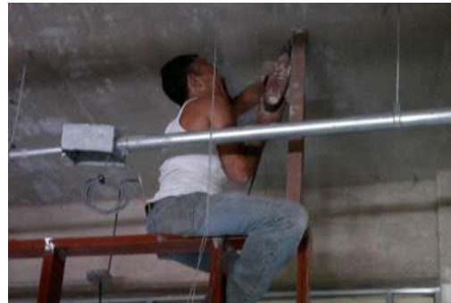
Img 20. Sujeción de la estructura del muro a la losa por medio de tornillos.
