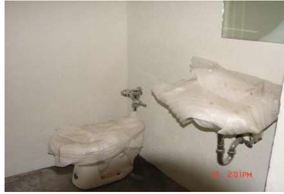
Img 36 y 37. Instalación de los muebles sanitarios; Wc, lavabos, espejos y accesorios diversos.
