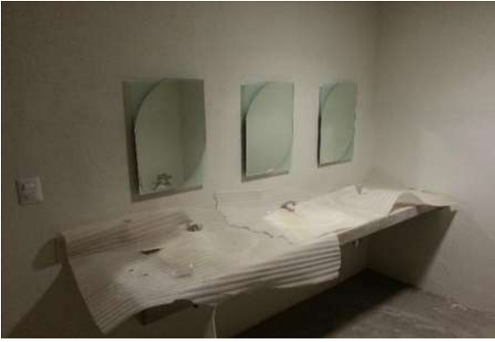
Img 36 y 37. Instalación de los muebles sanitarios; Wc, lavabos, espejos y accesorios diversos.
