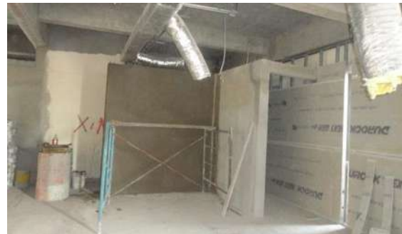
Img 18. Aplanado de los muros de tabicón y colocación de paneles de Durok.
