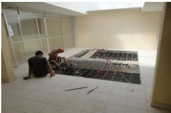
Img 3. Corte del acero de refuerzo de la losa de entre piso.
