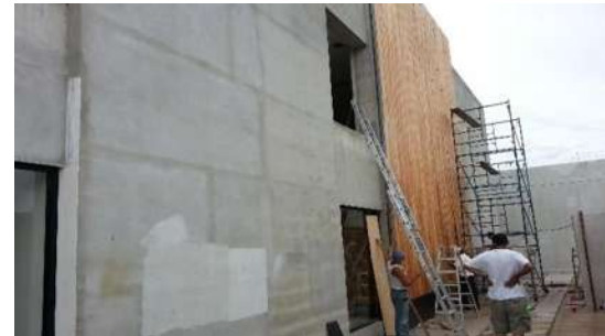
Img 14. Colocación de Teca en el centro de la fachada.
