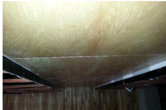
Img 33. Plafón de madera colocado solo en las salas de juicios.
