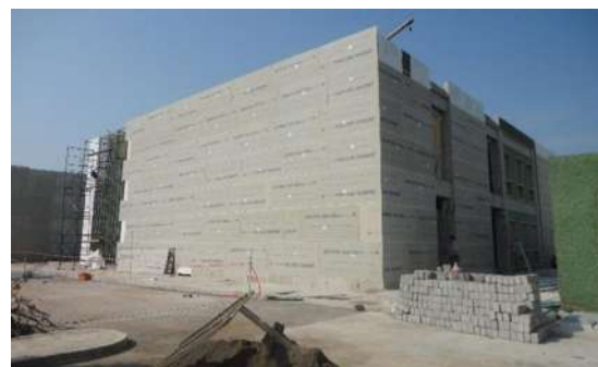
Img 12. Revestimiento casi terminado listo para colocar el aplanado.
