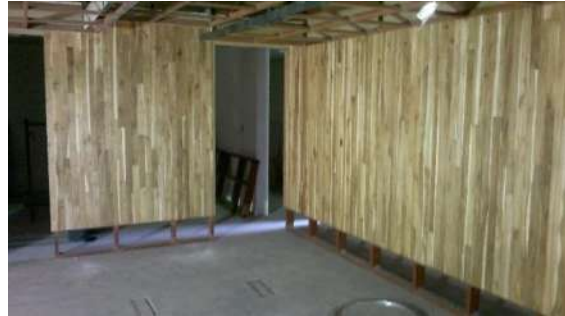
Img 25 y 26. Colocación de madera tipo teka dentro de las salas de juicios.
