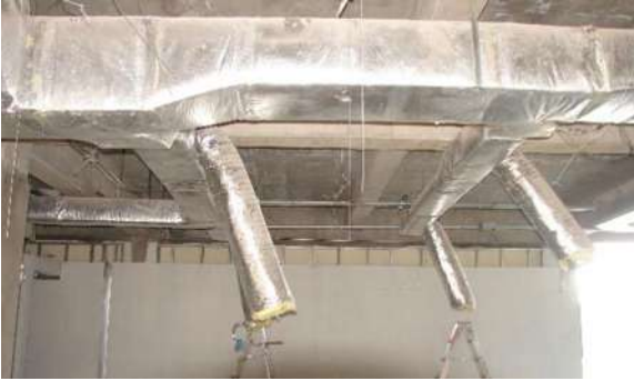
Img 15 y 16. Ductos de instalación de aire al descubierto sujetos a la losa.
