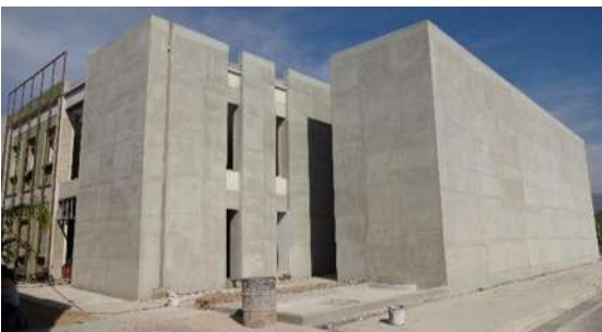
Img 13. Fachada del edificio con el panel revestimiento de cemento arena.
