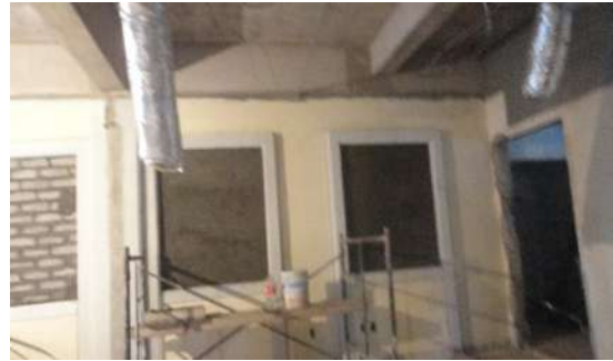
Img 10. Aplanado del tabicón utilizado en las ventanas por parte interior.
