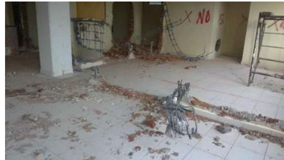
Img 2. Demolición de muros en el interior del edificio.
