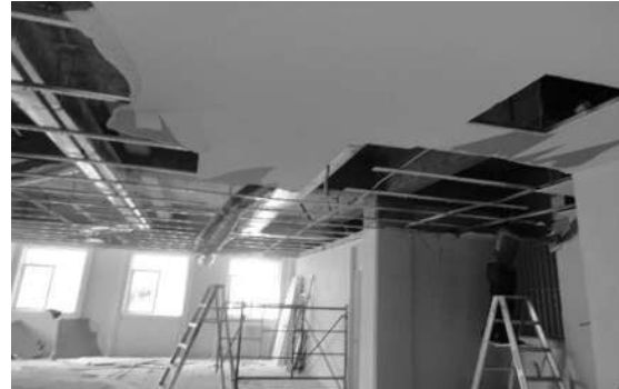
Img 6. Desmantelamiento de plafón de tablaroca
