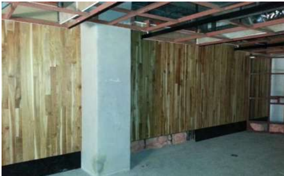
Img 27 y 28. Suministro y colocación de lámina metálica (zoclo) para la protección a la hora de hacer aseo.
