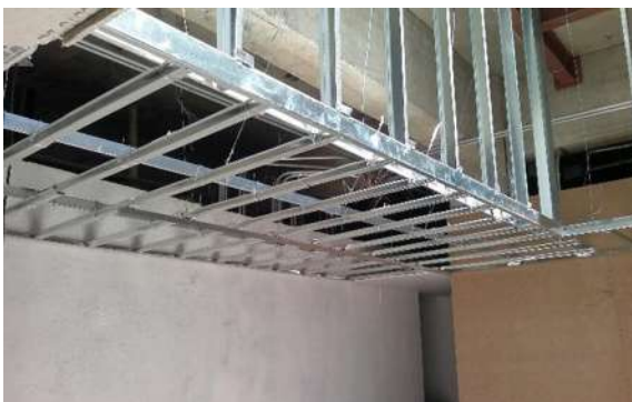
Img 30. Armado del soporte estructural del plafón visto en esquina.
