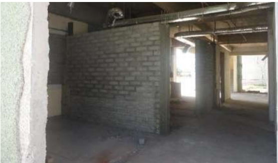
Img 17. Muro de tabicón ligero obra negra.
