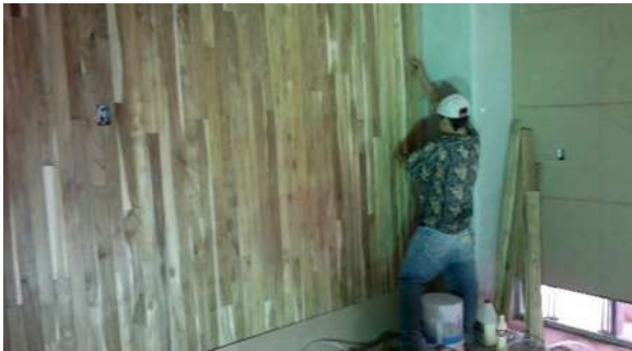
Img 25 y 26. Colocación de madera tipo teka dentro de las salas de juicios.
