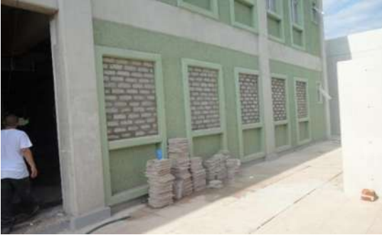
Img 9. Tapiado de ventanas del exterior con tabicón asentado con cemento-arena
