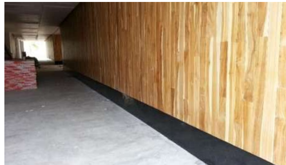
Img 27 y 28. Suministro y colocación de lámina metálica (zoclo) para la protección a la hora de hacer aseo.
