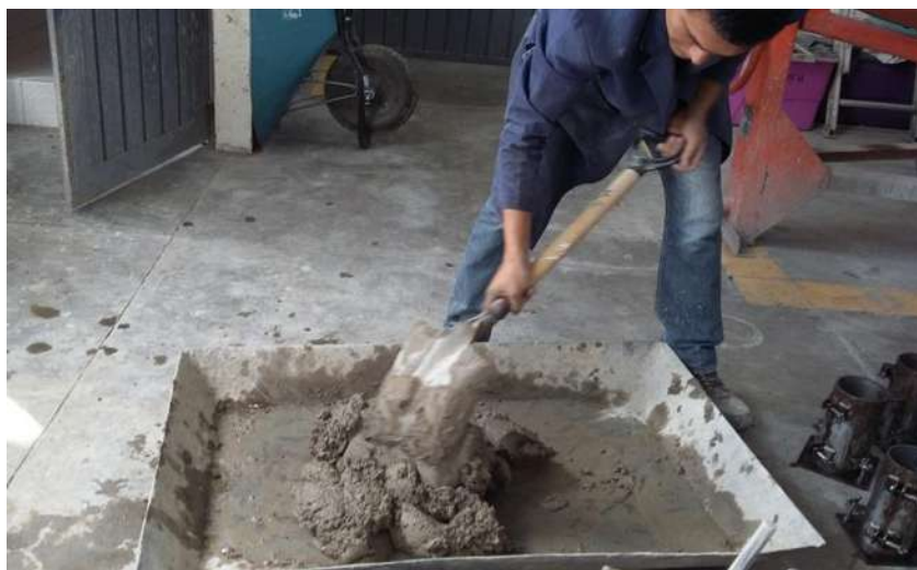
FIGURA 107: Mezclado de los materiales con el agua necesaria para obtener un revenimiento entre 8 y 14 cm.
