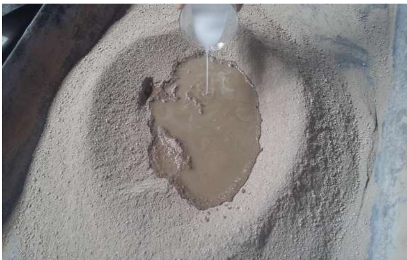
FIGURA 106: Agregación de una porción de agua y aditivo Maxe-h.
