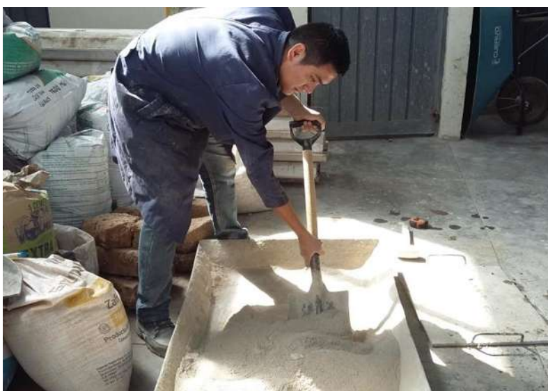
FIGURA 105: Homogenización en seco de suelo y cemento.
