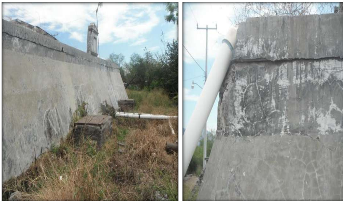
Figura 13. Estado actual del depósito principal.
