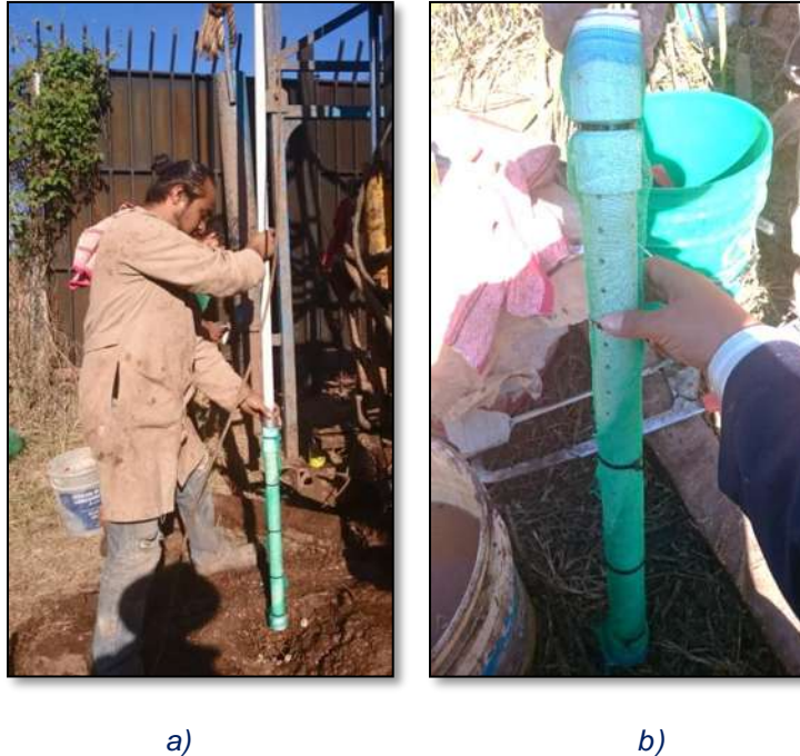
FIGURA 30. a) Instalación de un piezómetro. b) Detalle de bulbo piezométrico.
