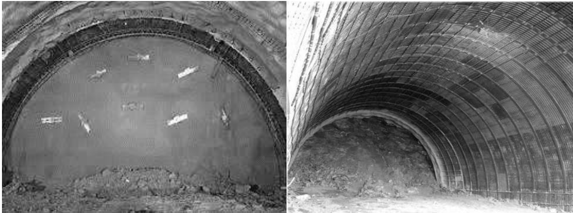
Figura 3.26 Marcos metálicos como sostenimiento en túneles.
