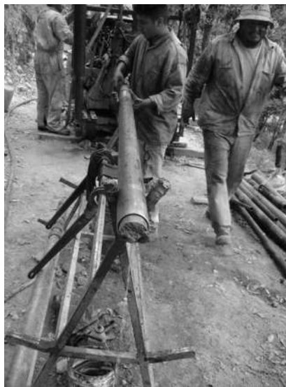
Figura 3.7 Equipo de perforación.
