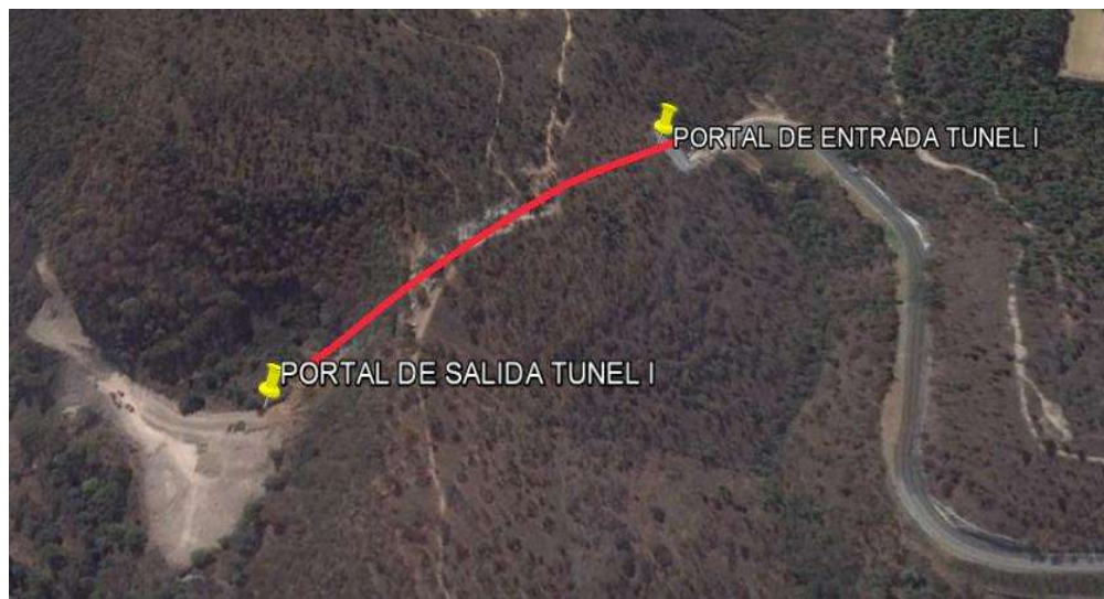
Figura 4.12 Fotografía satelital de la localización del Túnel I. Google Earth. 2015.
