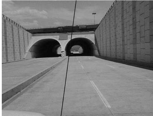
Figura 2.17 Distribuidor Vial Salida a Quiroga http://mimorelia.com/archivosnoticias/tunel-salida-guadalajara-molinero20120415.jpg 25/01/2016
