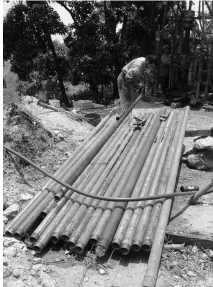
Figura 3.12 Tubería de revestimiento.
