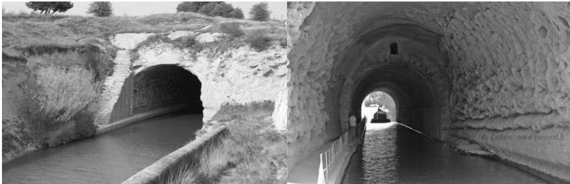
Figura 2.5 Túnel de Malpas http://www.beyond.fr/picssite/cdm-malpas0019b.jpg25/01/2016
