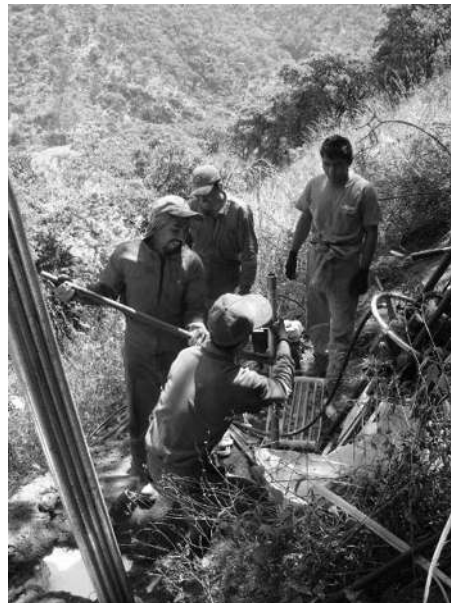
Figura 3.10 Montado de la tubería para extracción de testigos.
