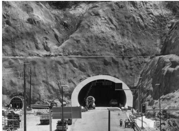
Figura 2.14 Entrada al túnel El Sinaloense.
