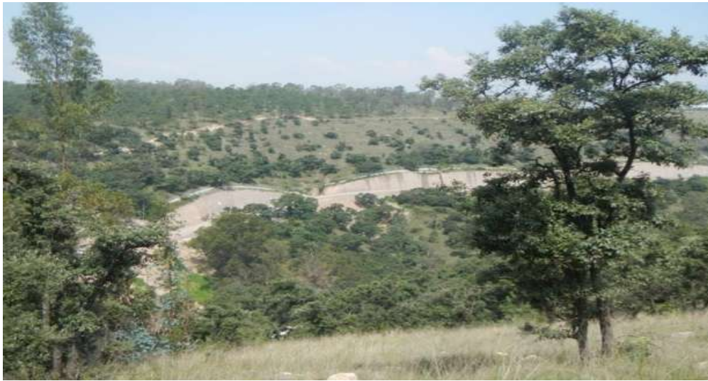
Figura 4.13 Vista panorámica del acceso al Tunel I.
