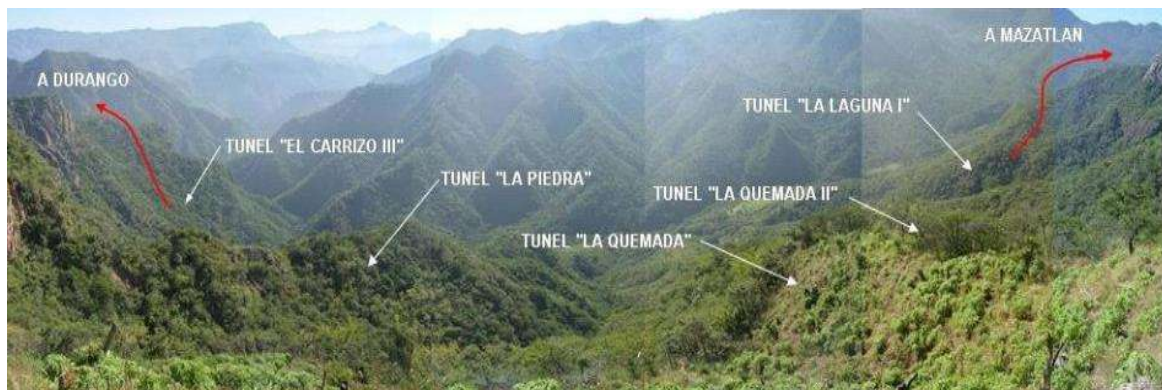
Figura 2.13 Ubicación de algunos túneles de la Autopista Durango-Mazatlán.
