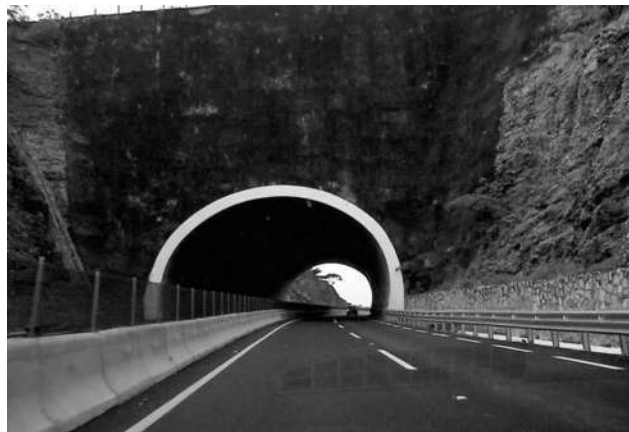
Figura 2.12 Túnel Los Querendes.
