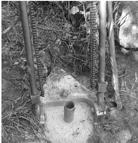
Figura 3.9 Lodo bentonítico en su proceso de introducción.
