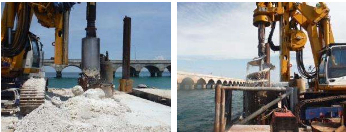
Figura 19 Pre-perforación con bote tipo corona y perforación inicial con broca helicoidal.
