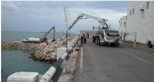
Figura 15 Suministro, prueba in situ de trabajabilidad y colocación de tubo Tremie para verter el concreto de pilas.
