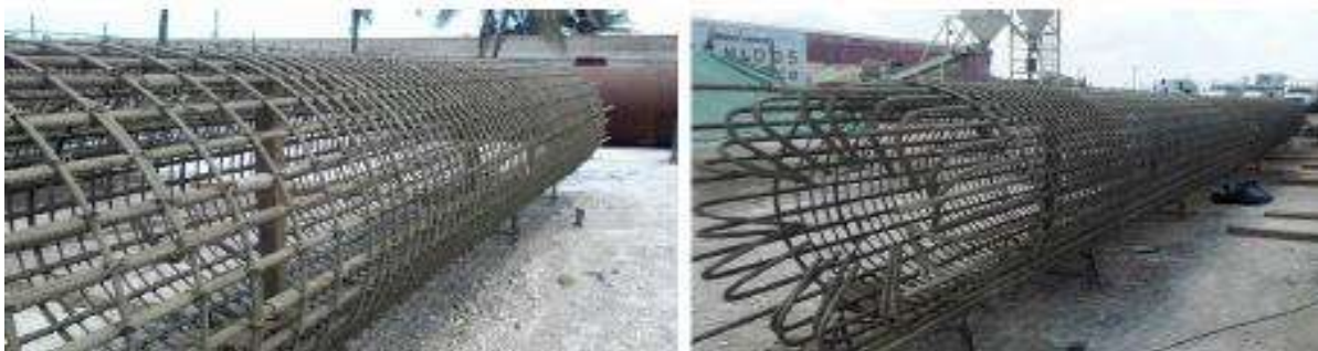
Figura 12 Armado de acero para pilas.
