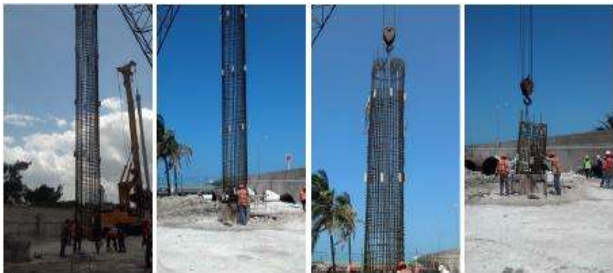
Figura 13 Armado de acero estructural casi terminado, el cual fue destinado para las pilas del nuevo viaducto.
