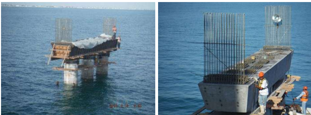
Figura 24 Revisión, protección de colado terminado para primera parte de cabezales.
