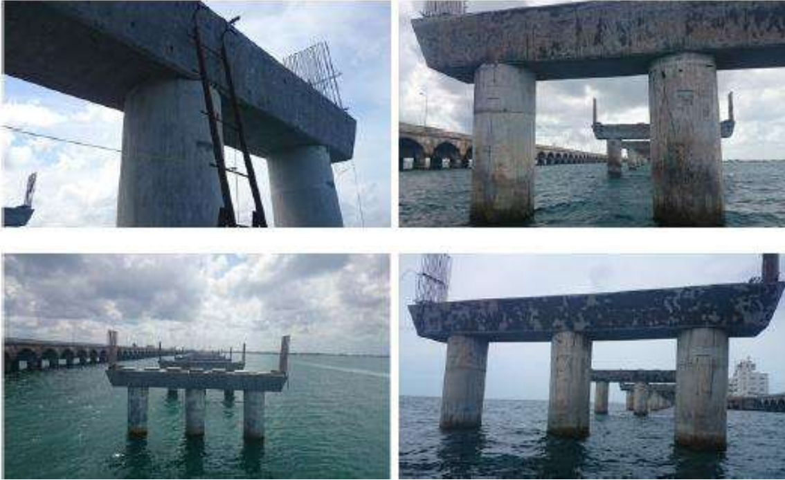
Figura 26 Vista de cabezales casi terminados, detalle de los restantes por colar.
