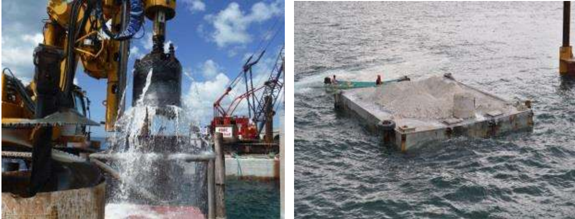
Figura 20 Depósito de material producto de perforación y retiro de material proveniente de excavación.
