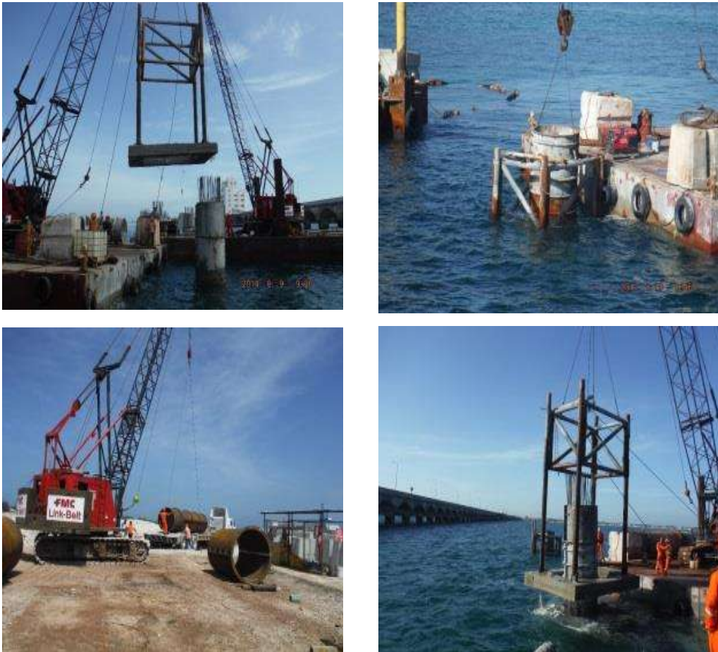
Figura 14 Colocación de escantillón, cimbra metálica y armado de acero para pilotes de Viaducto.
