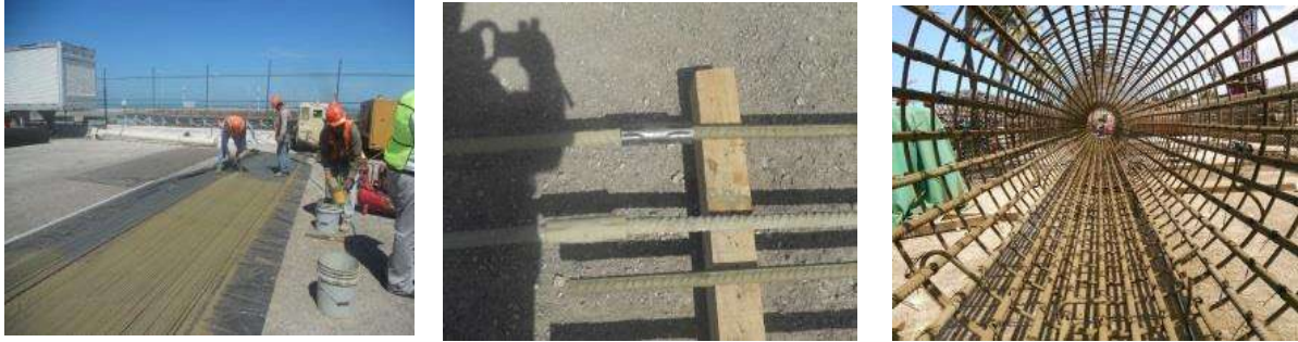
Figura 11 Preparación y armado de acero para pilotes del Viaducto de la obra.
