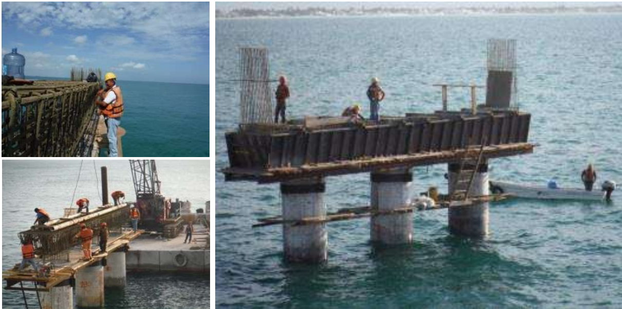
Figura 22 Nivelación y revisión de armado. Cimbra prefabricada para colar cabezales.
