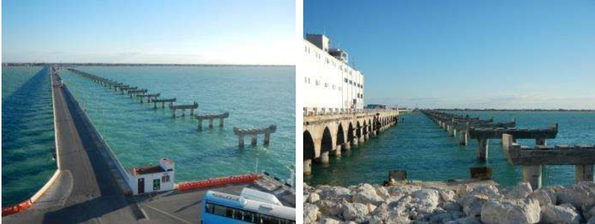
Figura 25 Cabezales completamente colados. Avance de la obra para el día 15 de marzo de 2015. Subestructura casi terminada.
