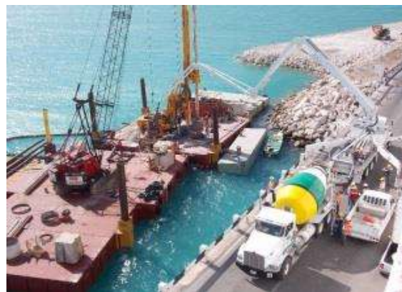
Figura 17 Colocación del concreto para pila con tubo Tremie y tolva.
