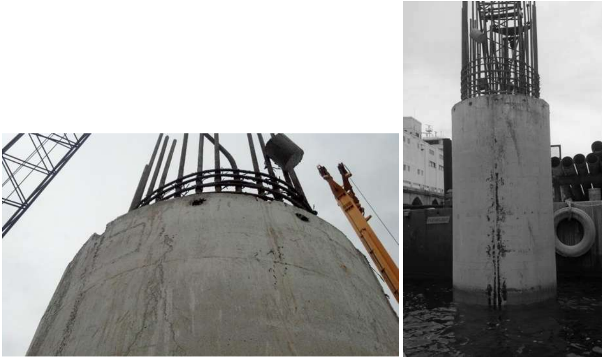
Figura 27. En la figura e observa el área de donde fueron extraídos los corazones de las pilas.
