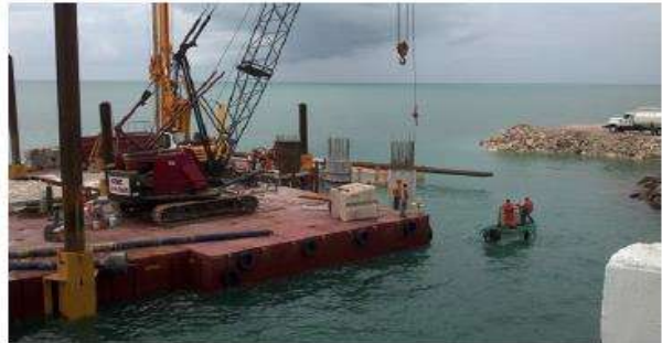
Figura 15 Suministro, prueba in situ de trabajabilidad y colocación de tubo Tremie para verter el concreto de pilas.
