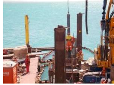
Figura 15 Suministro, prueba in situ de trabajabilidad y colocación de tubo Tremie para verter el concreto de pilas.
