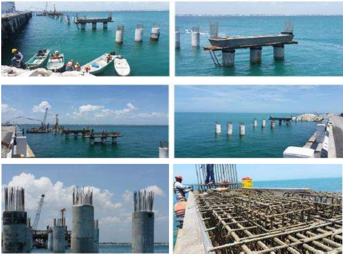
Figura 23 Vista avances de obra, algunos de los cabezales ya colados.
