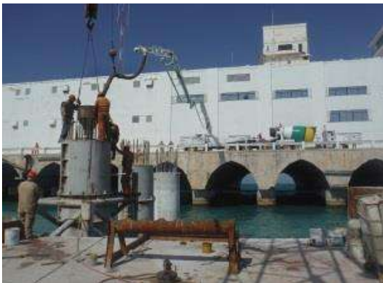
Figura 17 Colocación del concreto para pila con tubo Tremie y tolva.
