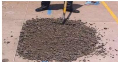
**Fig. 2.6.5.-** Secado de material en patio
