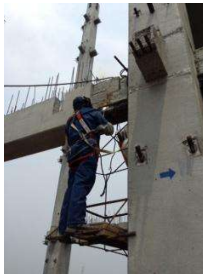
Imagen V.20. Soldadura de ménsulas
