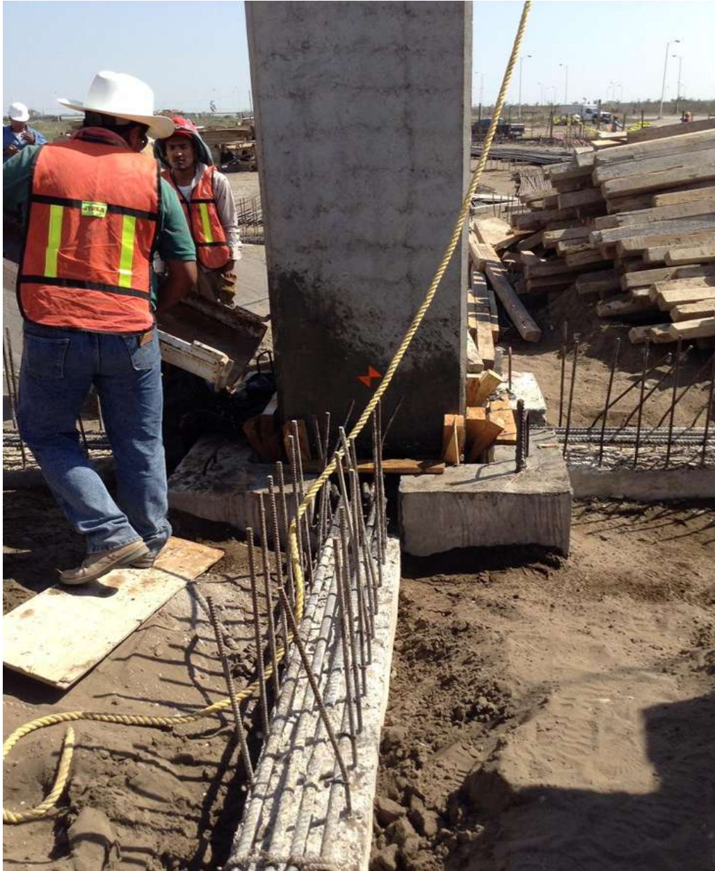
Imagen V.16. Colado de columna
