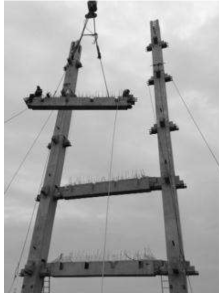
Imagen V.19. Montaje de traveses portantes en columnas
