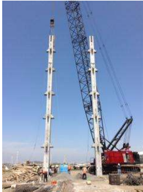
Imagen V.17. Columnas para resivir traves portantes
