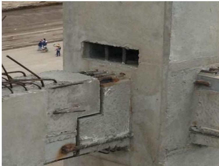
Imagen V.26. Nodo a colar detalle
