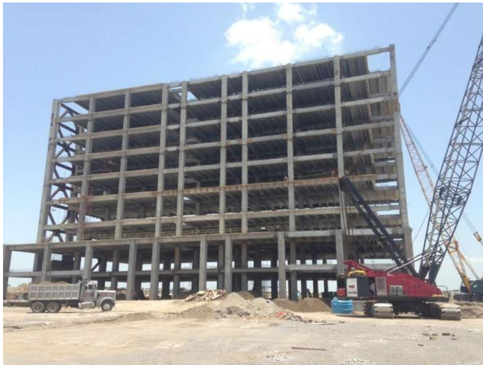
Imagen VI.3 Montaje de estructura prefabricada 3
