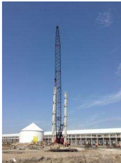
Imagen II.11. Pluma de grúa 1
