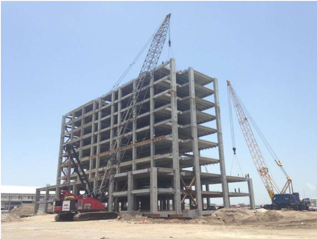
Imagen VI.1. Montaje de estructura prefabricada 1
