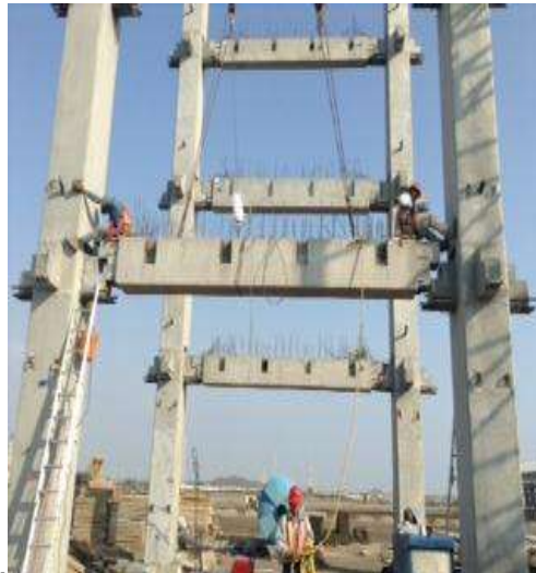
Imagen V.22. Cuadrante listo para recibir losas TT
