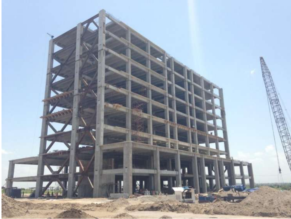
Imagen VI.2. Montaje de estructura prefabricada 2
