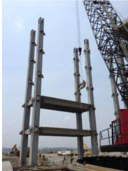
Imagen V.23. Montaje de losas TT en traves portantes
