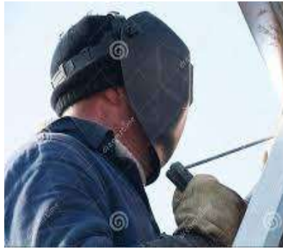
Imagen V.29. Soldadura de traves de rigidez
