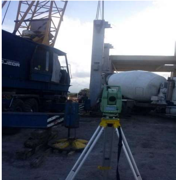
Imagen V.15. Plomeo de columna con estación total sentido Y
