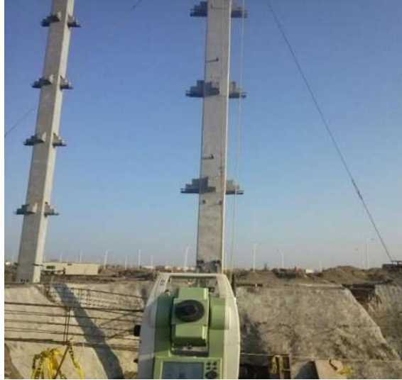
Imagen V.14. Plomeo de columna con estación total sentido X.
