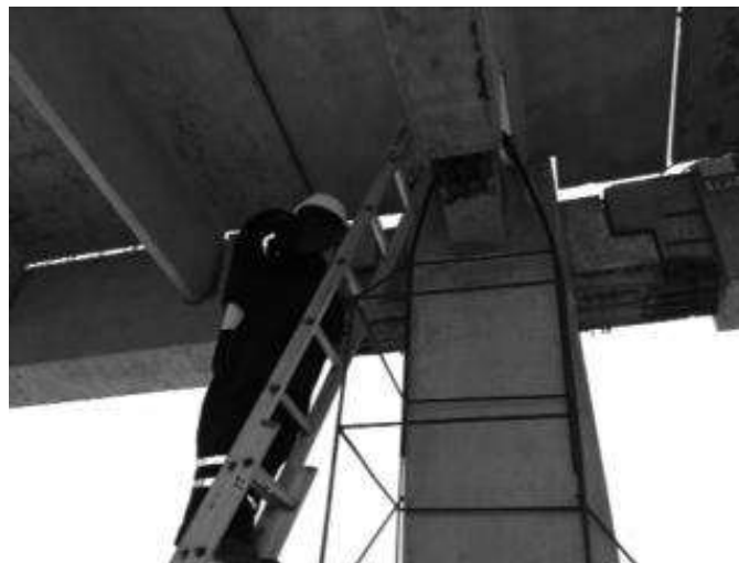
Imagen V.24. Soldadura entre conectores para unión de losas TT
