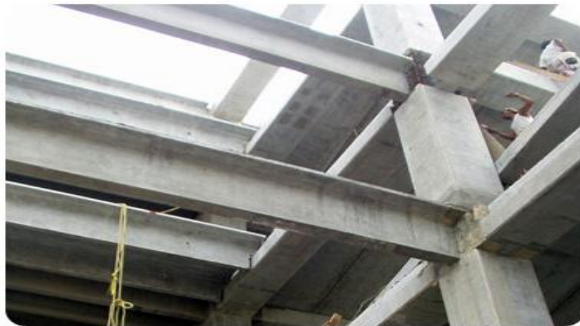
Imagen V.28. Montaje de trabes de rigidez
