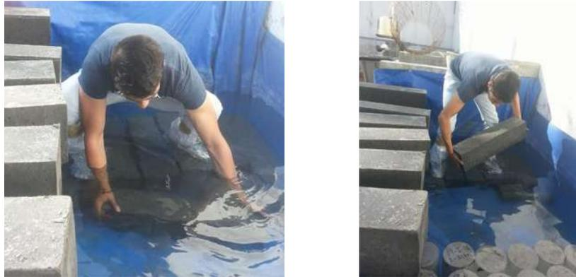
Figura 73. Inmersión de los elementos en la pila de curado. (Fotografías: E. González Castro).
