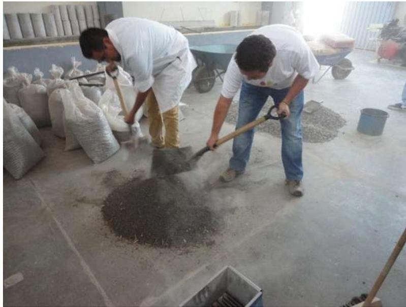
Figura 3.8. Mezclado del material. (F. López Regalado, 2016).
