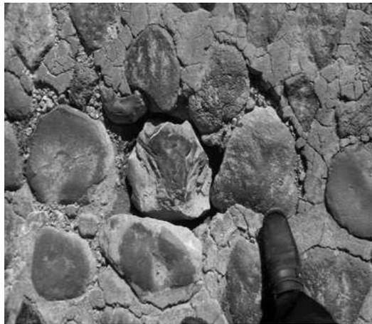
*Ilustración 1. Desprendimiento total entre mortero y roca de río (Fotografía L. Colín).*
