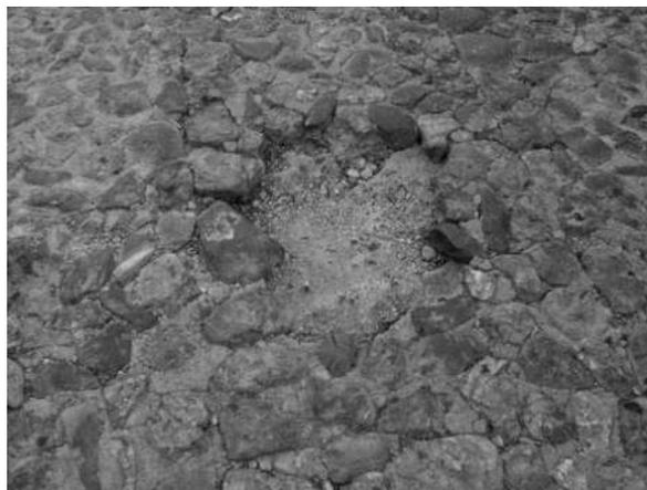
*Ilustración 2. Bache ocasionado por erosión del mortero (Fotografía L. Colín).*
