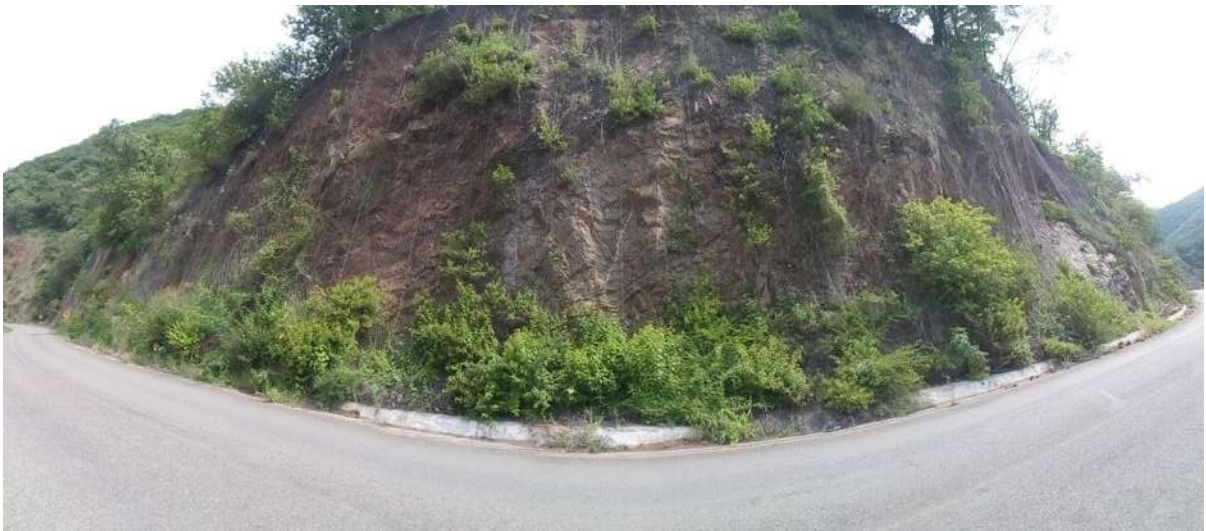
Figura 3-132 fotografía panorámica del talud 22 tomada en el 2016.
