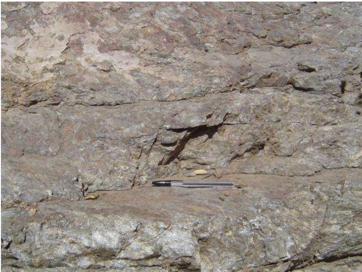
Figura 3-4. Detalla de las discontinuidades del talud 1. (Chávez y Arreygue 2009)
