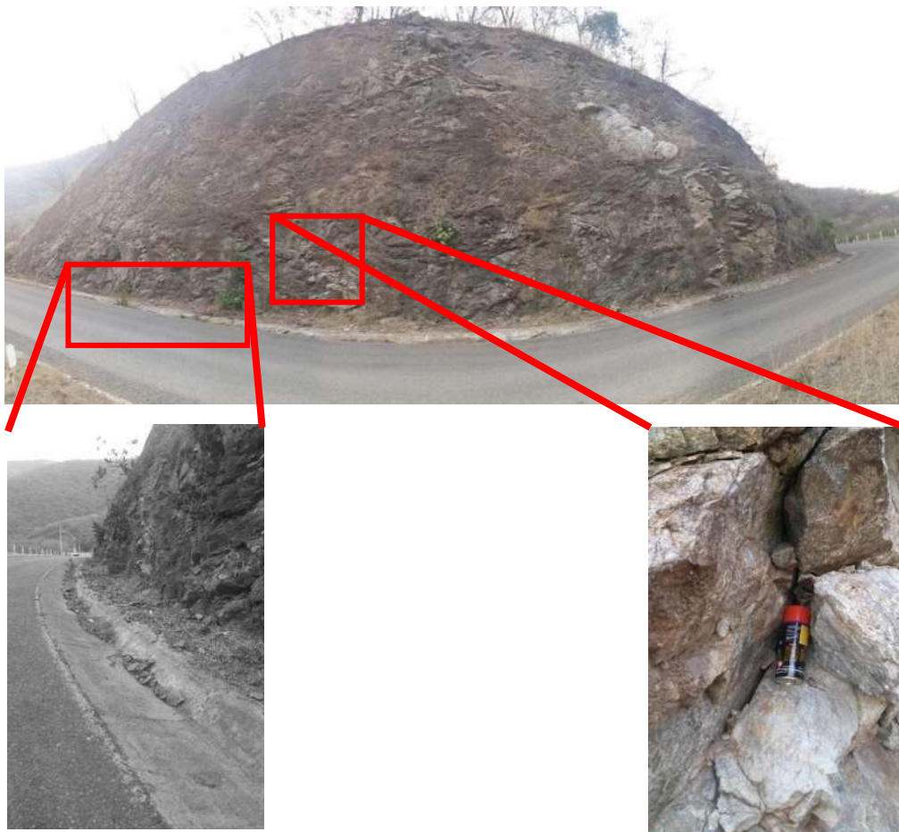
Figura 3-38 Identificación del estado que presenta el corte.
