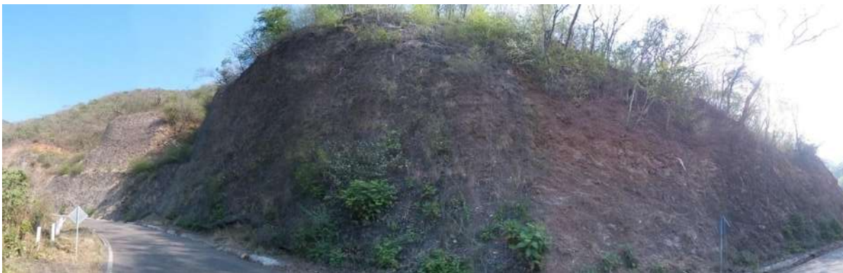
Figura 3-96 imagen panorámica del talud 16 tomada el 2016.
