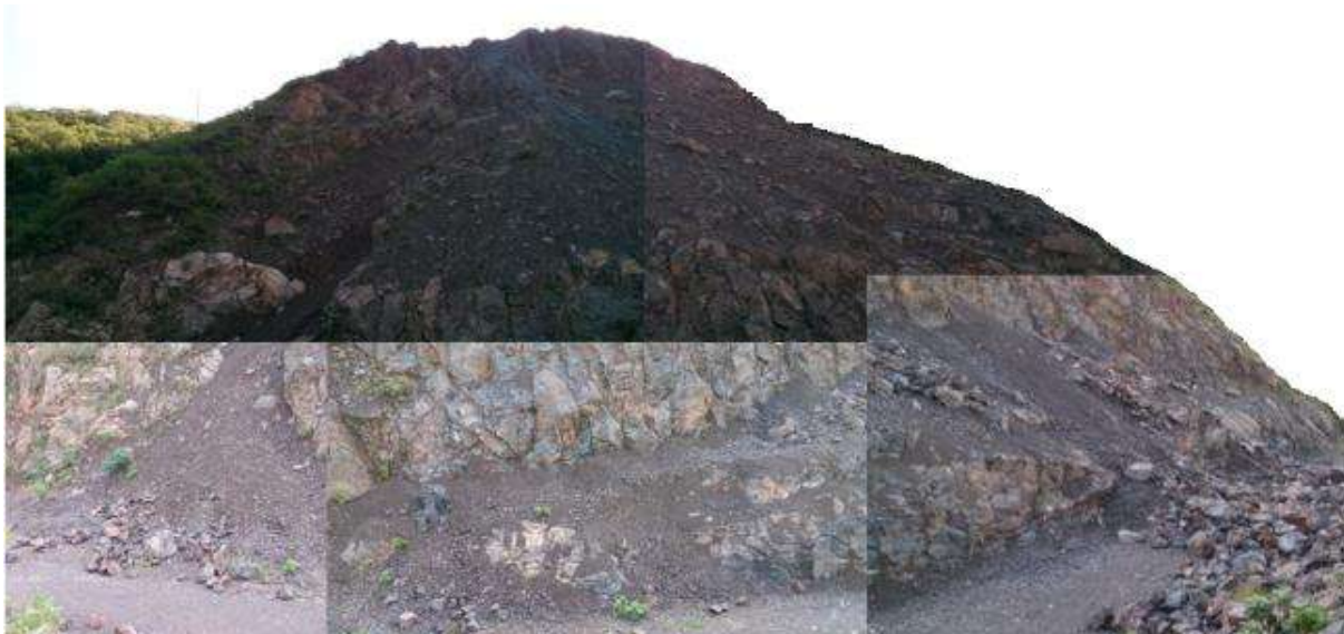
Figura 3-152 imagen panorámica del estado actual del talud faltante 6 en el 2016
