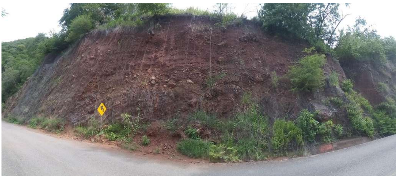
Figura 3-137 fotografía panorámica del estado del talud 23 tomada en el 2016.
