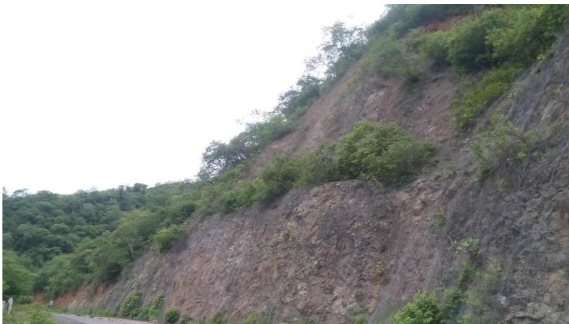
Figura 3-98 imagen panorámica del talud 17 tomada el 2016.
