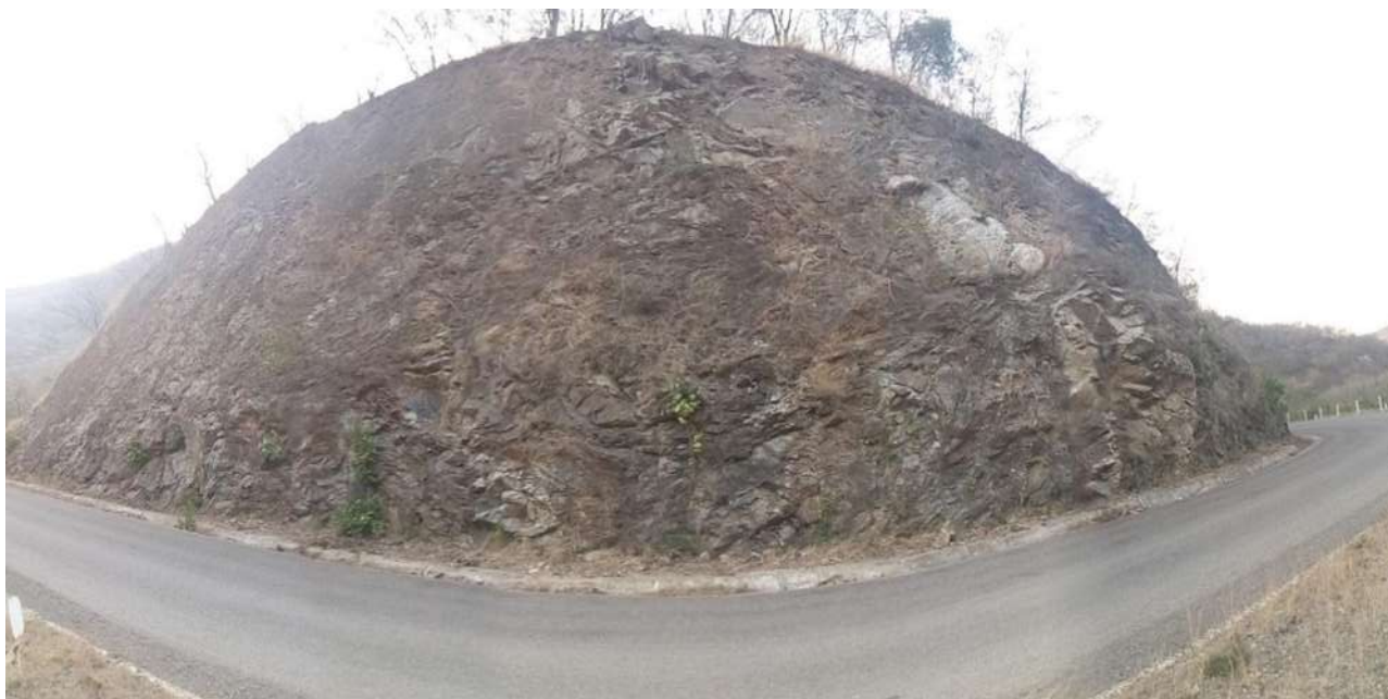
Figura 3-37 fotografía panorámica de la totalidad del talud 5 tomada en el 2016
