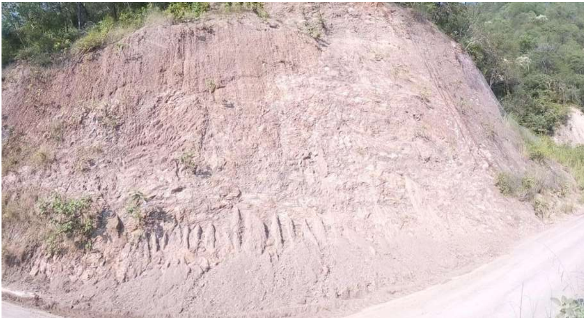
Figura 3-147 imagen panorámica del estado actual del talud faltante 3 en el 2016
