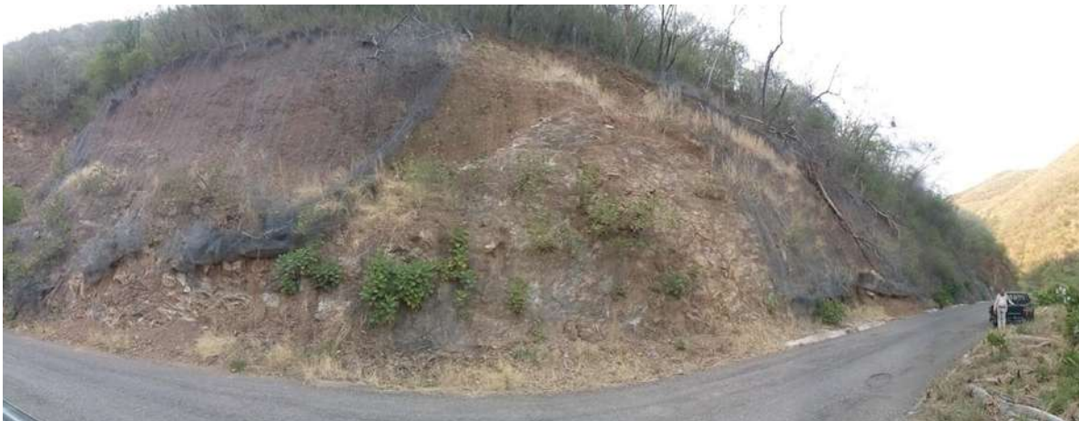
Figura 3-82 fotografía panorámica del talud 13 tomada en el 2016 siete años después de su construcción.
