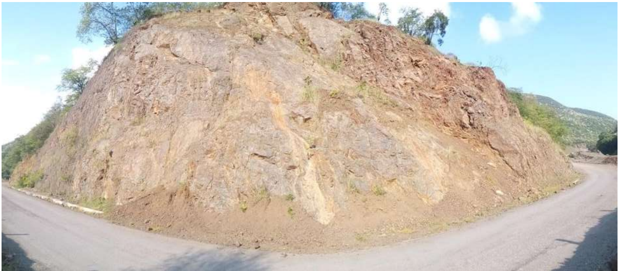
Figura 3-145 imagen panorámica del estado actual del talud faltante 2 en el 2016
