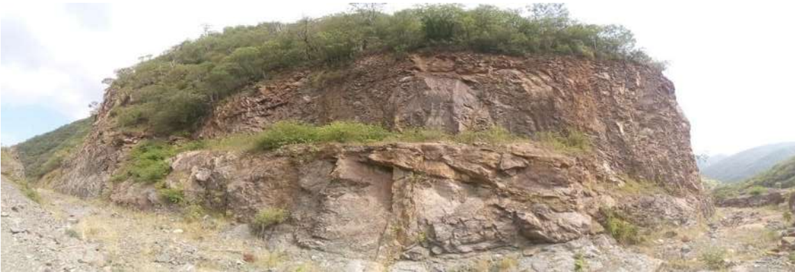
Figura 3-150 imagen panorámica del estado actual del talud faltante 5 en el 2016
