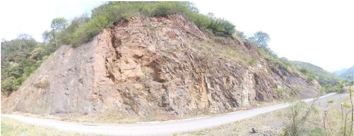
Figura 3-148 imagen panorámica del estado actual del talud faltante 4 en el 2016
