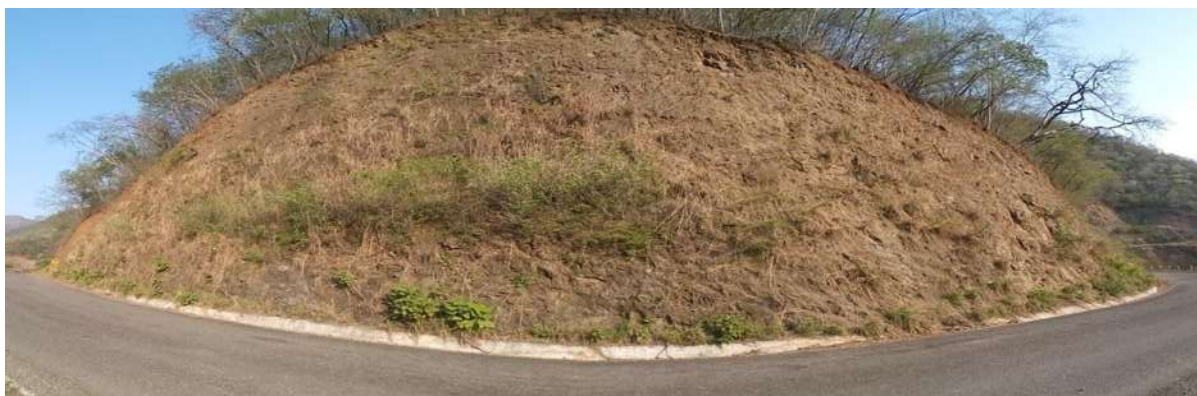
Figura 3-92 imagen panorámica del talud 15 tomada en el 2016.
