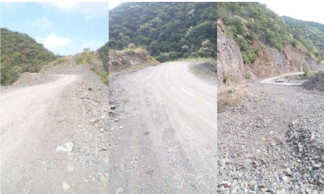
Figura 3-151 detalle de cómo se ve la terracería la cual está sobre el material del corte.
