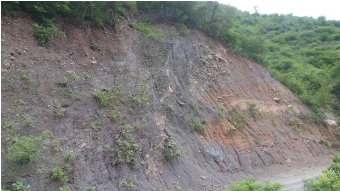
Figura 3-113 detalle de la parte de la derecha del talud 20.
