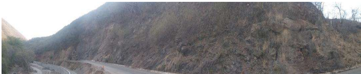
Figura 3-29 fotografía panorámica de las condiciones del talud cuatro en el año 2016
