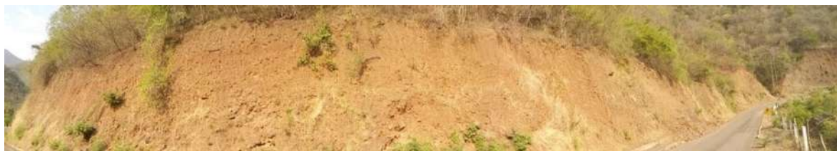
Figura 3-56 foto panorámica del talud 9 tomada en el 2016.
