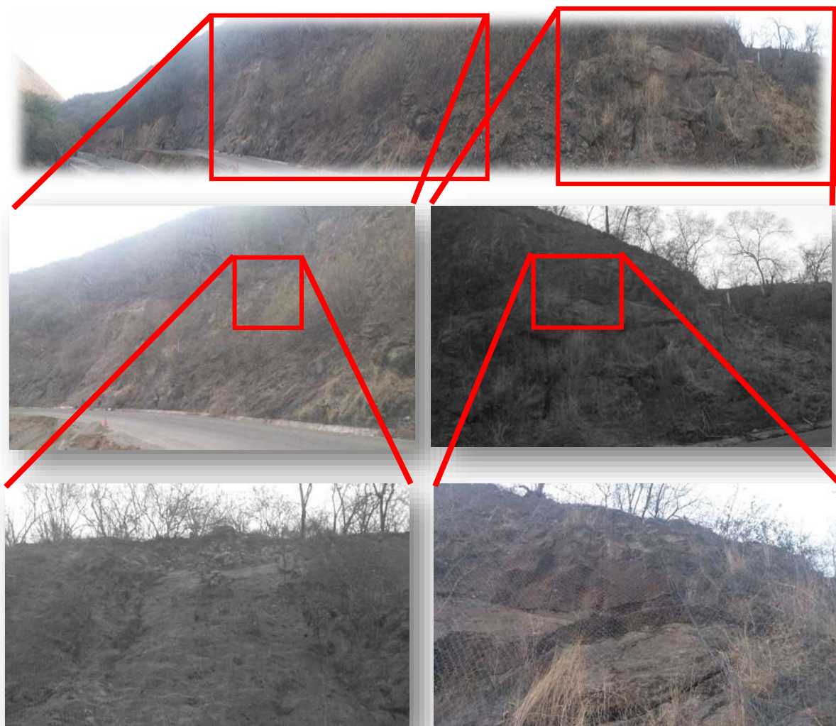
Figura 3-31 se presenta un zoom de algunos puntos del corte donde se han presentado movimientos grandes de material los cuales son tipo planar
