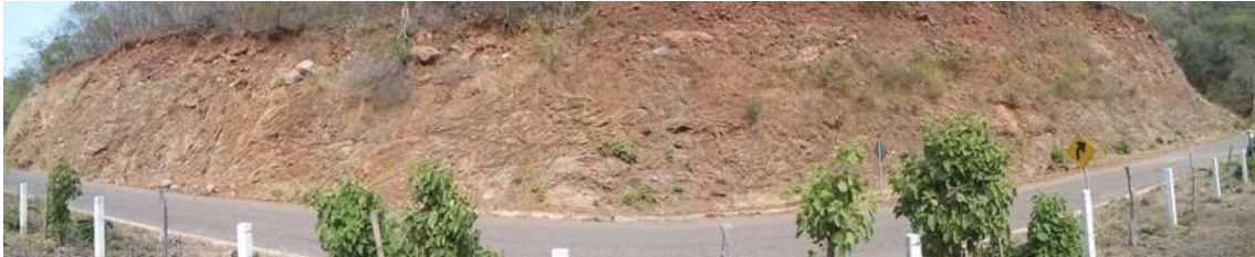
Figura 3-70 fotografía panorámica que muestra el estado que tiene el talud 11 en el 2016 a 7 años de su construcción.
