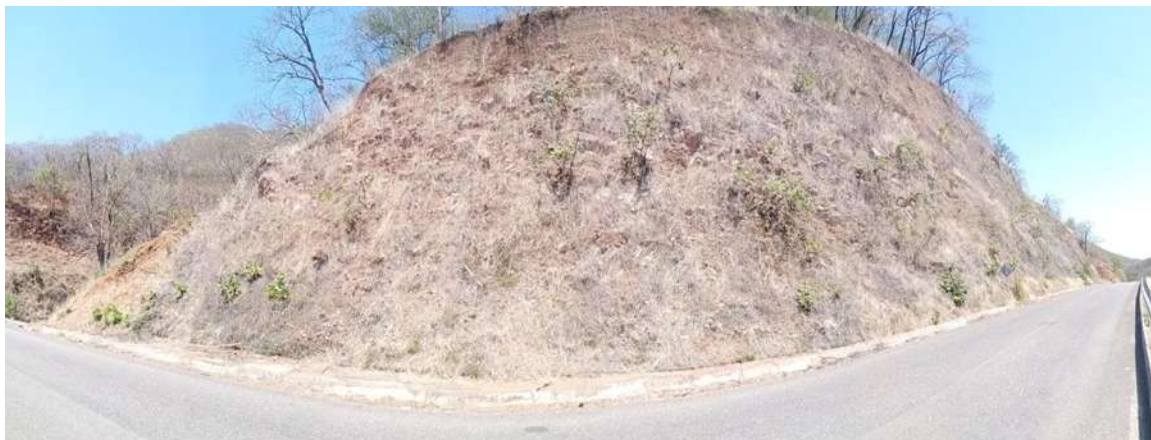
Figura 3-62 foto panorámica del talud 10 tomadas en el 2016.
