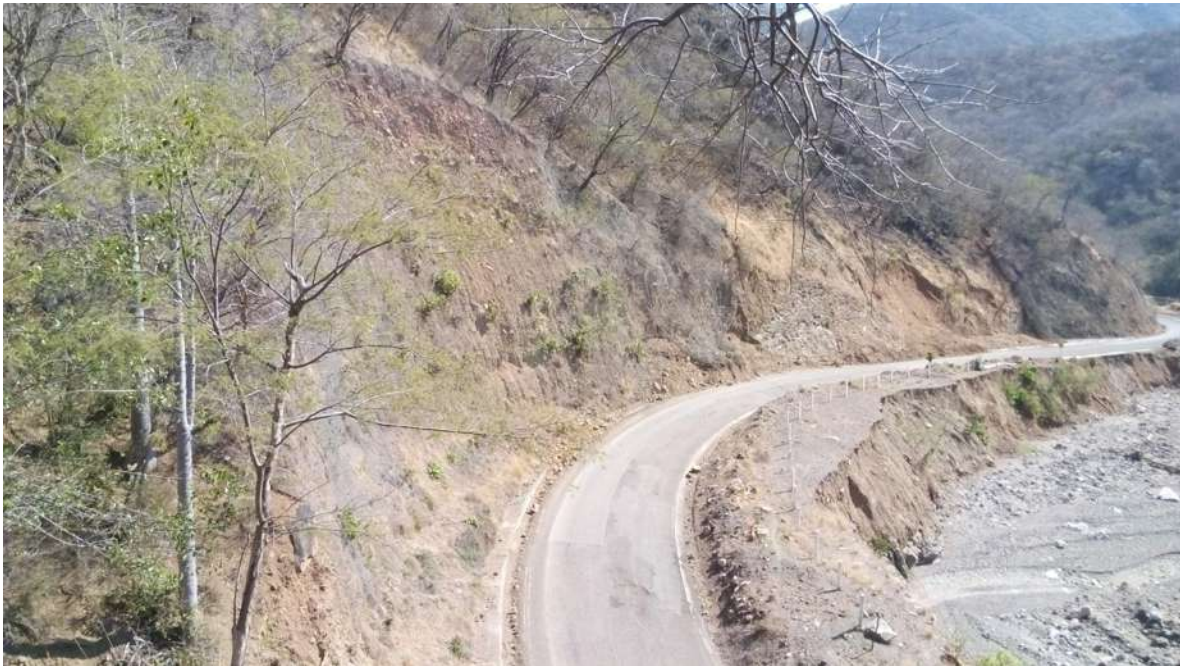
Figura 3-52 fotografía panorámica de talud 8 tomada en 2016
