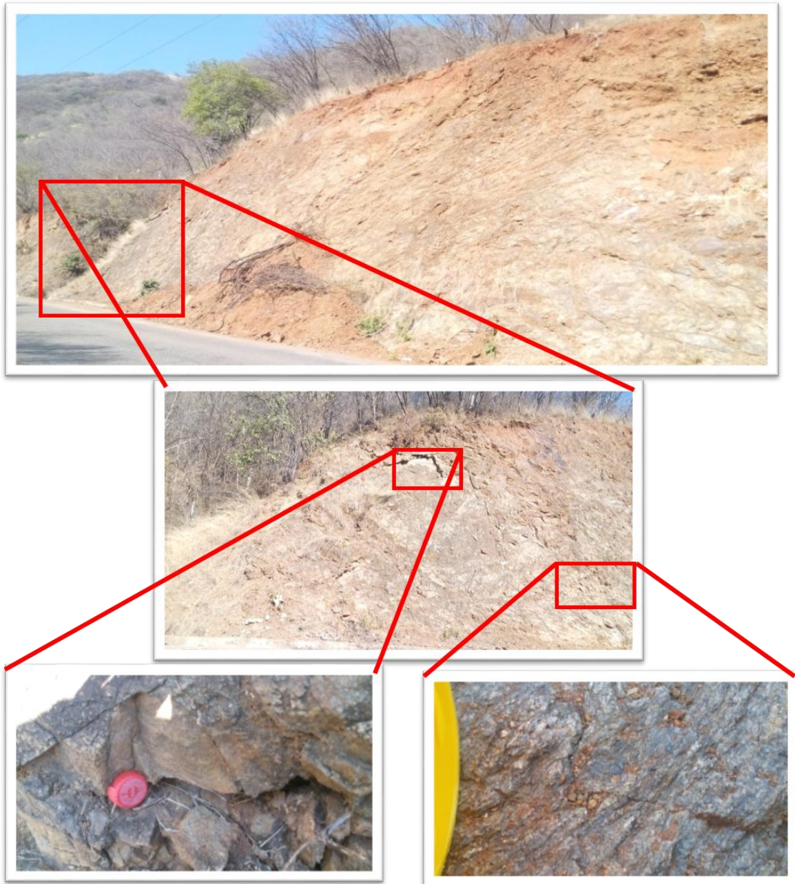
Figura 3-17 fotografías que muestran el estado de la roca que presenta el corte
