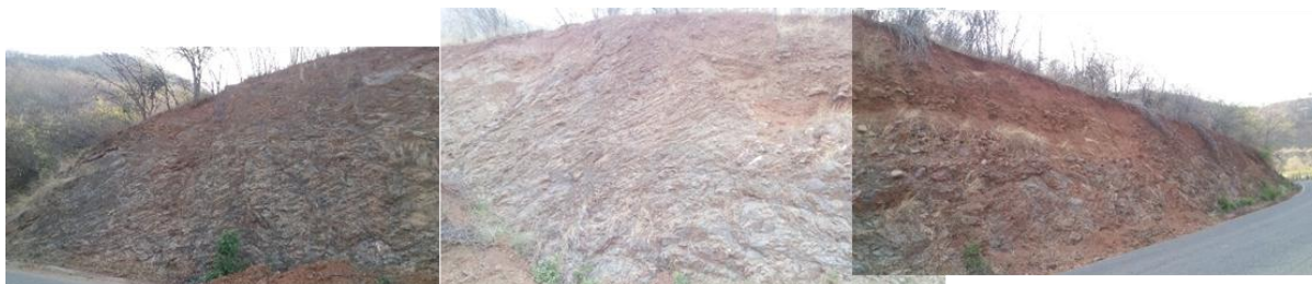
Figura 3-15 fotografías del talud 2 tomadas el 2016 donde muestra el estado que presenta actualmente.
