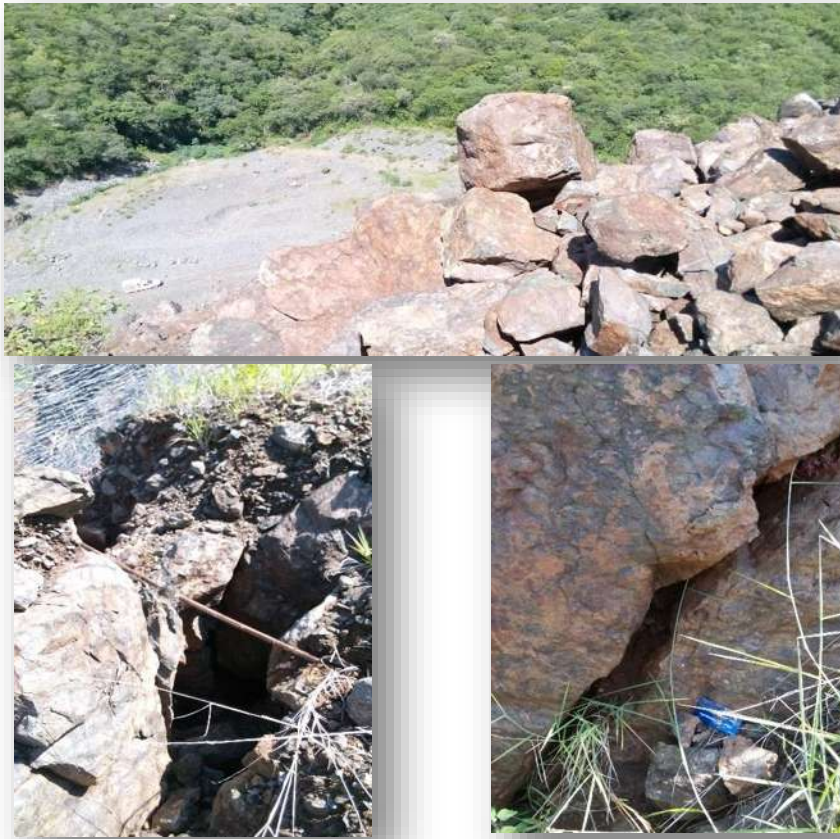
Figura 3-155 detalles que presenta el talud en la actualidad (2016).
